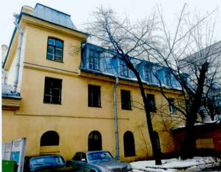
2. Общий вид. Восточный фасад объекта культурного наследия.
