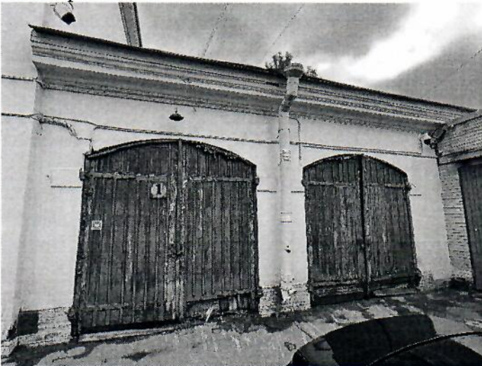
1. Фрагмент западного фасада
