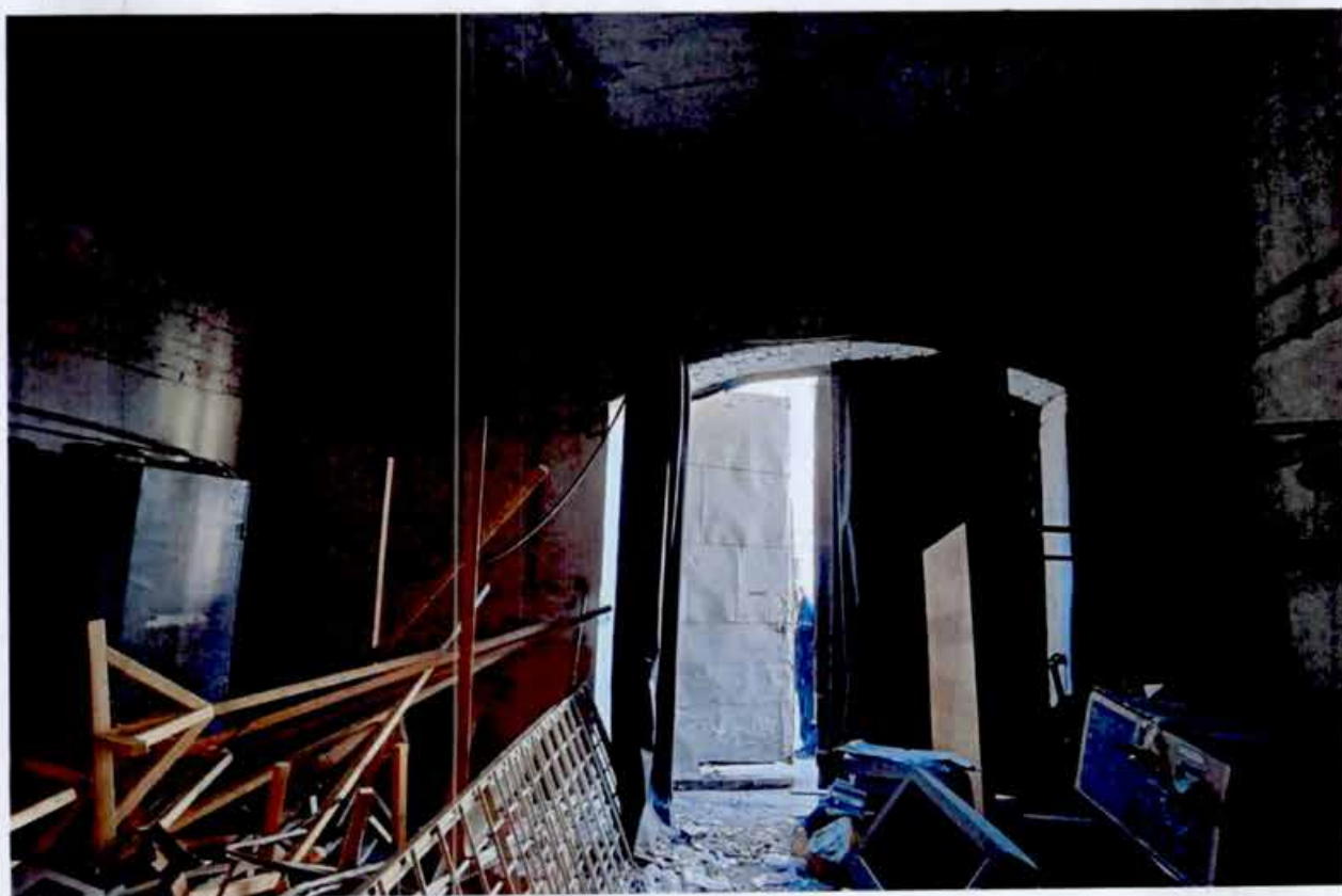
3. Помещение 1-го этажа.
