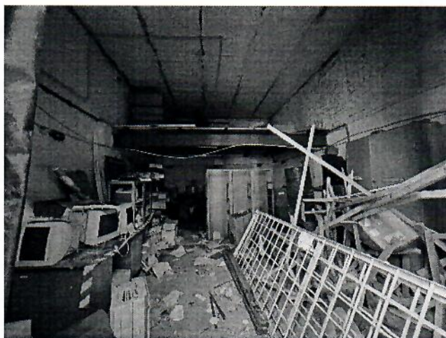
Фрагмент интерьера (пом. 1-го эт)
