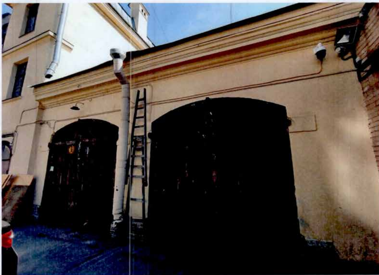
2. Вид на западный фасад объекта культурного наследия.
