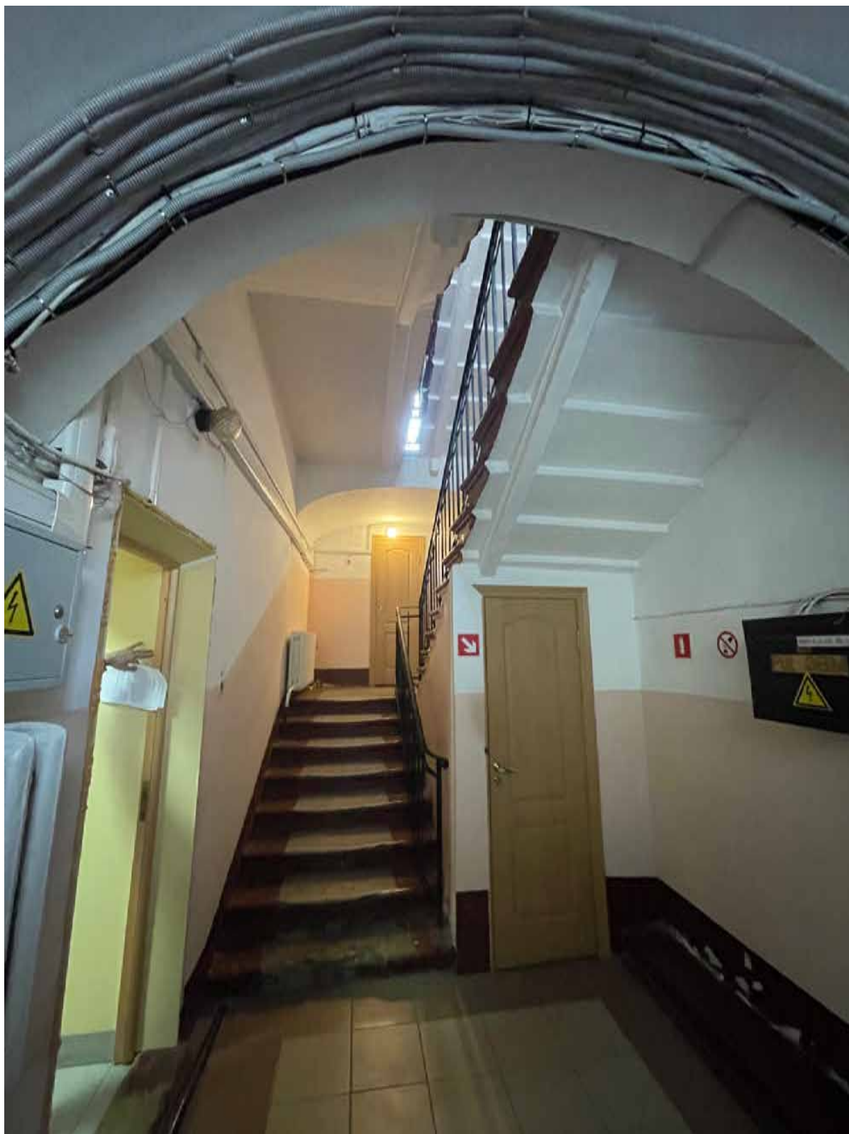
9. Вид на двухмаршевую лестницу в объекте культурного наследия федерального значения «Корпус служебный»
