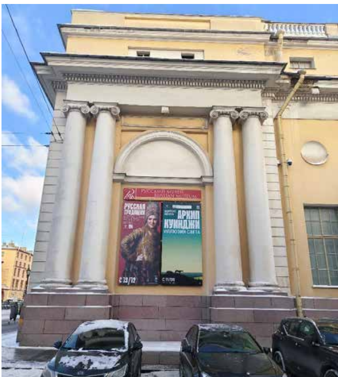
17. «Корпус западный Русского музея» (в составе «Дворец Великого князя Михаила Павловича (Русский музей Императора Александра III)»), г. Санкт-Петербург, Инженерная улица, дом 2-4, литера А. Южный фасад. Фрагмент. Фото 02.02.2026г.
