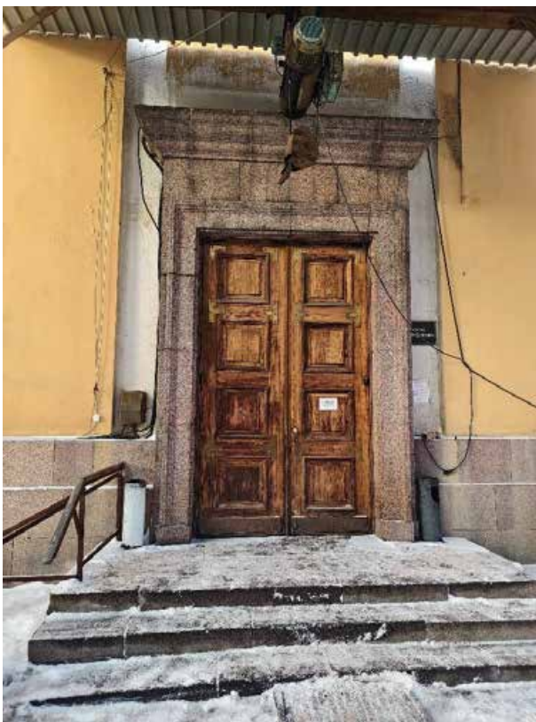
30. «Корпус западный Русского музея» (в составе «Дворец Великого князя Михаила Павловича (Русский музей Императора Александра III)»), г. Санкт-Петербург, Инженерная улица, дом 2-4, литера А. Восточный фасад. Фрагмент. Фото 02.02.2026г.
