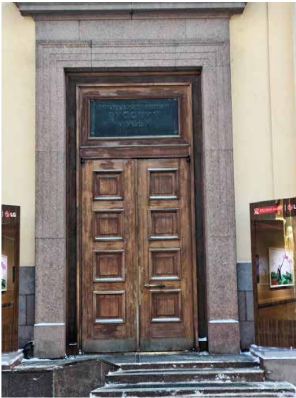
11. «Корпус западный Русского музея» (в составе «Дворец Великого князя Михаила Павловича (Русский музей Императора Александра III)»), г. Санкт-Петербург, Инженерная улица, дом 2-4, литера А. Западный фасад. Фрагмент. Фото 02.02.2026г.
