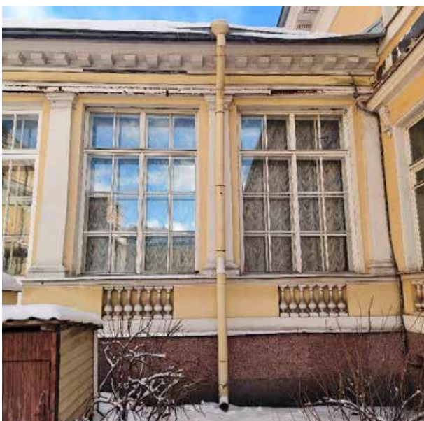
37. «Корпус западный Русского музея» (в составе «Дворец Великого князя Михаила Павловича (Русский музей Императора Александра III)»), г. Санкт-Петербург, Инженерная улица, дом 2-4, литера А. Переходная галерея. Южный фасад. Фрагмент. Фото 02.02.2026г.
