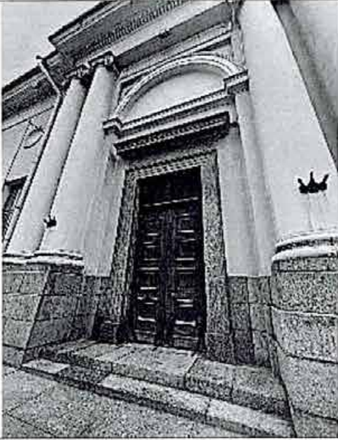
Фото 4. Фрагмент портала (по Инженерной ул.)
