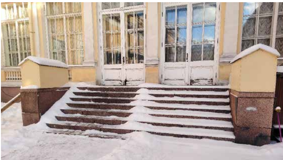
38. «Корпус западный Русского музея» (в составе «Дворец Великого князя Михаила Павловича (Русский музей Императора Александра III)»), г. Санкт-Петербург, Инженерная улица, дом 2-4, литера А. Переходная галерея. Южный фасад. Фрагмент. Фото 02.02.2026г.
