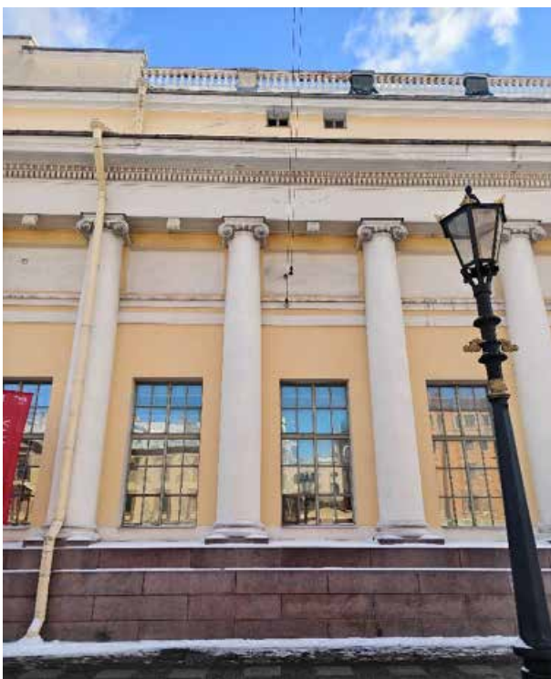
13. «Корпус западный Русского музея» (в составе «Дворец Великого князя Михаила Павловича (Русский музей Императора Александра III)»), г. Санкт-Петербург, Инженерная улица, дом 2-4, литера А. Западный фасад. Фрагмент. Фото 02.02.2026г.
