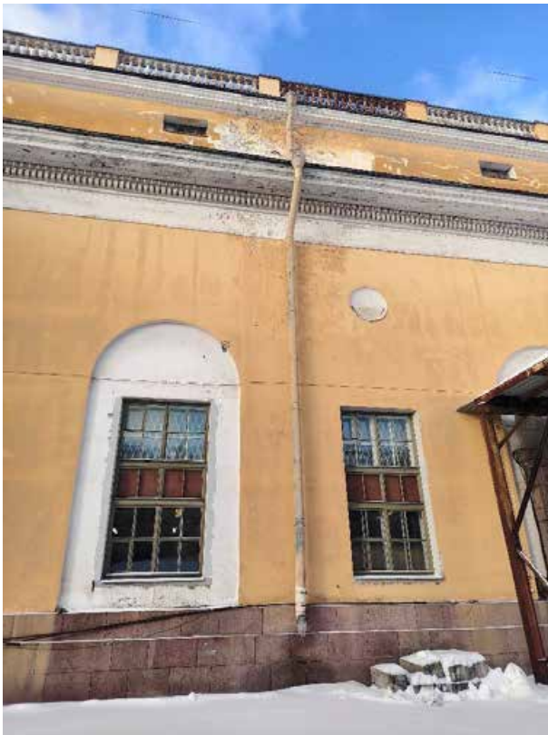
29. «Корпус западный Русского музея» (в составе «Дворец Великого князя Михаила Павловича (Русский музей Императора Александра III)»), г. Санкт-Петербург, Инженерная улица, дом 2-4, литера А. Восточный фасад. Фрагмент. Фото 02.02.2026г.
