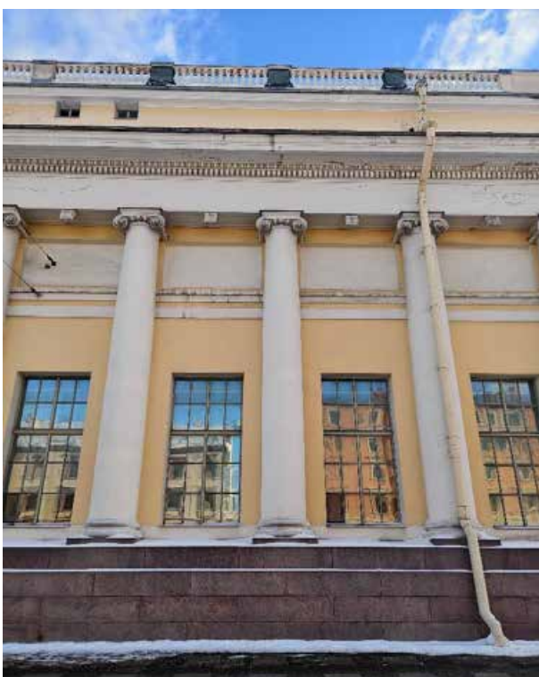
14. «Корпус западный Русского музея» (в составе «Дворец Великого князя Михаила Павловича (Русский музей Императора Александра III)»), г. Санкт-Петербург, Инженерная улица, дом 2-4, литера А. Западный фасад. Фрагмент. Фото 02.02.2026г.
