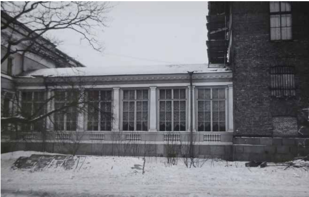
47. Корпус Бенуа. Вид на восстановленную восточную фасадную стенку здания и переходную галерею с западным дворцовым флигелем. Фотография. 1964 г. Сектор хранения документированной информации (архив) КГИОП (П-166-6. № 187 п).
