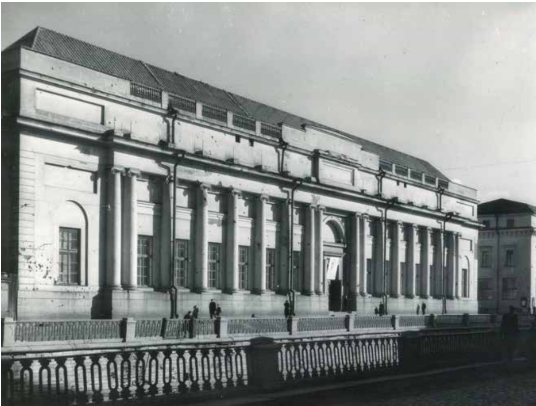
39. Общий вид корпуса Бенуа с набережной канала. Фотография А. Григорьева. 1949 г. Сектор хранения документированной информации (архив) КГИОП (инв. № 22363).
