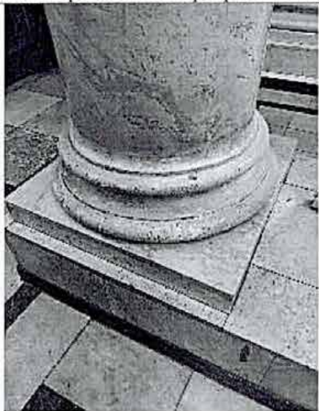
Фото 18. Фрагмент интерьера. База колонны
