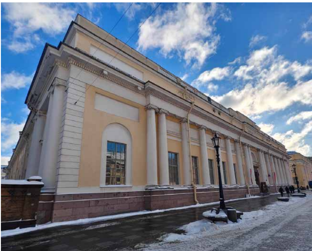
1. «Корпус западный Русского музея» (в составе «Дворец Великого князя Михаила Павловича (Русский музей Императора Александра III)»), г. Санкт-Петербург, Инженерная улица, дом 2-4, литера А. Западный фасад. Общий вид. Фото 02.02.2026г.
