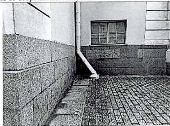
Фото 3. Фрагмент отделки фасада. Гранитный цоколь, отмостка, элемент водосточной системы
