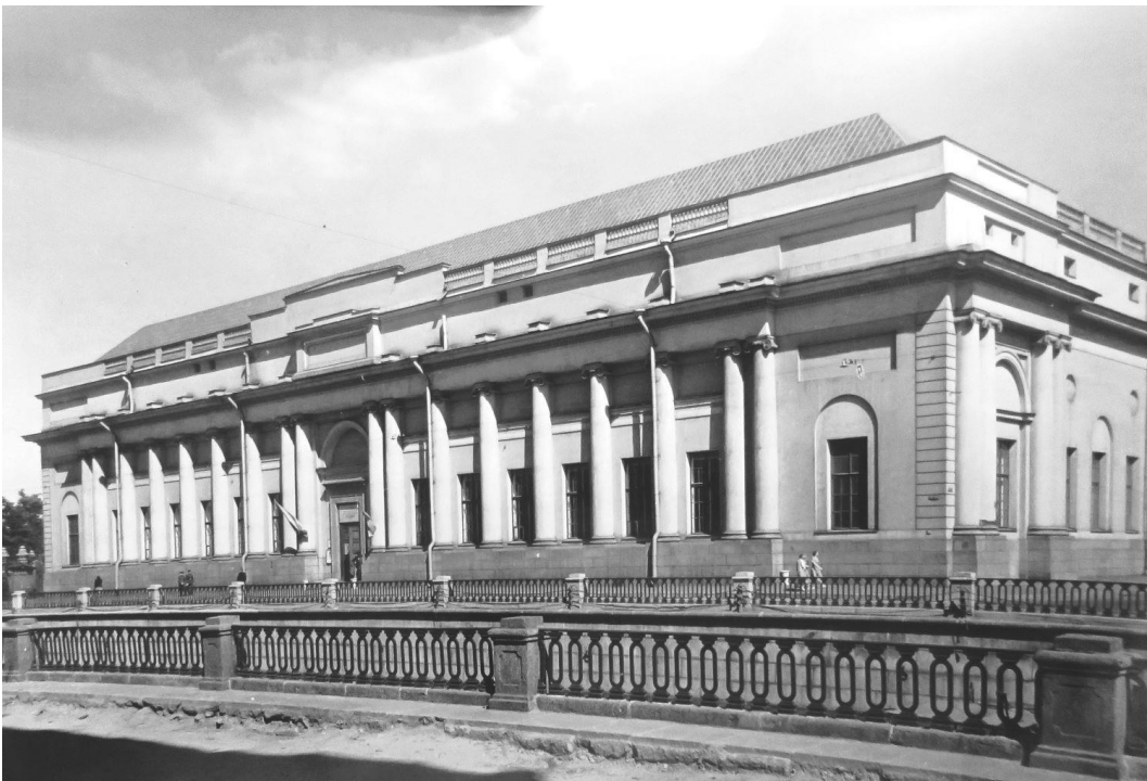
50. Общий вид корпуса Бенуа с юго-западной стороны. Фотография А. Григорьева. 1971 г. Сектор хранения документированной информации (архив) КГИОП (П-166-6. № 187 п).
