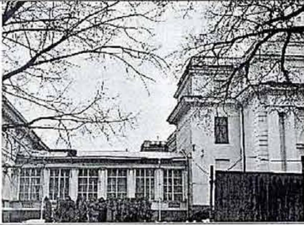
Фото 10. Фрагмент фасада с галереей
