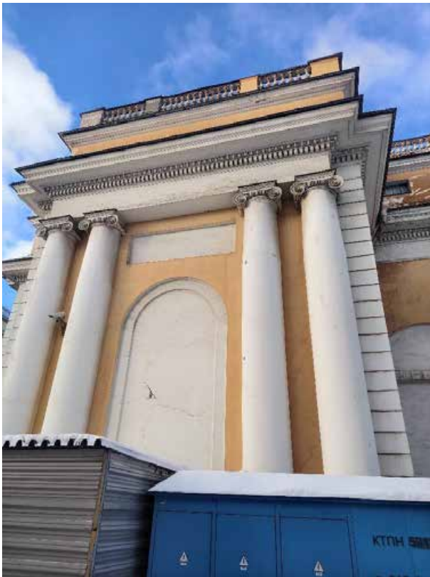
25. «Корпус западный Русского музея» (в составе «Дворец Великого князя Михаила Павловича (Русский музей Императора Александра III)»), г. Санкт-Петербург, Инженерная улица, дом 2-4, литера А. Восточный фасад. Фрагмент. Фото 02.02.2026г.
