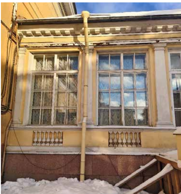
35. «Корпус западный Русского музея» (в составе «Дворец Великого князя Михаила Павловича (Русский музей Императора Александра III)»), г. Санкт-Петербург, Инженерная улица, дом 2-4, литера А. Переходная галерея. Южный фасад. Фрагмент. Фото 02.02.2026г.
