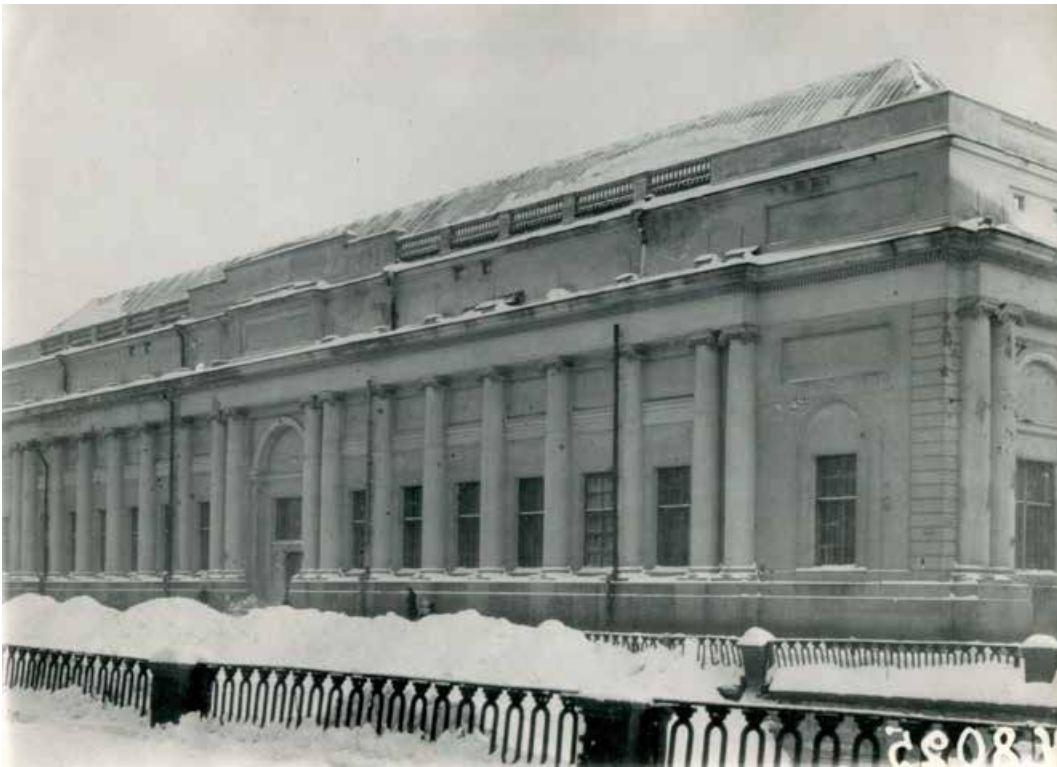
37. Общий вид корпуса Бенуа с набережной канала. Фотография А. Григорьева. 1948 г. Сектор хранения документированной информации (архив) КГИОП (инв. № 21117).
