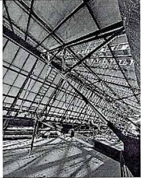
Фото 13. Фрагмент конструкций светового фонаря
