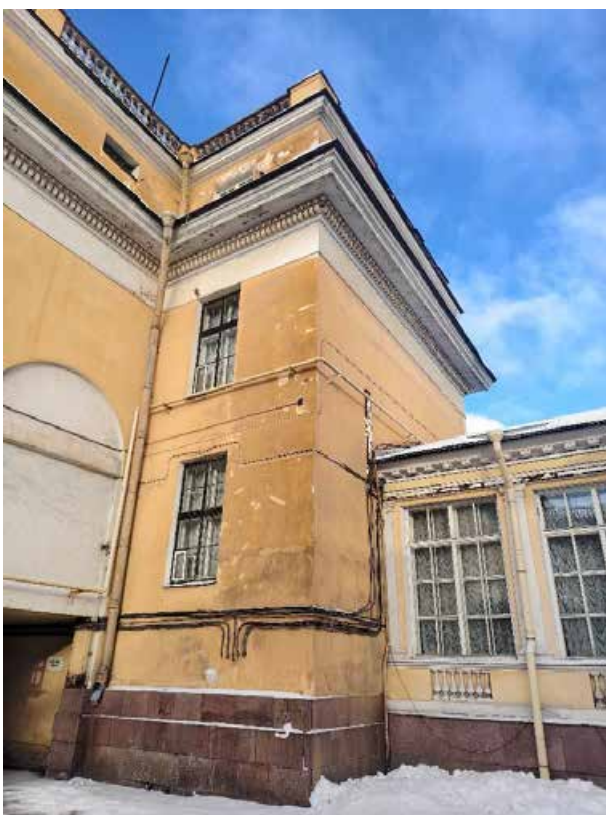
34. «Корпус западный Русского музея» (в составе «Дворец Великого князя Михаила Павловича (Русский музей Императора Александра III)»), г. Санкт-Петербург, Инженерная улица, дом 2-4, литера А. Восточный фасад. Фрагмент. Фото 02.02.2026г.
