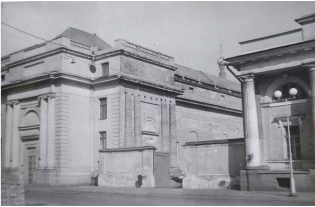
45. Корпус Бенуа. Вид с Инженерной улицы на восстановленную восточную фасадную стенку здания. Фотография. 1962 г. Сектор хранения документированной информации (архив) КГИОП (П-166-6. № 187 п).
