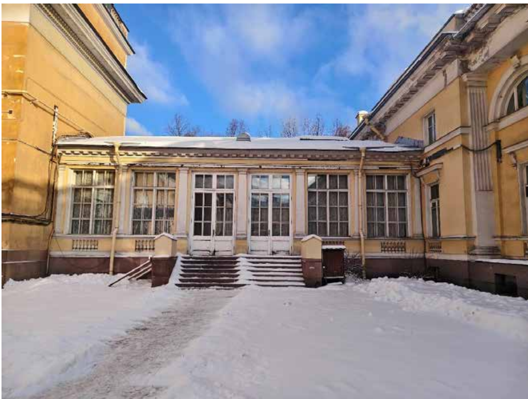
4. «Корпус западный Русского музея» (в составе «Дворец Великого князя Михаила Павловича (Русский музей Императора Александра III)»), г. Санкт-Петербург, Инженерная улица, дом 2-4, литера А. Переходная галерея. Южный фасад. Общий вид. Фото 02.02.2026г.
