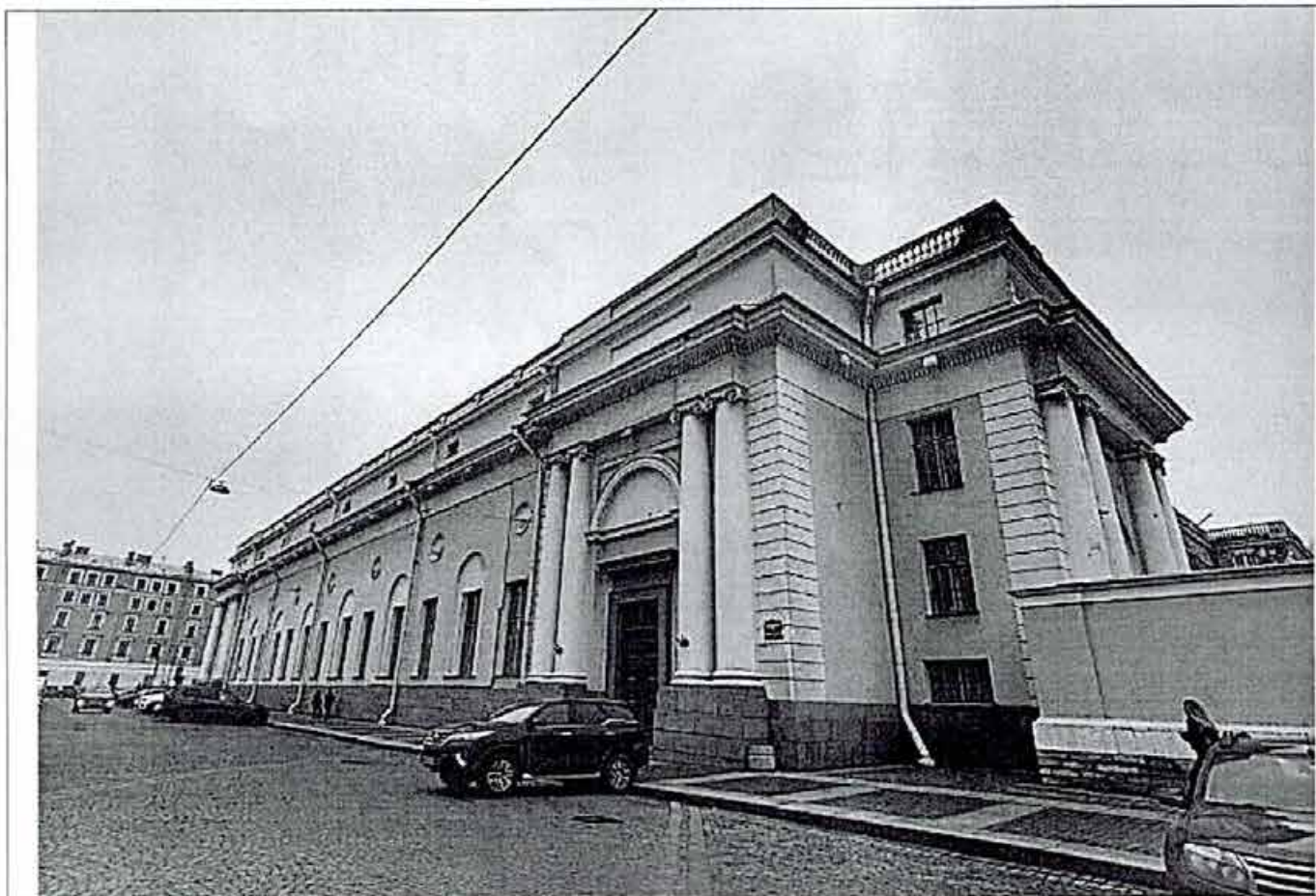
Фото 1. Общий вид на здание со стороны пл. Искусств
