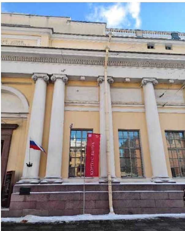
12. «Корпус западный Русского музея» (в составе «Дворец Великого князя Михаила Павловича (Русский музей Императора Александра III)»), г. Санкт-Петербург, Инженерная улица, дом 2-4, литера А. Западный фасад. Фрагмент. Фото 02.02.2026г.
