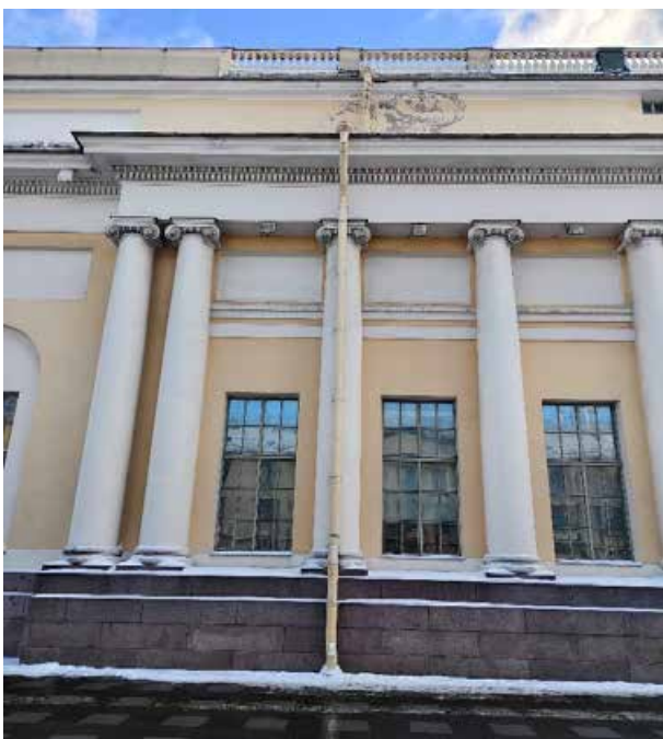
8. «Корпус западный Русского музея» (в составе «Дворец Великого князя Михаила Павловича (Русский музей Императора Александра III)»), г. Санкт-Петербург, Инженерная улица, дом 2-4, литера А. Западный фасад. Фрагмент. Фото 02.02.2026г.
