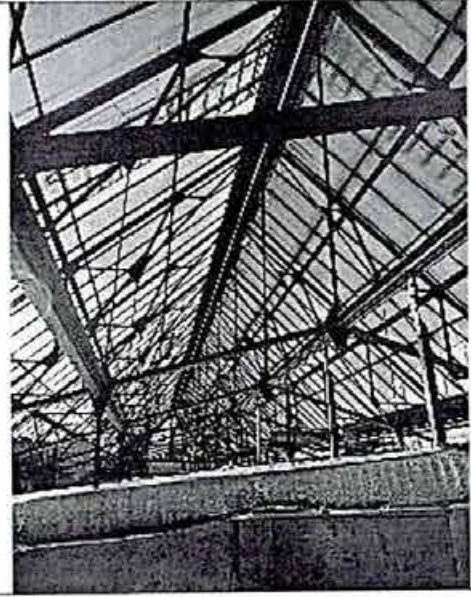
Фото 15. Фрагмент конструкций светового фонаря
