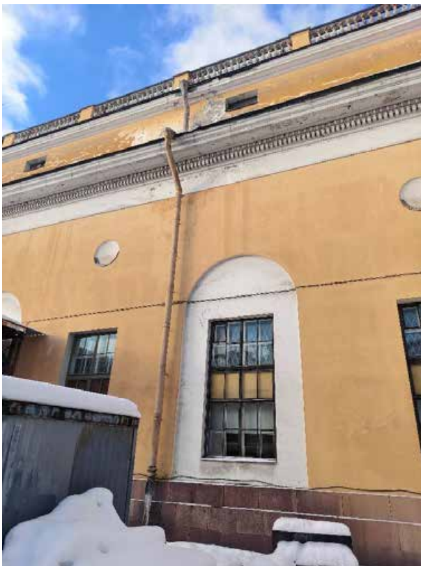
32. «Корпус западный Русского музея» (в составе «Дворец Великого князя Михаила Павловича (Русский музей Императора Александра III)»), г. Санкт-Петербург, Инженерная улица, дом 2-4, литера А. Восточный фасад. Фрагмент. Фото 02.02.2026г.
