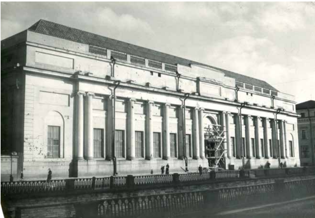
38. Общий вид корпуса Бенуа с набережной канала. Фотография А. Григорьева. 1949 г. Сектор хранения документированной информации (архив) КГИОП (инв. № 29350).
