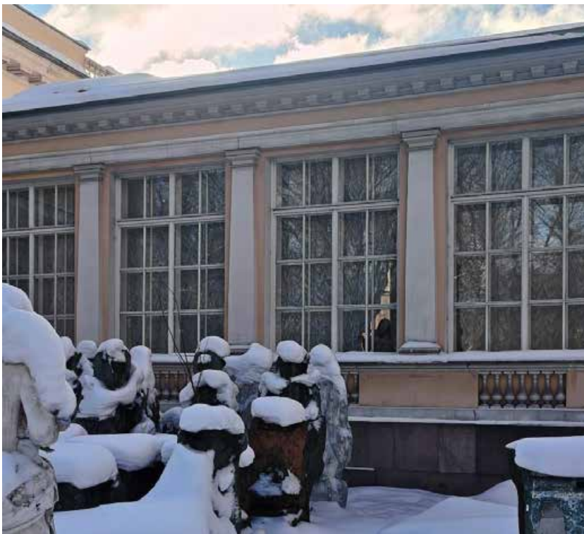
40. «Корпус западный Русского музея» (в составе «Дворец Великого князя Михаила Павловича (Русский музей Императора Александра III)»), г. Санкт-Петербург, Инженерная улица, дом 2-4, литера А. Переходная галерея. Северный фасад. Фрагмент. Фото 02.02.2026г.
