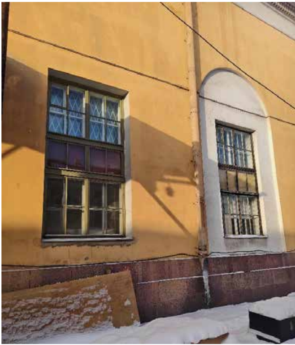
31. «Корпус западный Русского музея» (в составе «Дворец Великого князя Михаила Павловича (Русский музей Императора Александра III)»), г. Санкт-Петербург, Инженерная улица, дом 2-4, литера А. Восточный фасад. Фрагмент. Фото 02.02.2026г.
