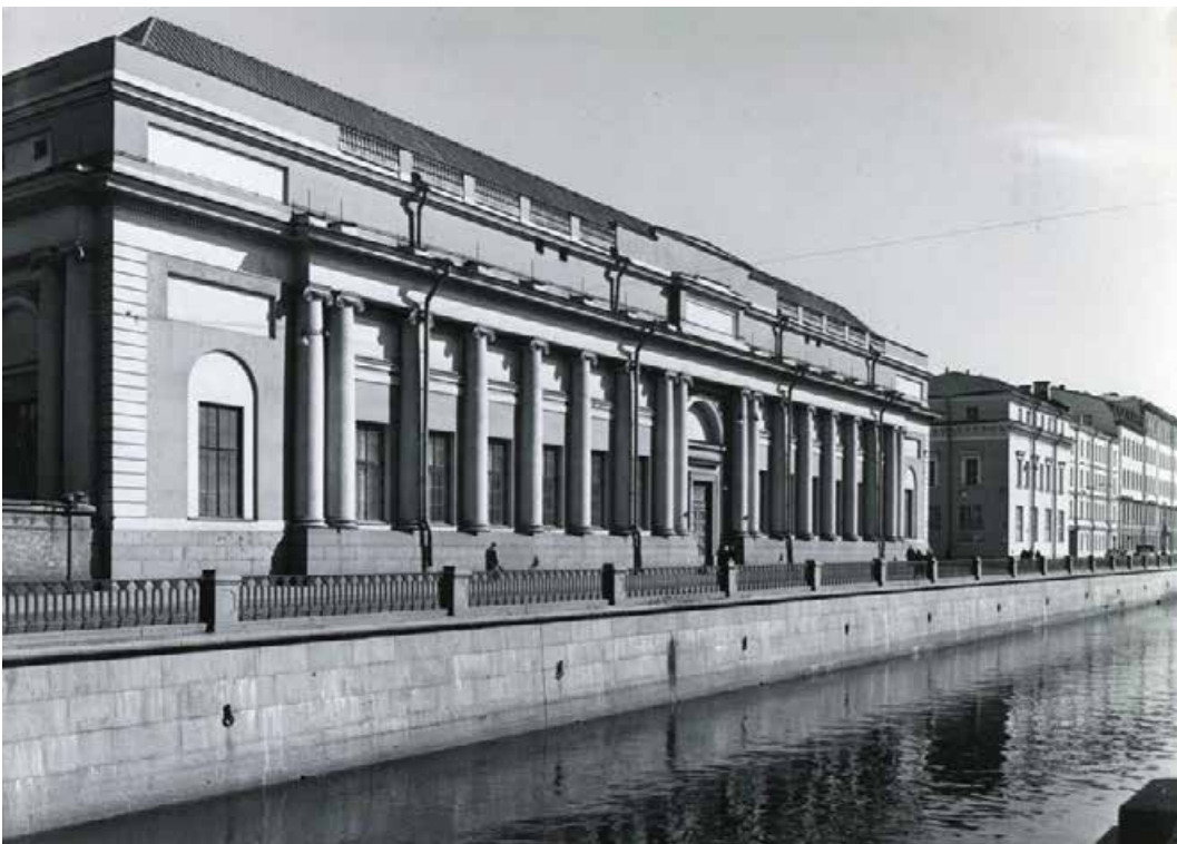
48. Общий вид корпуса Бенуа с северо-западной стороны. Фотография А. Григорьева. 1971 г. Сектор хранения документированной информации (архив) КГИОП (инв. № 97875).
