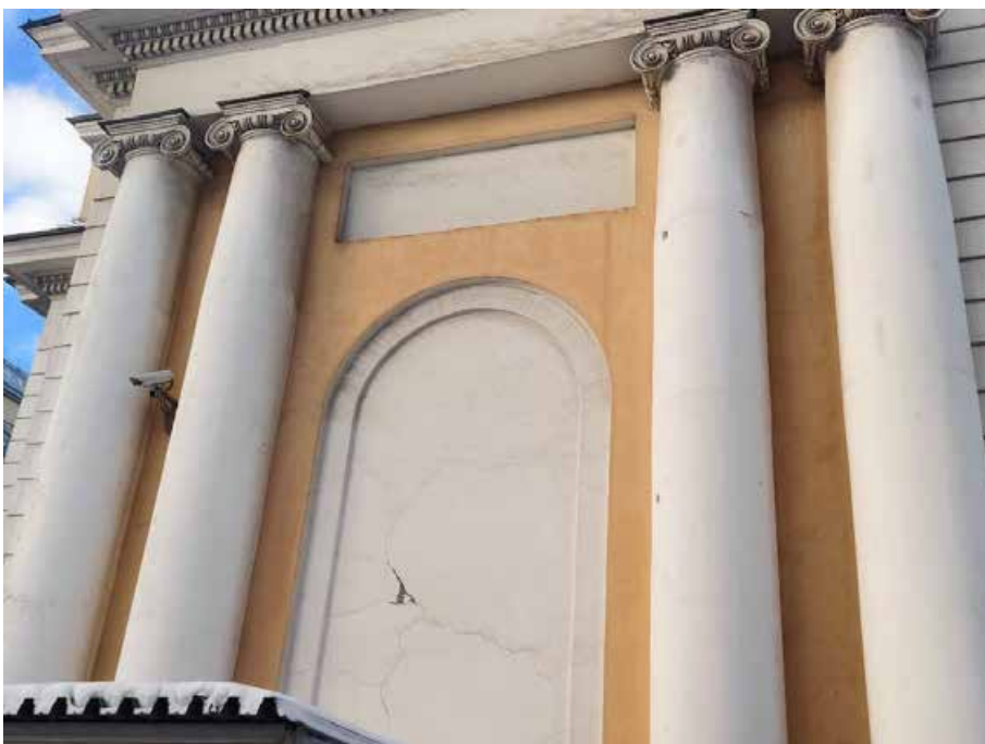
27. «Корпус западный Русского музея» (в составе «Дворец Великого князя Михаила Павловича (Русский музей Императора Александра III)»), г. Санкт-Петербург, Инженерная улица, дом 2-4, литера А. Восточный фасад. Фрагмент. Фото 02.02.2026г.
