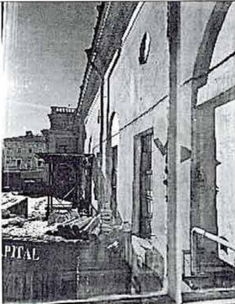
Фото 12. Фрагмент дворового фасада
