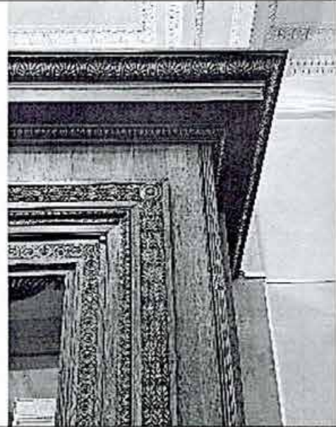
Фото 17. Фрагмент интерьера. Тамбур
