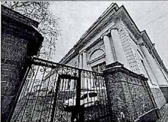
Фото 8. Фрагмент фасада во внутреннем дворе
