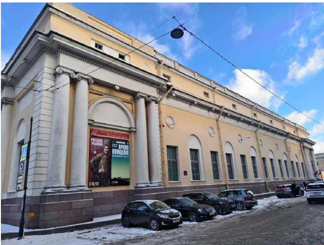
2. «Корпус западный Русского музея» (в составе «Дворец Великого князя Михаила Павловича (Русский музей Императора Александра III)»), г. Санкт-Петербург, Инженерная улица, дом 2-4, литера А. Южный фасад. Общий вид. Фото 02.02.2026г.
