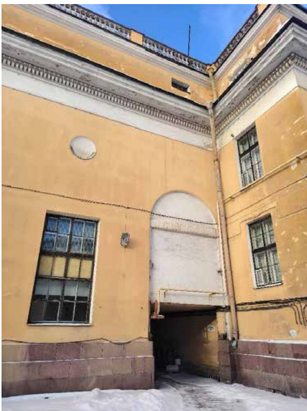
33. «Корпус западный Русского музея» (в составе «Дворец Великого князя Михаила Павловича (Русский музей Императора Александра III)»), г. Санкт-Петербург, Инженерная улица, дом 2-4, литера А. Восточный фасад. Фрагмент. Фото 02.02.2026г.
