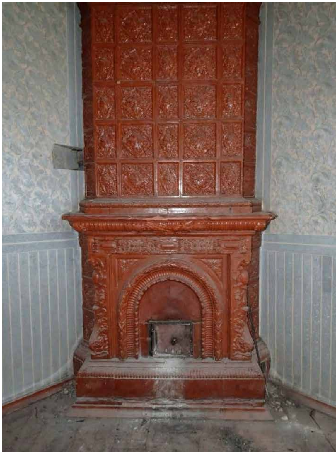
7. Вид на печь в помещении 2/54.3;
