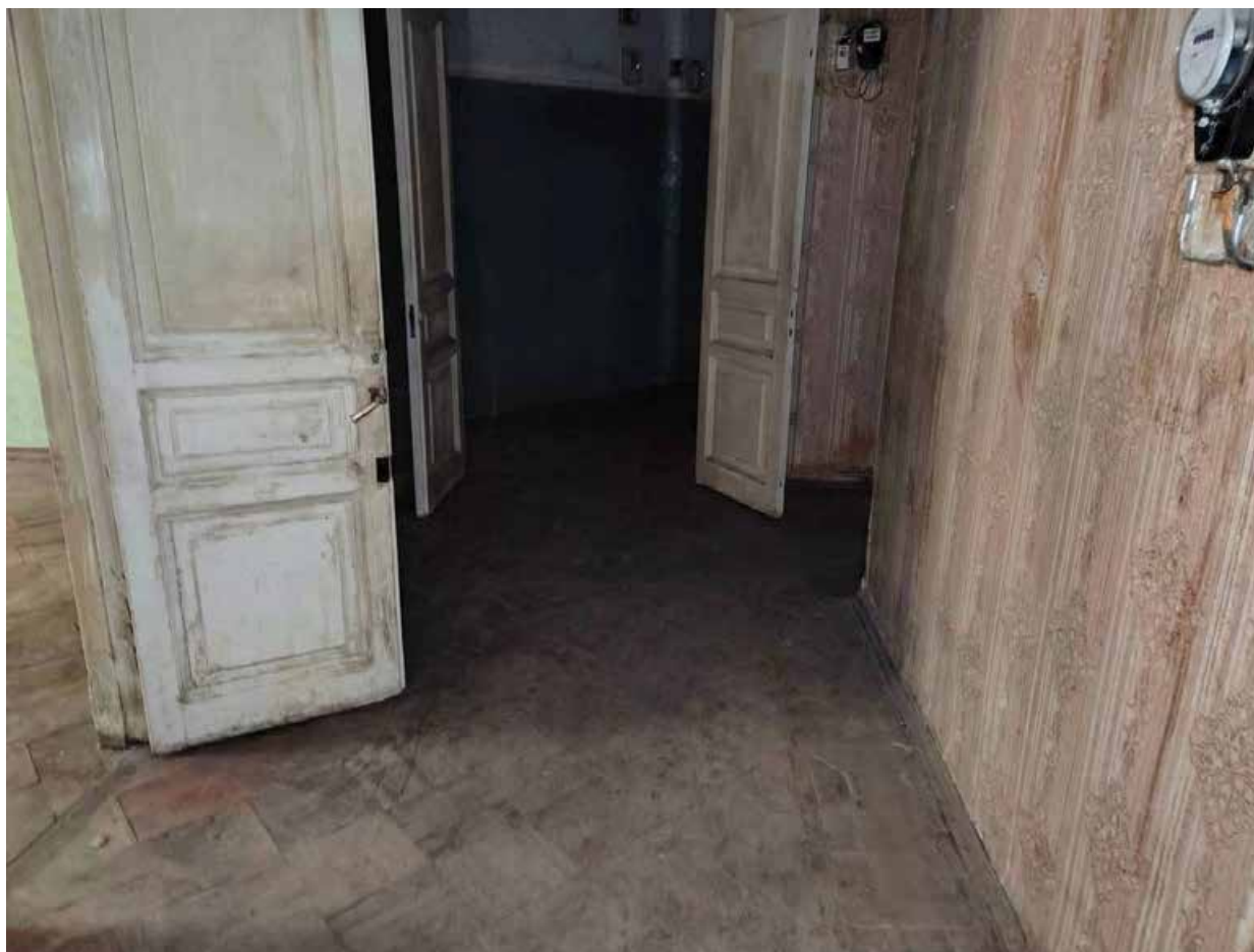
4. Фрагмент интерьера коридора (помещение 1/11.7);
