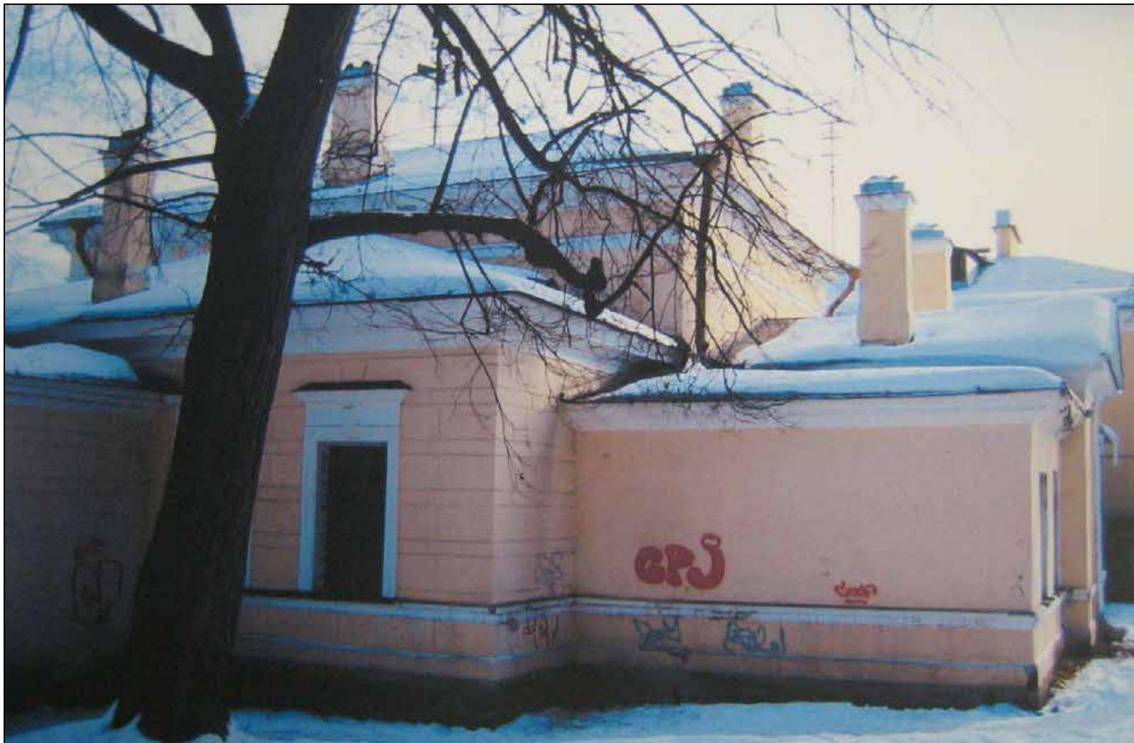
21. Дом № 33 по Московской ул. Западный боковой фасад. Фотофиксация перед проведением реставрационных работ. 2006 г.
