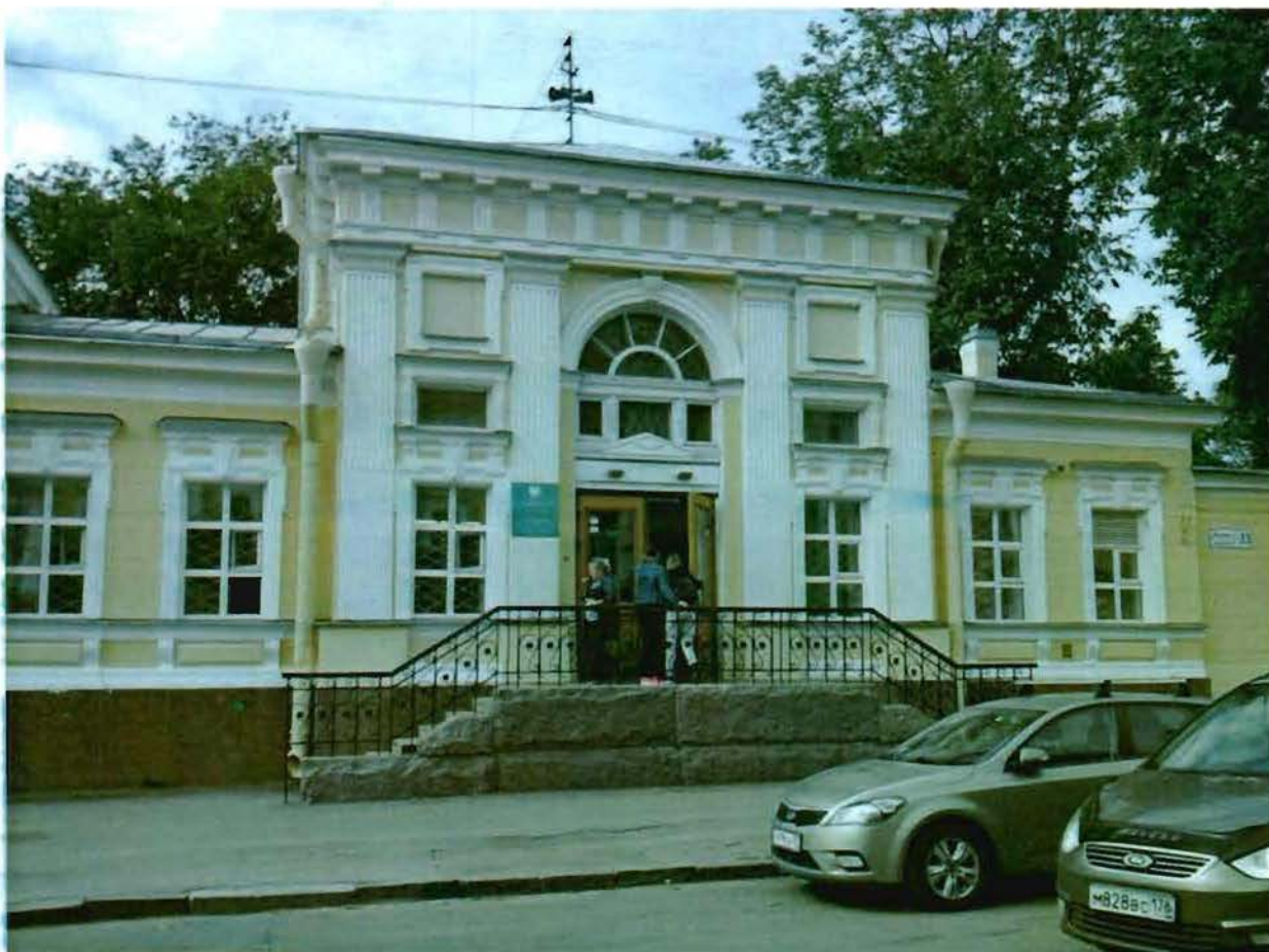
1. Северный фасад здания.
