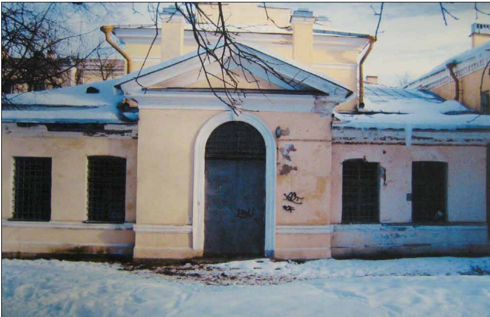
22. Дом № 33 по Московской ул. Южный (дворовый) фасад. Фотофиксация перед проведением реставрационных работ. 2006 г.
