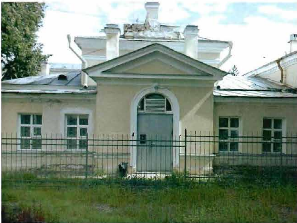
2. Южный фасад здания.
