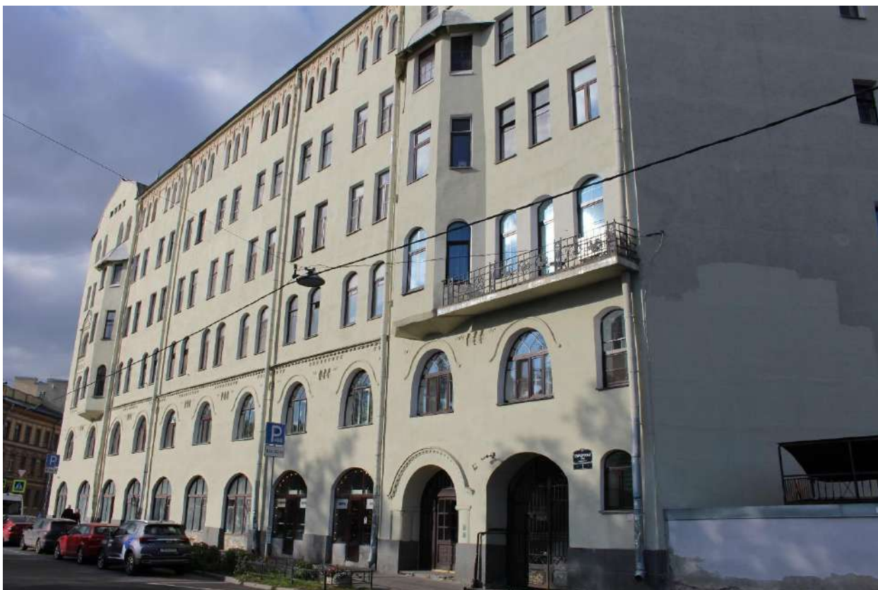
Фото 5. Вид на лицевой фасад объекта культурного наследия регионального значения «Дом П.М. Станового» по Старорусской улице.
