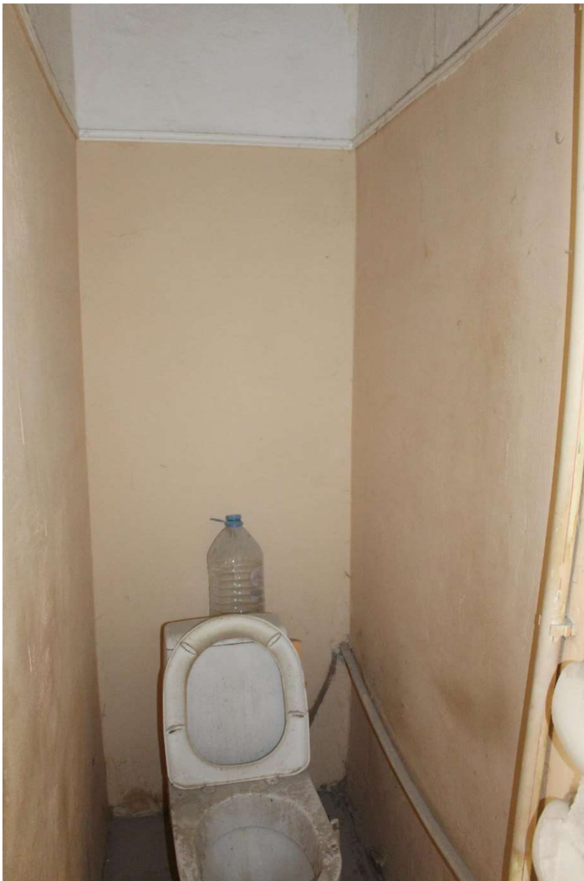
Фото 32. Объект культурного наследия регионального значения «Дом П.М. Станового». Квартира № 20, ч.п. 3.
