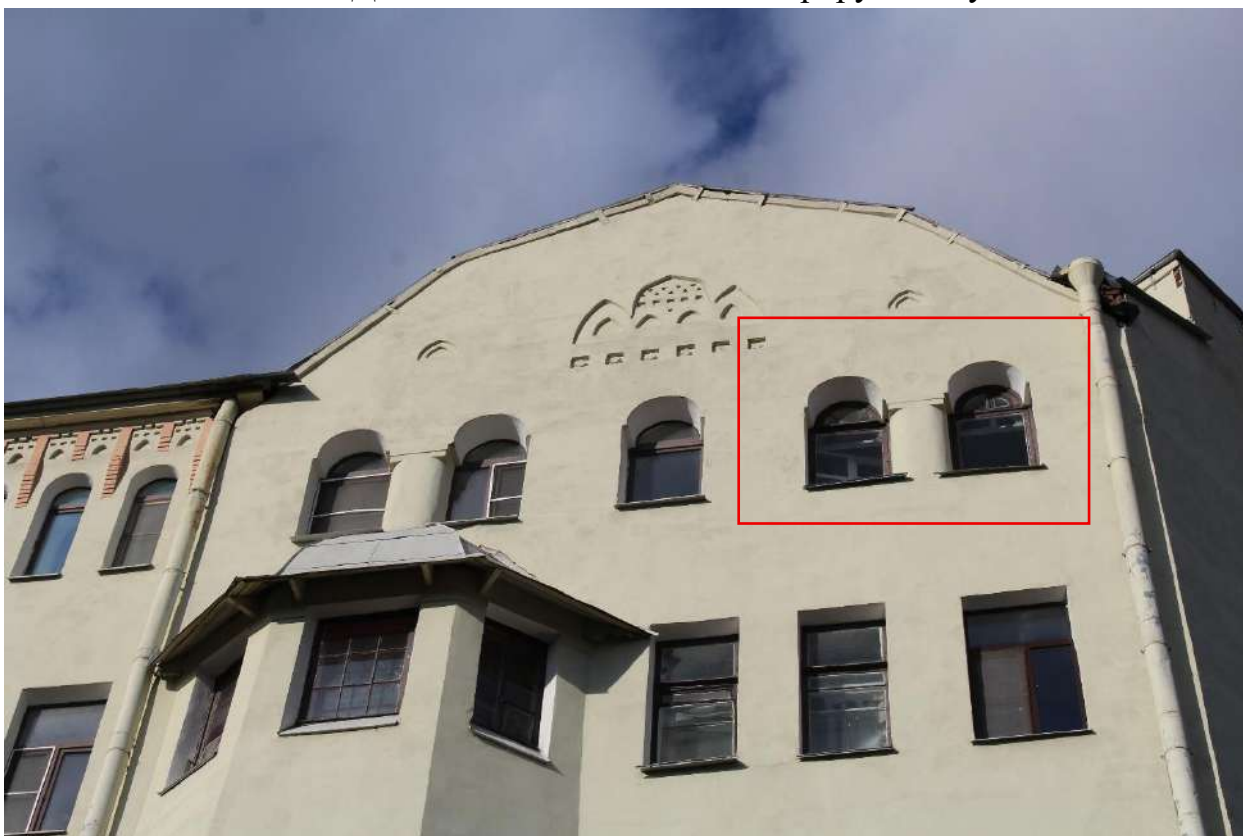
Фото 6. Вид на лицевой фасад объекта культурного наследия регионального значения «Дом П.М. Станового» по Старорусской улице. Красным отмечены оконные проемы квартиры № 20.
