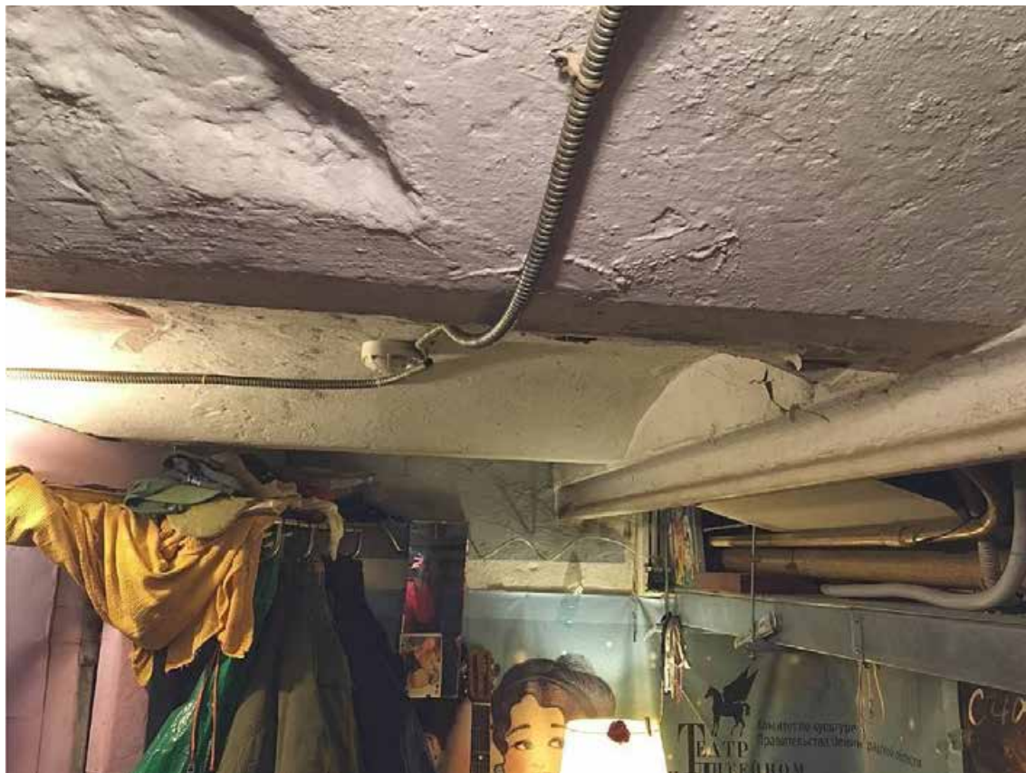
39. Подвал 15-Н. Пом. 4. Общий вид.
