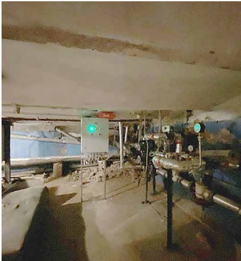
44. Подвал 15-Н. Пом. 5. Общий вид.
