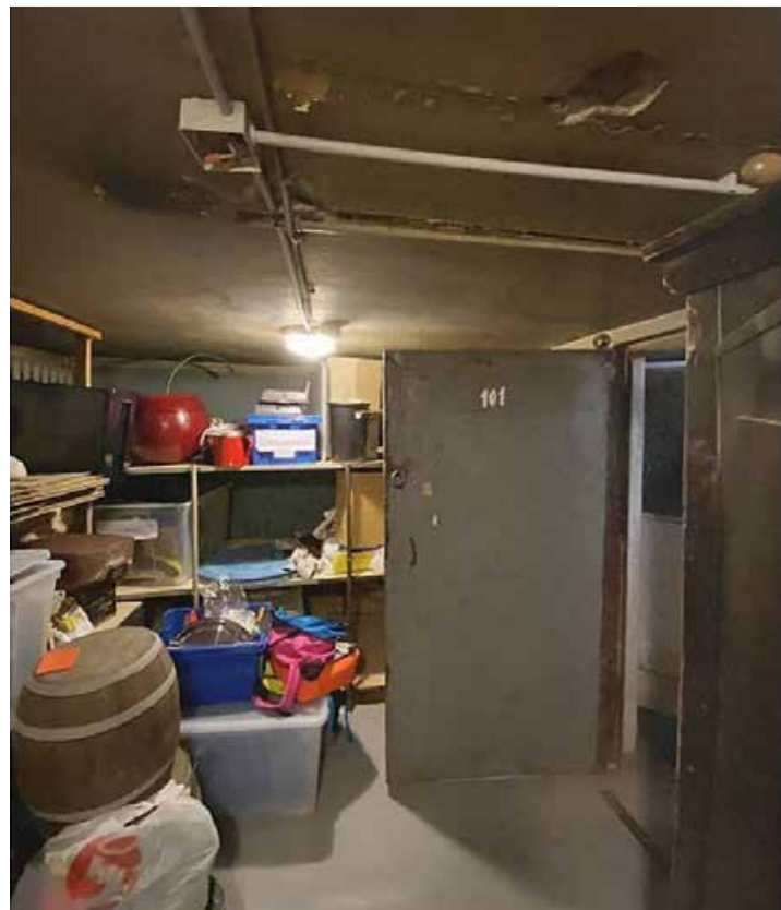
50. Подвал 12-Н. Пом. 8. Общий вид.
