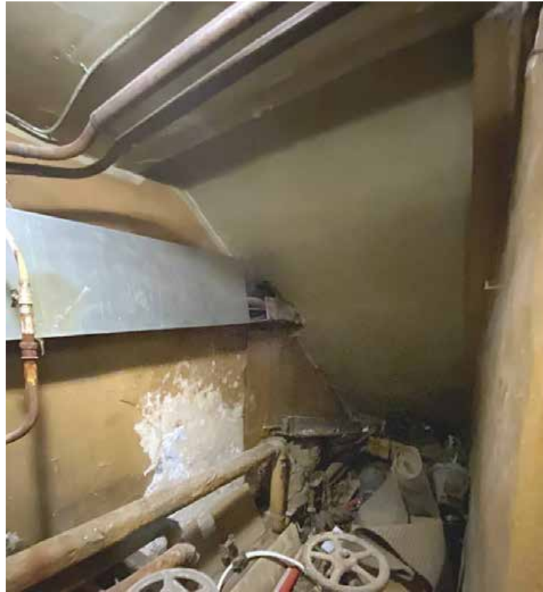
45. Подвал 12-Н. Пом. 2. Общий вид.
