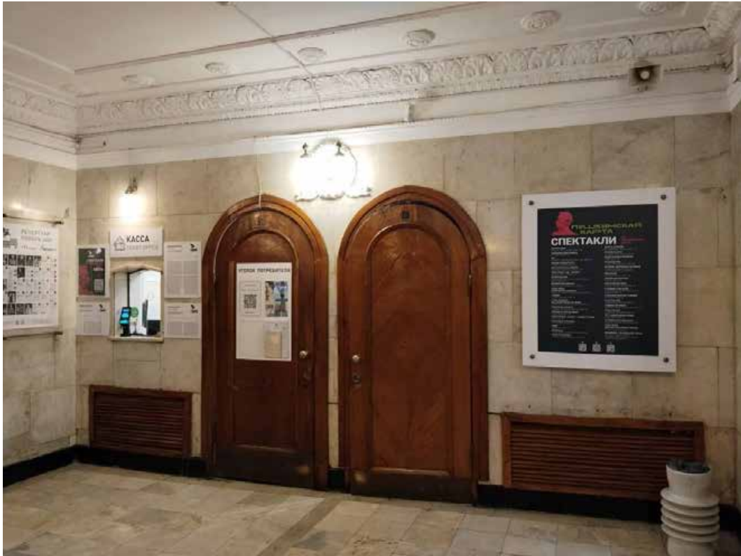
103. 12-Н. Входная зона вестибюля. Пом. 49. Общий вид.
