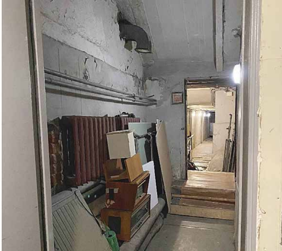
41. Подвал 12-Н. Пом. 4. Общий вид.
