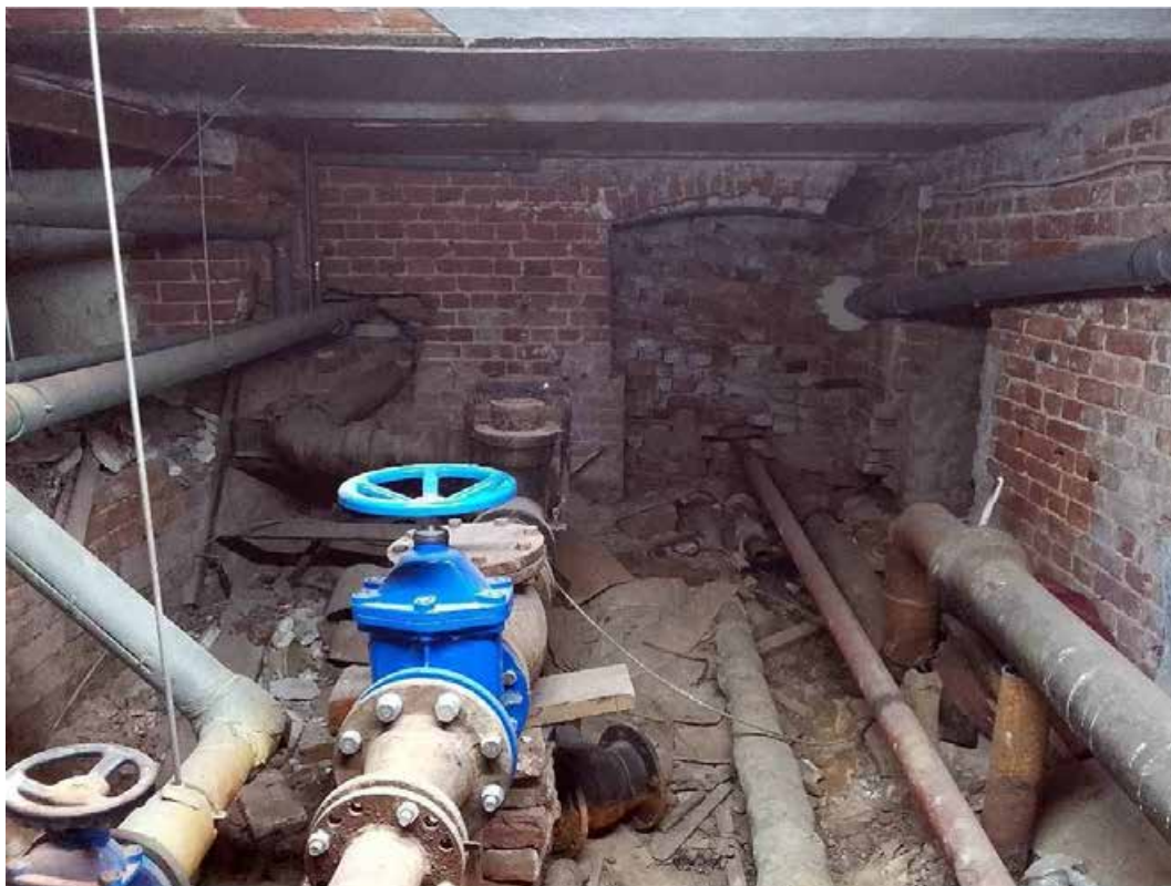
29. Подвал 37-Н. Пом. 2. Общий вид.
