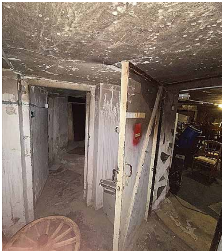
62. Подвал 12-Н. Пом. 10. Общий вид.
