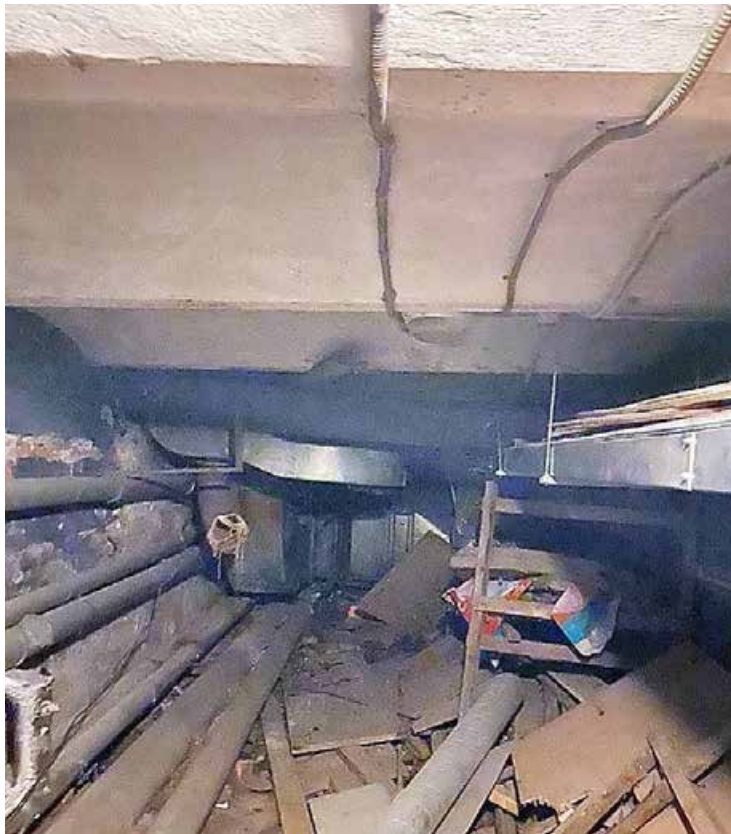
35. Подвал 15-Н. Пом. 2. Общий вид.
