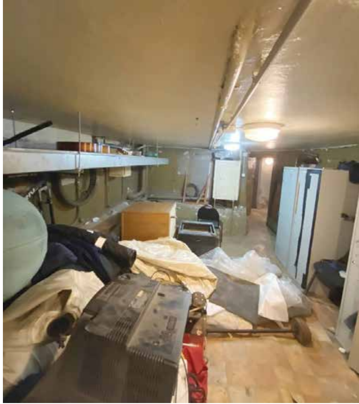
55. Подвал 12-Н. Пом. 15. Общий вид.
