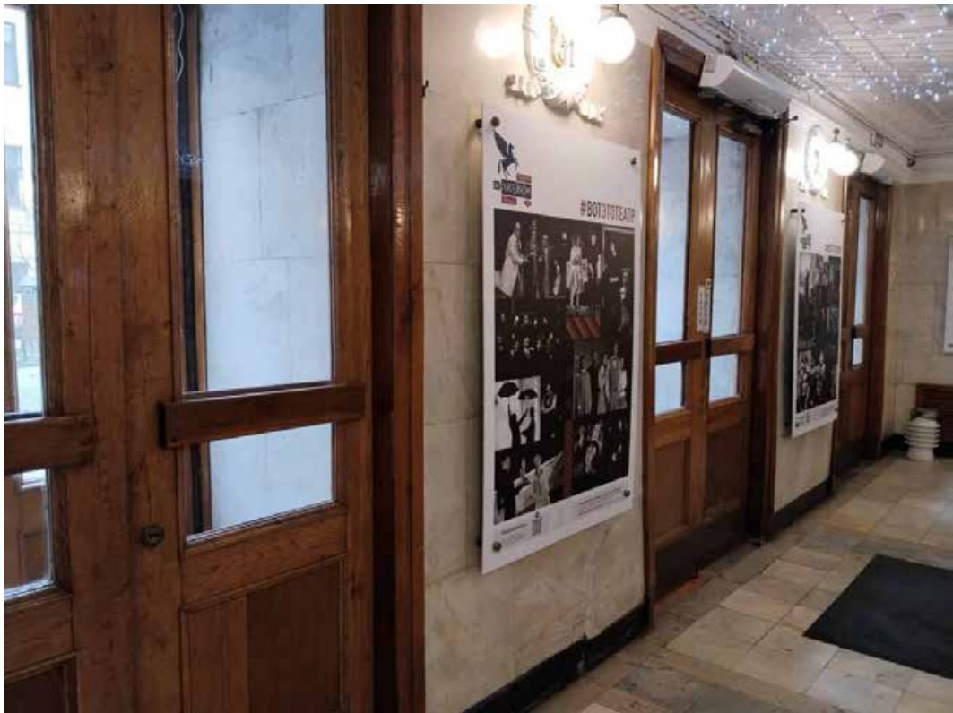
106. Входная зона вестибюля. Пом. 49. Вид на дверные заполнения.
