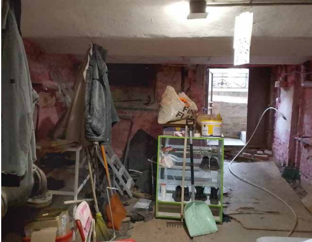
63. Подвал 19-Н. Пом. 1. Общий вид.
