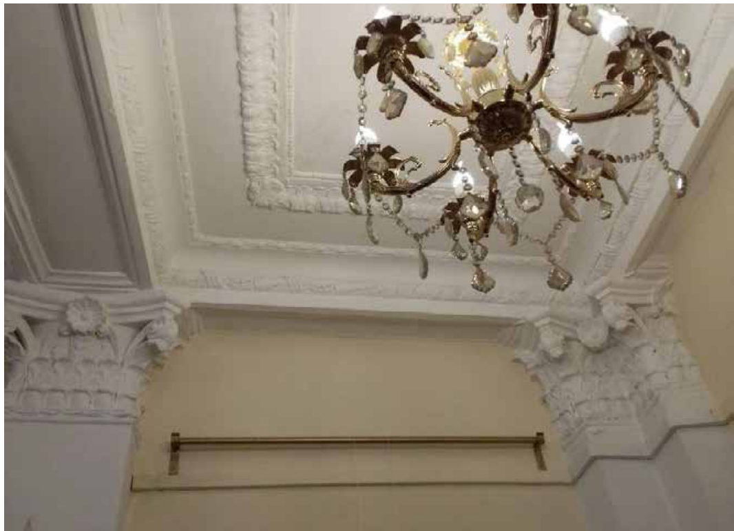
88. 12-Н. Пом. 28. Фрагмент лепного декора стен и потолка.
