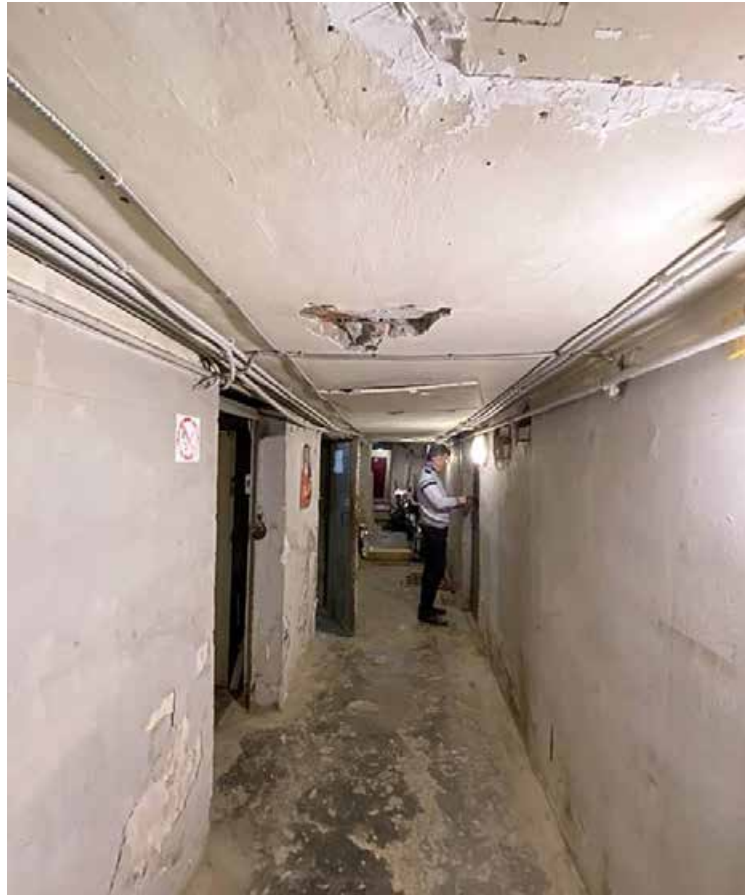
49. Подвал 12-Н. Пом. 5. Общий вид.
