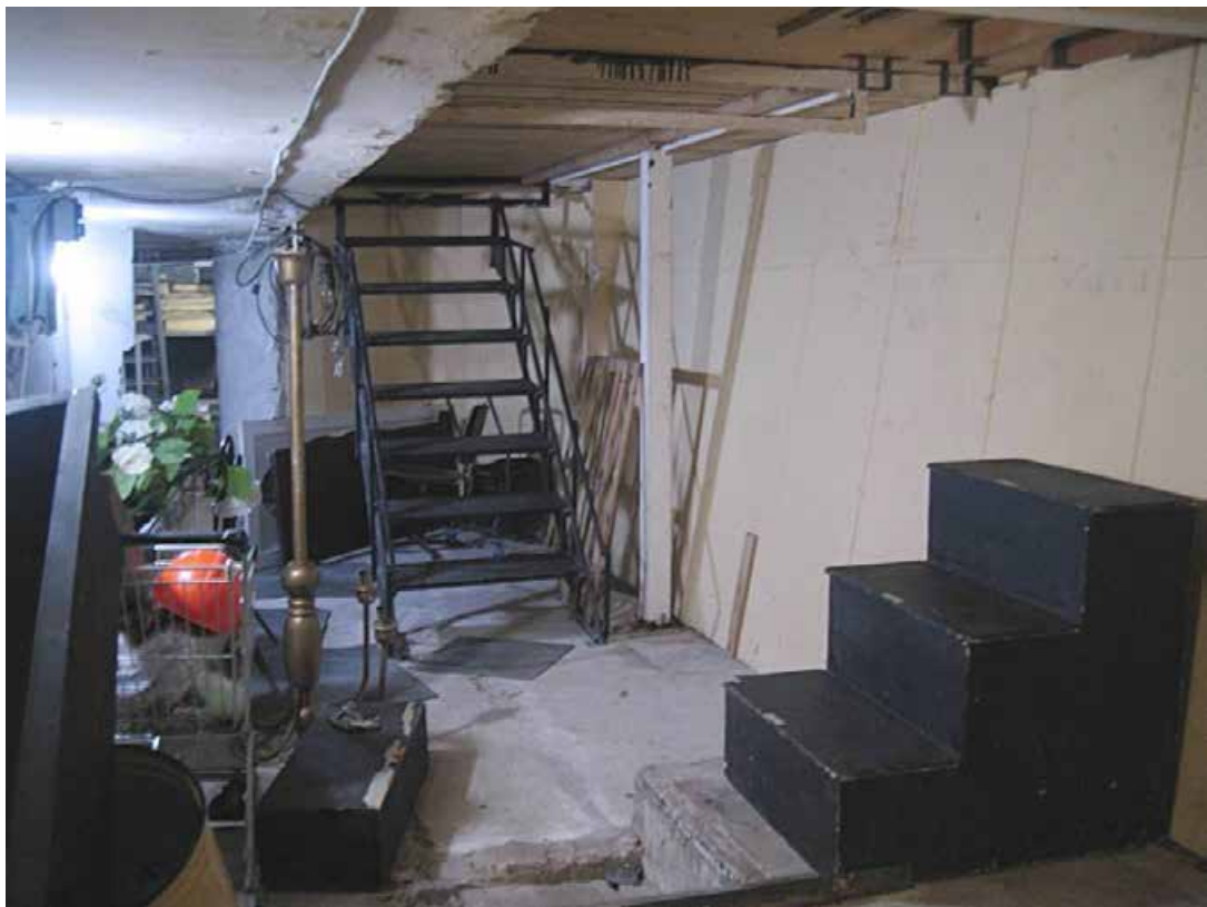
58. Подвал 12-Н. Пом. 14. Общий вид.
