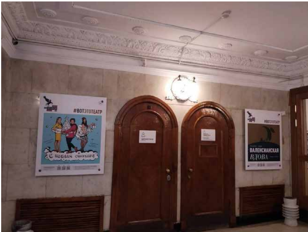
104. 12-Н. Входная зона вестибюля. Пом. 49. Общий вид.
