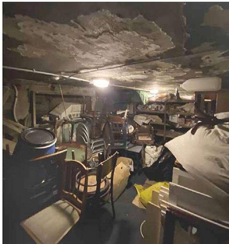
56. Подвал 12-Н. Пом. 13. Общий вид.
