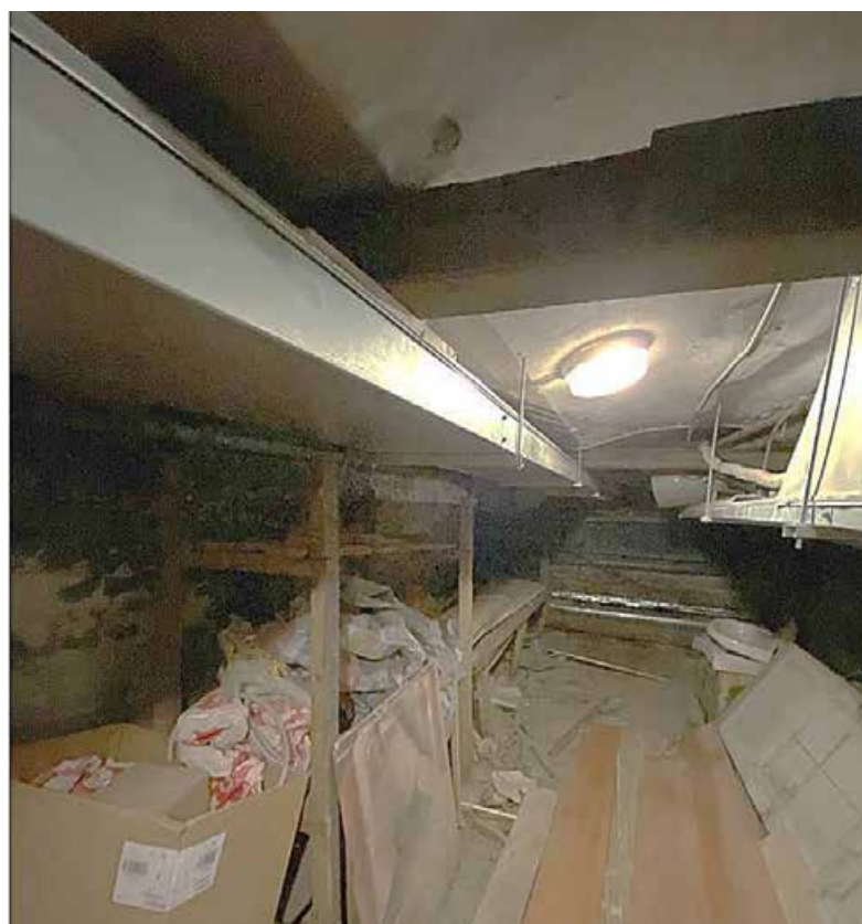
36 Подвал 15-Н. Пом. 2. Общий вид.
