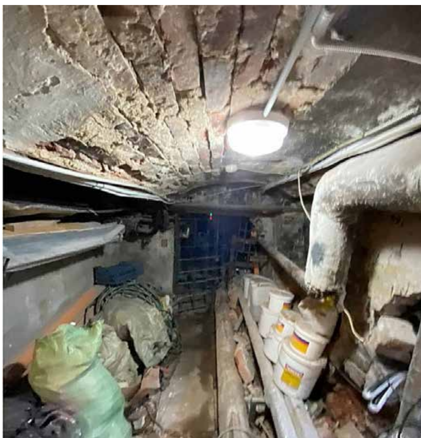
40. Подвал 15-Н. Пом. 1. Общий вид.
