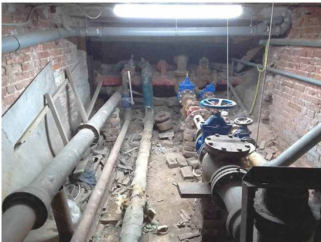
30. Подвал 37-Н. Пом. 2. Общий вид.
