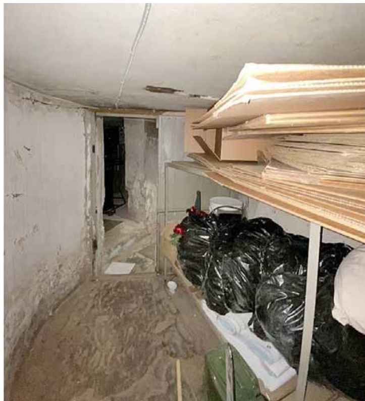
60. Подвал 12-Н. Пом. 11. Общий вид.
