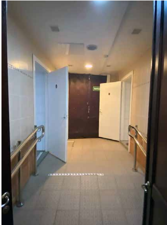
95. 12-Н. Пом. 40. Вид на служебный выход.
