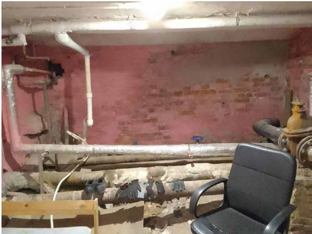
64. Подвал 19-Н. Пом. 1. Общий вид.
