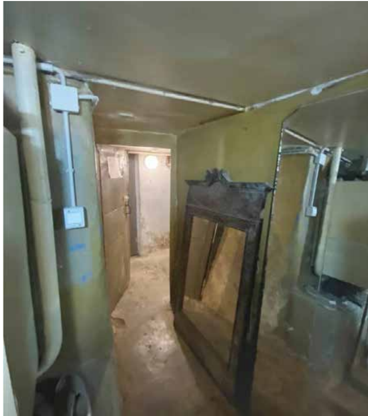
53. Подвал 12-Н. Пом. 15. Общий вид.
