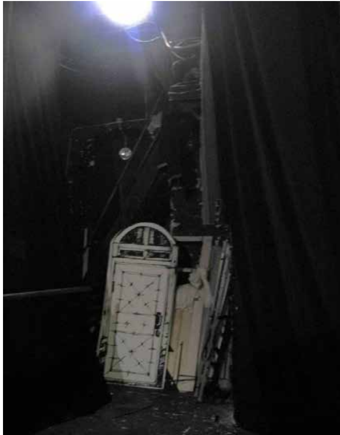
75. 12-Н. Пом. 18. Вид на нишу заложеного бокового входа южного корпуса.
