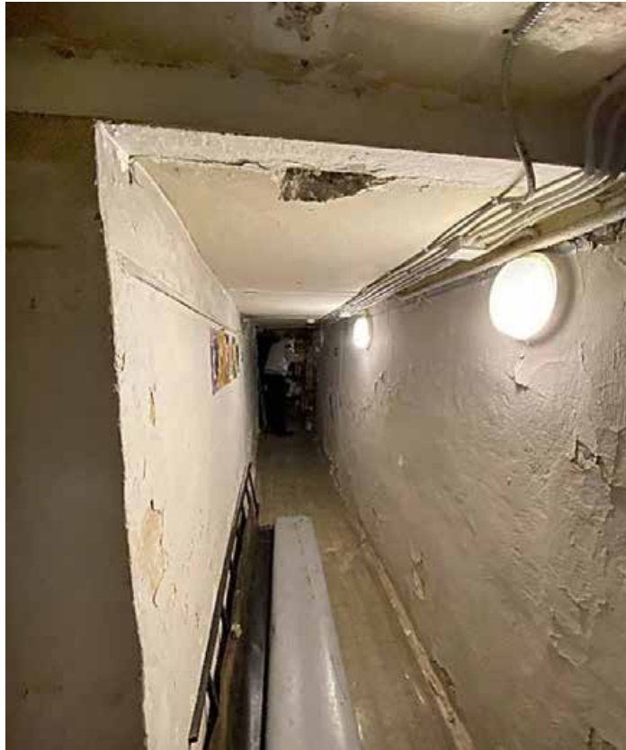
59. Подвал 12-Н. Пом. 14. Общий вид.
