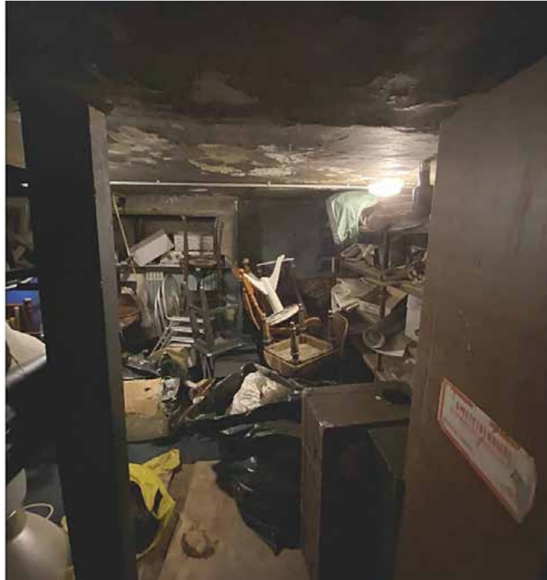
57. Подвал 12-Н. Пом. 13. Общий вид.
