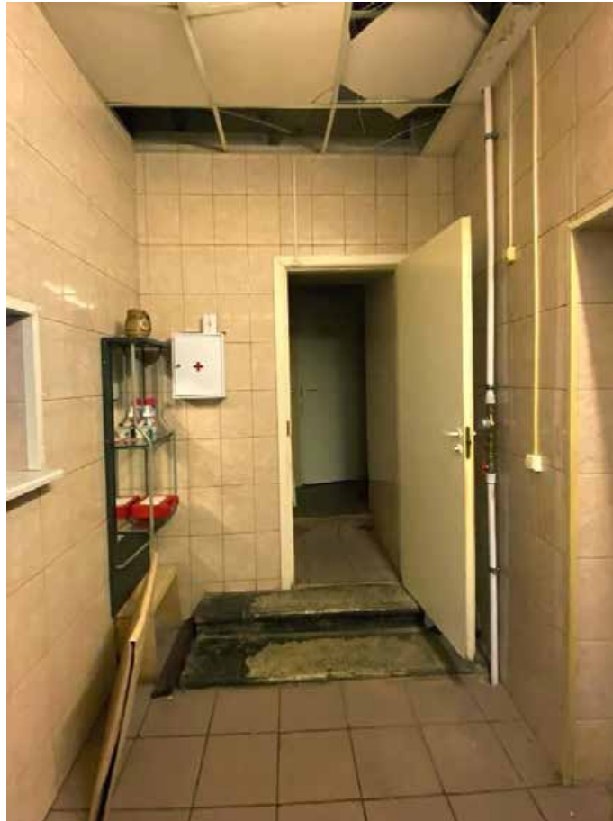
91.1. 12-Н. Пом. 29. Вид на служебный выход.
