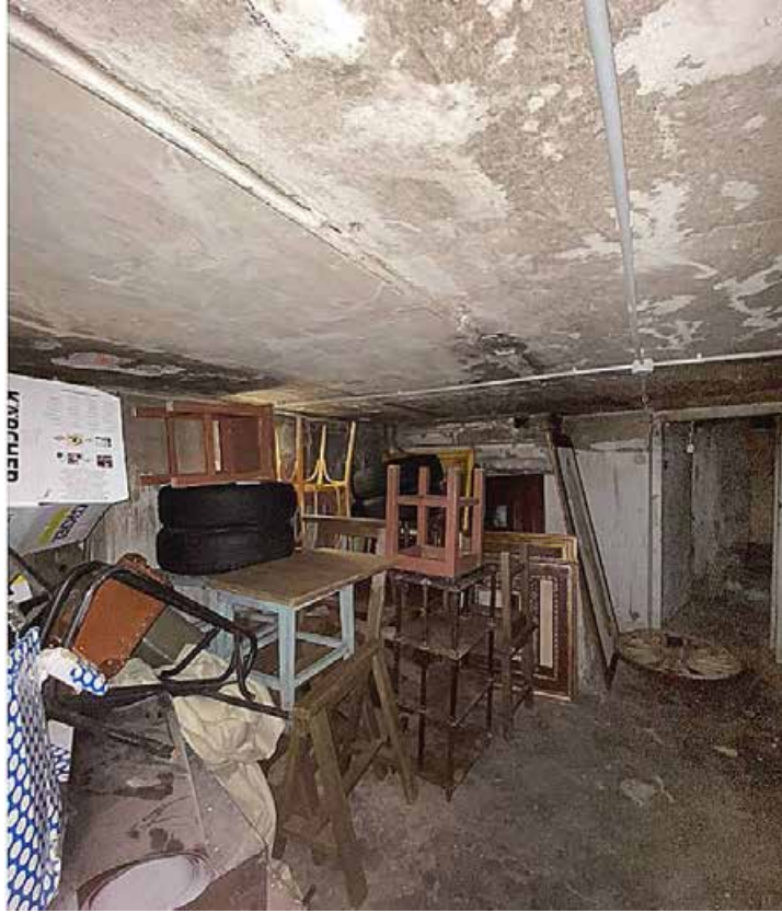
61. Подвал 12-Н. Пом. 10. Общий вид.
