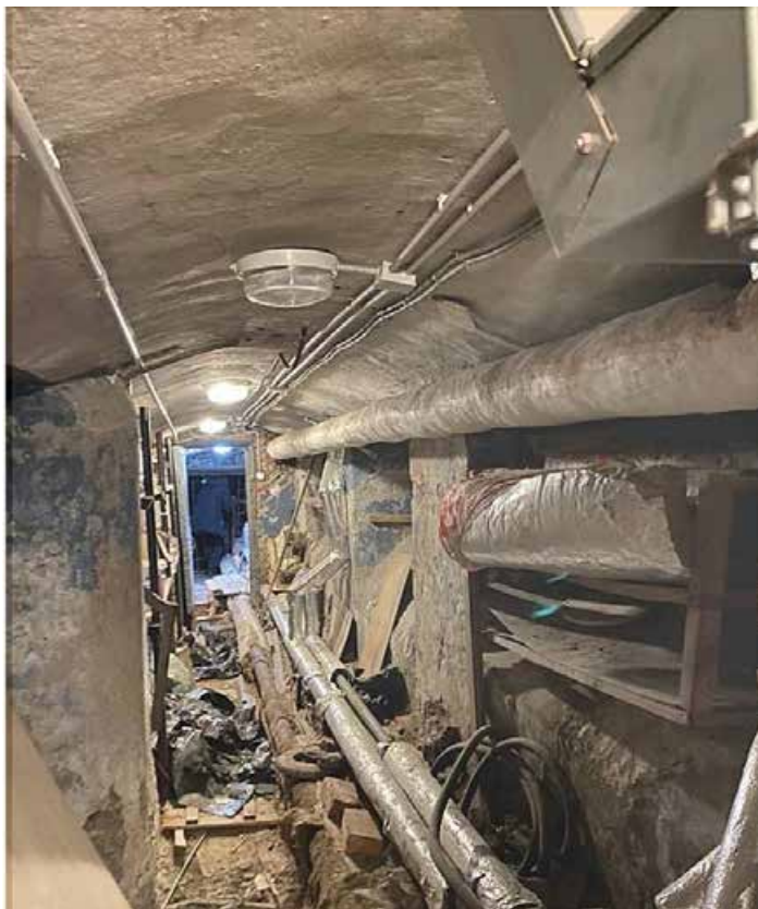
37. Подвал 15-Н. Пом. 2. Общий вид.
