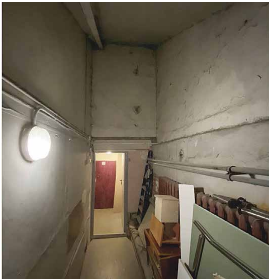
42. Подвал 12-Н. Пом. 4. Общий вид.
