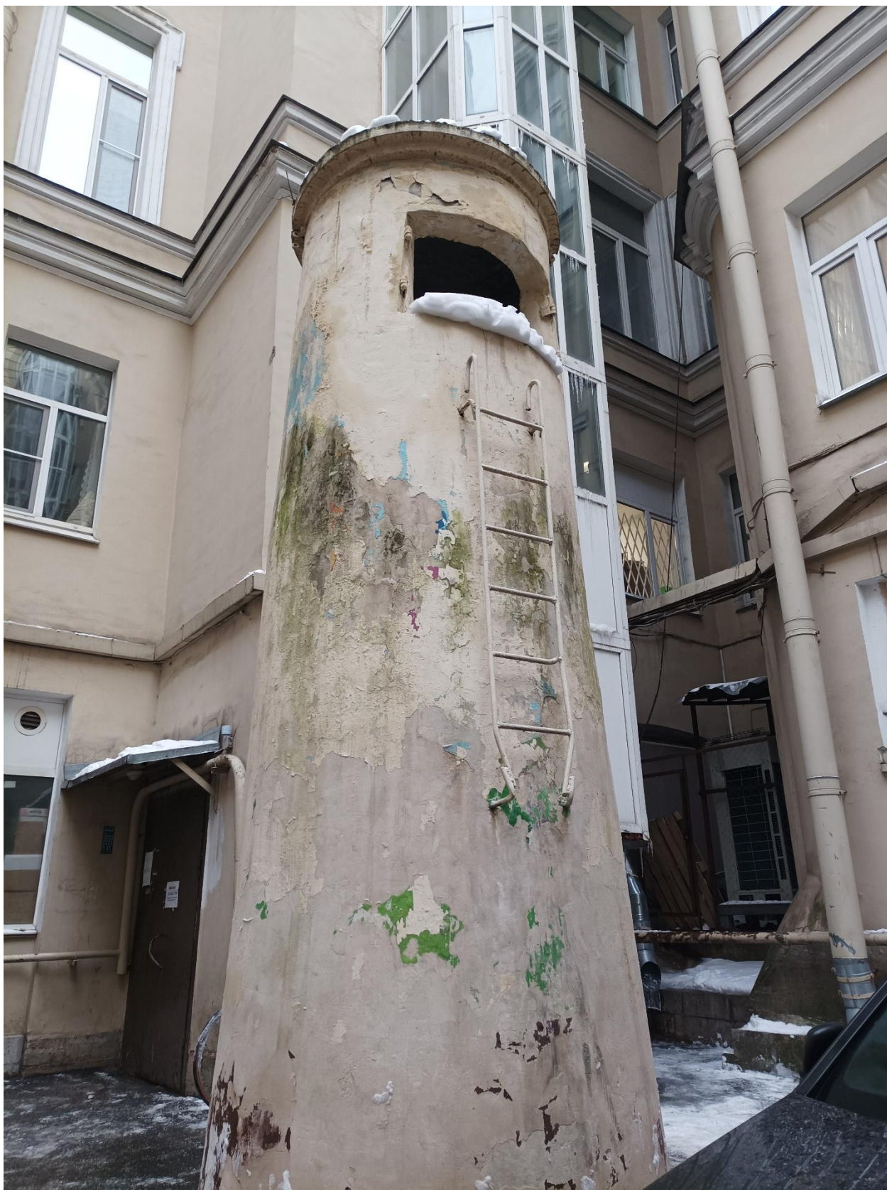
Фото 6. Вид на дворовый фасад объекта культурного наследия регионального значения «Дом Е.С. Егорова».
