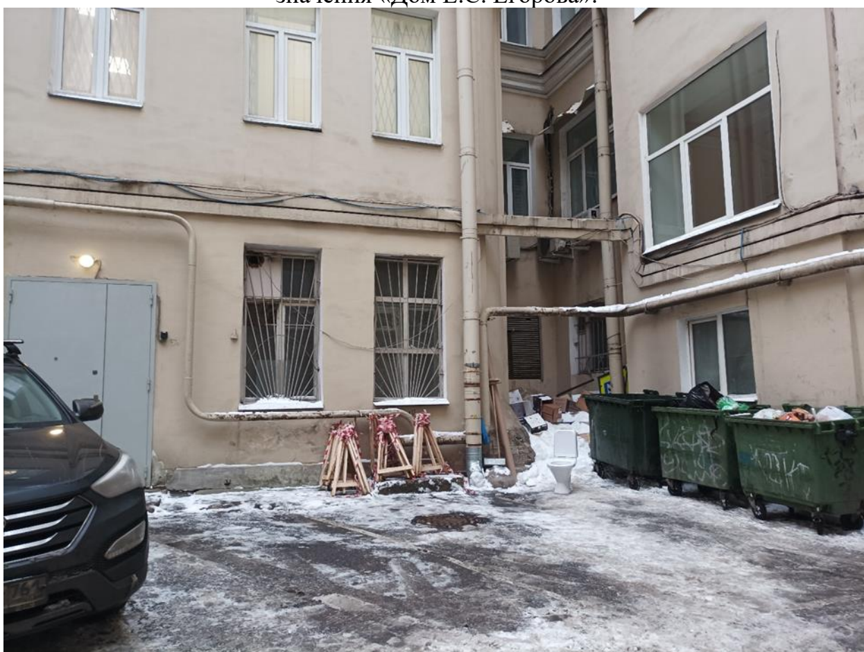
Фото 16. Вид на дворовый фасад объекта культурного наследия регионального значения «Дом Е.С. Егорова»
