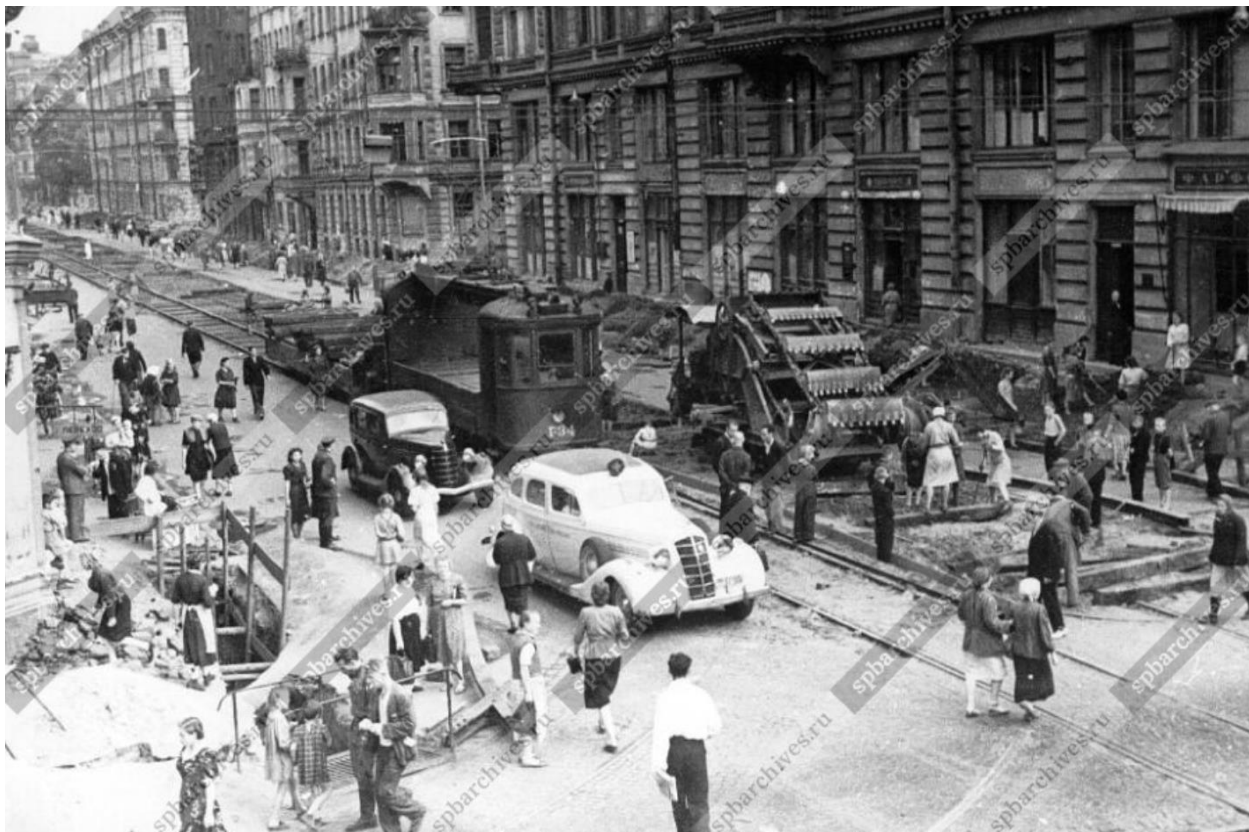
Илл. 32. Ремонт дорожного покрытия на улице Восстания. 1948-1950 гг. (источник: ЦГАКФФД СПб. Фотодокументы. Описание 1АР-150. Ед.хр.202953).
