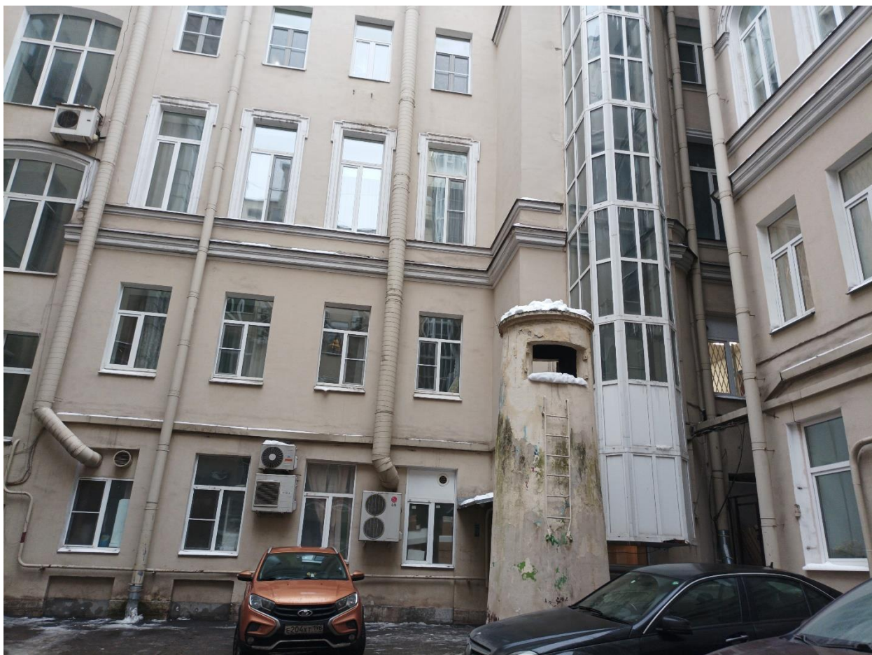
Фото 5. Вид на дворовый фасад объекта культурного наследия регионального значения «Дом Е.С. Егорова».
