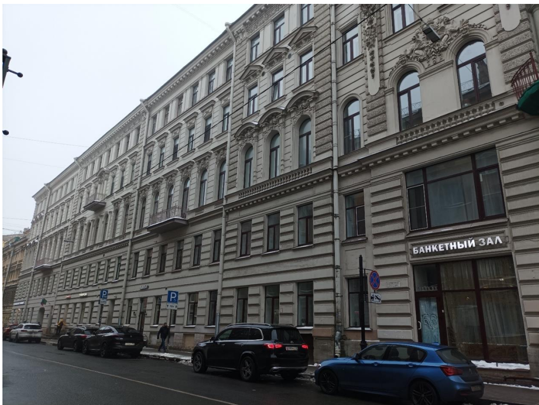
Фото 11. Вид на лицевой фасад объекта культурного наследия регионального значения «Дом Е.С. Егорова» по Баскову переулку.
