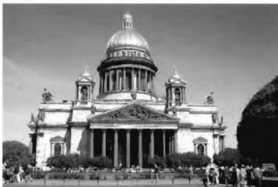
1. Общий вид на объект культурного наследия. Фото от 23.06.2022.
