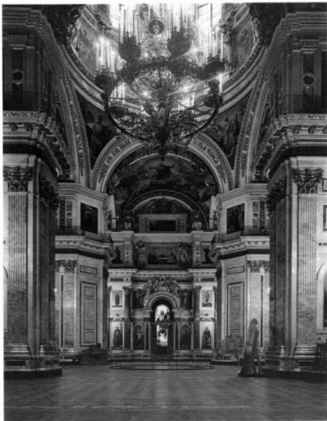
42. Центральный неф. Фото 1960-х гг. После реставрации. /Восстановление памятников архитектуры Ленинграда. - Л., 1989. С.426
