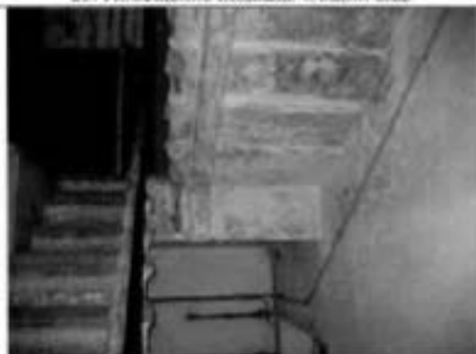
27. Лестница в западной части здания. Общий вид.
