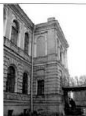
8. Северный фасад. Фрагмент.
