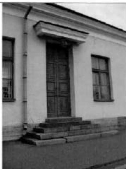
7. Дверное заполнение. Южный фасад.
