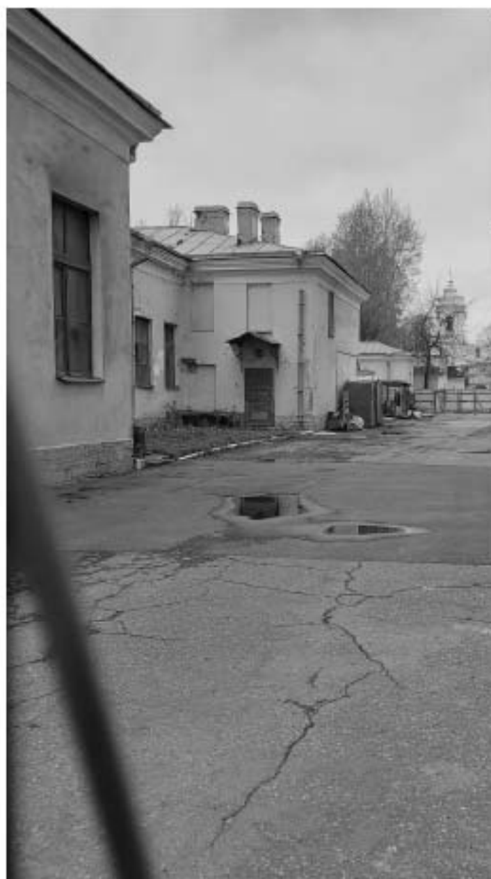
Фото 3. Вид дворового фасада.
