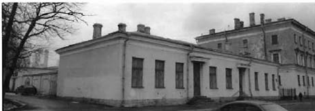
1. Объект культурного наследия. Общий вид с юго-запада.
