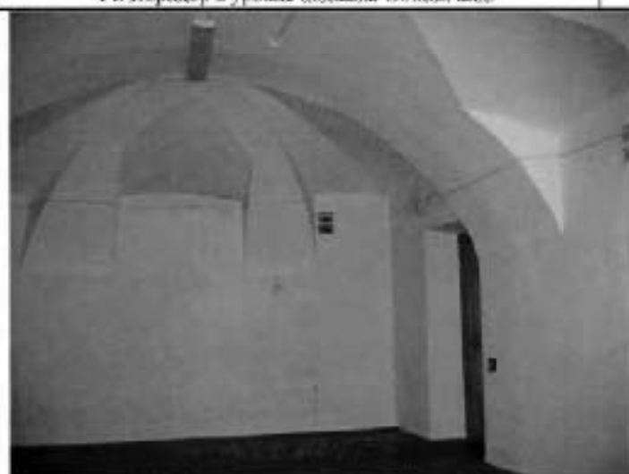
16. Помещение 1-го этажа. Общий вид.
