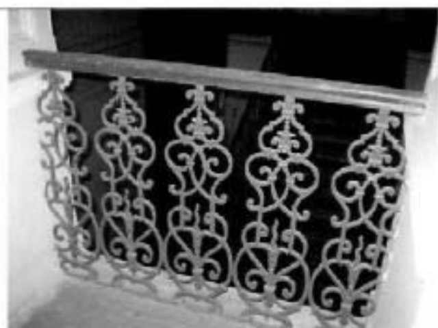
16. Ограждение лестница северной части здания. Фрагмент.
