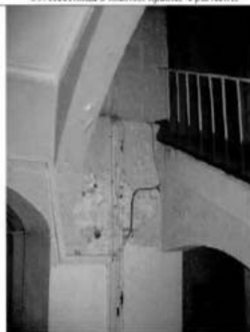
41. Лестница в южном крыле. Фрагмент.
