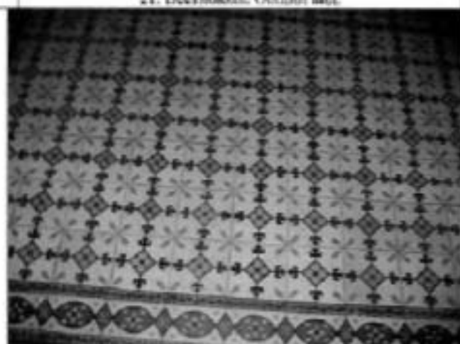
23. Покрытие пола вестибюля. Фрагмент.
