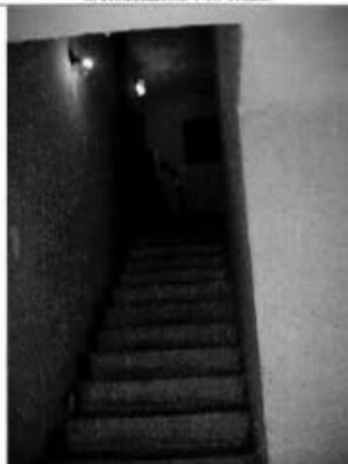
10. Лестница. Общий вид.
