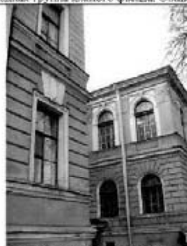
4. Восточный фасад. Фрагмент.
