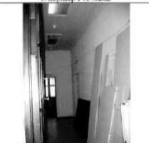
11. Коридор 1-го этажа. Общий вид.
