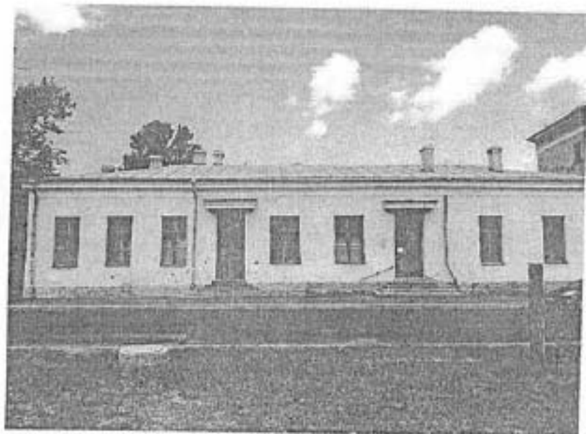
Фасад со стороны наб. Обводного канала
