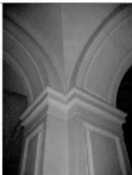
17. Помещение 2-го этажа. Фрагмент.
