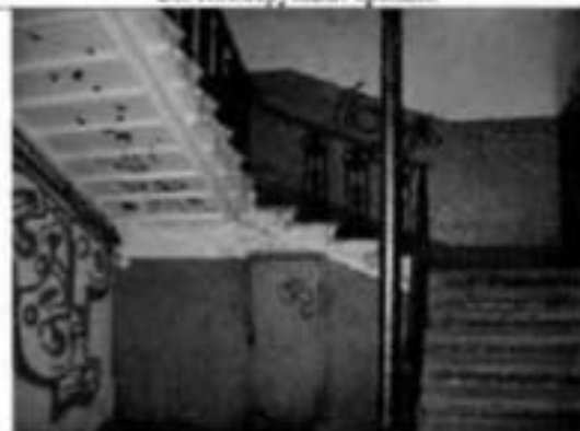
28. Лестница в восточной части здания. Общий вид.
