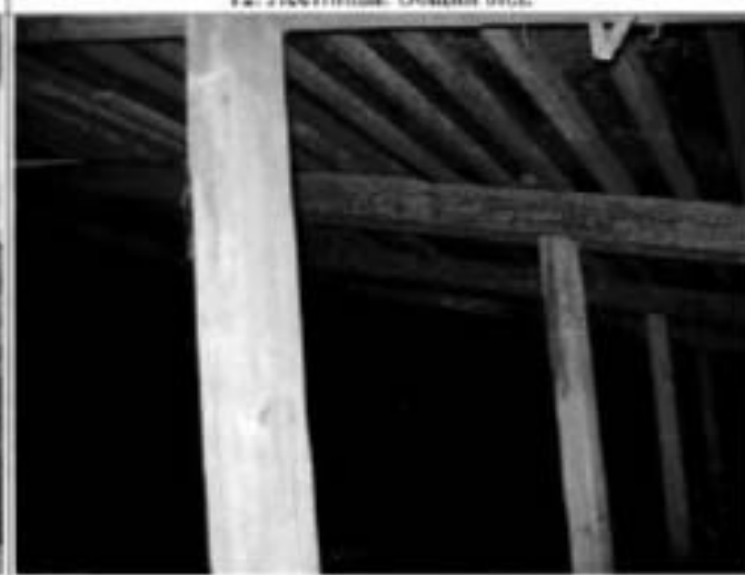
14. Конструкция крыши. Общий вид.
