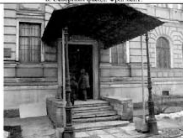
10. Входная группа северного фасада. Общий вид.
