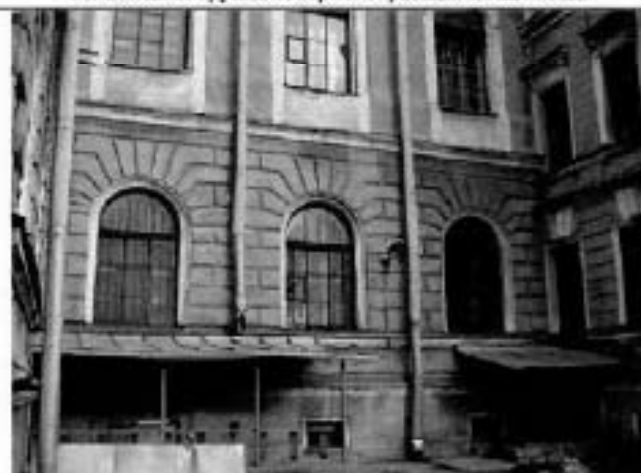
12. Западный фасад. Фрагмент.
