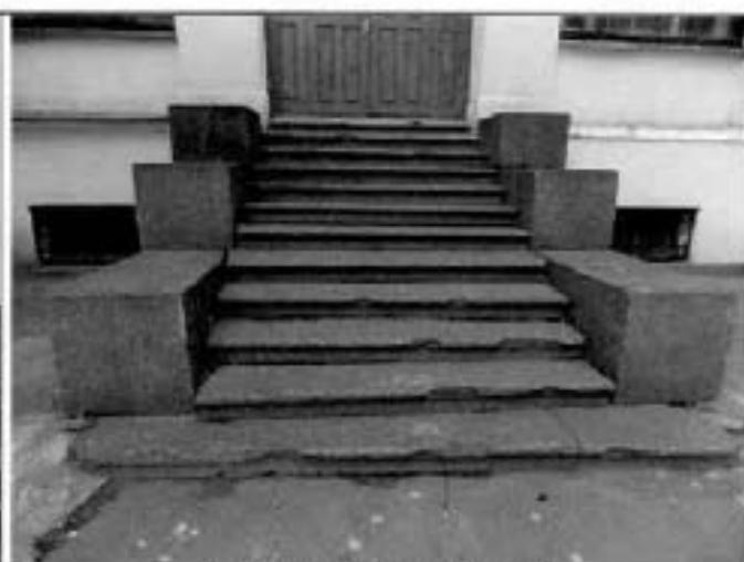
13. Дворовые фасады. Крыльца.
