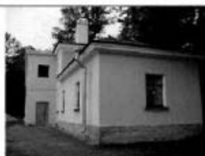
2. Южный фасад. Фрагмент.
