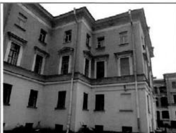
12. Дворовые фасады северного флигеля.
