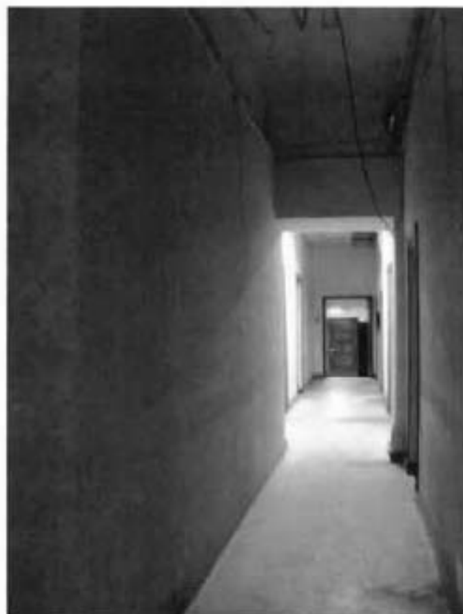
5. Первый этаж. Коридор (пом. 1-Н (13)).
