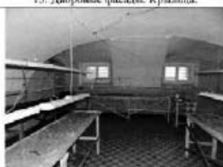
15. Помещение в уровне подвала. Общий вид.
