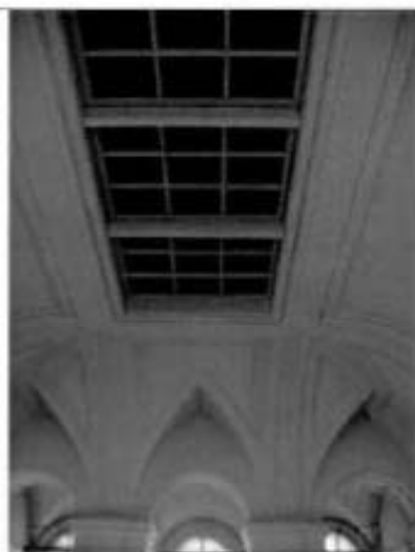
18. Помещение 2-го этажа. Общий вид.
