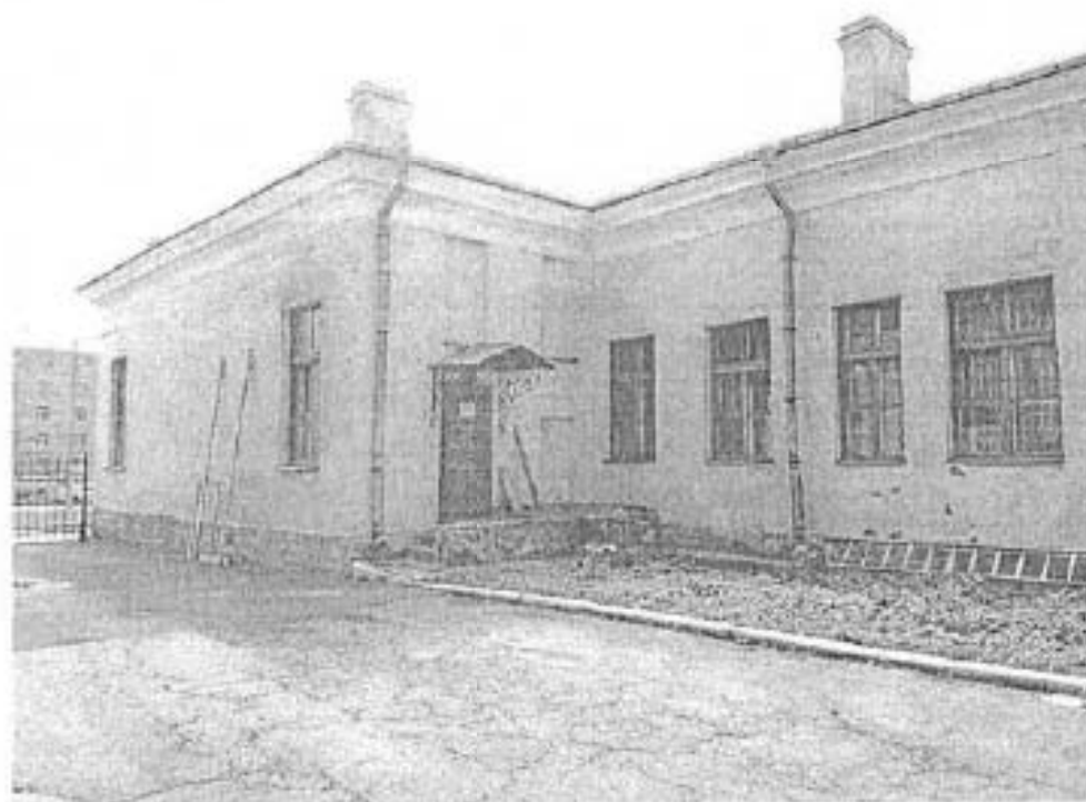
Восточный фасад здания
