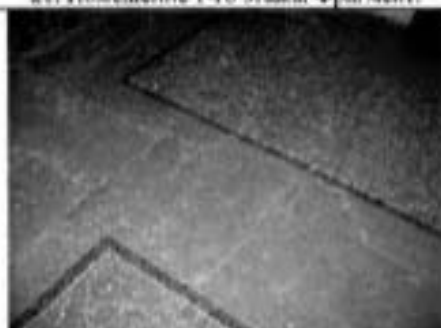
23. Напольное покрытие помещений. Фрагмент.
