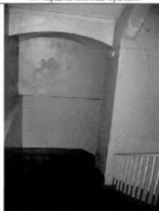
39. Лестница в южном крыле. Фрагмент.
