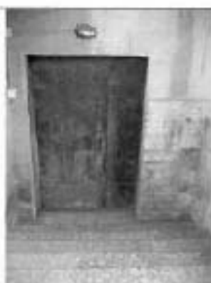
7. Входной проем восточного фасада. Общий вид.
