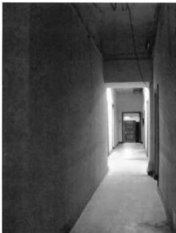
5. Первый этаж. Коридор (пом. 1-Н (13)).
