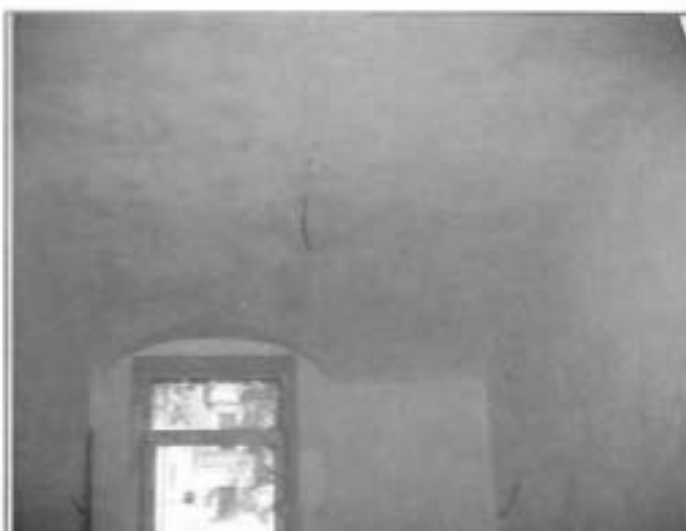
9. Перекритие помещений 1-го этажа.
