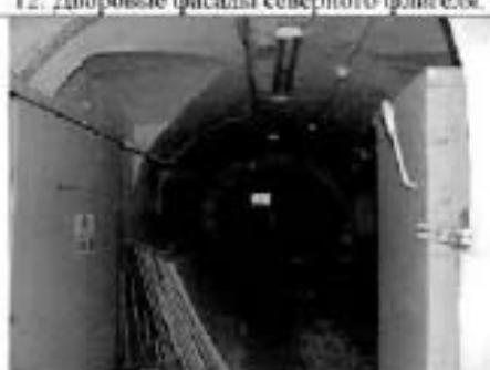
14. Коридор в уровне подвала. Общий вид.
