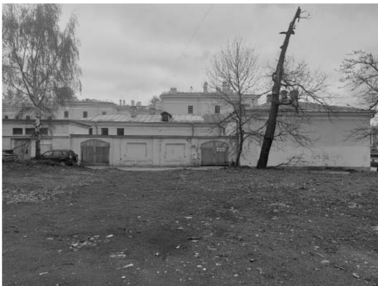
Фото 15. Западный фасад здания лазарета.
