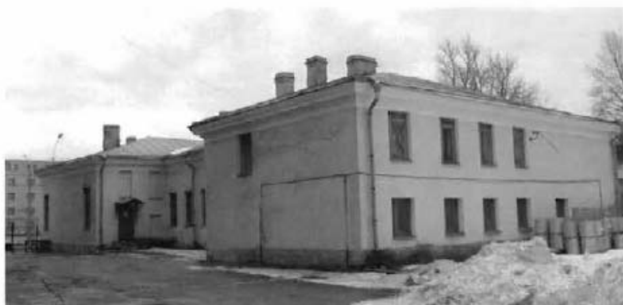
2. Общий вид с северо-востока. Дворовые фасады.
