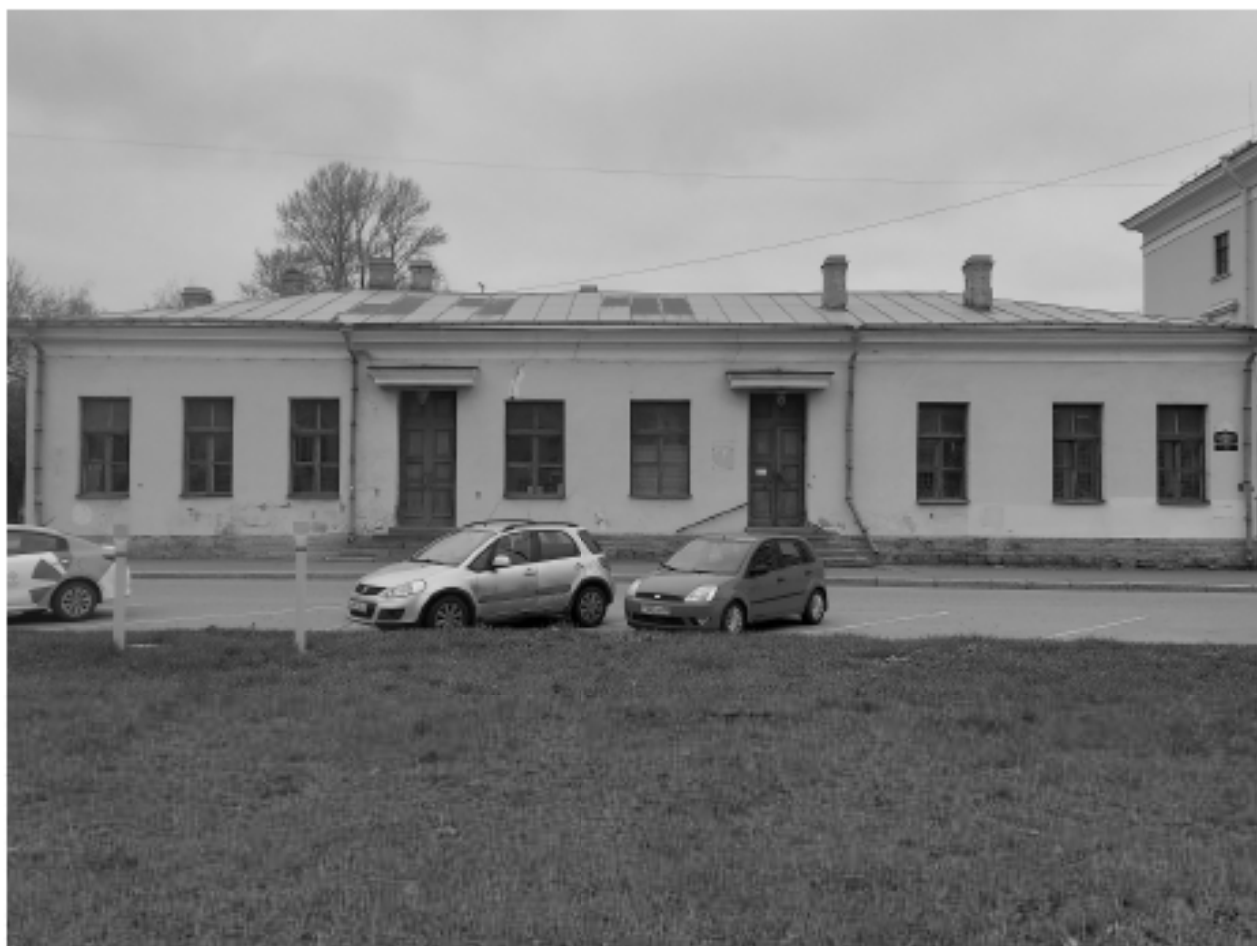
Фото 1. Главный фасад. Вид со стороны наб. Обводного канала.
