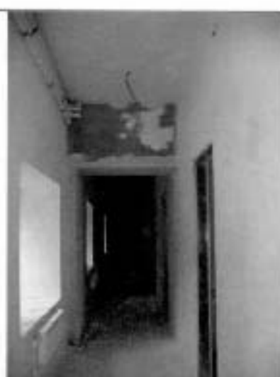
10. Коридор 2-го этажа. Общий вид.
