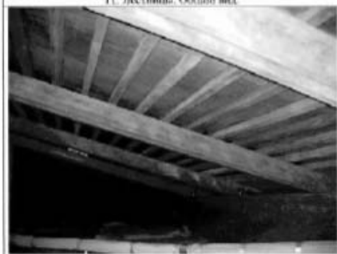
13. Конструкция крыши. Общий вид.
