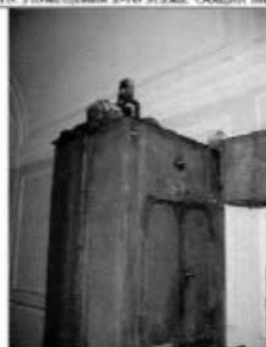
20. Лифтовая шахта. Фрагмент.
