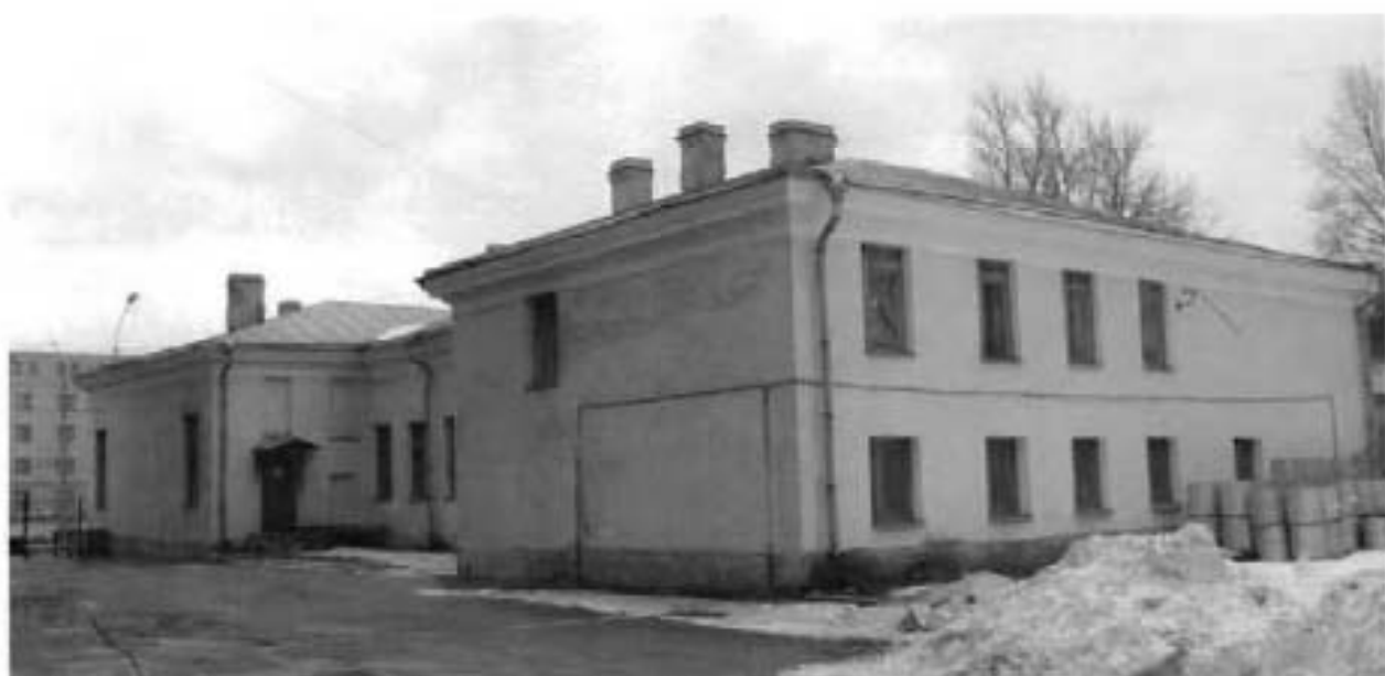
2. Общий вид с северо-востока. Дворовые фасады.
