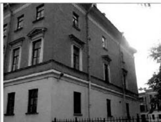
8. Западный торцевой фасад северного флигеля. Общий вид.
