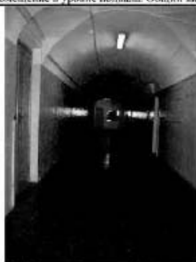
17. Коридор 1-го этажа. Общий вид.
