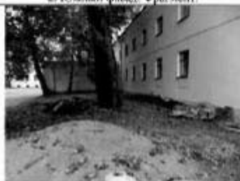
4. Восточный фасад. Фрагмент.
