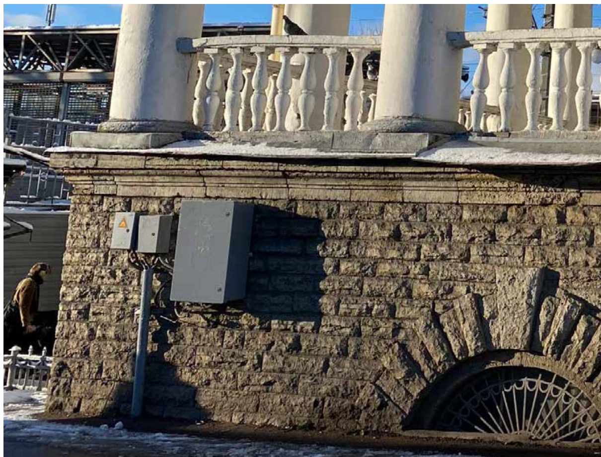
21. Выявленный объект культурного наследия «Вокзал станции Павловск» по адресу: Санкт-Петербург, город Павловск, Привокзальная площадь, дом 1, литера А. Междуэтажный профилированный карниз из тесаных камней известняка, облицовка цокольной части — плиты известняка грубого окола. Фрагмент юго-восточного фасада. Дата съемки: 15.11.2025
