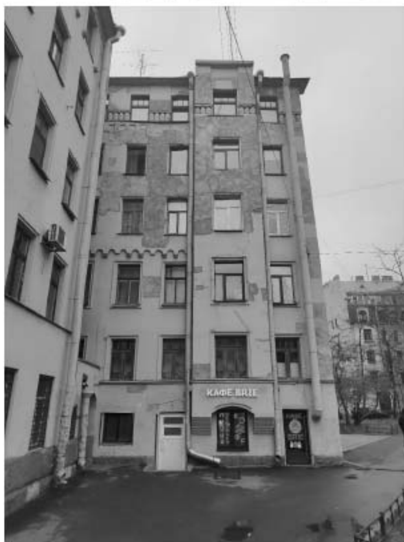
31. Вид на объект культурного наследия регионального значения «Дом А.Л. Лишневского, М.Л. Сагалова», расположенный по адресу: г. Санкт-Петербург, улица Всеволода Вишневского, дом 10, литера А, и зону производства работ. 01.11.2025 г.
