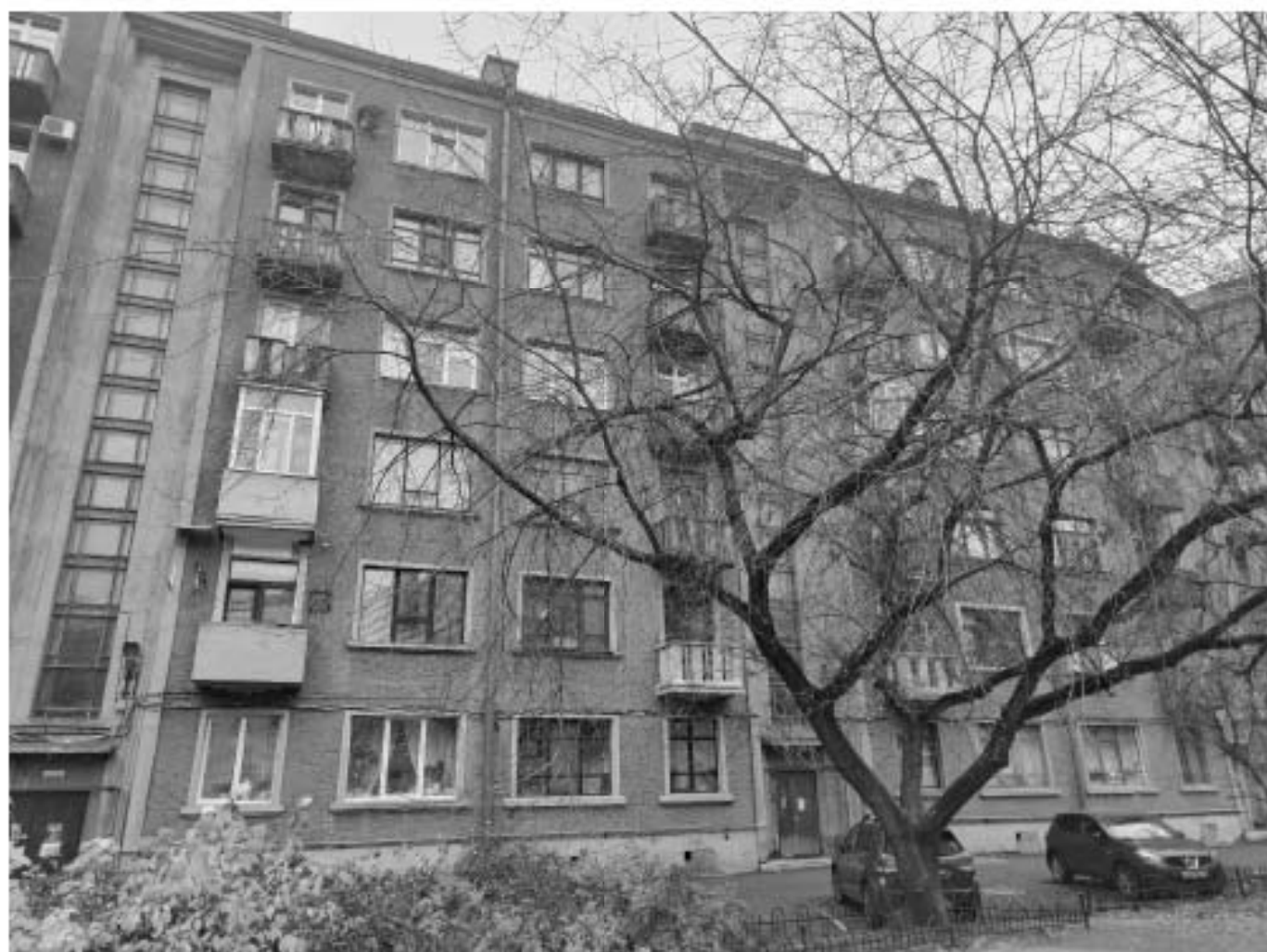
67. Вид на объект культурного наследия регионального значения «Жилой дом», входящий в состав объекта культурного наследия регионального значения «Жилой дом специалистов «Свирьстрой», расположенный по адресу: г. Санкт-Петербург, Малый проспект П.С., дом 84-86, литера А, и зону производства работ. 01.11.2025 г.
