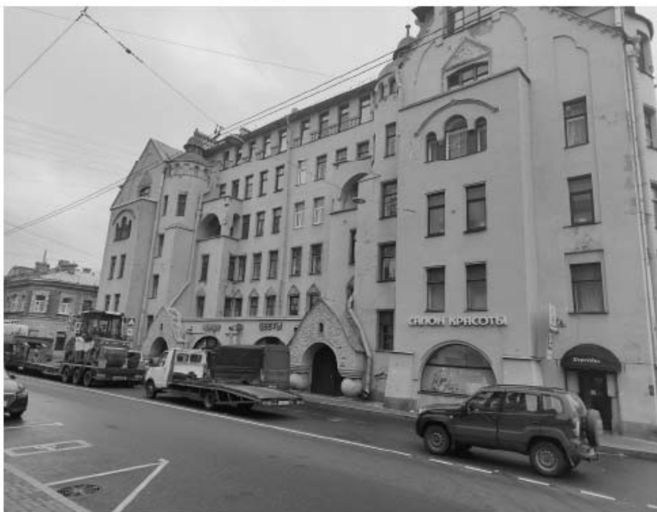
23. Вид на объект культурного наследия регионального значения «Дом А.Л. Лишневского, М.Л. Сагалова», расположенный по адресу: г. Санкт-Петербург, улица Всеволода Вишневского, дом 10, литера А, и зону производства работ. 01.11.2025 г.
