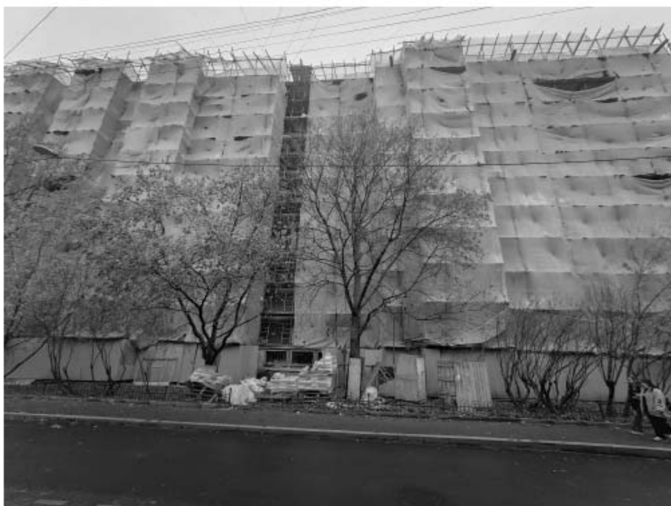
60. Вид на объект культурного наследия регионального значения «Жилой дом», входящий в состав объекта культурного наследия регионального значения «Жилой дом специалистов «Свирьстрой», расположенный по адресу: г. Санкт-Петербург, Малый проспект П.С., дом 84-86, литера А, и зону производства работ. 01.11.2025 г.
