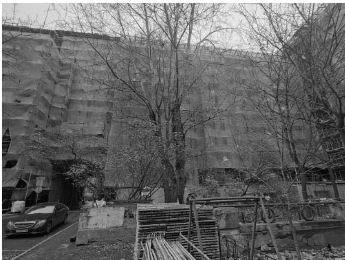
55. Вид на объект культурного наследия регионального значения «Жилой дом», входящий в состав объекта культурного наследия регионального значения «Жилой дом специалистов «Свирьстрой», расположенный по адресу: г. Санкт-Петербург, Малый проспект П.С., дом 84-86, литера А, и зону производства работ. 01.11.2025 г.
