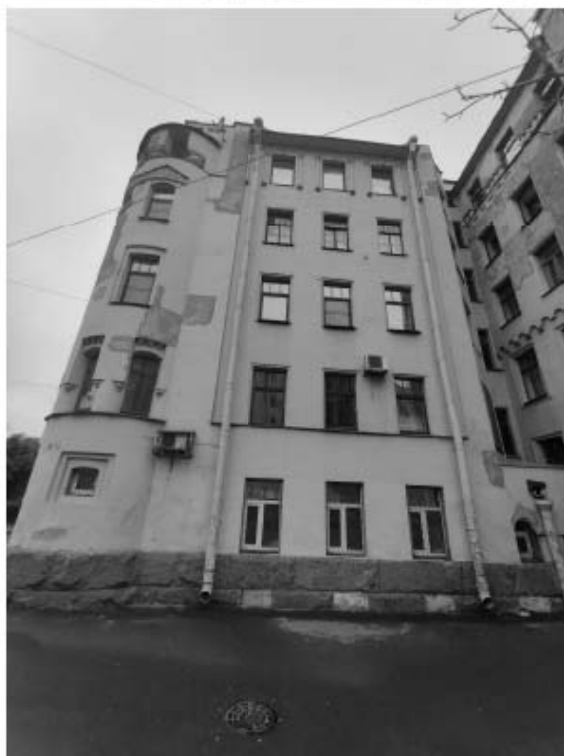
32. Вид на объект культурного наследия регионального значения «Дом А.Л. Липневского, М.Л. Сагалова», расположенный по адресу: г. Санкт-Петербург, улица Всеволода Вишневского, дом 10, литера А, и зону производства работ. 01.11.2025 г.
