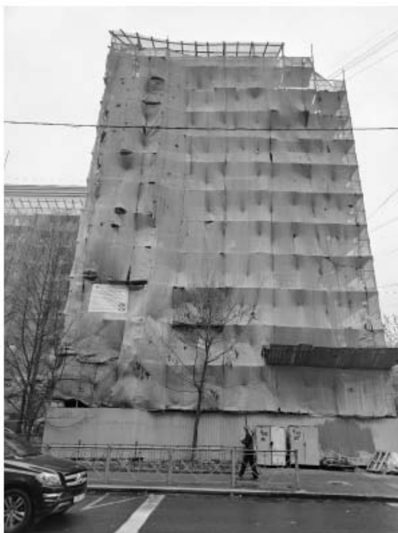
53. Вид на объект культурного наследия регионального значения «Жилой дом», входящий в состав объекта культурного наследия регионального значения «Жилой дом специалистов «Свирьстрой», расположенный по адресу: г. Санкт-Петербург, Малый проспект П.С., дом 84-86, литера А, и зону производства работ. 01.11.2025 г.
