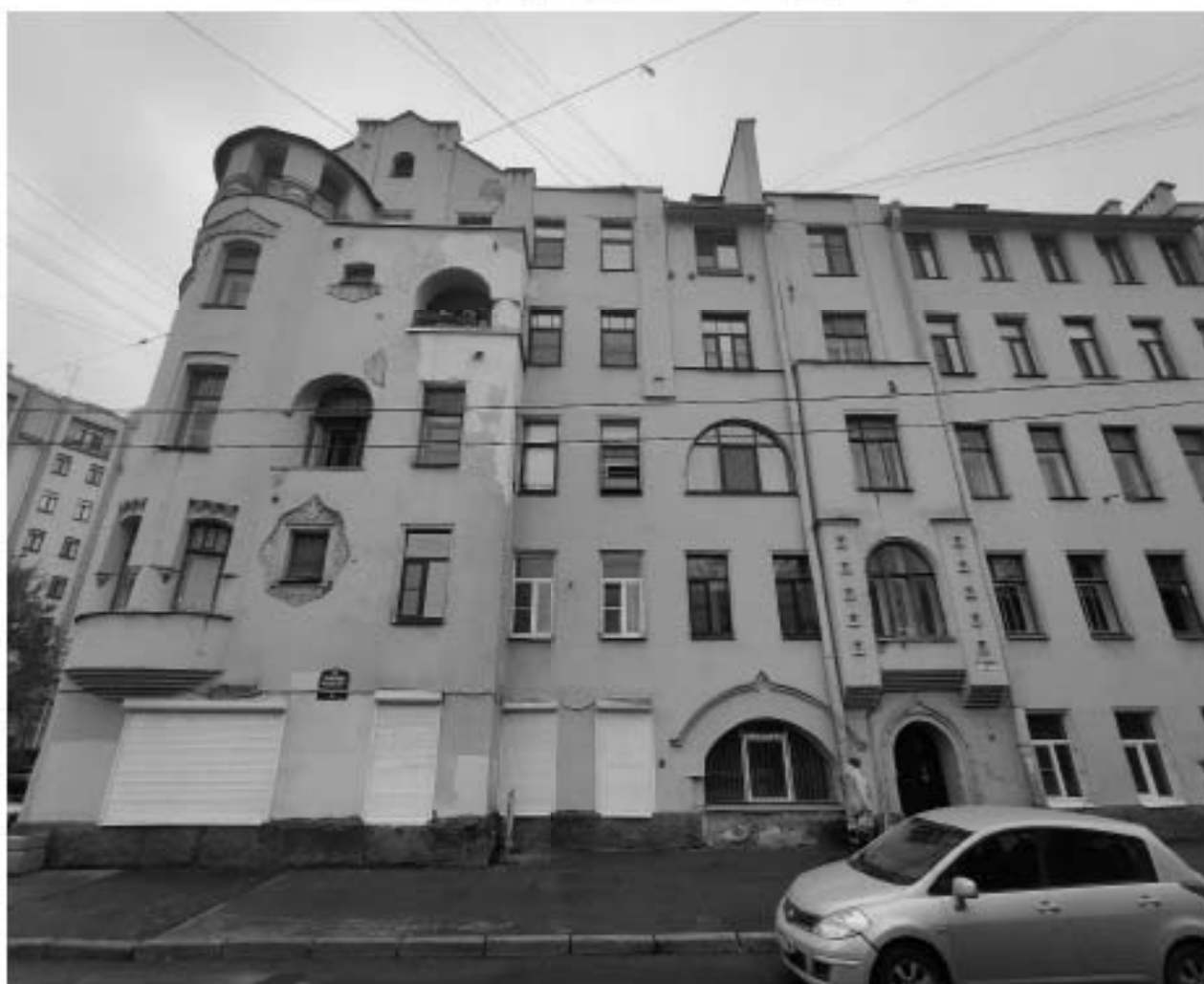
27. Вид на объект культурного наследия регионального значения «Дом А.Л. Лишневского, М.Л. Сагалова», расположенный по адресу: г. Санкт-Петербург, улица Всеволода Вишневского, дом 10, литера А, и зону производства работ. 01.11.2025 г.
