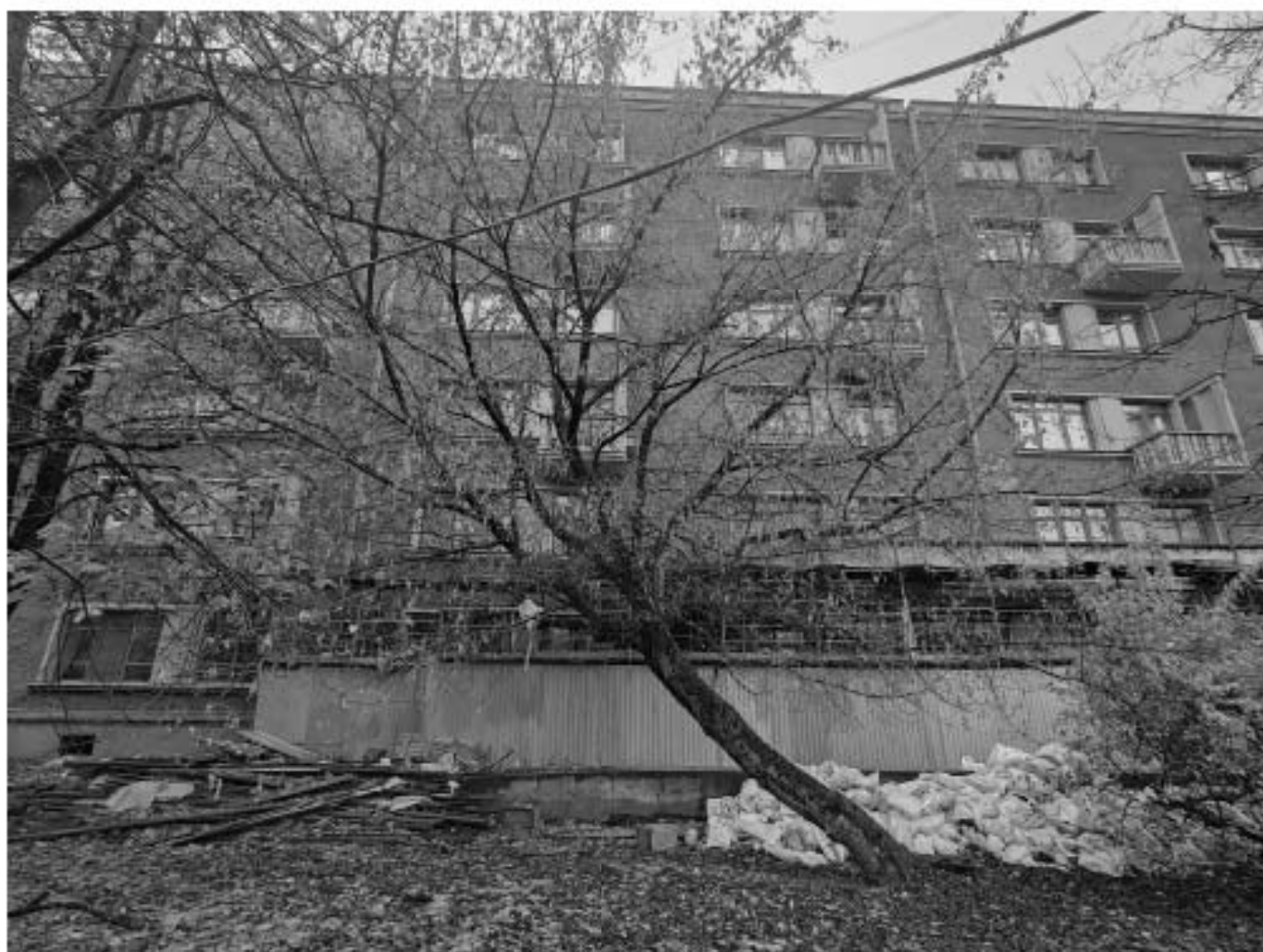
49. Вид на объект культурного наследия регионального значения «Жилой дом», входящий в состав объекта культурного наследия регионального значения «Жилой дом специалистов «Свирьстрой», расположенный по адресу: г. Санкт-Петербург, Малый проспект П.С., дом 84-86, литера А, и зону производства работ. 01.11.2025 г.
