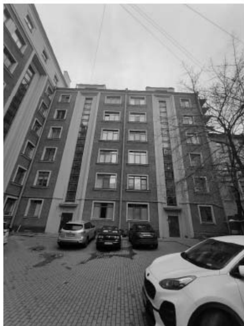
62. Вид на объект культурного наследия регионального значения «Жилой дом», входящий в состав объекта культурного наследия регионального значения «Жилой дом специалистов «Свирьстрой», расположенный по адресу: г. Санкт-Петербург, Малый проспект П.С., дом 84-86, литера А, и зону производства работ. 01.11.2025 г.
