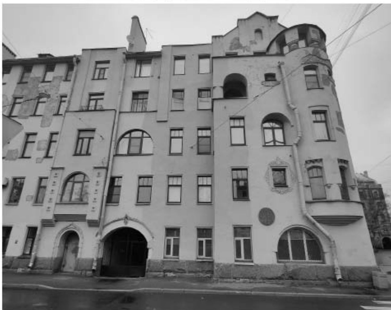
33. Вид на объект культурного наследия регионального значения «Дом А.Л. Лишневского, М.Л. Сагалова», расположенный по адресу: г. Санкт-Петербург, улица Всеволода Вишневского, дом 10, литера А, и зону производства работ. 01.11.2025 г.
