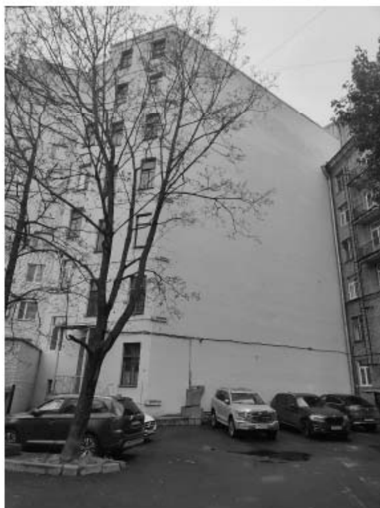
6. Вид на объект культурного наследия регионального значения «Дом К.Г. Чубакова», расположенный по адресу: г. Санкт-Петербург, набережная реки Карповки, дом 30, литера А, и зону производства работ. 01.11.2025 г.
