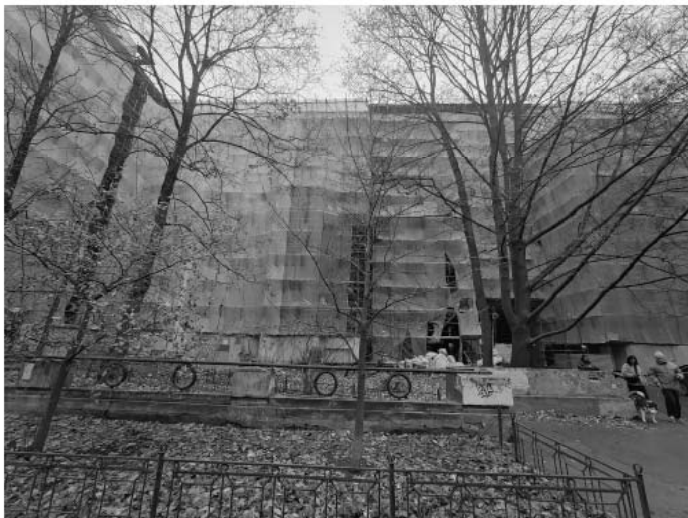
56. Вид на объект культурного наследия регионального значения «Жилой дом», входящий в состав объекта культурного наследия регионального значения «Жилой дом специалистов «Свирьстрой», расположенный по адресу: г. Санкт-Петербург, Малый проспект П.С., дом 84-86, литера А, и зону производства работ. 01.11.2025 г.
