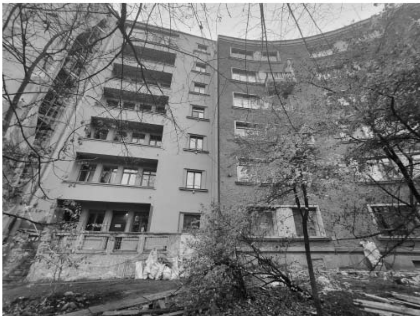
51. Вид на объект культурного наследия регионального значения «Жилой дом», входящий в состав объекта культурного наследия регионального значения «Жилой дом специалистов «Свирьстрой», расположенный по адресу: г. Санкт-Петербург, Малый проспект П.С., дом 84-86, литера А, и зону производства работ. 01.11.2025 г.
