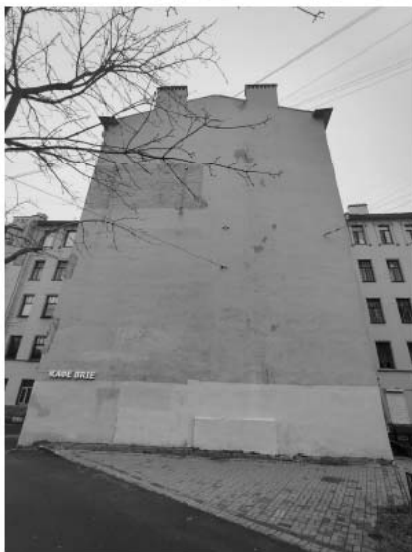
30. Вид на объект культурного наследия регионального значения «Дом А.Л. Лишневского, М.Л. Сагалова», расположенный по адресу: г. Санкт-Петербург, улица Всеволода Вишневского, дом 10, литера А, и зону производства работ. 01.11.2025 г.
