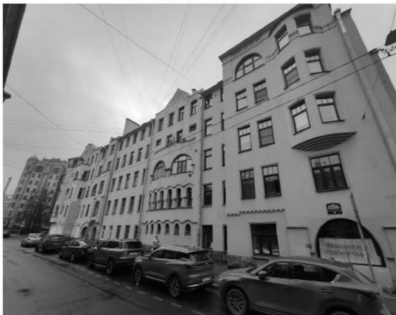
25. Вид на объект культурного наследия регионального значения «Дом А.Л. Липневского, М.Л. Сагалова», расположенный по адресу: г. Санкт-Петербург, улица Всеволода Вишневского, дом 10, литера А, и зону производства работ. 01.11.2025 г.
