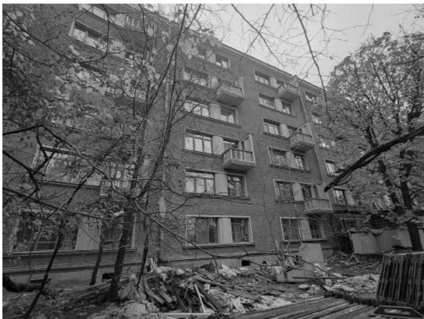
50. Вид на объект культурного наследия регионального значения «Жилой дом», входящий в состав объекта культурного наследия регионального значения «Жилой дом специалистов «Свирьстрой», расположенный по адресу: г. Санкт-Петербург, Малый проспект П.С., дом 84-86, литера А, и зону производства работ. 01.11.2025 г.
