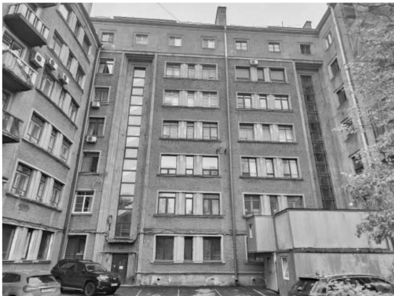
65. Вид на объект культурного наследия регионального значения «Жилой дом», входящий в состав объекта культурного наследия регионального значения «Жилой дом специалистов «Свирьстрой», расположенный по адресу: г. Санкт-Петербург, Малый проспект П.С., дом 84-86, литера А, и зону производства работ. 01.11.2025 г.
