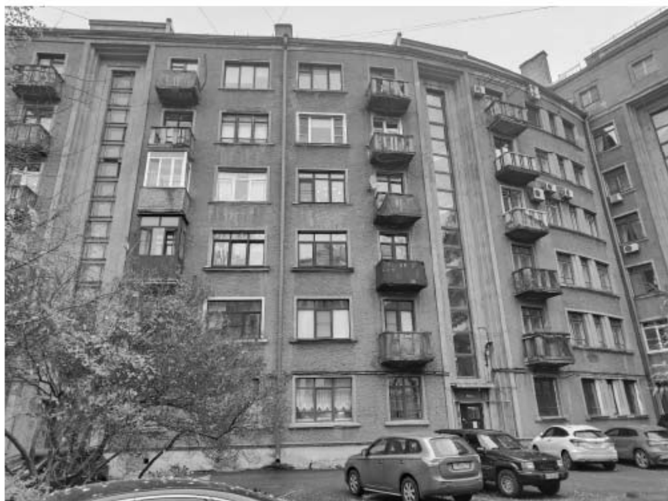
66. Вид на объект культурного наследия регионального значения «Жилой дом», входящий в состав объекта культурного наследия регионального значения «Жилой дом специалистов «Свирьстрой», расположенный по адресу: г. Санкт-Петербург, Малый проспект П.С., дом 84-86, литера А, и зону производства работ. 01.11.2025 г.
