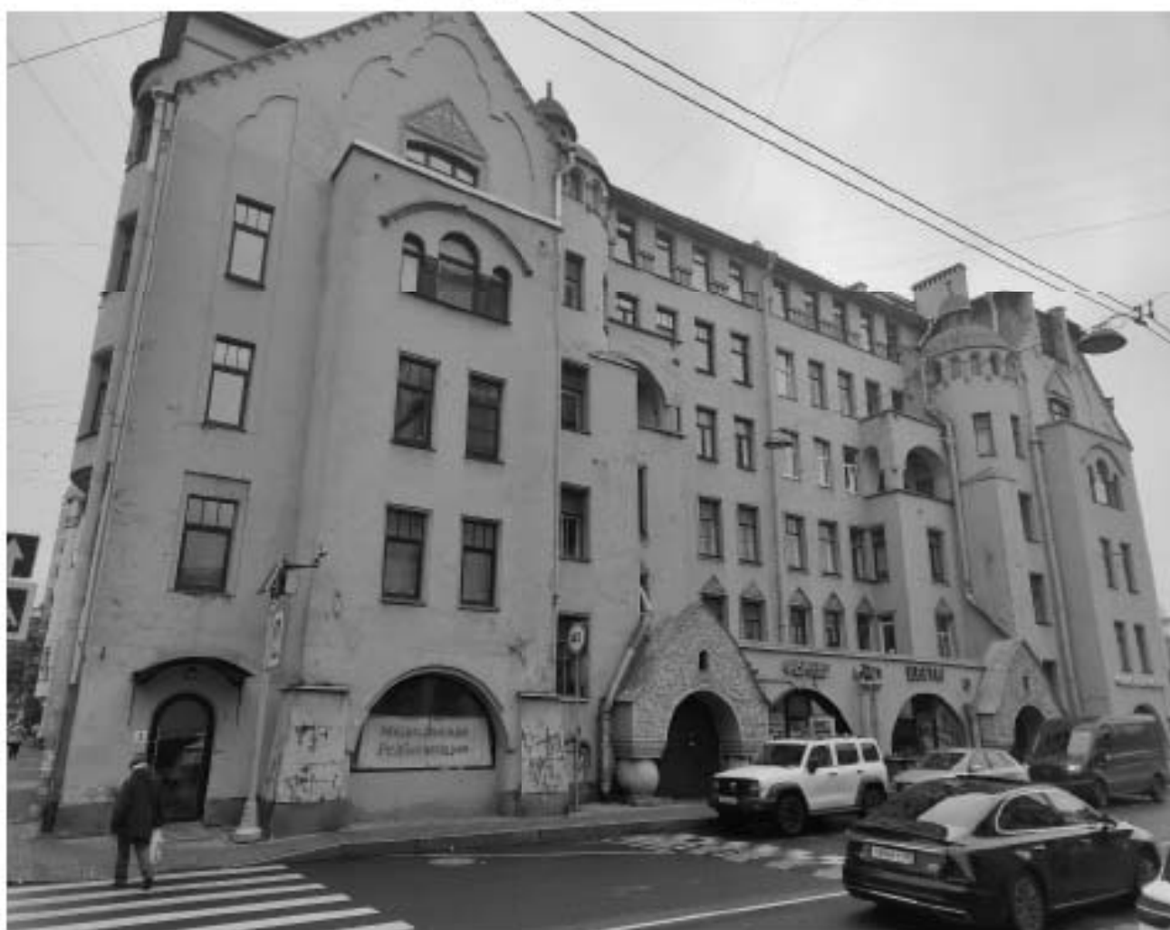
24. Вид на объект культурного наследия регионального значения «Дом А.Л. Лишневского, М.Л. Сагалова», расположенный по адресу: г. Санкт-Петербург, улица Всеволода Вишневского, дом 10, литера А, и зону производства работ. 01.11.2025 г.
