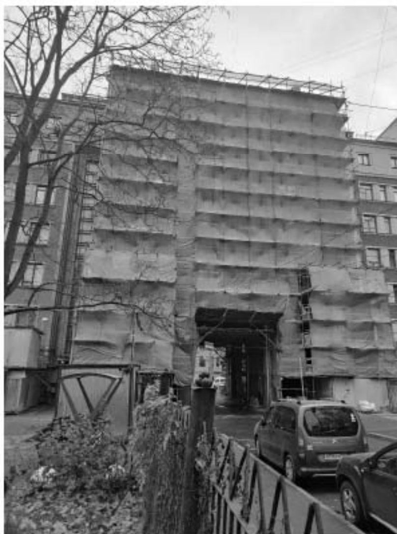
64. Вид на объект культурного наследия регионального значения «Жилой дом», входящий в состав объекта культурного наследия регионального значения «Жилой дом специалистов «Свирьстрой», расположенный по адресу: г. Санкт-Петербург, Малый проспект П.С., дом 84-86, литера А, и зону производства работ. 01.11.2025 г.
