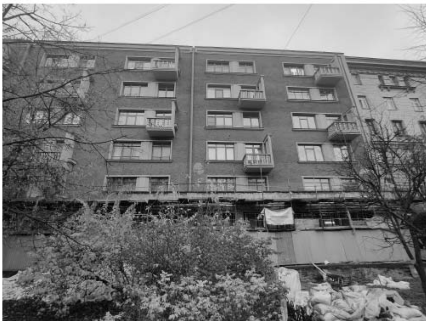
48. Вид на объект культурного наследия регионального значения «Жилой дом», входящий в состав объекта культурного наследия регионального значения «Жилой дом специалистов «Свирьстрой», расположенный по адресу: г. Санкт-Петербург, Малый проспект П.С., дом 84-86, литера А, и зону производства работ. 01.11.2025 г.
