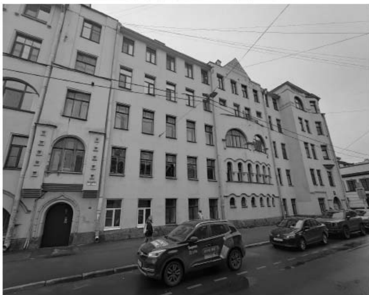
26. Вид на объект культурного наследия регионального значения «Дом А.Л. Лишневского, М.Л. Сагалова», расположенный по адресу: г. Санкт-Петербург, улица Всеволода Вишневского, дом 10, литера А, и зону производства работ. 01.11.2025 г.
