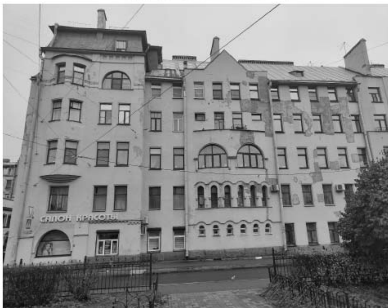
34. Вид на объект культурного наследия регионального значения «Дом А.Л. Лишневского, М.Л. Сагалова», расположенный по адресу: г. Санкт-Петербург, улица Всеволода Вишневского, дом 10, литера А, и зону производства работ. 01.11.2025 г.
