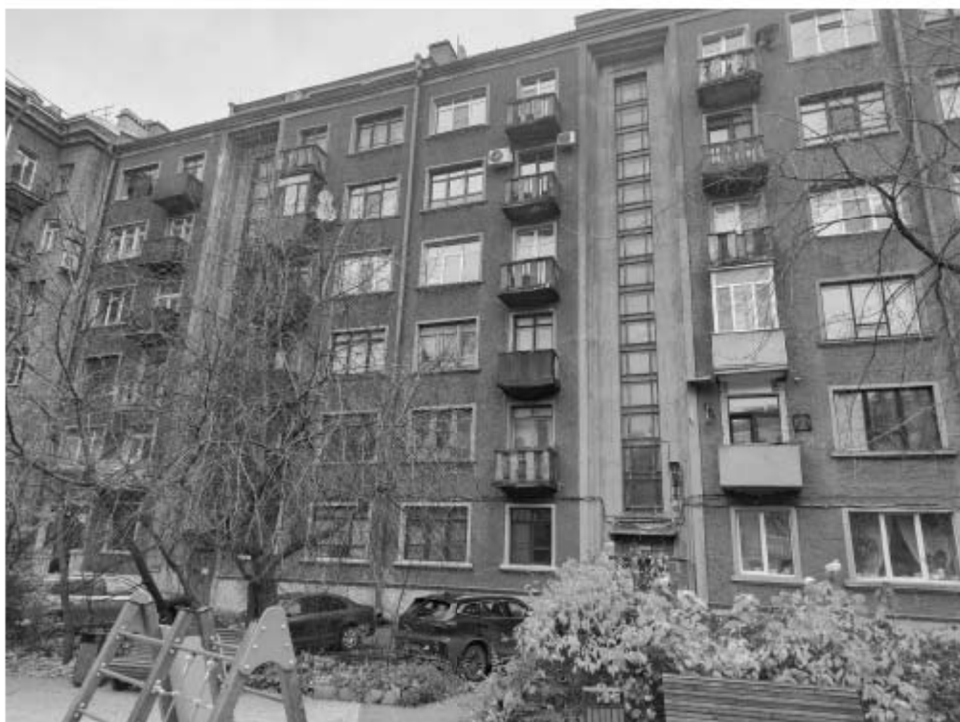
68. Вид на объект культурного наследия регионального значения «Жилой дом», входящий в состав объекта культурного наследия регионального значения «Жилой дом специалистов «Свирьстрой», расположенный по адресу: г. Санкт-Петербург, Малый проспект П.С., дом 84-86, литера А, и зону производства работ. 01.11.2025 г.
