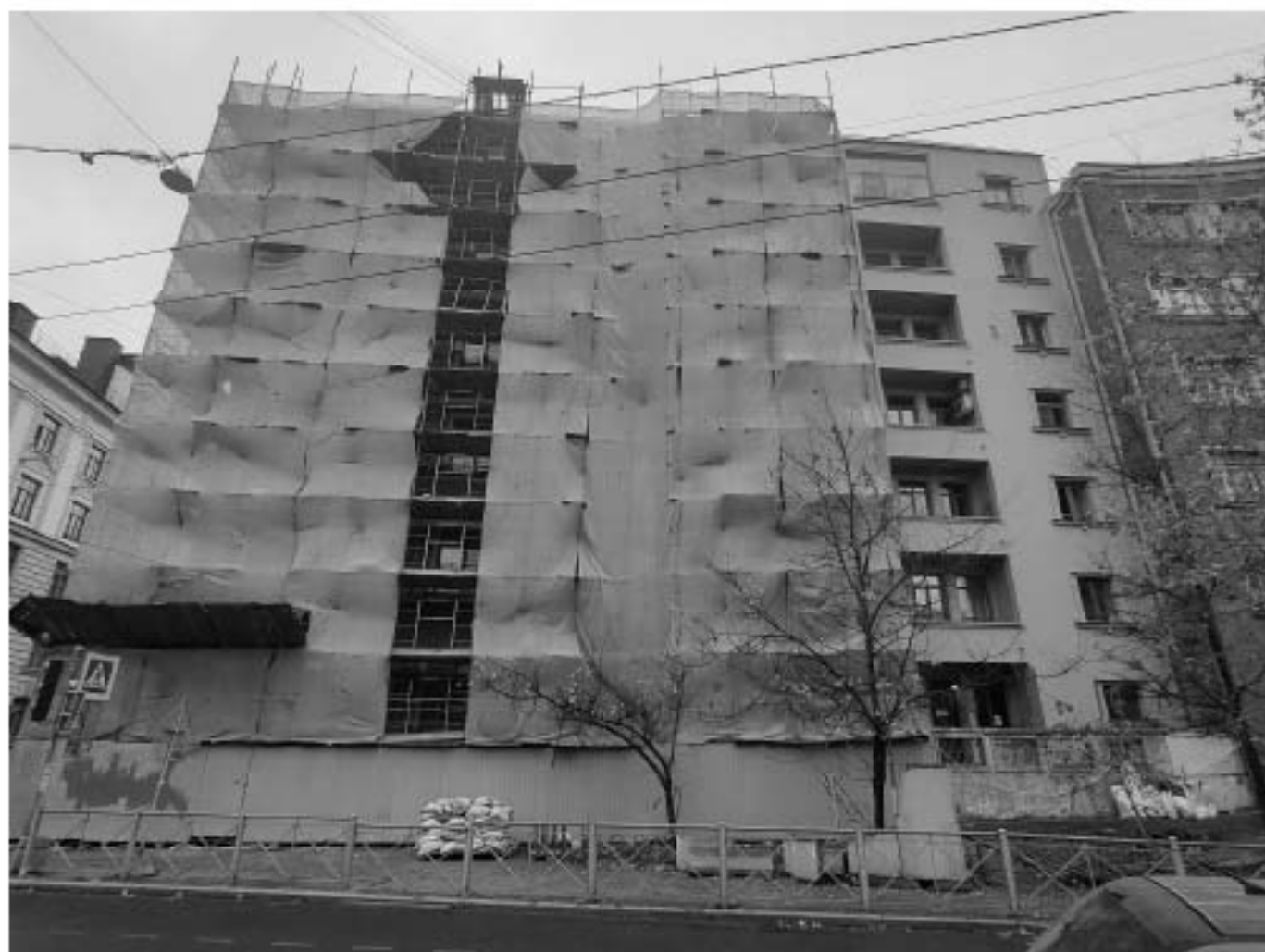
52. Вид на объект культурного наследия регионального значения «Жилой дом», входящий в состав объекта культурного наследия регионального значения «Жилой дом специалистов «Свирьстрой», расположенный по адресу: г. Санкт-Петербург, Малый проспект П.С., дом 84-86, литера А, и зону производства работ. 01.11.2025 г.
