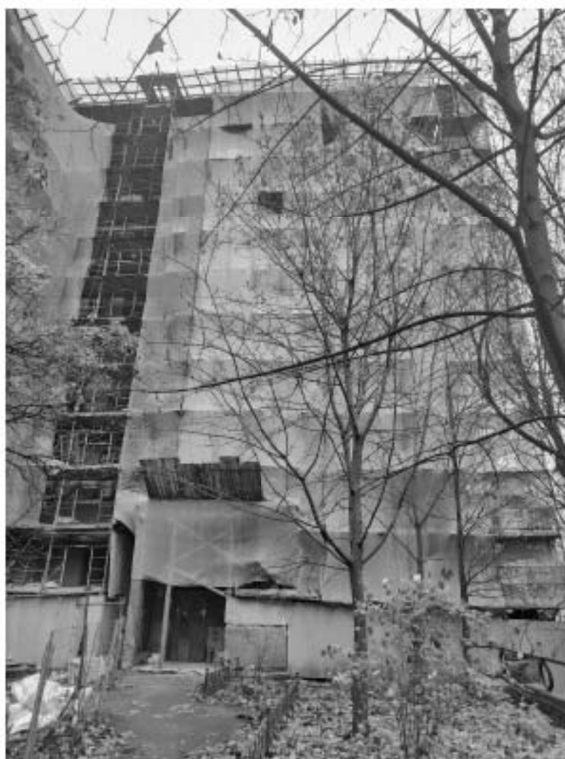
54. Вид на объект культурного наследия регионального значения «Жилой дом», входящий в состав объекта культурного наследия регионального значения «Жилой дом специалистов «Свирьстрой», расположенный по адресу: г. Санкт-Петербург, Малый проспект П.С., дом 84-86, литера А, и зону производства работ. 01.11.2025 г.
