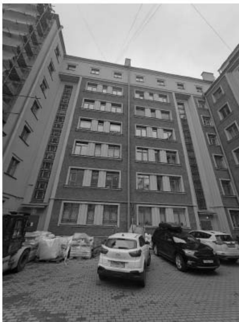
63. Вид на объект культурного наследия регионального значения «Жилой дом», входящий в состав объекта культурного наследия регионального значения «Жилой дом специалистов «Свирьстрой», расположенный по адресу: г. Санкт-Петербург, Малый проспект П.С., дом 84-86, литера А, и зону производства работ. 01.11.2025 г.
