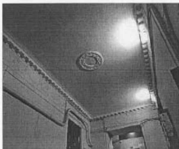
Парадная лестница №7 вестибюль
