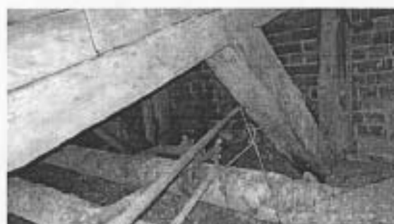
Вид деревянных конструкций кровли чердака
