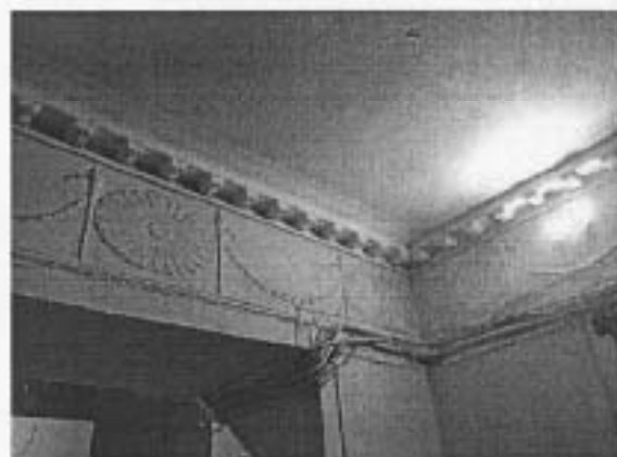
Парадная лестница №7 вестибюль
