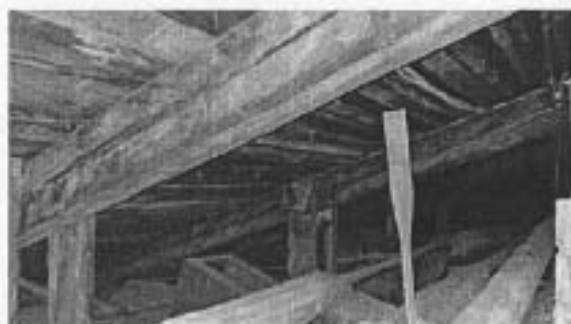
Вид деревянных конструкций кровли чердака
