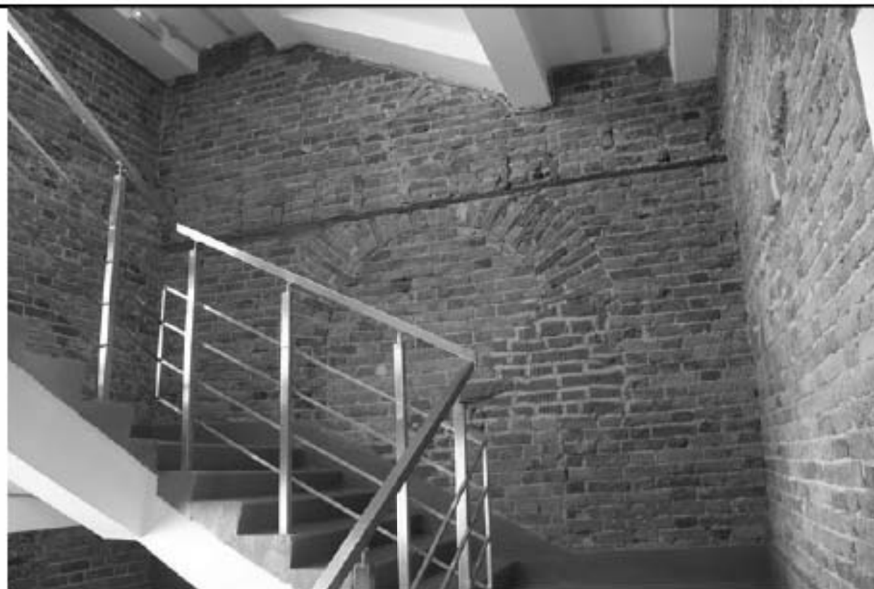
Восточная лестница. Заложенный проем.
