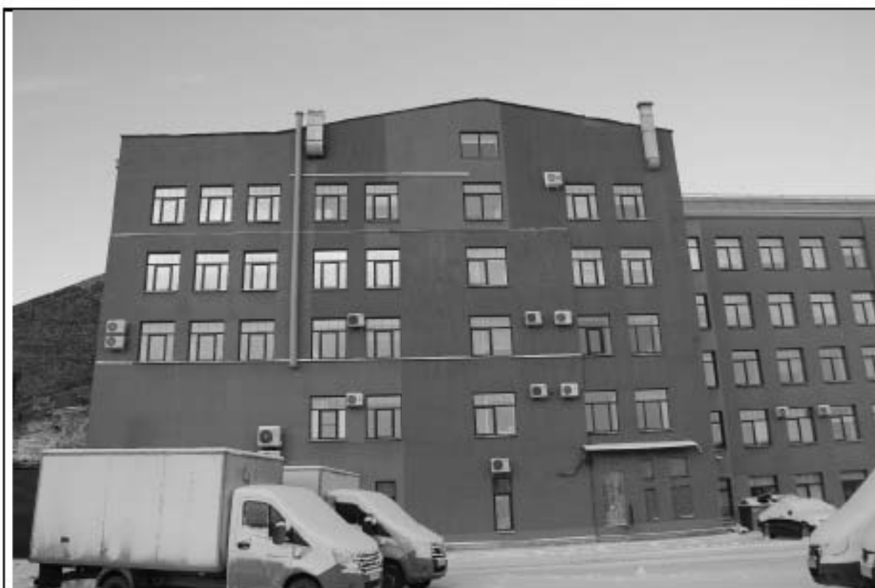
Прядильный корпус. Переход из лицевого корпуса в западный флигель (утрачен). Южный фасад. На оси здания – лестничная клетка полукруглой лестницы. Январь 2025 г.
