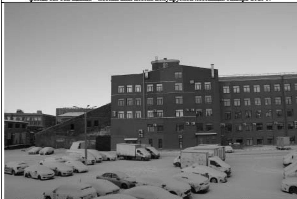
Здание Новой Бумагопрядильни. Фрагмент южного фасада с переходом из Прядильного корпуса в западный флигель (утрачен) и кочегаркой (слева). Январь 2025 г.
