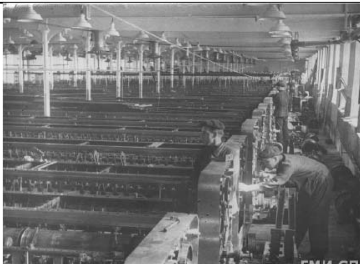
1939 г. Фабрика Анисимова. Рабочие устанавливают ватера на 8500 веретен. ГМИ СПб Инв.№-П-Б-27245 ф.
