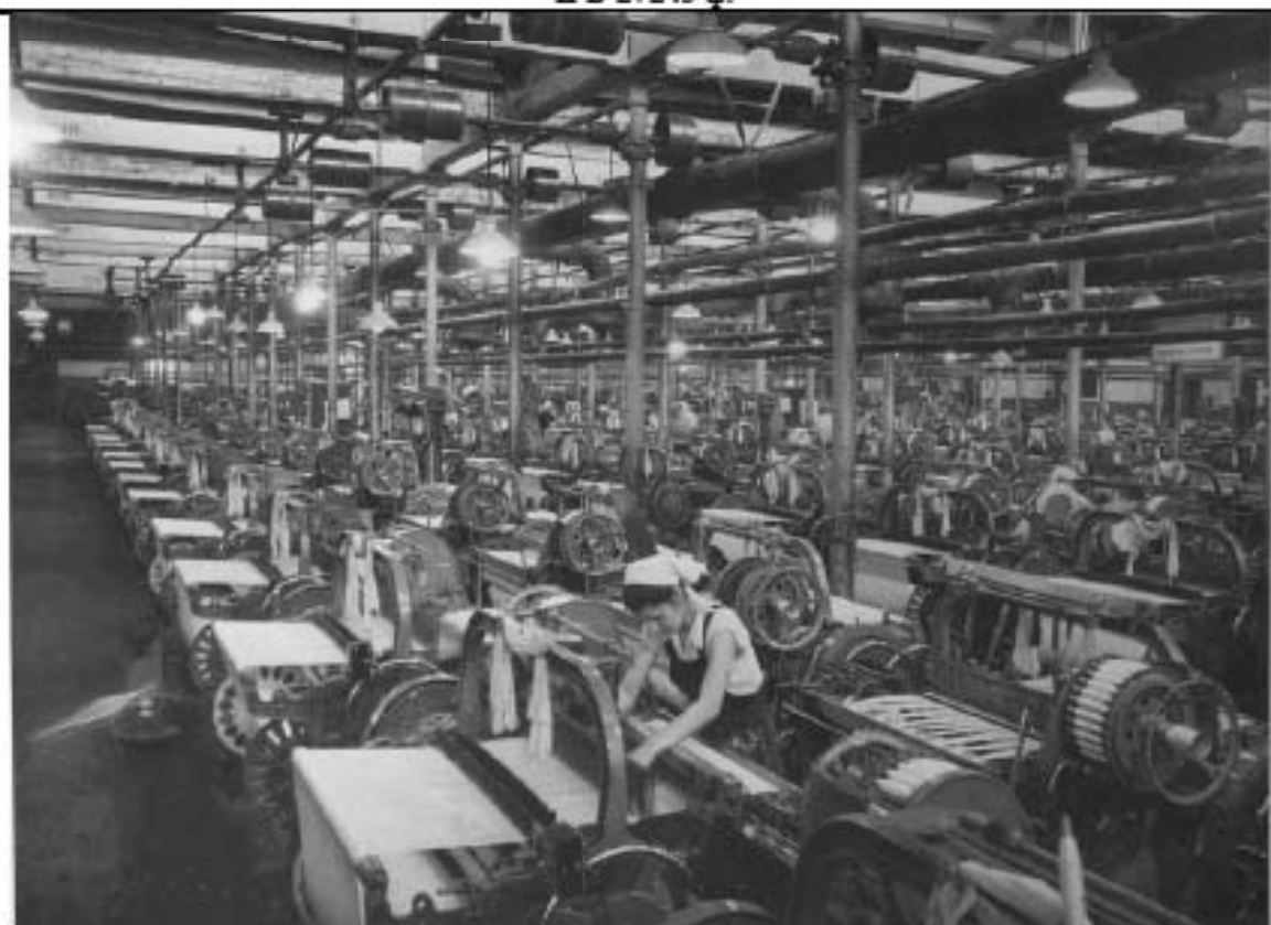
1955 г. Наровлянский И. А., Федотов П. Прядильно-ткацкая фабрика имени Петра Анисимова. Новые станки ATK-100 в первом цехе ткацкого производства фабрики. ГМИ СПб Инв.№-П-Б-16720 ф.
