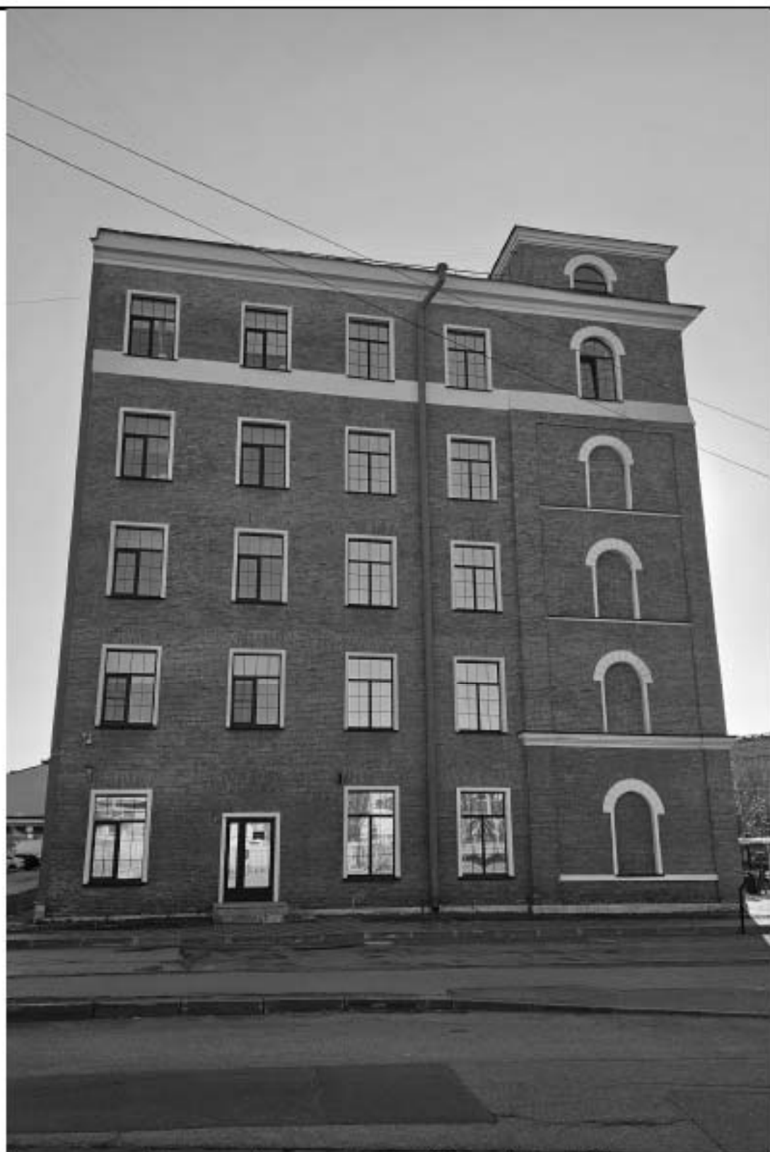
Прядильный корпус. Восточный фасад. Июнь 2025 г.
