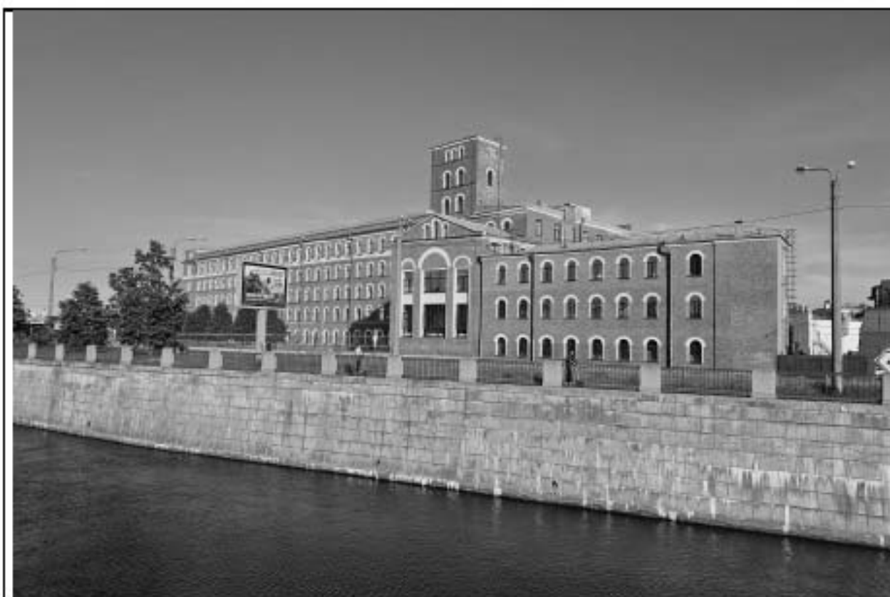
Здание Новой Бумажнопрядильни. Лицевой фасад. Июнь 2025 г.
