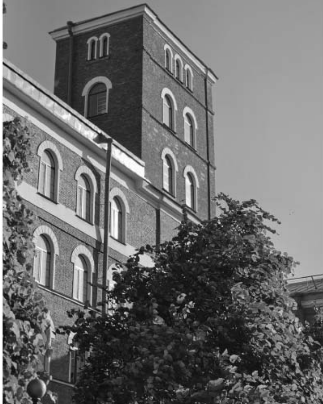
Прядильный корпус с водонапорной башней и пристройкой для Паровой. Июнь 2025 г.
