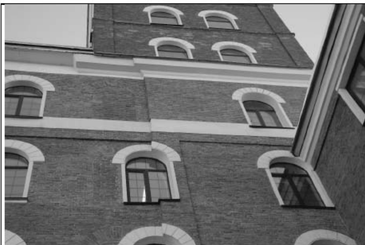
Прядильный корпус. Лицевой фасад. Следы перебивки оконных проемов (смещение на лопатку фланкирующего ризалита) при строительстве водонапорной башни. Январь 2025 г.
