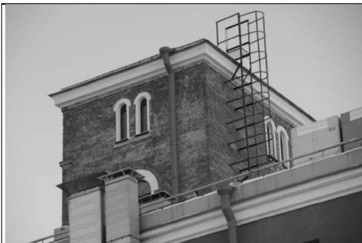
Водонапорная башня. Вид с юго-запада. Январь 2025 г.
