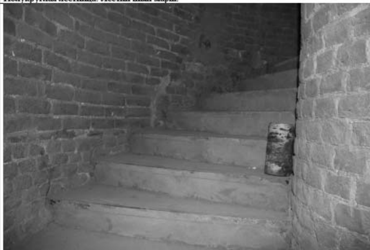
Полукруглая лестница. Лестничный марш.
