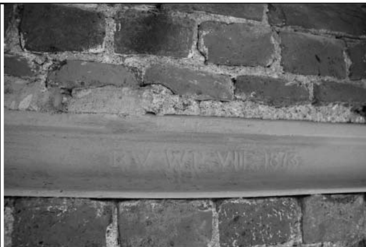
Башия. Металлическая балка с клеймом 1873 г.
