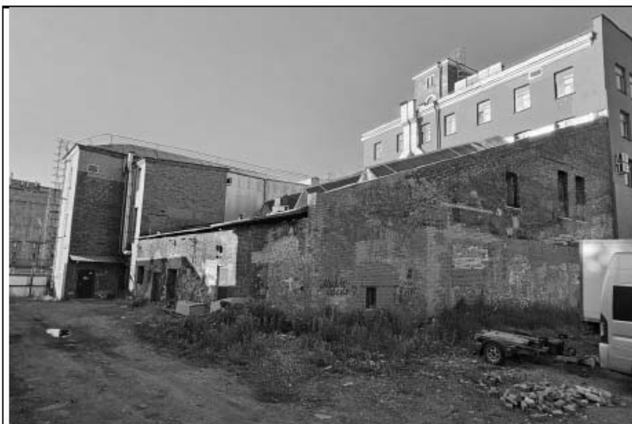
Здание котельной. Вид с юго-запада. Июнь 2025 г.
