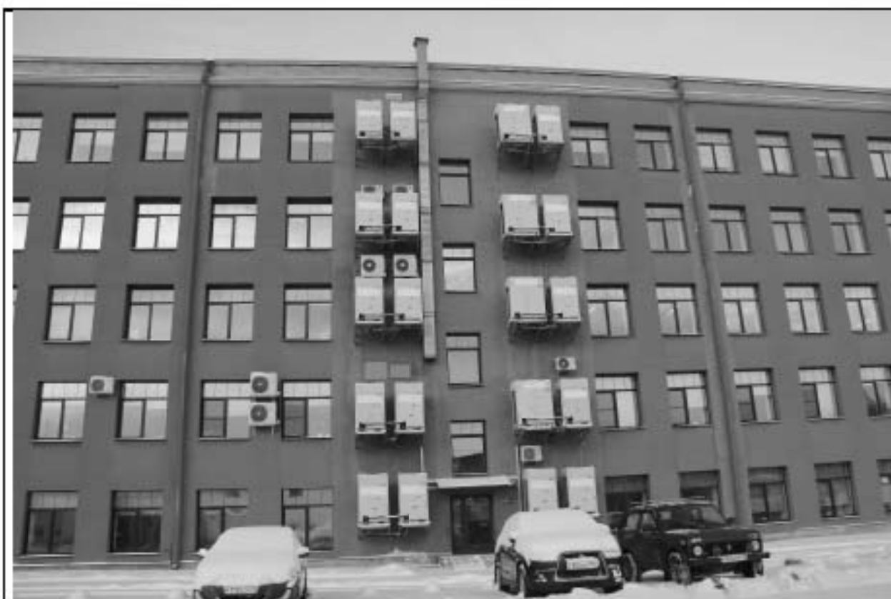
Прядильный корпус. Центральная часть южного (дворового) фасада с новой (2012 г.) лестничной клеткой. Январь 2025 г.
