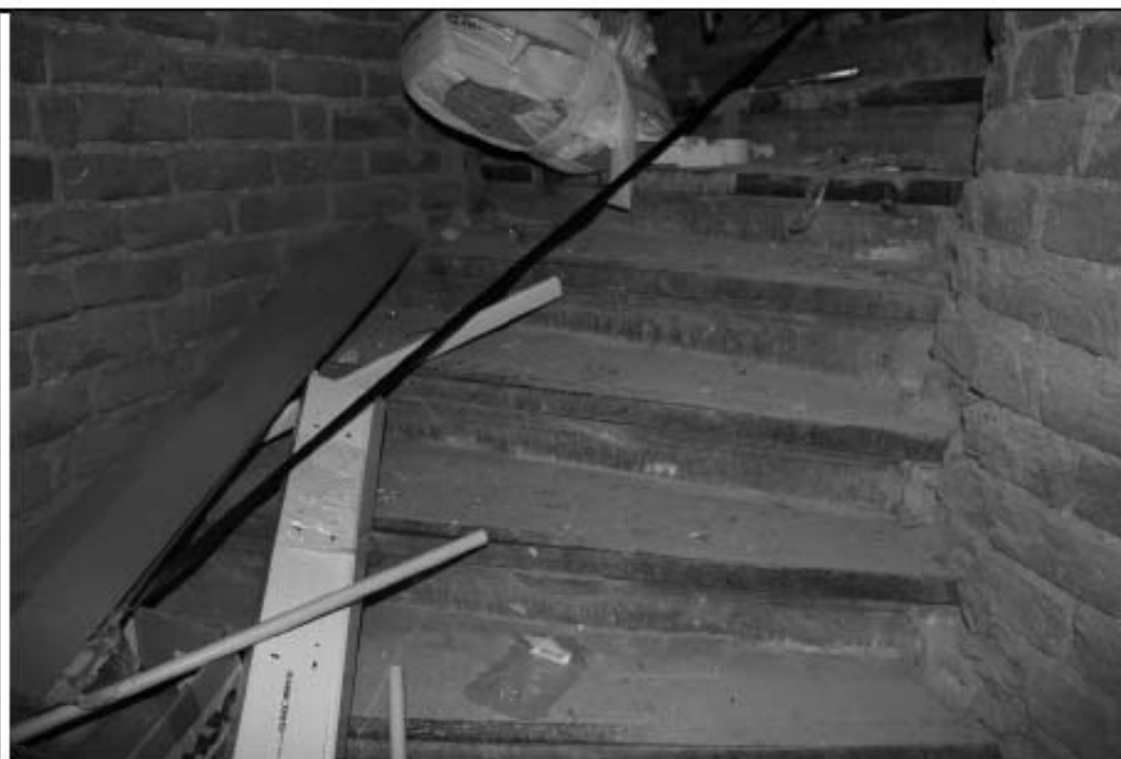
Полукруглая лестница. Лестничный марш.
