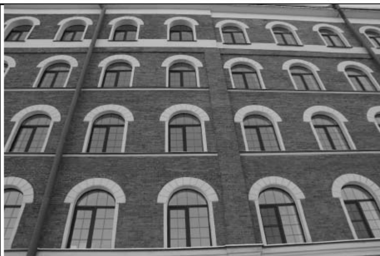
Прядильный корпус. Фрагмент лицевого фасада. Оформление оконных проемов. Лопатка центрального ризалита. Январь 2025 г.
