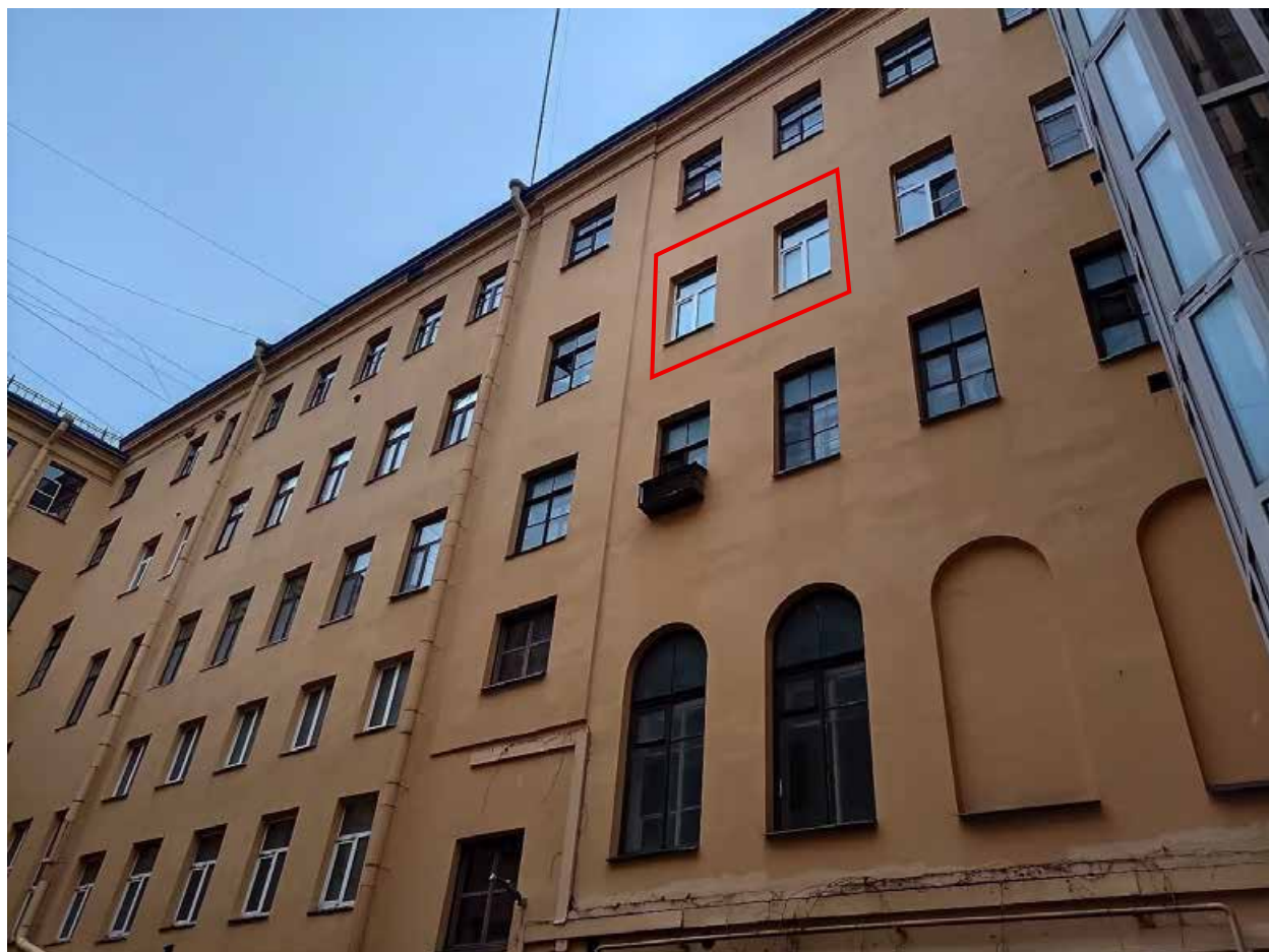
Фото 4. Вид на дворовый фасад.
