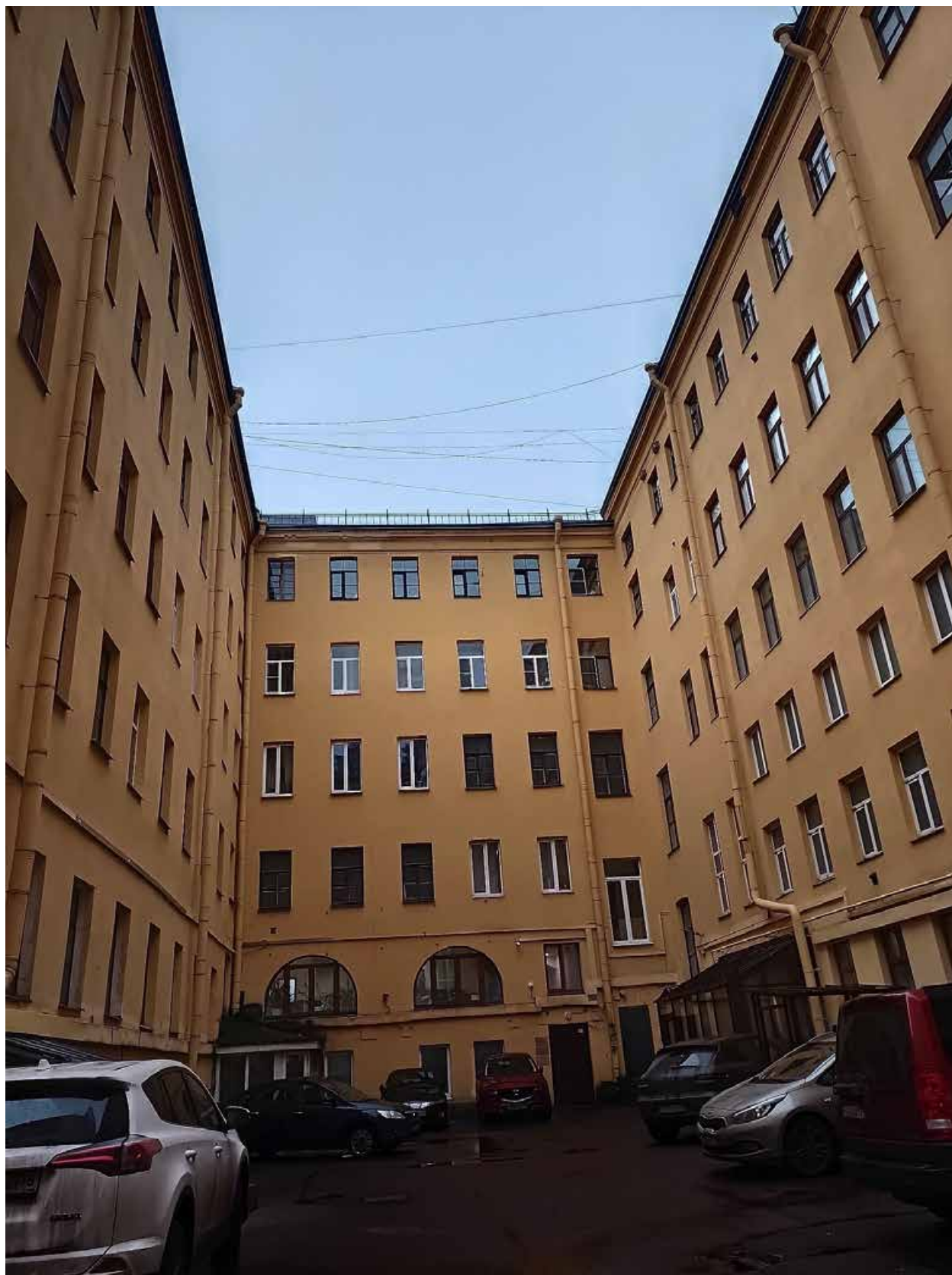
Фото 3. Вид на дворовые фасады.
