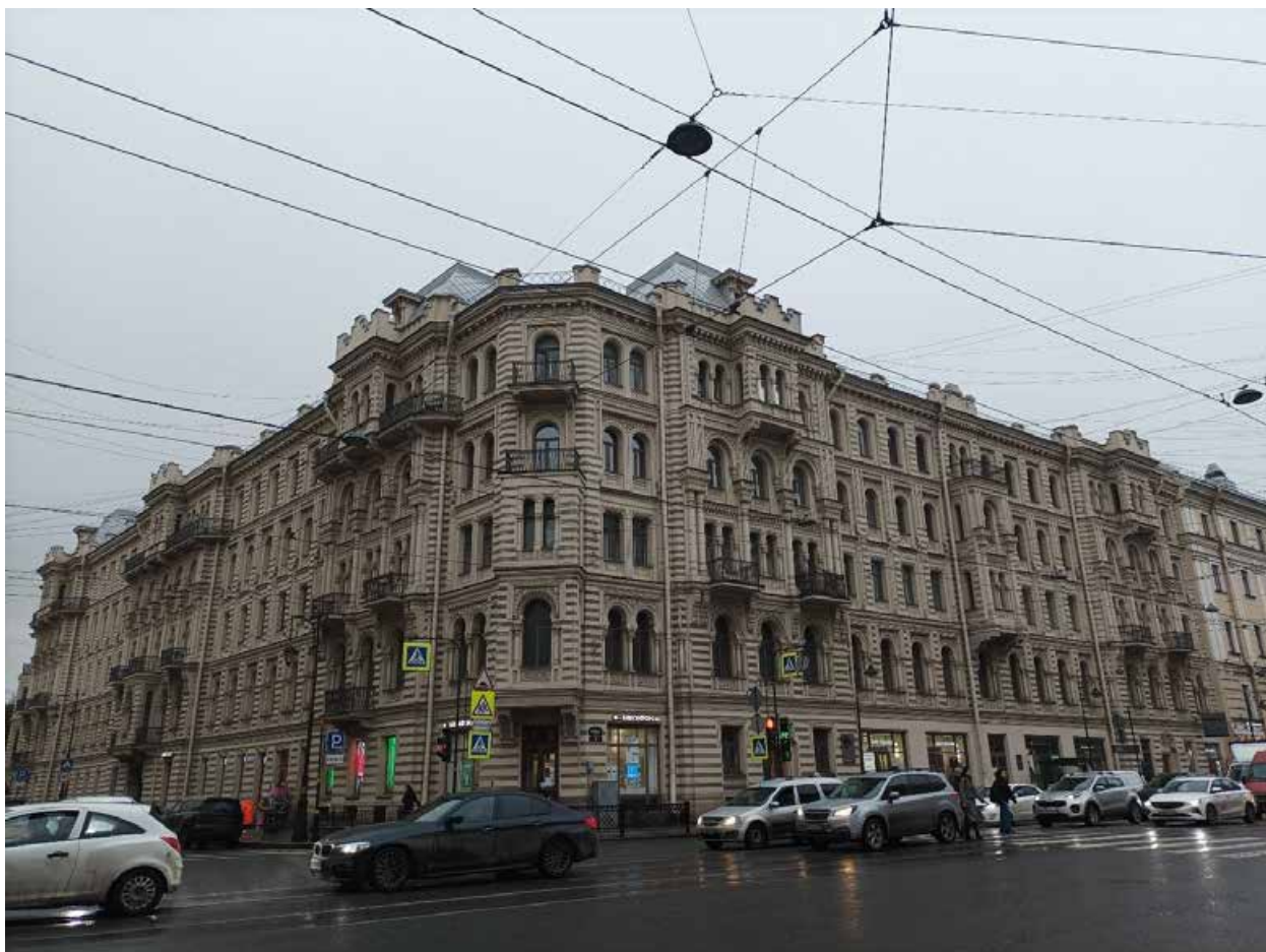
Фото 1. Вид на угол пересечения Литейного проспекта, 24, и улицы Пестеля, 27.
