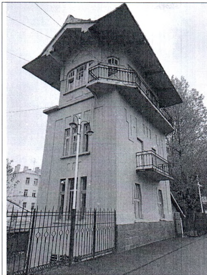
3. Северный и западный фасад. Общий вид.
