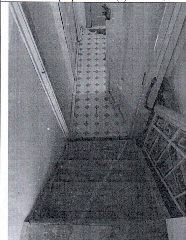
21. Интерьер. Пом. 1-Н(12). Лестница.
