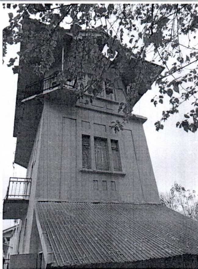
4. Южный фасад. Общий вид.
