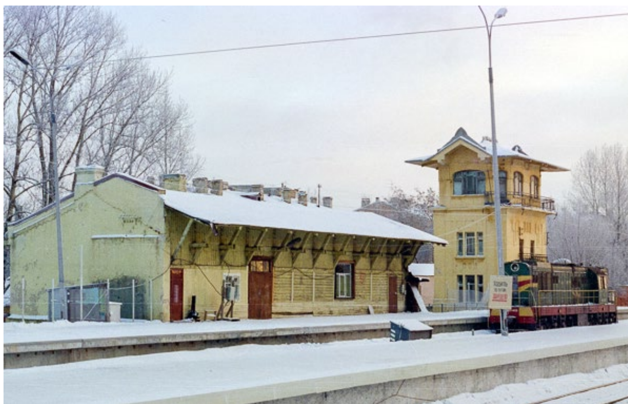
Илл. 24. Витебский вокзал. Центральный пост. 2002-2003 гг. Водонапорные и другие башни [Электронный ресурс] URL: https://watertowers.ru/drugie-bashni/zdanie-ispolnitelno-rasporyaditelnogo-posta-na-stantsii-sankt-peterburg-vitebskij
