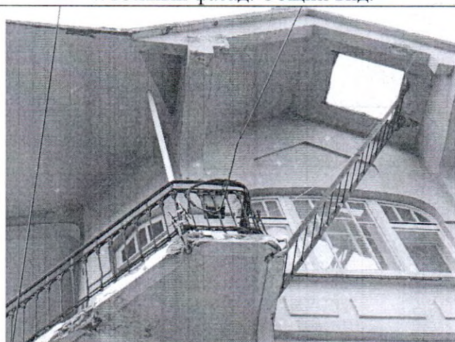
6. Южный фасад. Фрагмент. Балкон и лестница на крышу.
