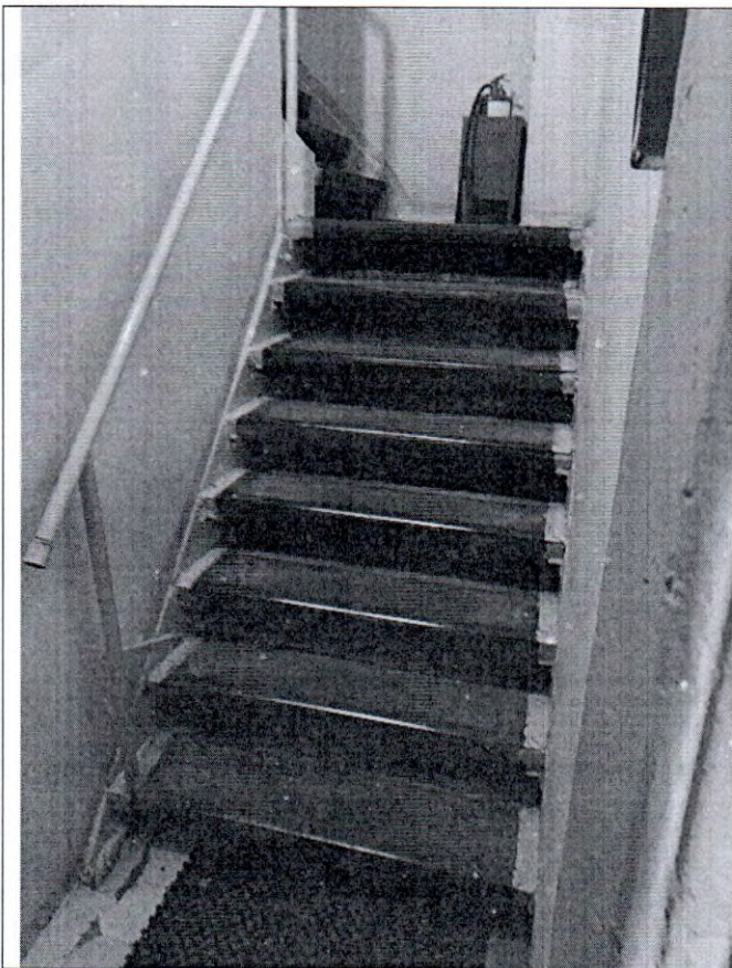
19. Интерьер. Пом. 1-Н(1). Лестница.
