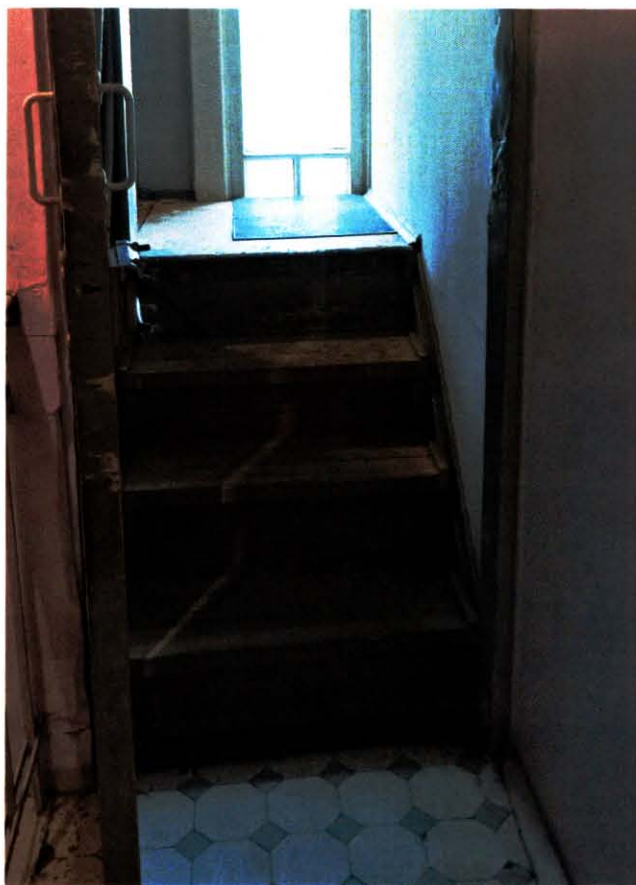
8. Интерьер объекта культурного наследия. Помещение № 1-Н.
