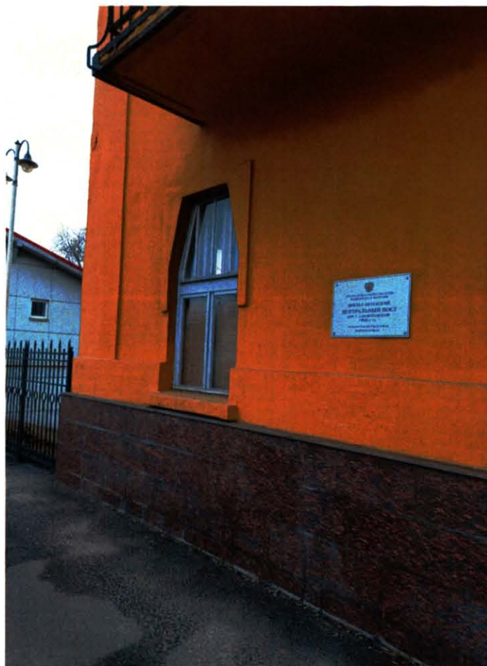
4. Фрагмент западного фасада объекта культурного наследия.
