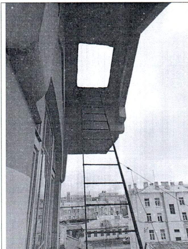
7. Южный фасад. Фрагмент. Балкон и лестница на крышу.
