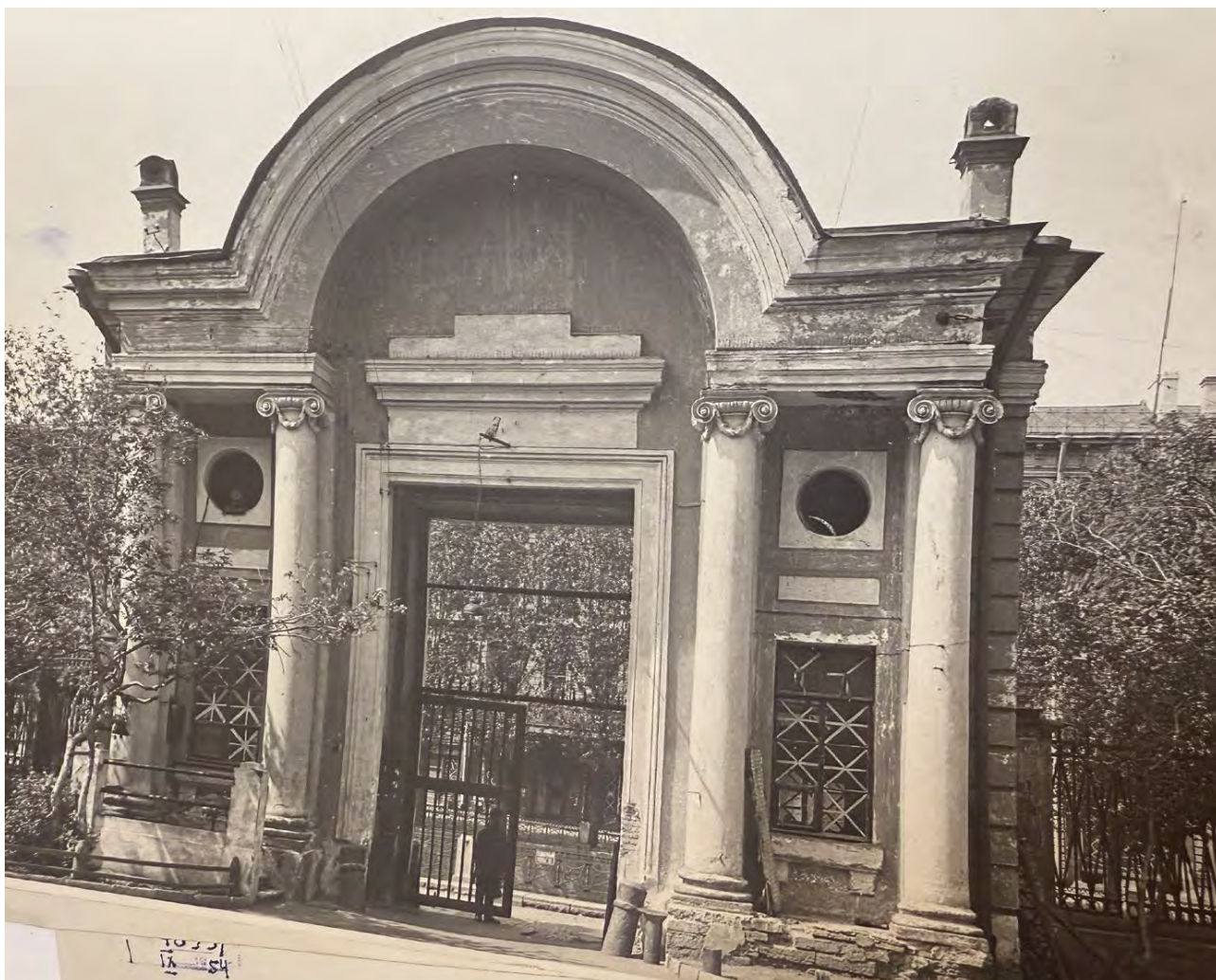
Рис. 90. Государственный педагогический институт имени А. И. Герцена (б. дворец К. Г. Разумовского, наб. реки Мойки, 48). Фото 1972 года. Источник: Сектор хранения документированной информации Управление организационного обеспечения и контроля КГИОП (архив КГИОП). Фототека охраны памятников №298291.
