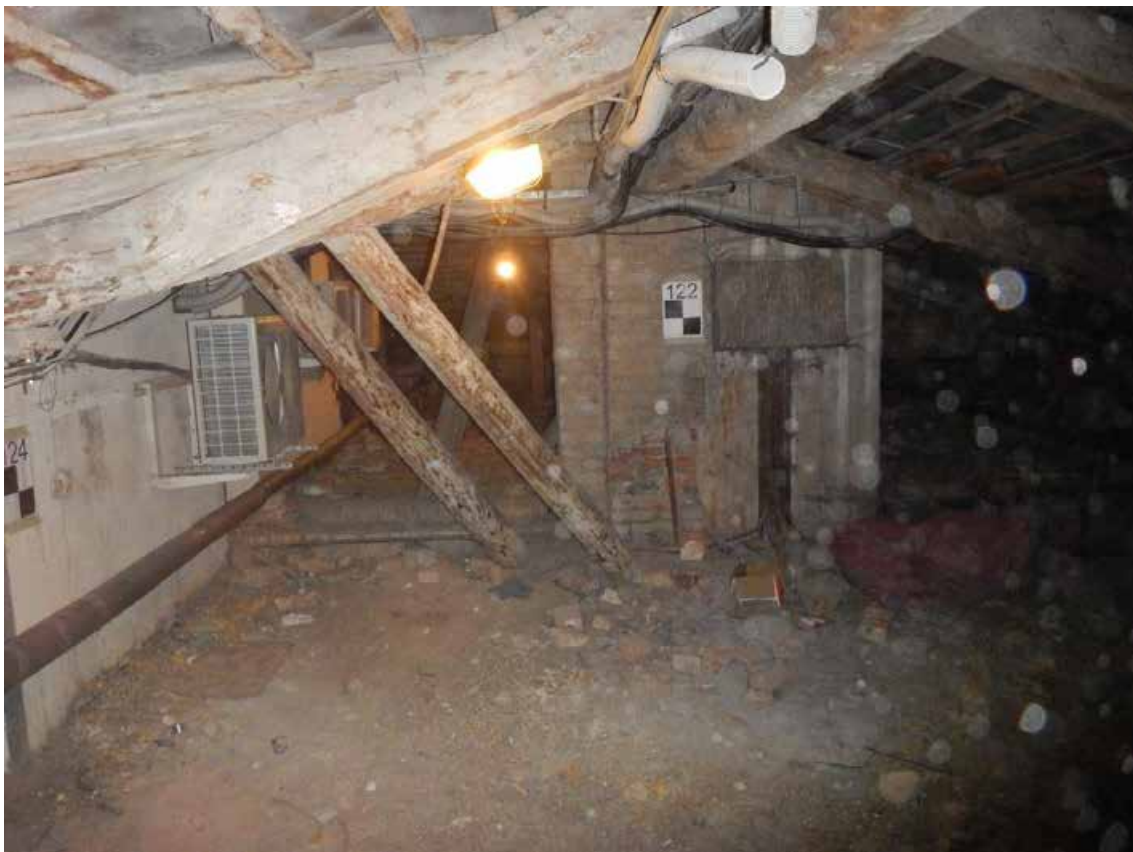
Фото 19. Устройство подкосов стропильной системы.
