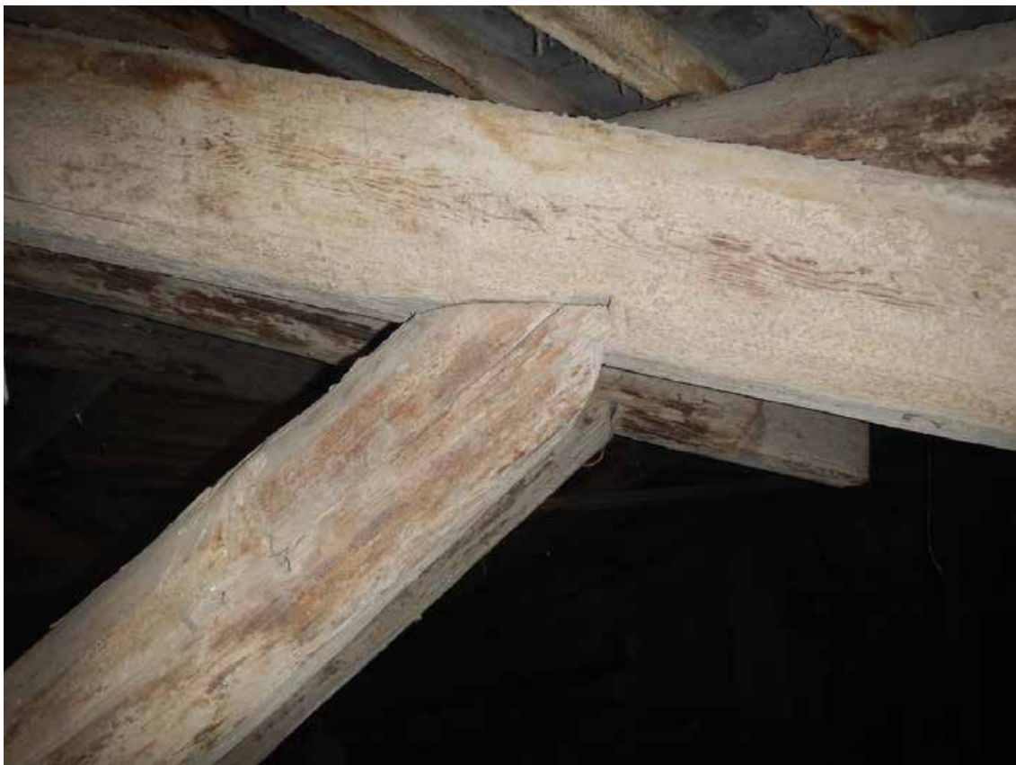
Фото 5. Общий вид сопряжения подкоса и стропильной ноги.
