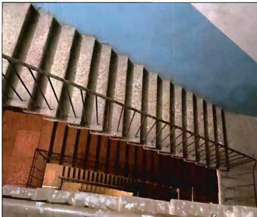
42. Двухмаршевая лестница (центральный дворовый флигель (центральный внутренний двор № 1). Фото от 17.11.2021 г.
