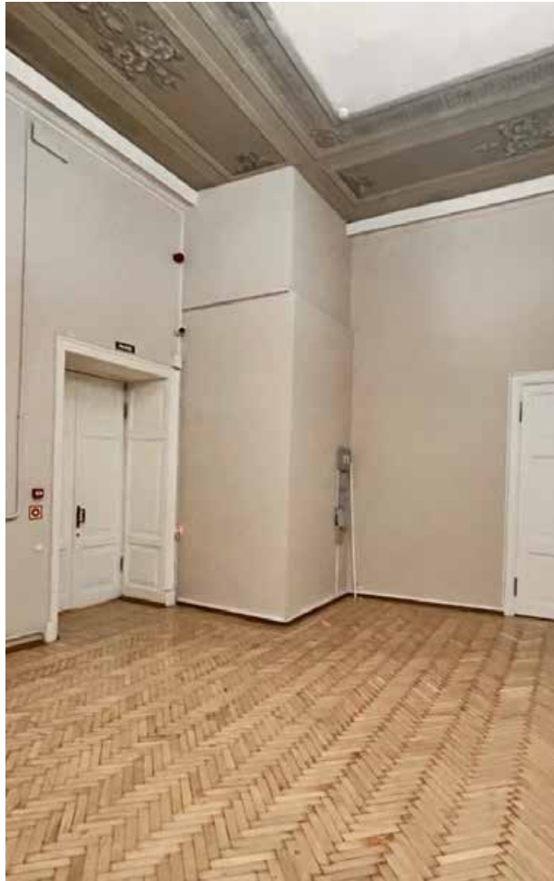
Фото №13. Помещение 27-Н (11).
