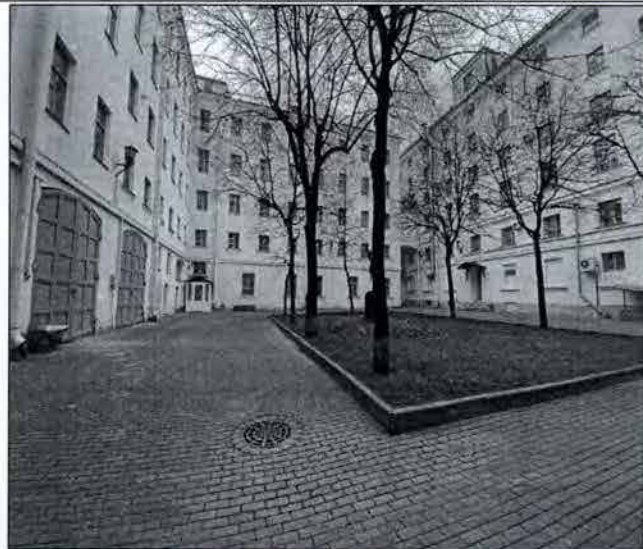
15. Дворовые фасады. Южный двор. Фото от 09.11.2021 г.
