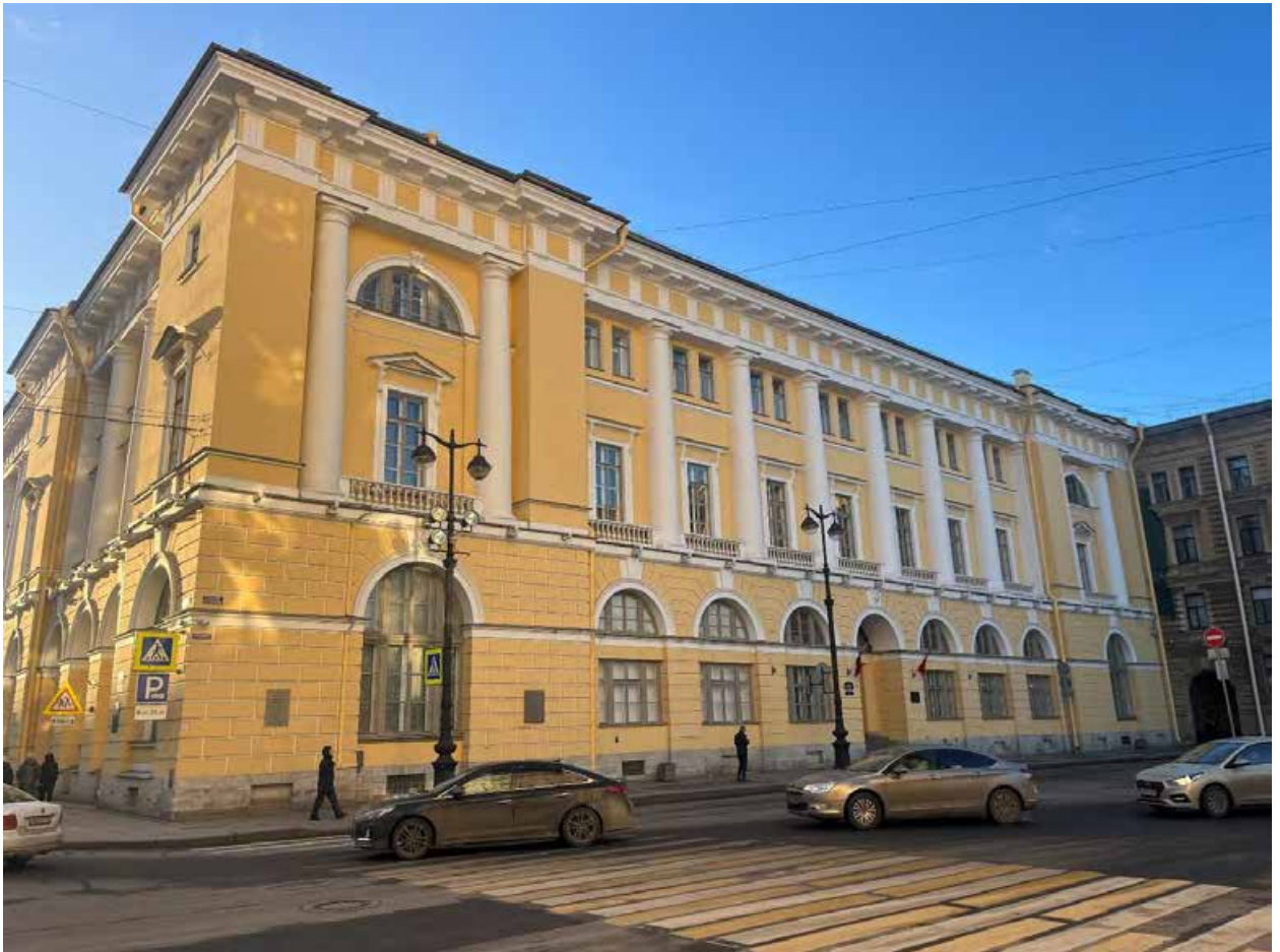
Фото №15. Северный лицевой фасад.
