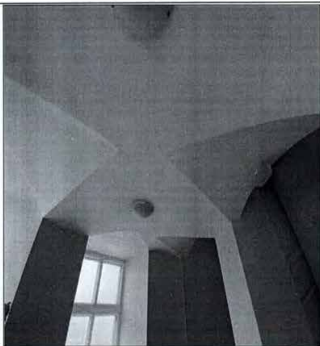
54. Крестовый свод на лестничной клетке. Фото от 10.11.2021 г.
