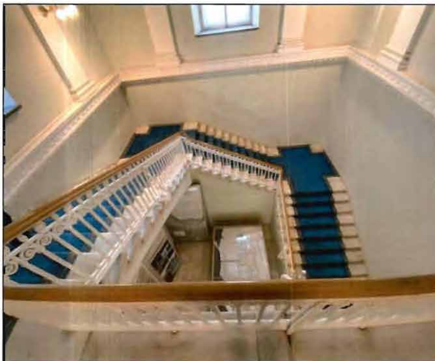
35. Трехмаршшевая парадная лестница (12ЛК) со стороны пл. Ломоносова. Фото от 16.11.2021 г.
