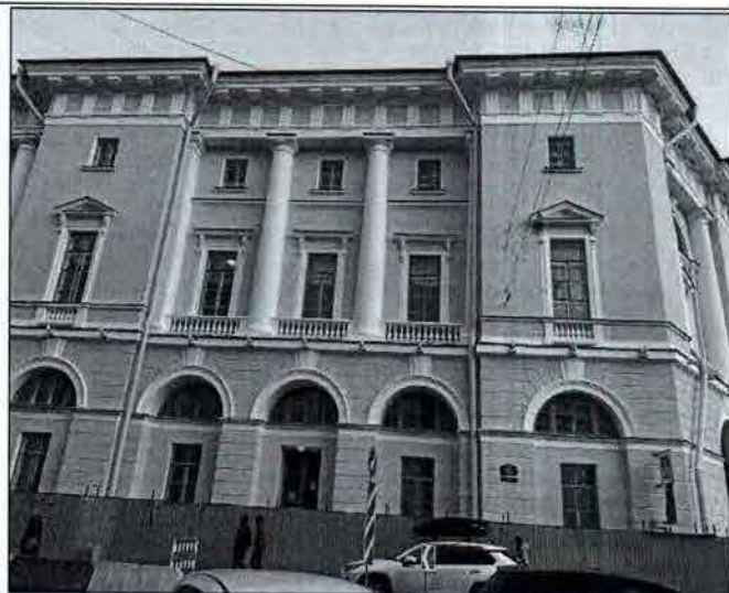
7. Фрагмент западного фасада. Фото от 09.11.2021 г.
