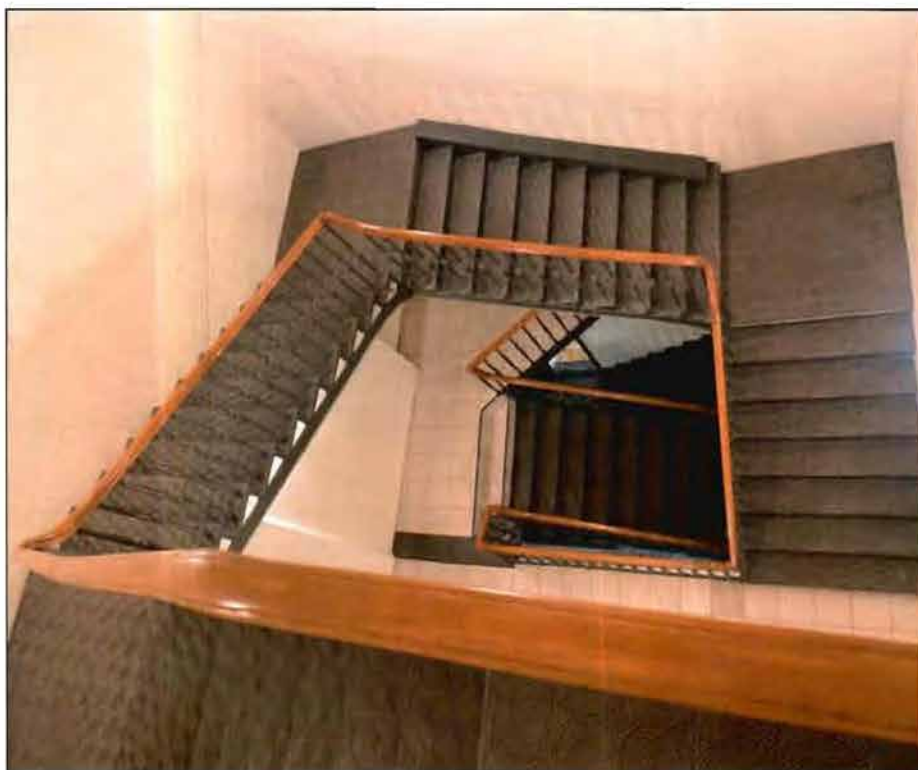
31. Четырехмаршевая железная лестница в пом. 21-Н (20) в угловой части корпусов по пл. Ломоносова и ул. Зодчего Росси. Фото от 16.11.2021 г.
