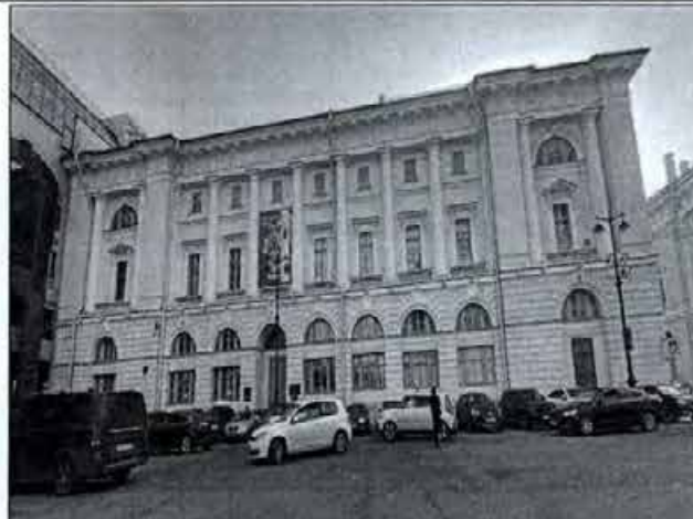
2. Северный фасад объекта культурного наследия, вид со стороны пл. Островского. Фото от 09.11.2021 г.
