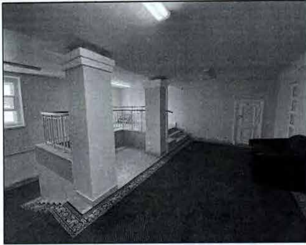
26. Поздние несущие колонны квадратного сечения, оштукатурены, окрашены на лестничных клетках основного объема здания по ул. Зодчего Росси в уровне 7-го этажа. Фото от 09.11.2021 г.
