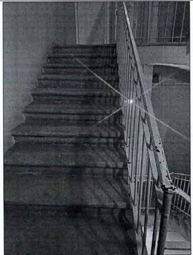
53. Двухмаршевая лестница с известняковыми ступенями. Фото от 10.11.2021 г.
