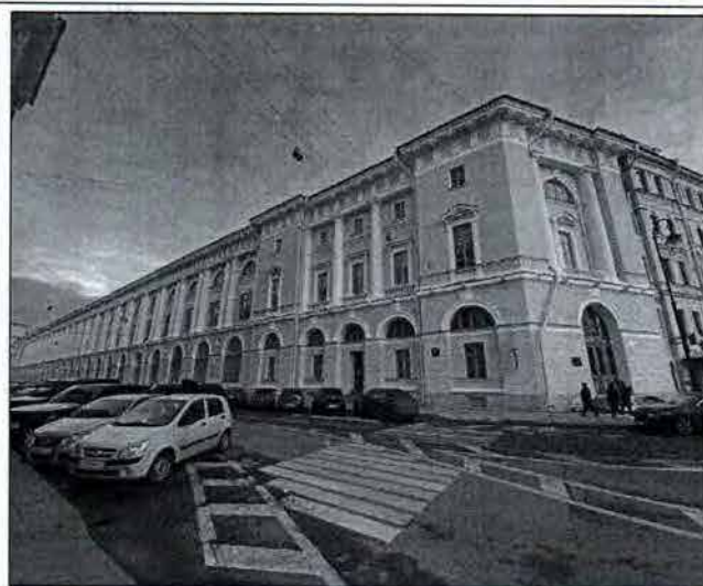
8. Общий вид на объект культурного наследия со стороны пл. Ломоносова. Фото от 09.11.2021 г.
