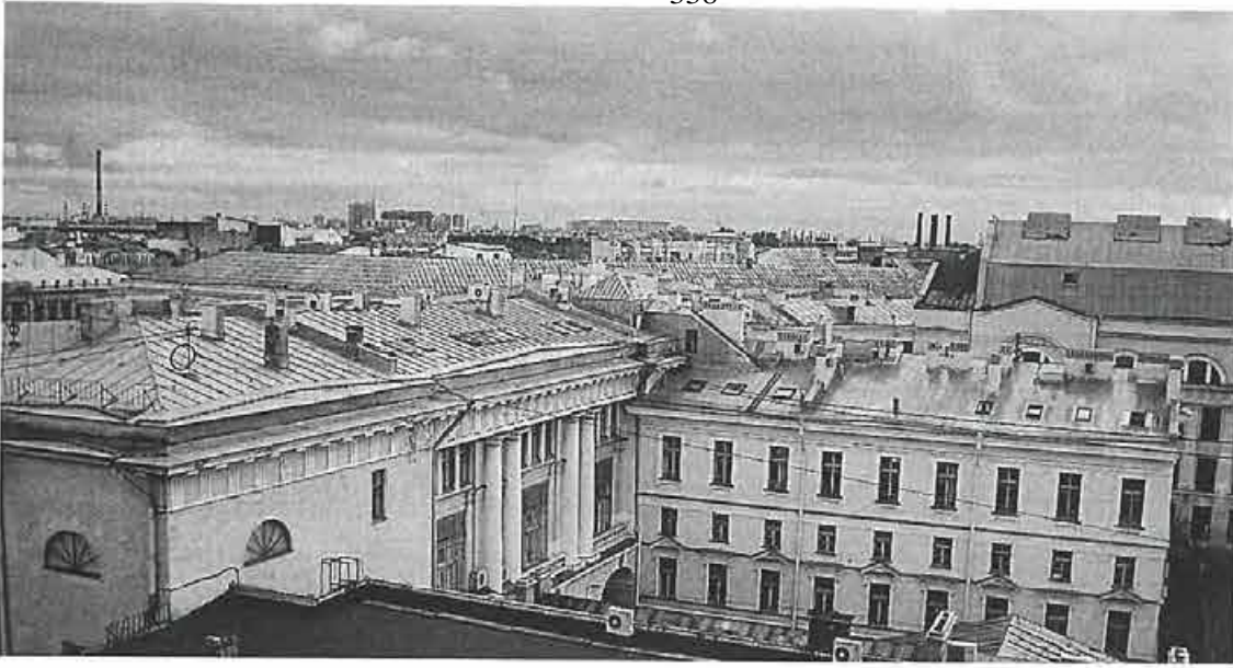
Вид на крышу ОКН
