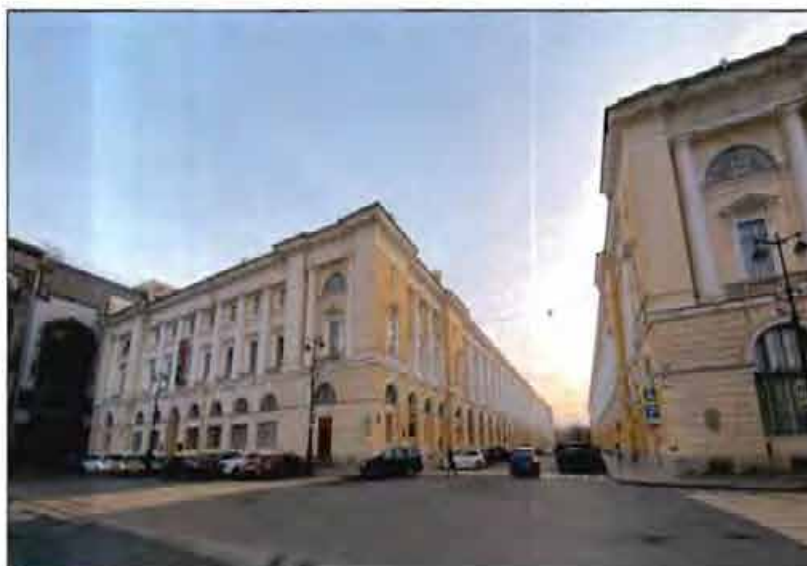
1. Общий вид на объект культурного наследия со стороны пл. Островского. Фото от 09.11.2021 г.
