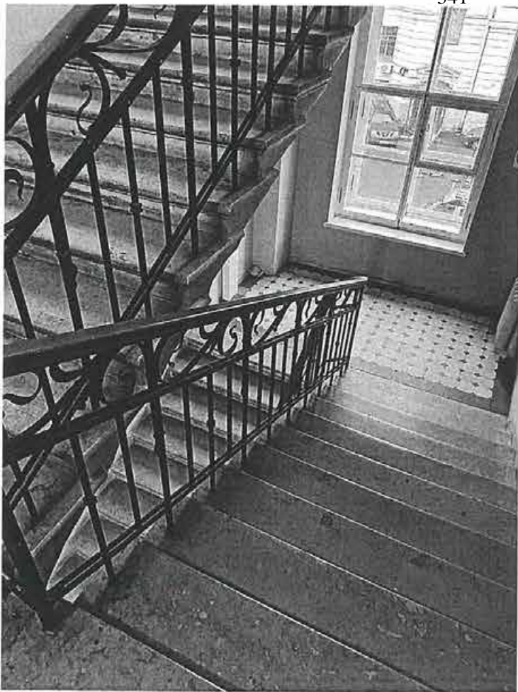
Фрагмент интерьеров. Лестница
