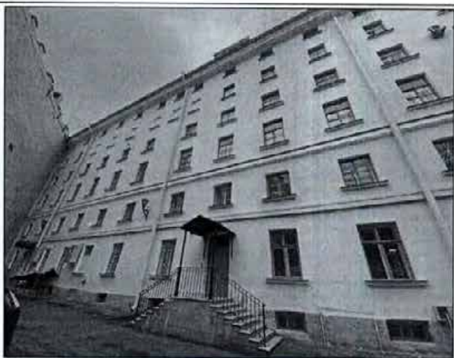
19. Западный дворовый фасад. Дополнительное инженерное оборудование на фасаде. Фото от 09.11.2021 г.
