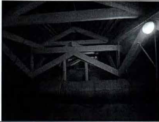
32. Фрагмент стропильной системы. Фото от 09.11.2021 г.
