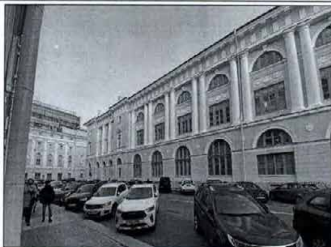
3. Общий вид на западный фасад со стороны ул. Зодчего Росси. Фото от 09.11.2021 г.
