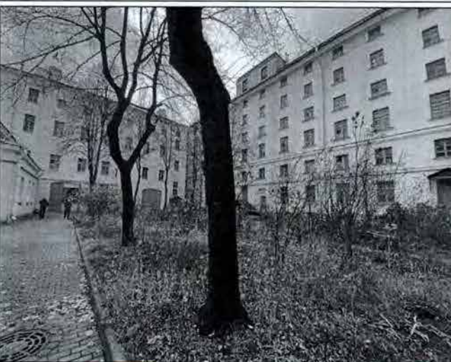
17. Дворовые фасады. Северный двор. Фото от 09.11.2021 г.
