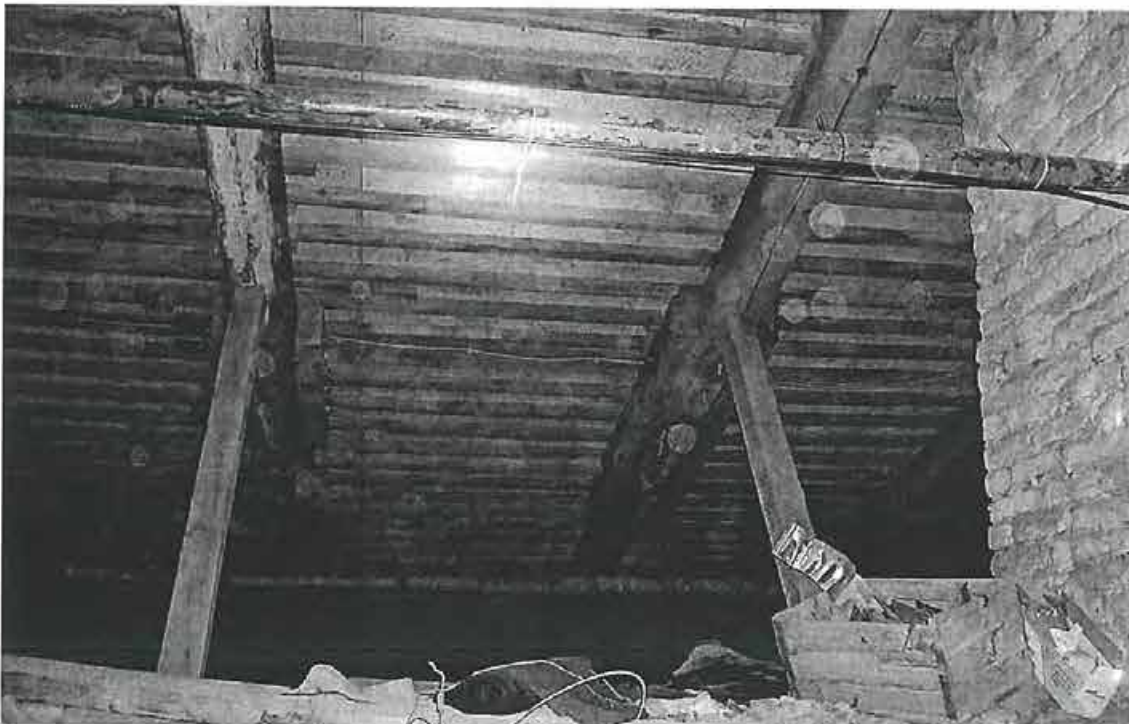
Чердачное помещение ОКН
