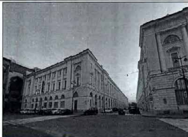
1. Общий вид на объект культурного наследия с северной стороны. Фото от 09.11.2021 г.
