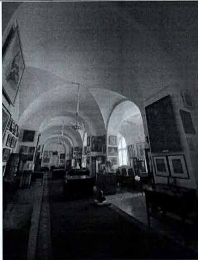
40. Помещения музея в уровне 1-го этажа. Своды. Фото от 09.11.2021 г.
