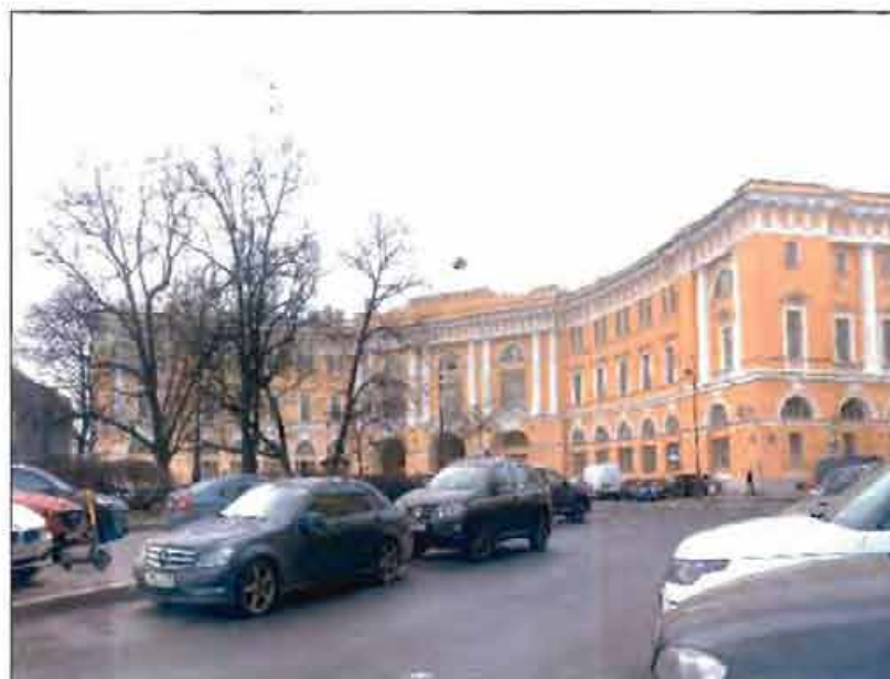
2. Южный фасад объекта культурного наследия, вид со стороны пл. Ломоносова. Фото от 19.11.2021 г.
