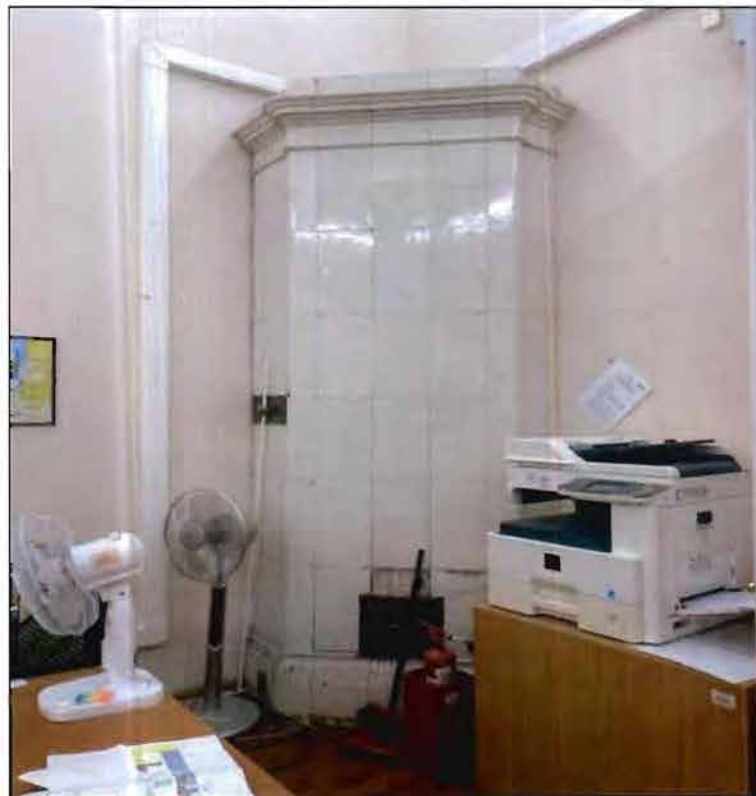
48. Печь белого изразца с профилированным карнизом (пом. 38-Н (8)) в уровне 5-го этажа. Фото от 16.11.2021 г.
