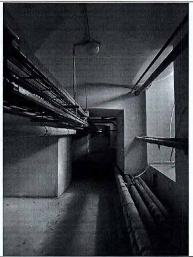
43. Подвальные помещения. Фото от 09.11.2021 г.
