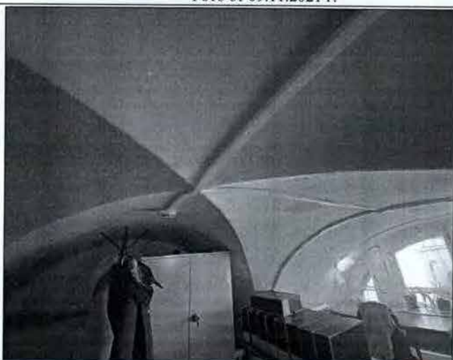
64. Оконный проем в уровне антресоли пом. 38-Н(50). Фото от 09.11.2021 г.
