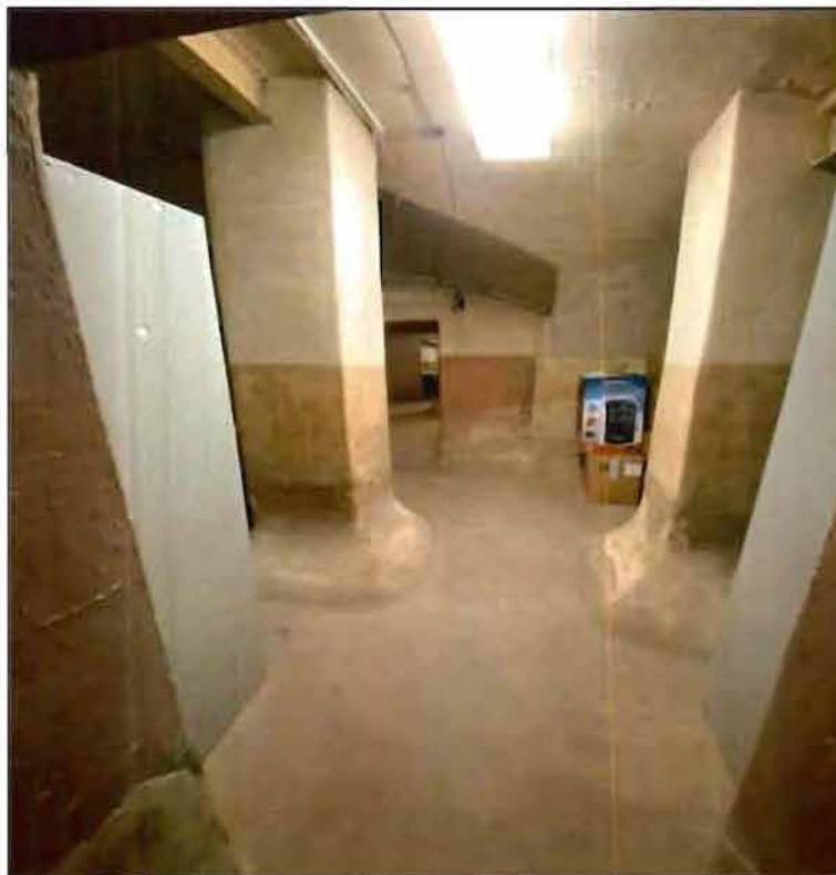
52. Пилоны подвальных помещений. Фото от 19.11.2021 г.
