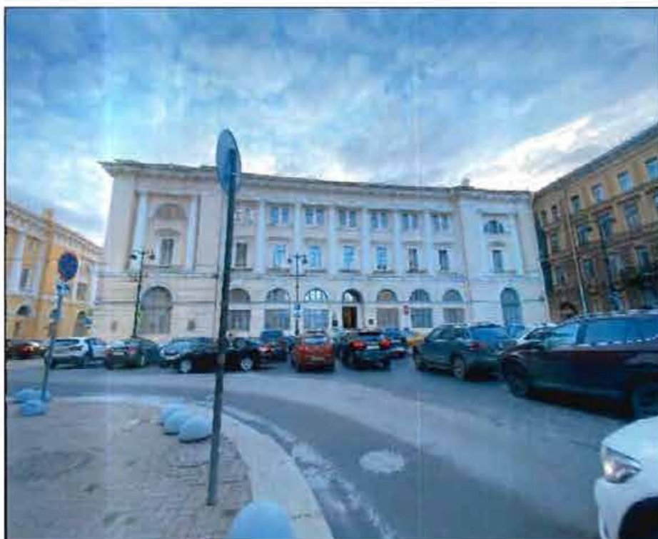
3. Общий вид на северный фасад со стороны по. Островского. Фото от 19.11.2021 г.
