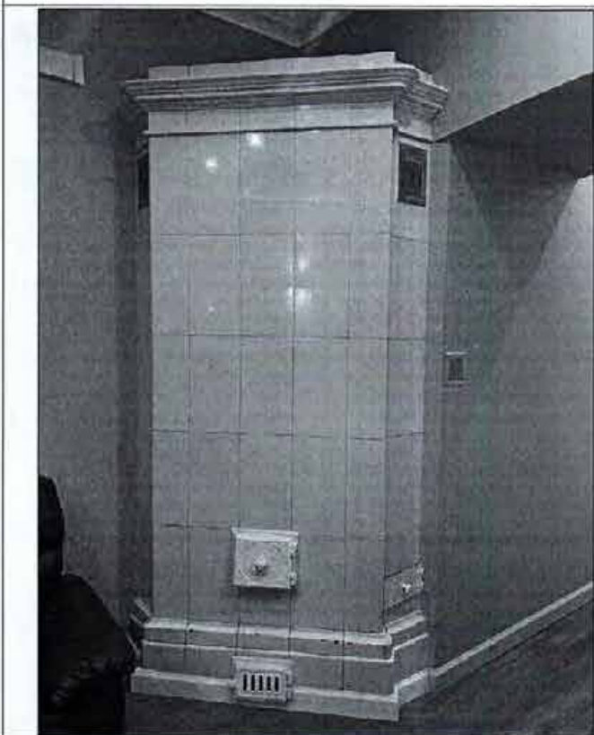
70. Печь в уровне 1-го этажа пом. 38-Н(5). Фото от 09.11.2021 г.
