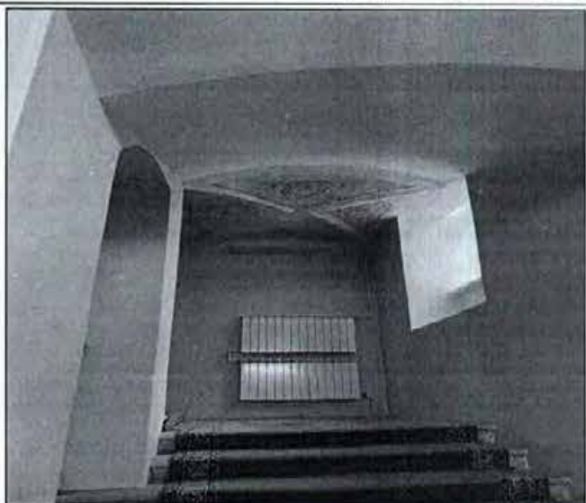
21. Живописное оформление потолка межэтажной лестничной площадки в уровне 2-го этажа лицевого корпуса по ул. Зодчего Росси (парадная лестница). Фото от 09.11.2021 г.
