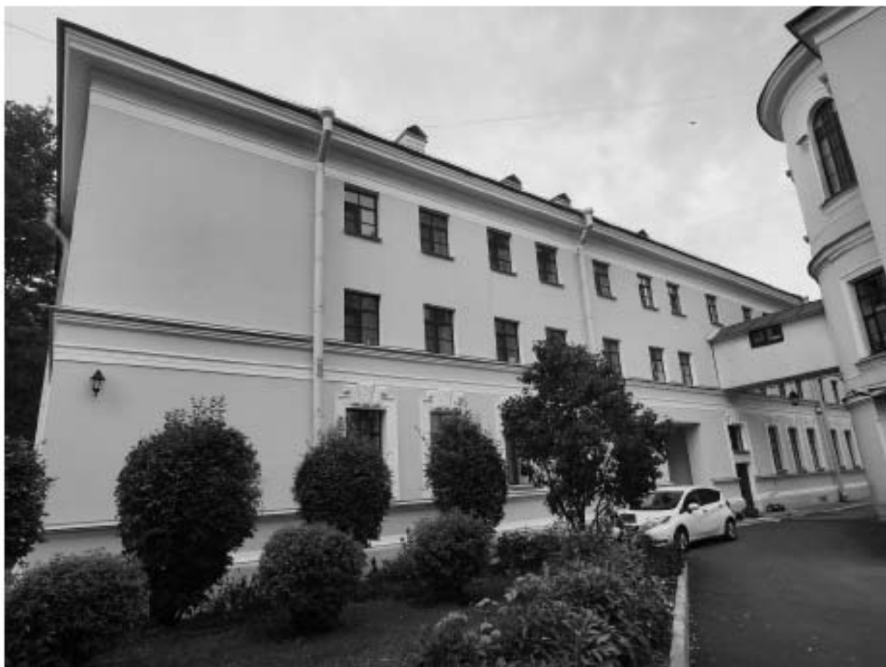
Фото 11. Южный фасад ОКН.
