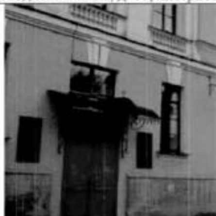
2. Дверной проем южного фасада.
