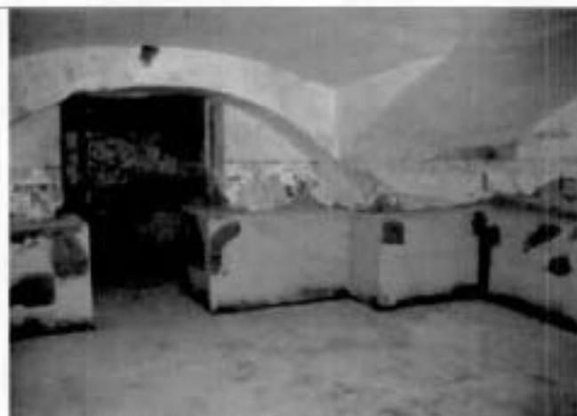
9. Подвал. Академический квартирный флигель.
