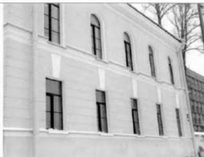
4. Южный фасад. Академический квартирный флигель.
