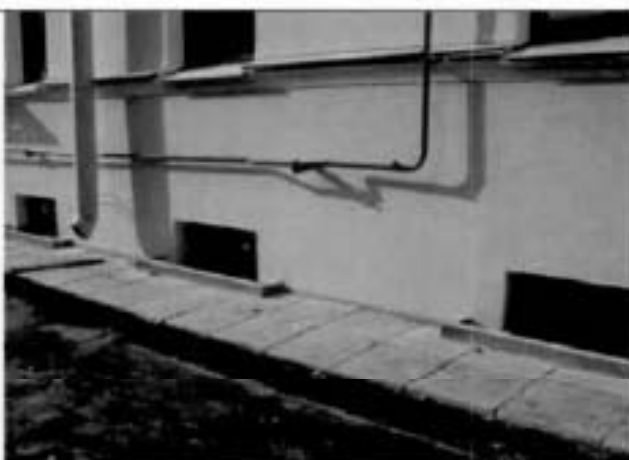
5. Фрагмент западного фасада. Академический квартирный флигель.
