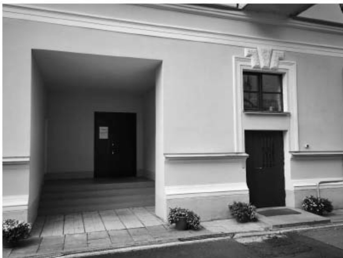
Фото 3. Вход в Лазарет с крыльцом в нише и входная дверь в служебное общежитие сотрудников.
