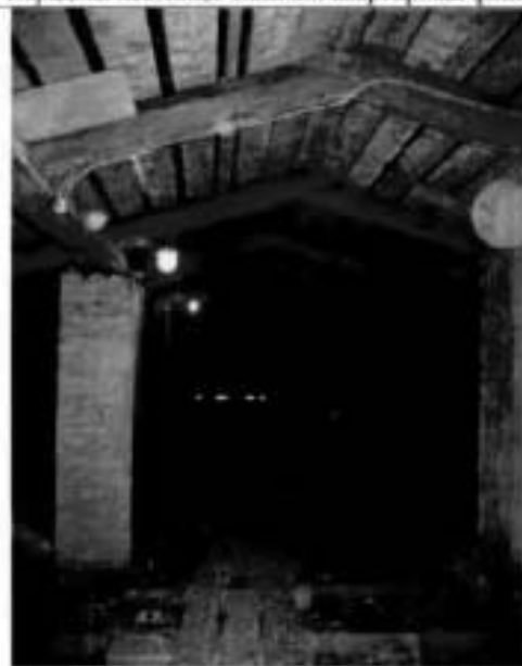
20. Конструкции крыши. Казачий квартирный флигель.
