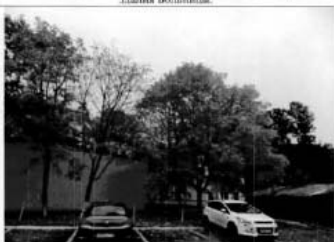
8. Вид со стороны западного фасада Служебного корпуса.
