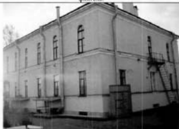
12. Восточный, северный фасады. Казачий квартирный флигель.
