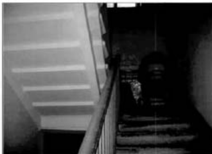
9. Лестница. Общий вид
