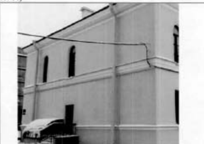
2. Северный фасад. Академический квартирный флигель.
