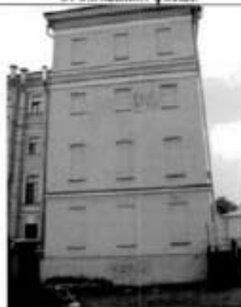
5. Фрагмент северного фасада.
