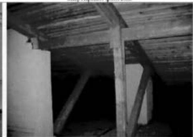
8. Конструкция крыши. Академический квартирный флигель.
