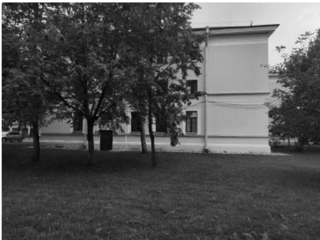
Фото 9. Северный фасад ОКН.
