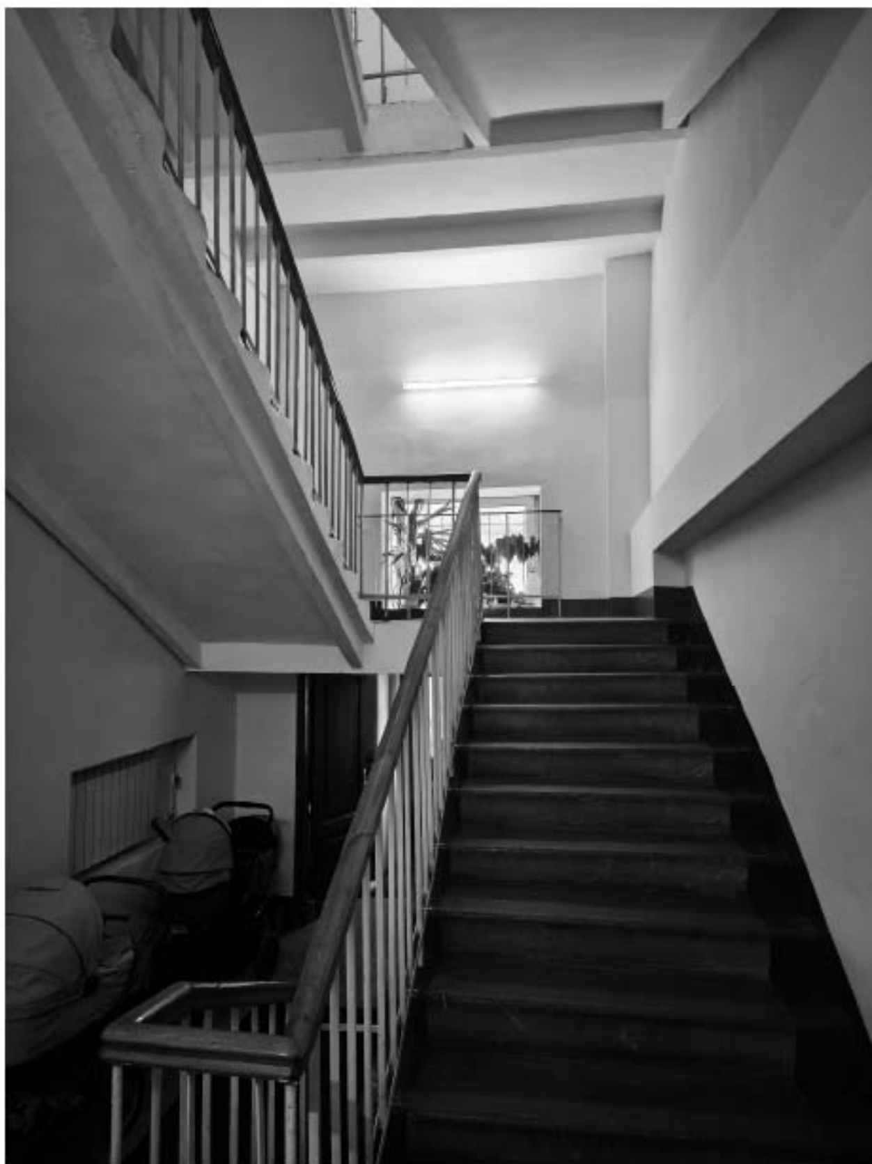
Фото 14. Лестница на второй этаж в части общежития сотрудников.
