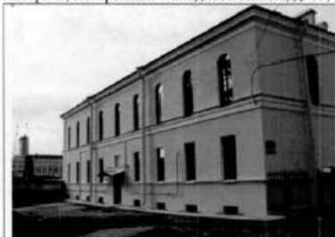
1. Восточный фасад. Академический квартирный флигель.
