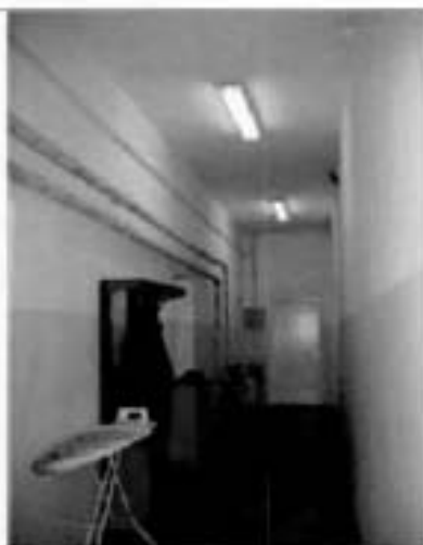
5. Коридор 1-го этажа. Общий вид
