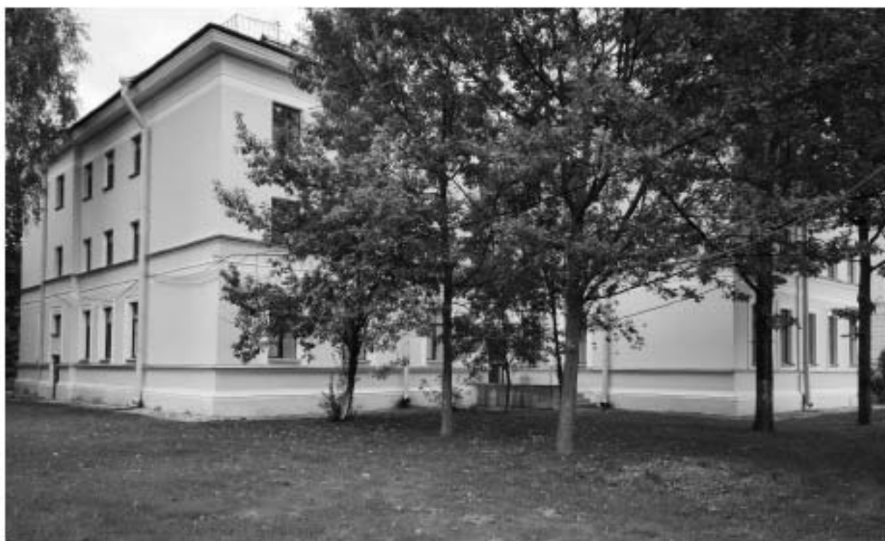
Фото 6. Северо-Западный угол ОКН.
