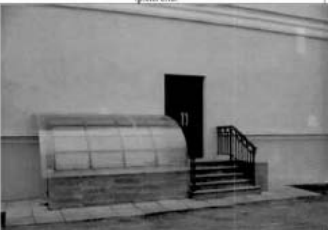
7. Входная группа восточный фасад. Академический квартирный флигель.
