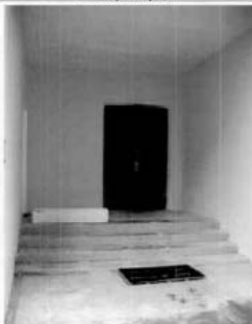
6. Дверной проем южного фасада.
