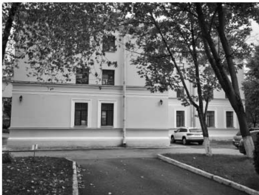
Фото 2. Вид на ОКН восточный фасад.
