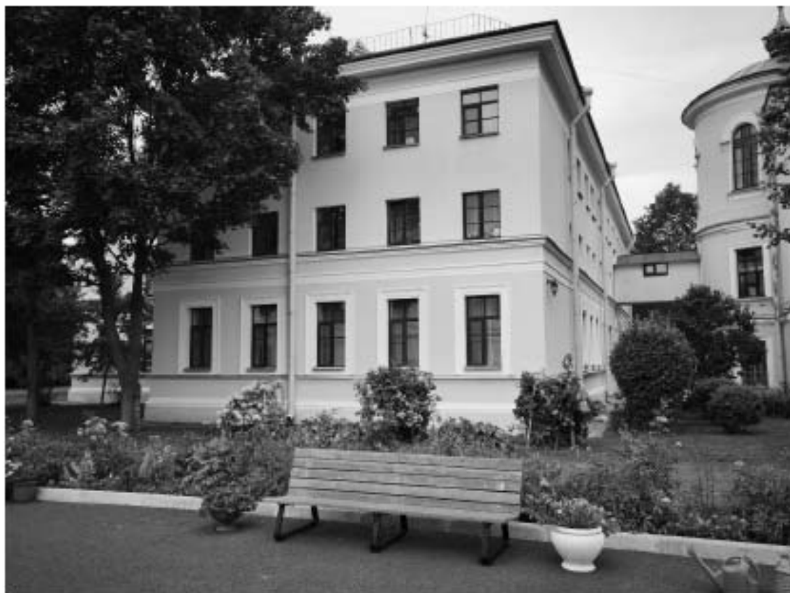
Фото 5. Вид на западный фасад ОКН.
