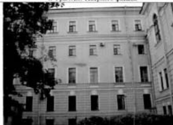
6. Фрагмент северного фасада.
