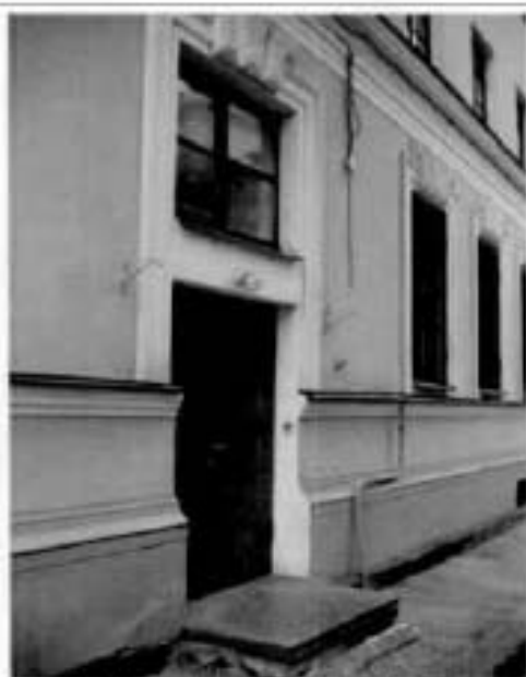
7. Дверной проем южного фасада.
