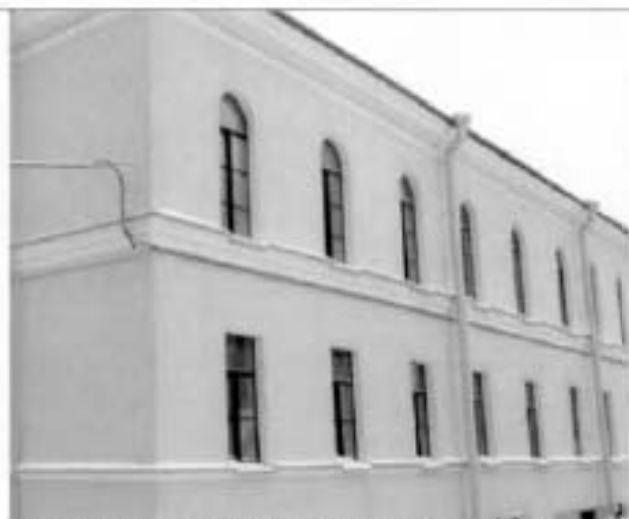
3. Западный фасад. Академический квартирный флигель.
