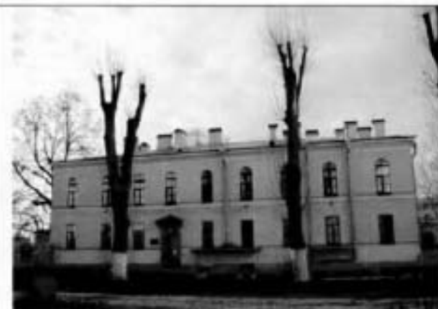
11. Восточный фасад. Казачий квартирный флигель.
