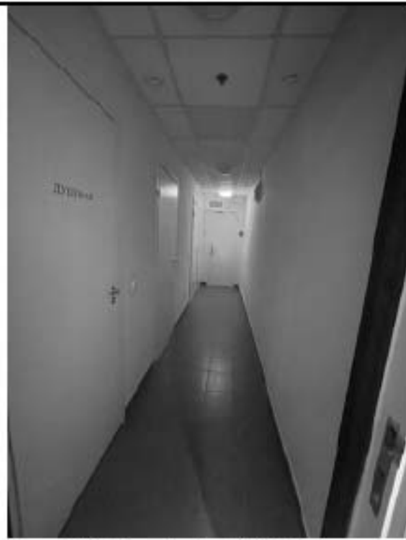
Фото 3.101 Коридор (ч.п.151) Вид в сторону Лестницы (ч.п.113)
