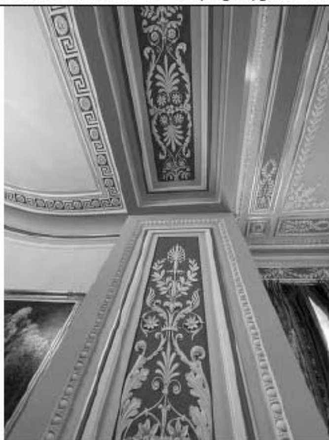
Фото 3.70 Промежуток между частями Комнаты (ч.п.139). Вид существующей отделки.
