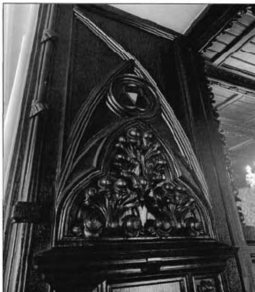
21. Деревянные резные элементы.
