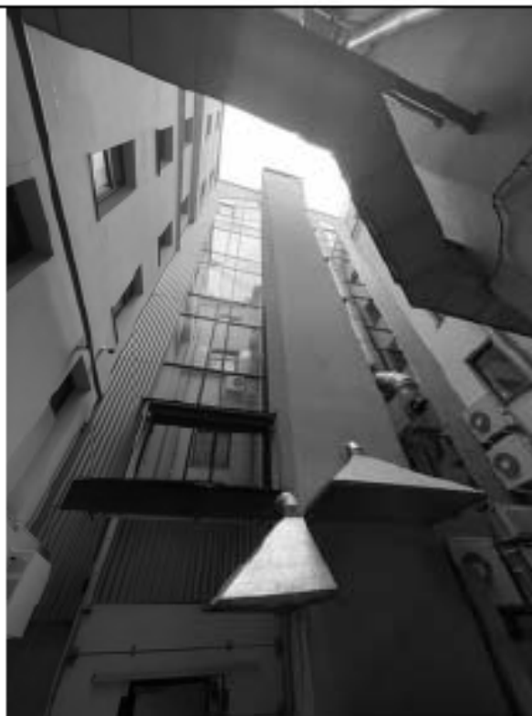
Фото 9.5 Вид дворового юго-восточного фасада здания
