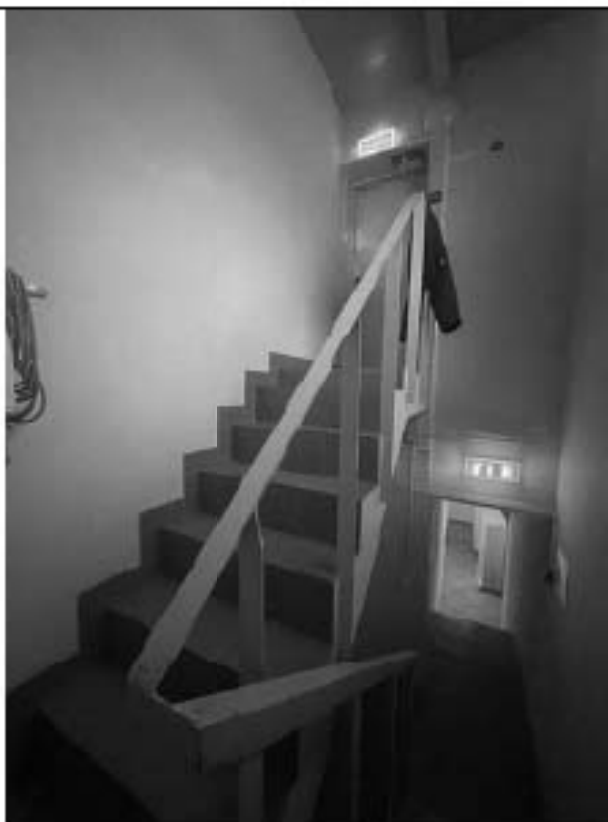
Фото 8.1 Лестница (ч.п.291). Выход на кровлю здания.
