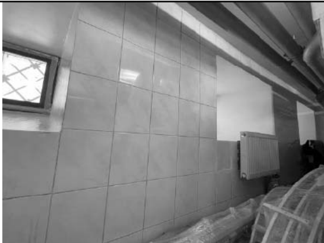
Фото 1.61 Кладовая (ч.п.21). Вид в сторону наружной стены здания
