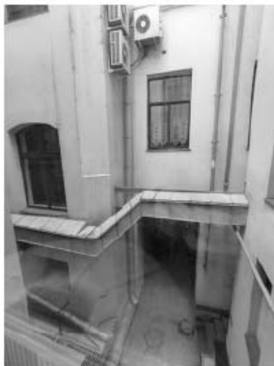
Фото 9.4 Вид дворового северо-западного фасада здания
