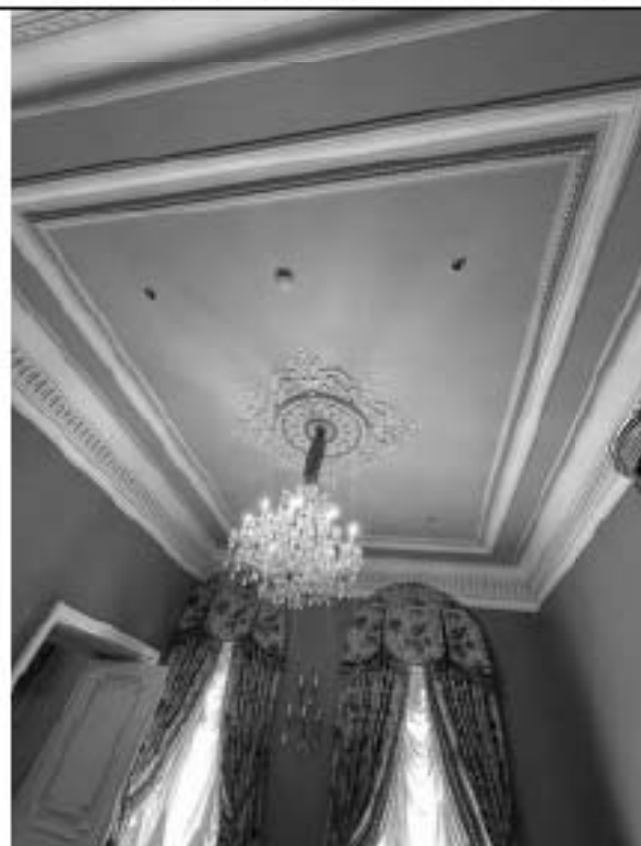
Фото 5.92 Комната (ч.п.214) Вид в сторону наружной стены здания. Вид потолка.
