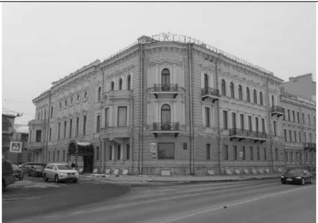
Фото 10.3 Общий вид лицевых фасадов здания с угла Шпалерной улицы и набережной Кутузова
