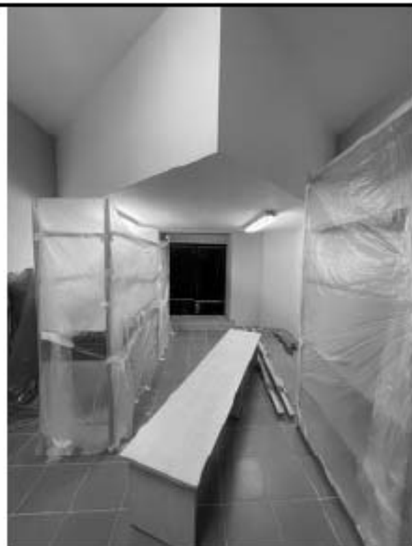
Фото 5.113 Подсобное помещение (ч.п.194). Вид в сторону Балкона (ч.п.195)
