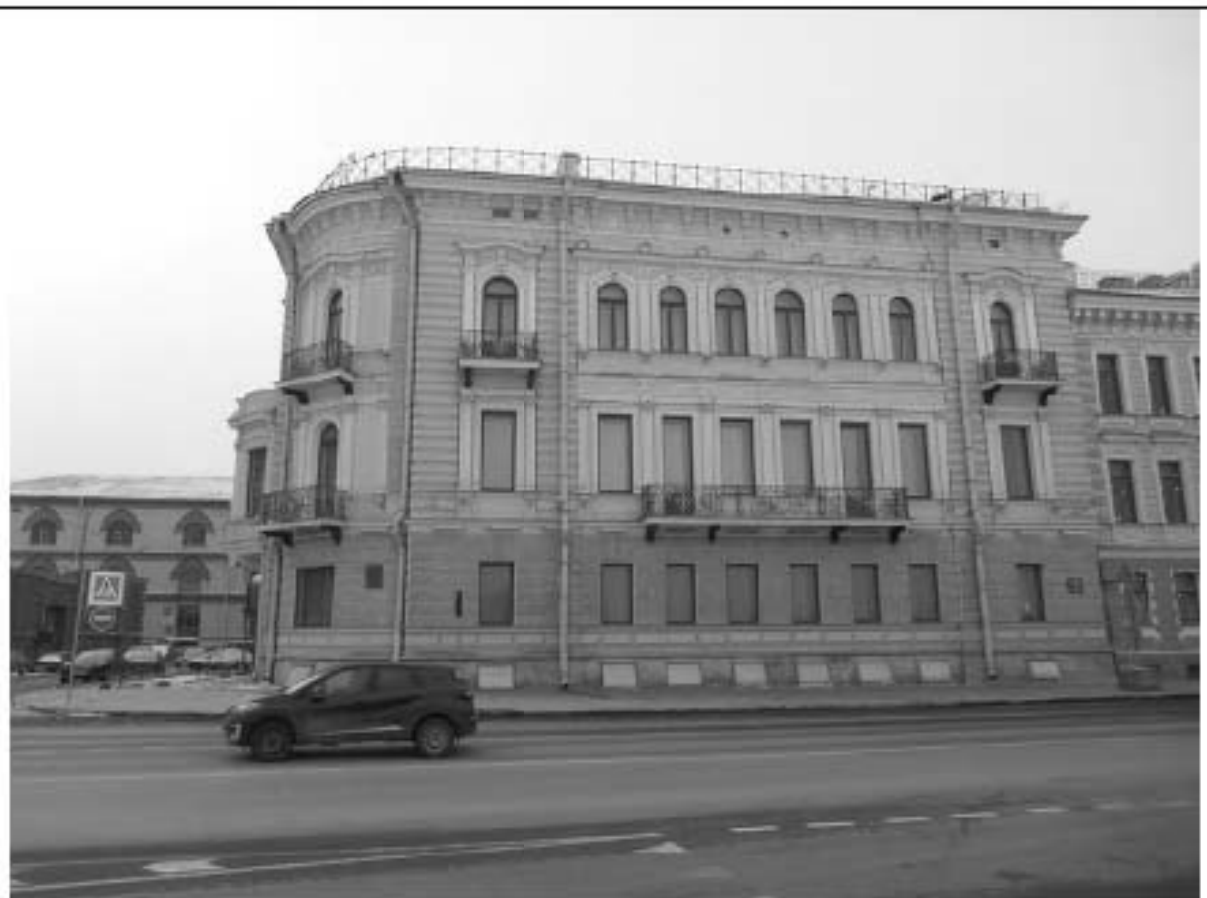
Фото 10.4 Общий вид лицевого фасада с набережной Кутузова
