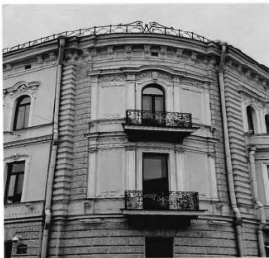
6. Фрагмент северо-восточного фасада объекта культурного наследия.
