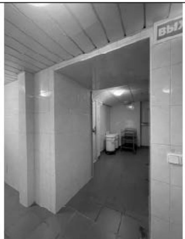
Фото 2.107 Кухня (ч.п.96) Вид в сторону Коридора (ч.п.103)
