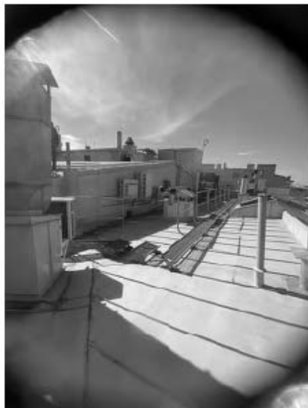
Фото 11.2 Фрагмент кровли здания
