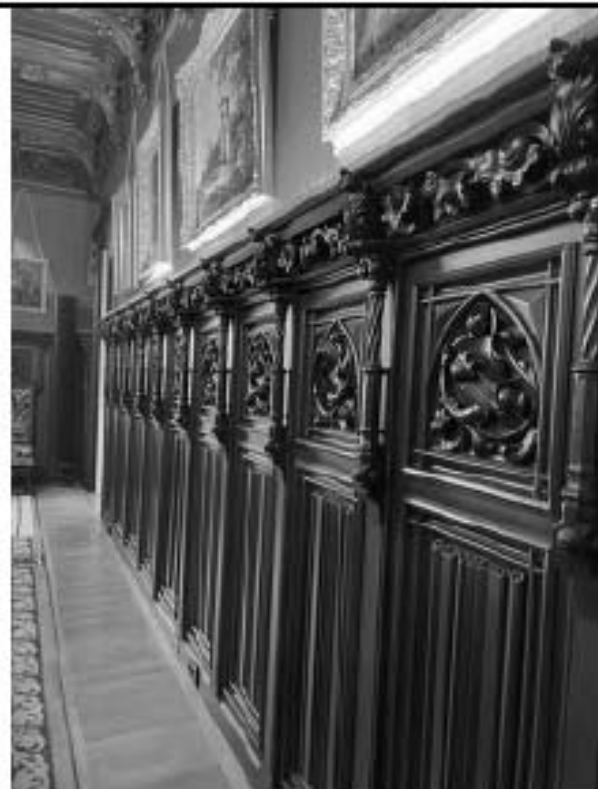
Фото 3.16 Зал (ч.п.119). Вид в сторону наружной стены здания.
