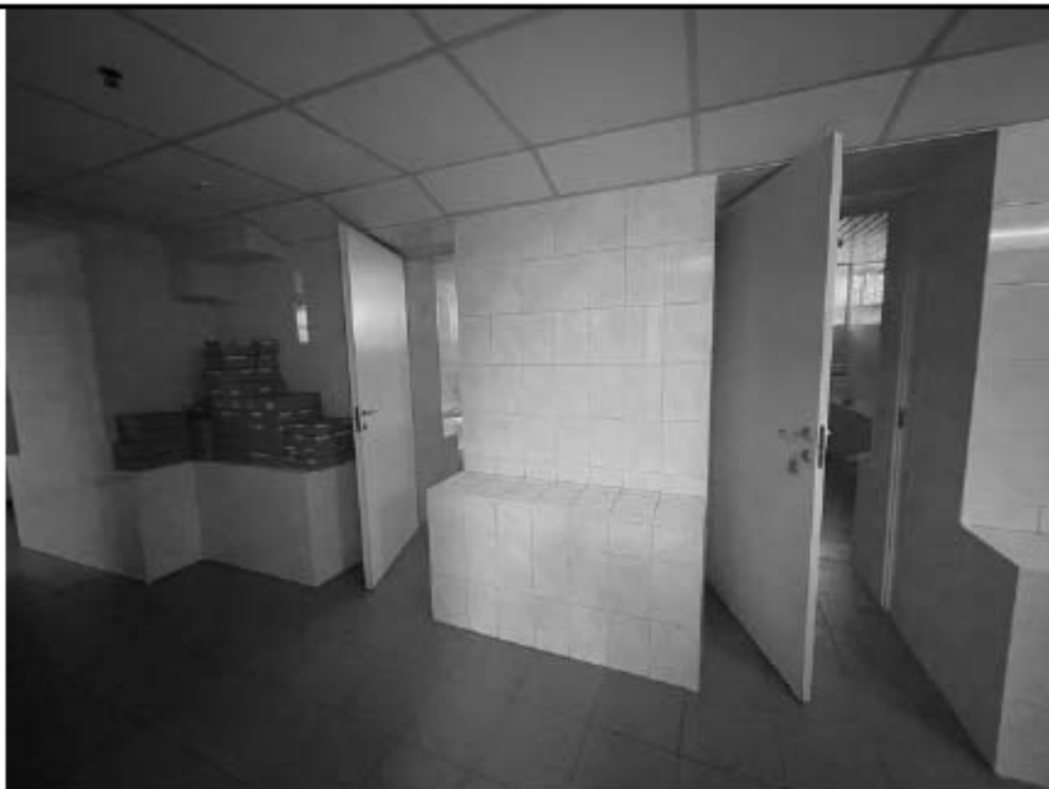
Фото 1.56 Коридор(ч.п.17). Вид в сторону Помещения (ч.п.18) и Душевой (ч.п.19)
