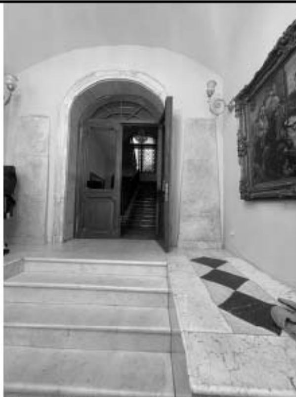
Фото 2.16 Лестница (ч.п.55) Вид в сторону Лестницы (ч.п.56)
