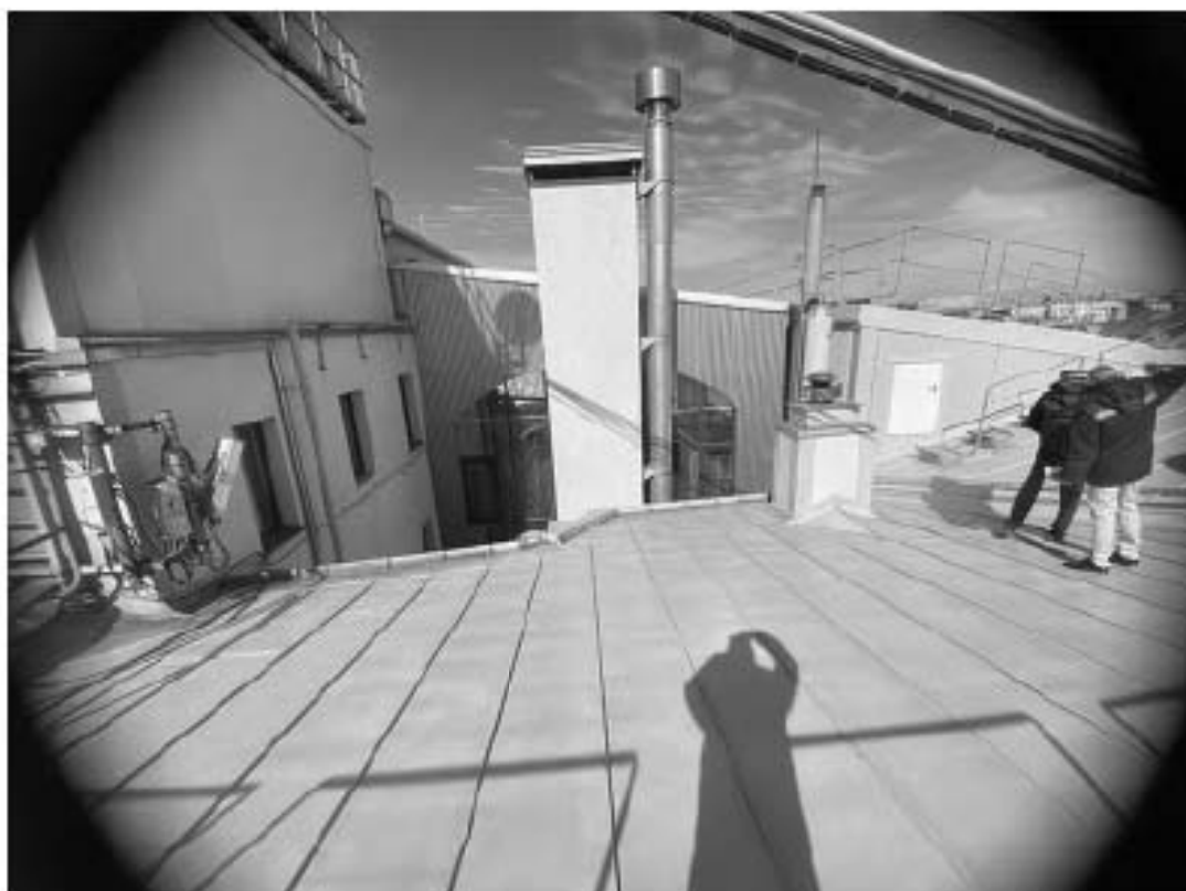
Фото 11.6 Фрагмент кровли здания
