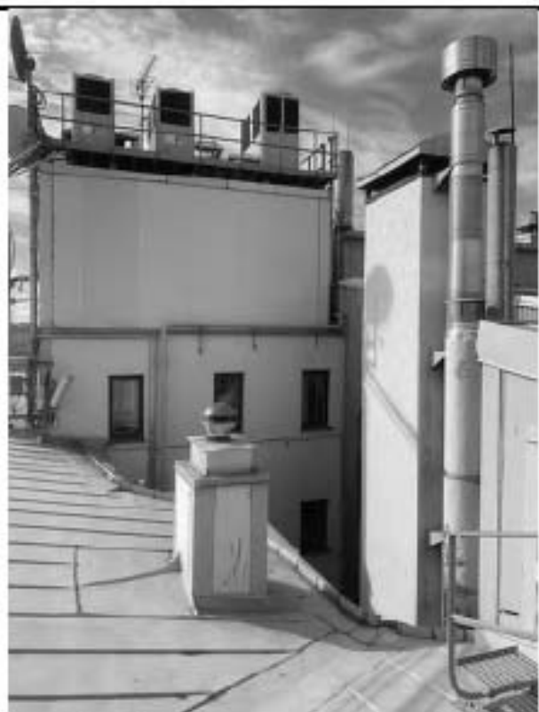
Фото 11.5 Фрагмент кровли здания
