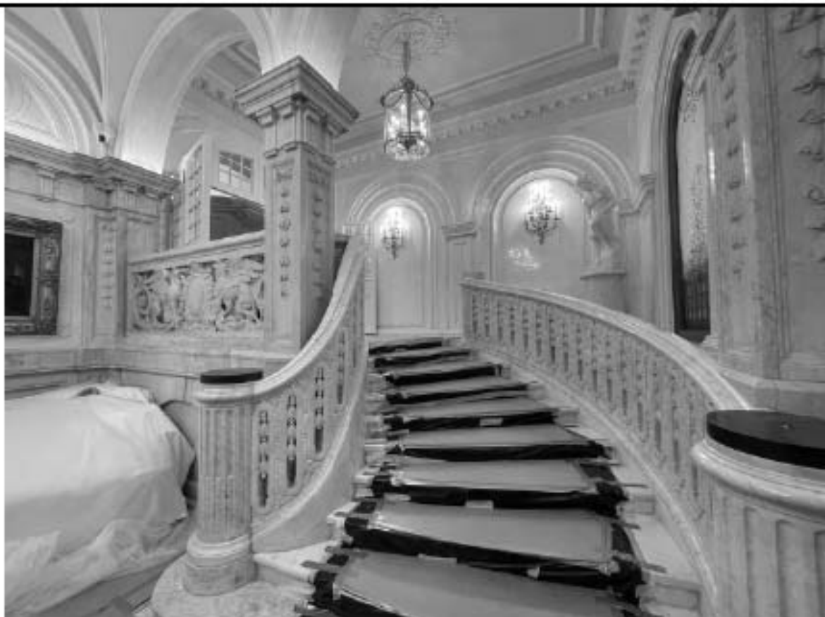
Фото 2.70 Вестибюль (ч.п.84). Вид лестницы.
