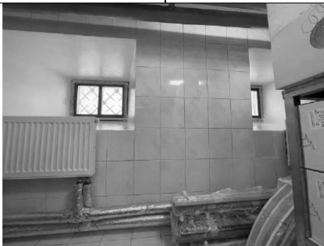
Фото 160 Кладовая (ч.п.21). Вид в сторону наружной стены здания
