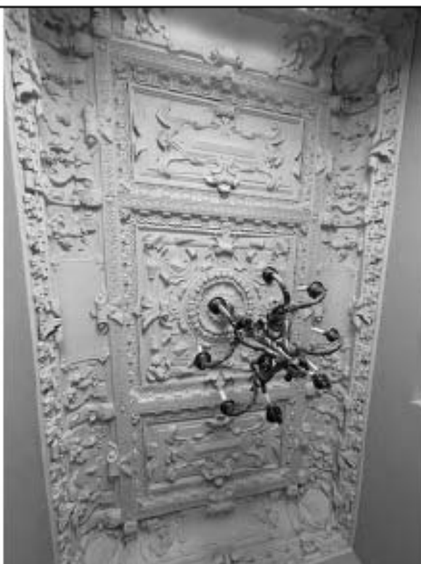
Фото 3.58 Коридор (ч.п.136) Вид потолка
