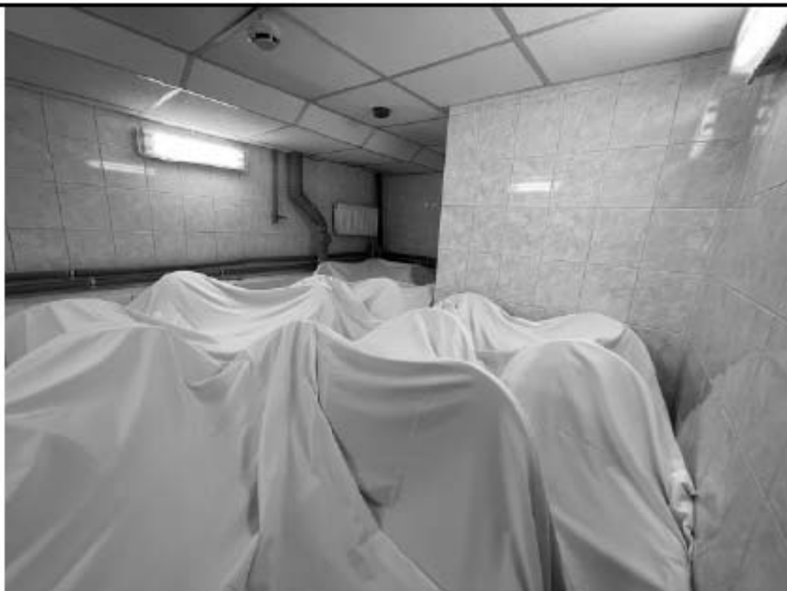
Фото 1.67 Кладовая (ч.п.13). Вид в сторону наружной стены здания
