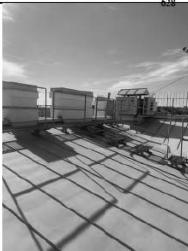
Фото 11.4 Фрагмент кровли здания
