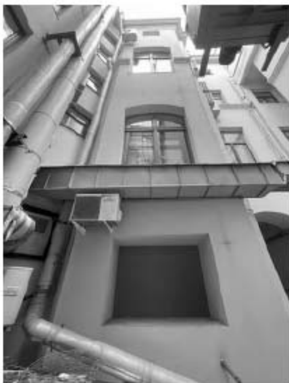
Фото 9.3 Вид дворового северо-западного фасада здания
