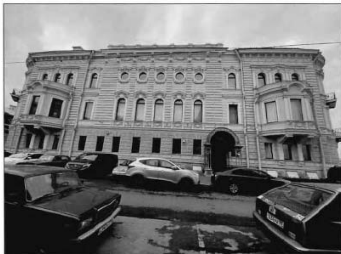
4. Восточный фасад объекта культурного наследия.
