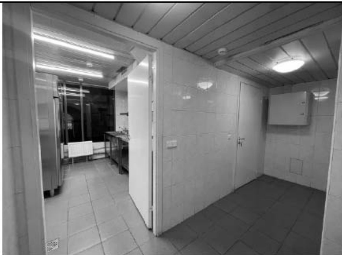
Фото 2.24 Кухня (ч.п.96). Вид в сторону Цеха(ч.п.100)
