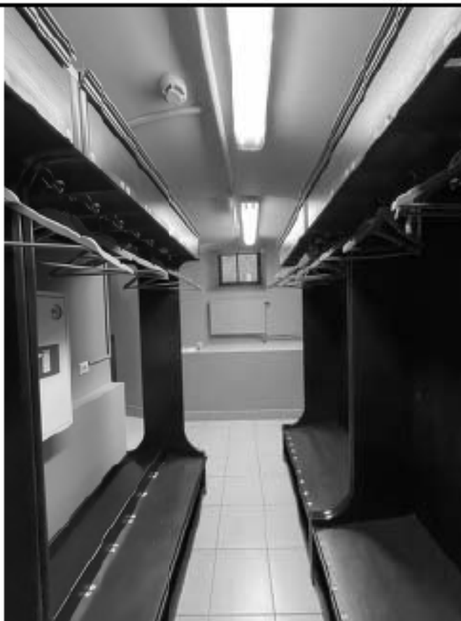
Фото 1.95 Гардеробная (ч.п.40). Вид в сторону наружной стены здания
