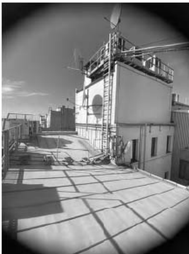
Фото 11.1 Фрагмент кровли здания
