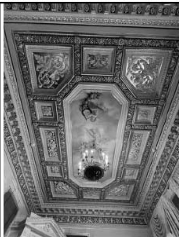
Фото 3.35 Зал (ч.п.121) Вид потолка.
