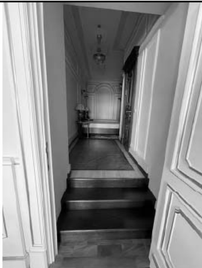
Фото 5.39 Комната (ч.п.189). Вид в сторону Коридора (ч.п.186)
