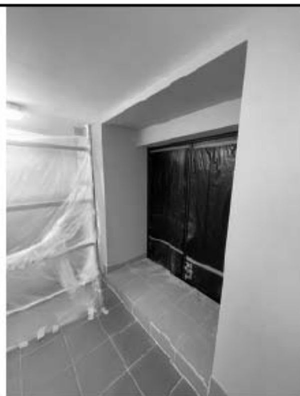
Фото 5.114 Подсобное помещение (ч.п.194). Выход на Балкон (ч.п.195)
