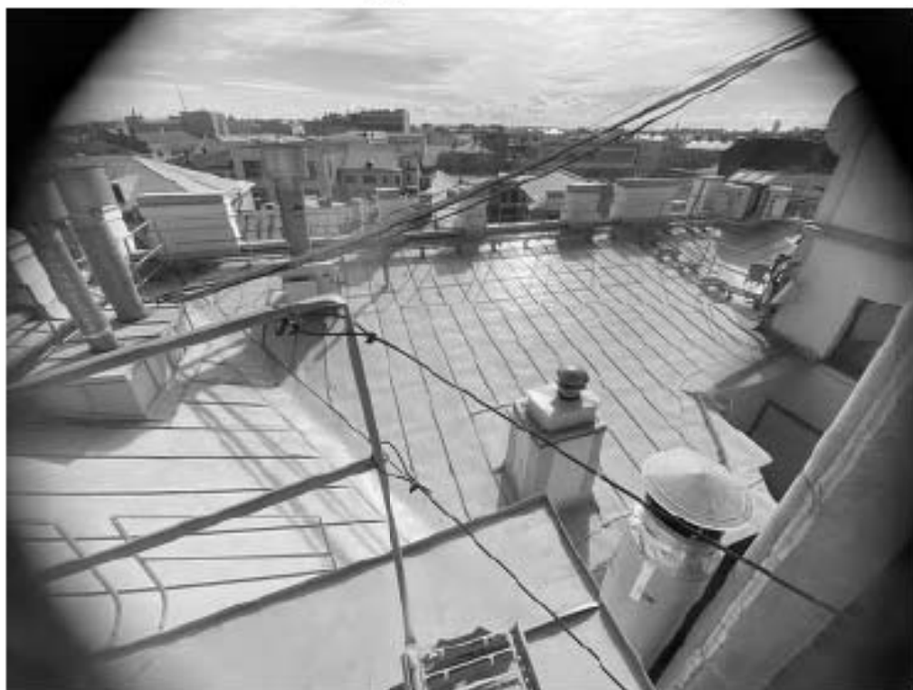
Фото 11.7 Фрагмент кровли здания
