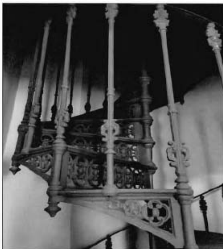
25. Чугунная, винтовая лестница.
