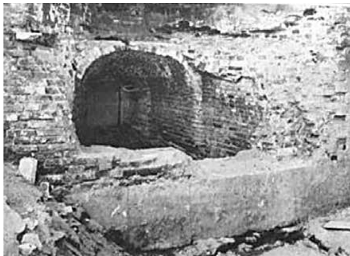
38. Правый фланк: амбразура каземата № 3 со стороны эскарпа после удаления закладки 1832 года. Внизу цоколь закладки. СНРПМ. Бенуа И. Н. 1961-1969 г // Научный архив Государственного музея истории Санкт-Петербурга
