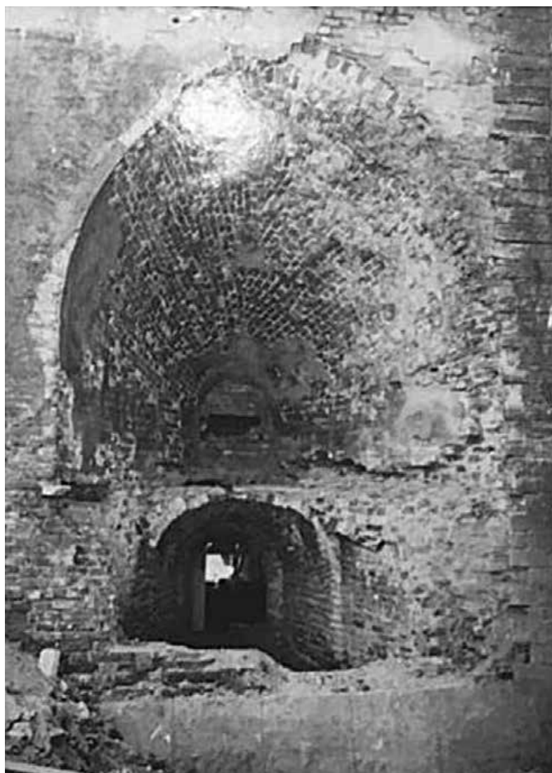
39. Правый фланк: амбразура первого яруса и второго яруса каземата №3 после удаления закладки 1832 года со стороны эскарпа. Внизу цоколь закладки. СНРПМ. Бенуа И. Н. 1961 - 1969 г. // Научный архив Государственного музея истории Санкт-Петербурга
