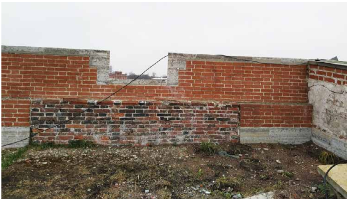
13. ОКН федерального значения «Бастион Зотов». Верхняя часть эскарповой стены правого фланка. Сохраненный фрагмент ранней кладки.
