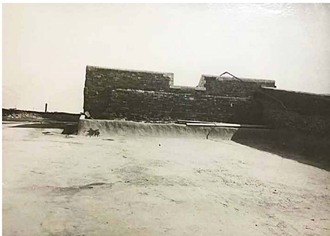
43. Правый фланк (слева часть орельона) Зотова бастиона. Укладка гидроизоляционного ковра на валу. СНРПМ. Бенуа И. Н. 1966 // Научный архив Государственного музея истории Санкт-Петербурга
