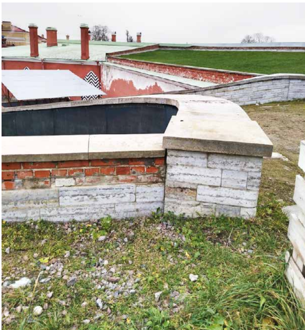
19. ОКН федерального значения «Бастион Зотов». Шпиц. Примыкание парапета аппарели к парапету валганговой стены правого фаса.
