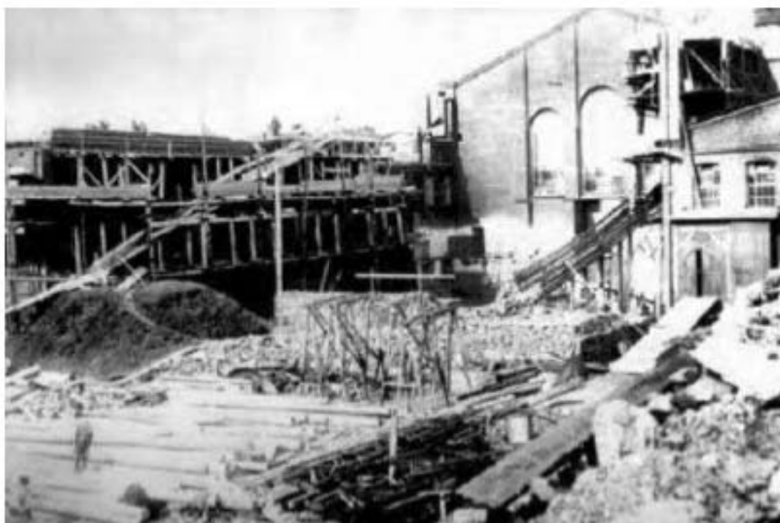
Илл. 12. Строительство электростанции. 1897–1898 гг. https://pastvu.com/
