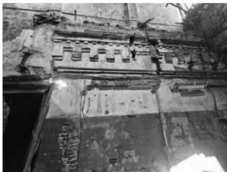
32. Фрагмент основания дымоходной трубы.
