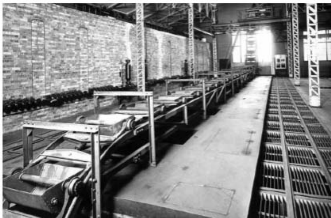
Илл. 23. В Центральной электростанции «Общества электрического освещения 1886 г.». Фото 1911 г. https://pastvu.com/
