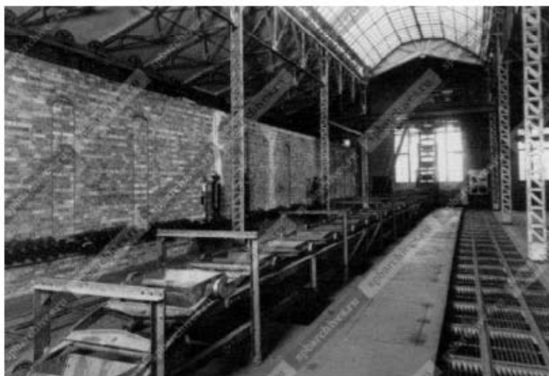
Илл. 18. Механическая подача угля на электростанции «Общества электрического освещения 1886 г.». 1911 г. ЦГА КФФД СПб. Шифр: Е 8658
