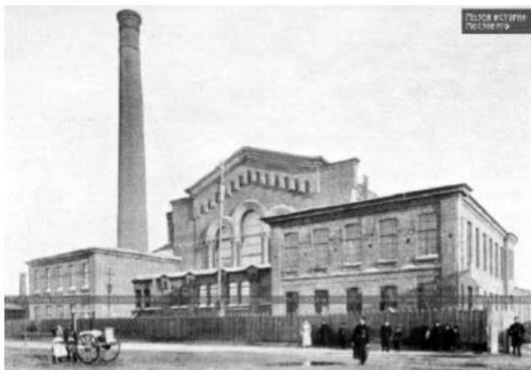
Илл. 13. Центральная станция Общества электрического освещения 1886 г. Фото 1898-1900 гг. https://pastvu.com/
