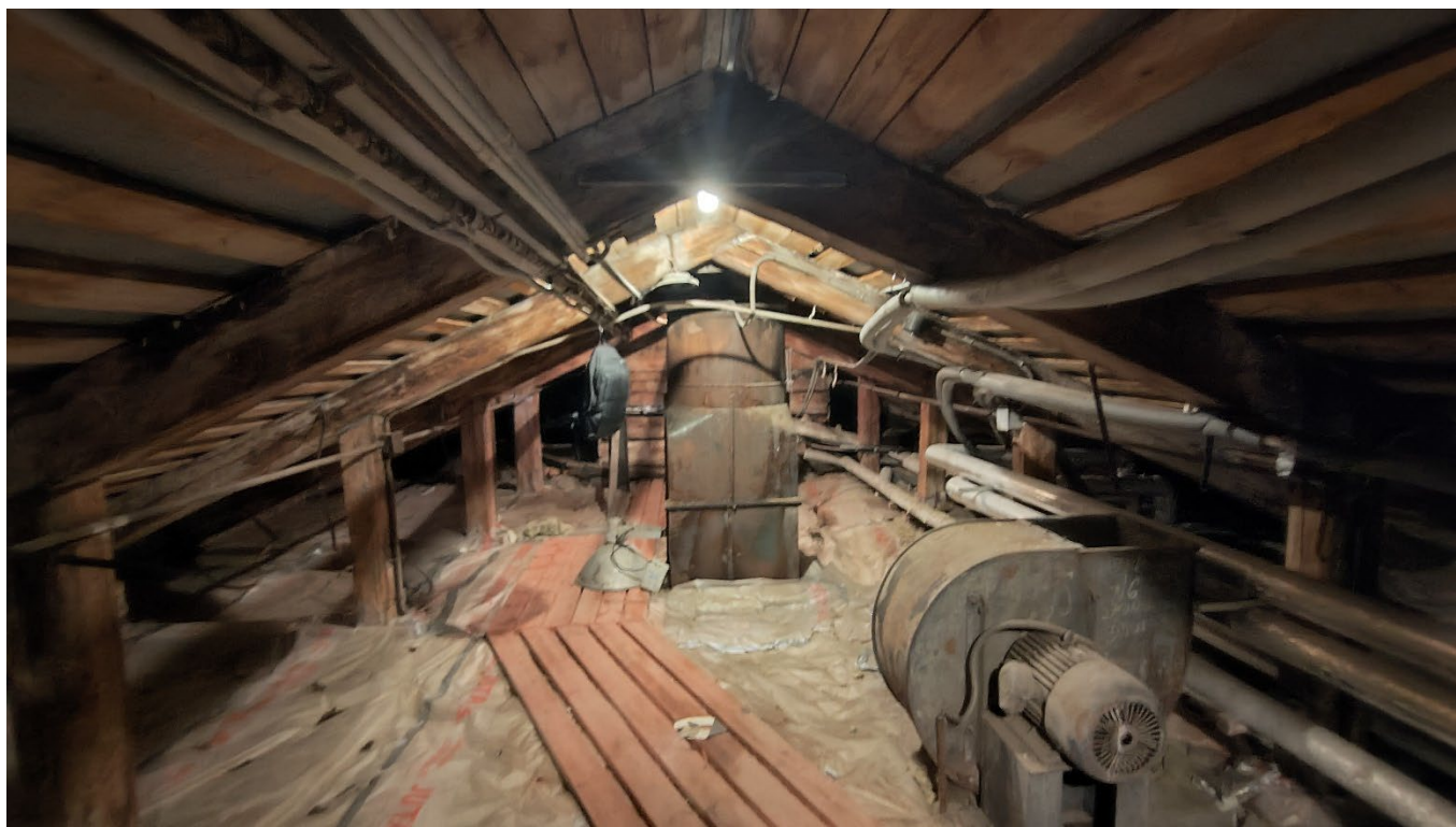
Фото 54. Объём чердака. Стропильная система. Фрагмент. Дата фотофиксации: 14.11.25
