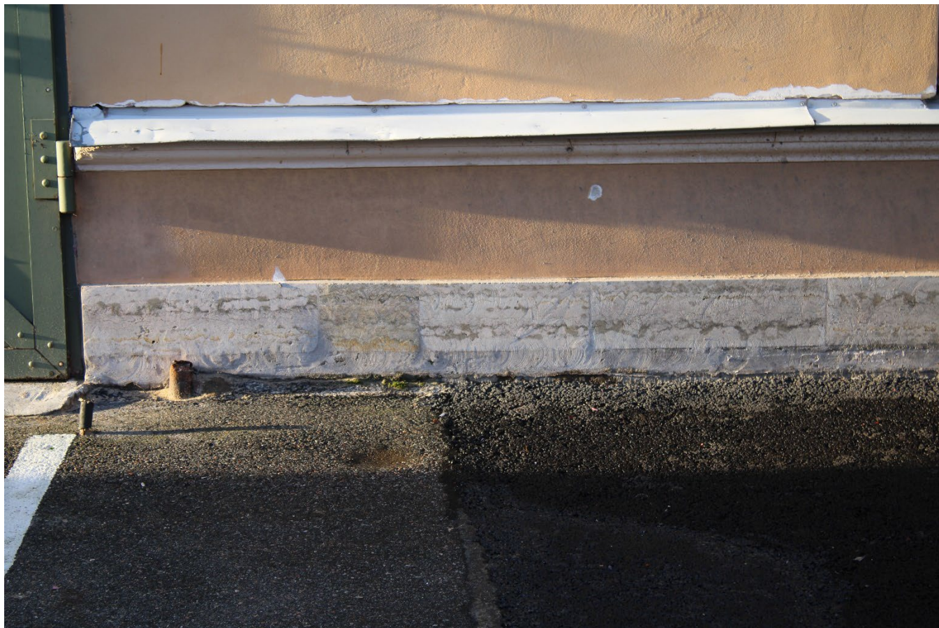
Фото 21. Материал отделки цоколя – известняк. Фрагмент. Дата фотофиксации: 14.11.25
