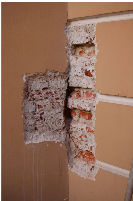
Фото 28. Зондаж на юго-восточном фасаде. Материал отделки стен – кирпич. Фрагмент. Дата фотофиксации: 14.11.25
