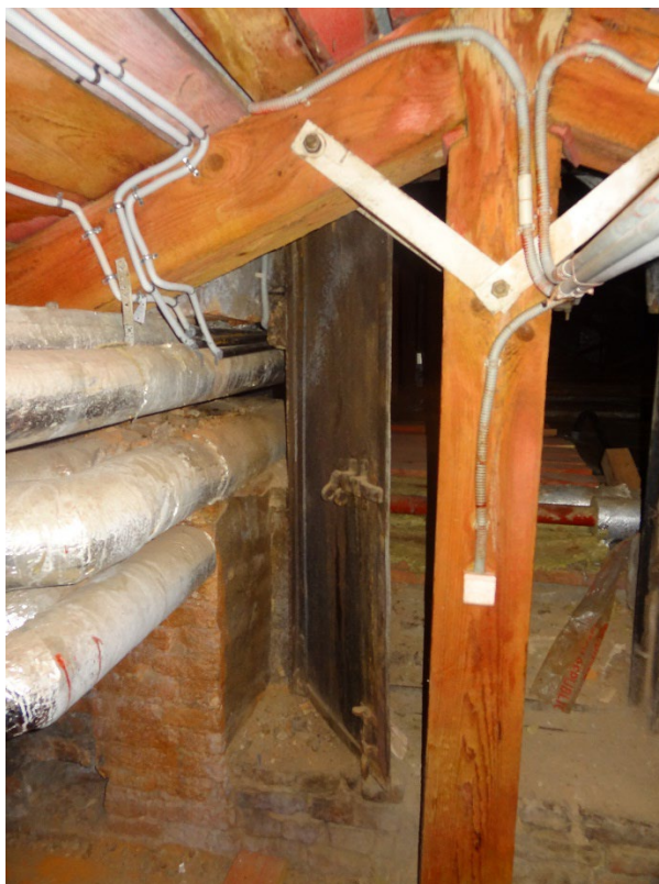
Фото 85. Металлическое дверное заполнение в проёме, соединяющем главный и юго-восточный объёмы чердака 1-го корпуса. Фрагмент. Дата фотофиксации: 14.11.25
