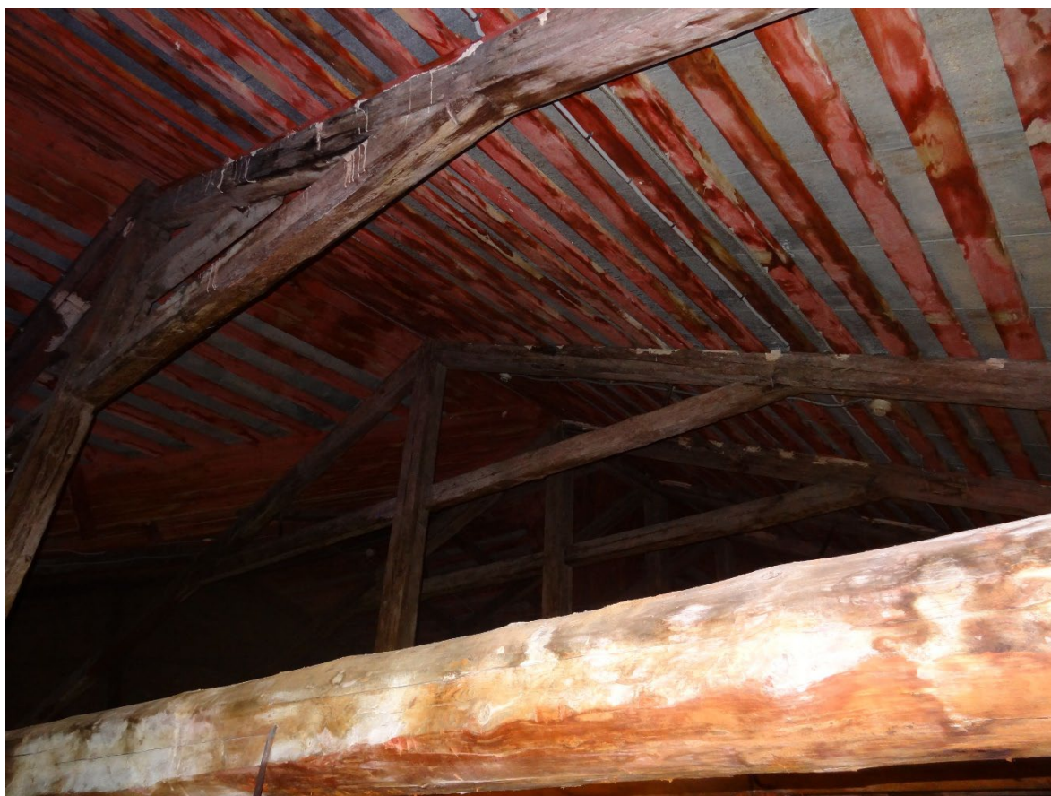
Фото 81. Стропильная система главного объёма чердака 1-го корпуса. Фрагмент. Дата фотофиксации: 14.11.25
