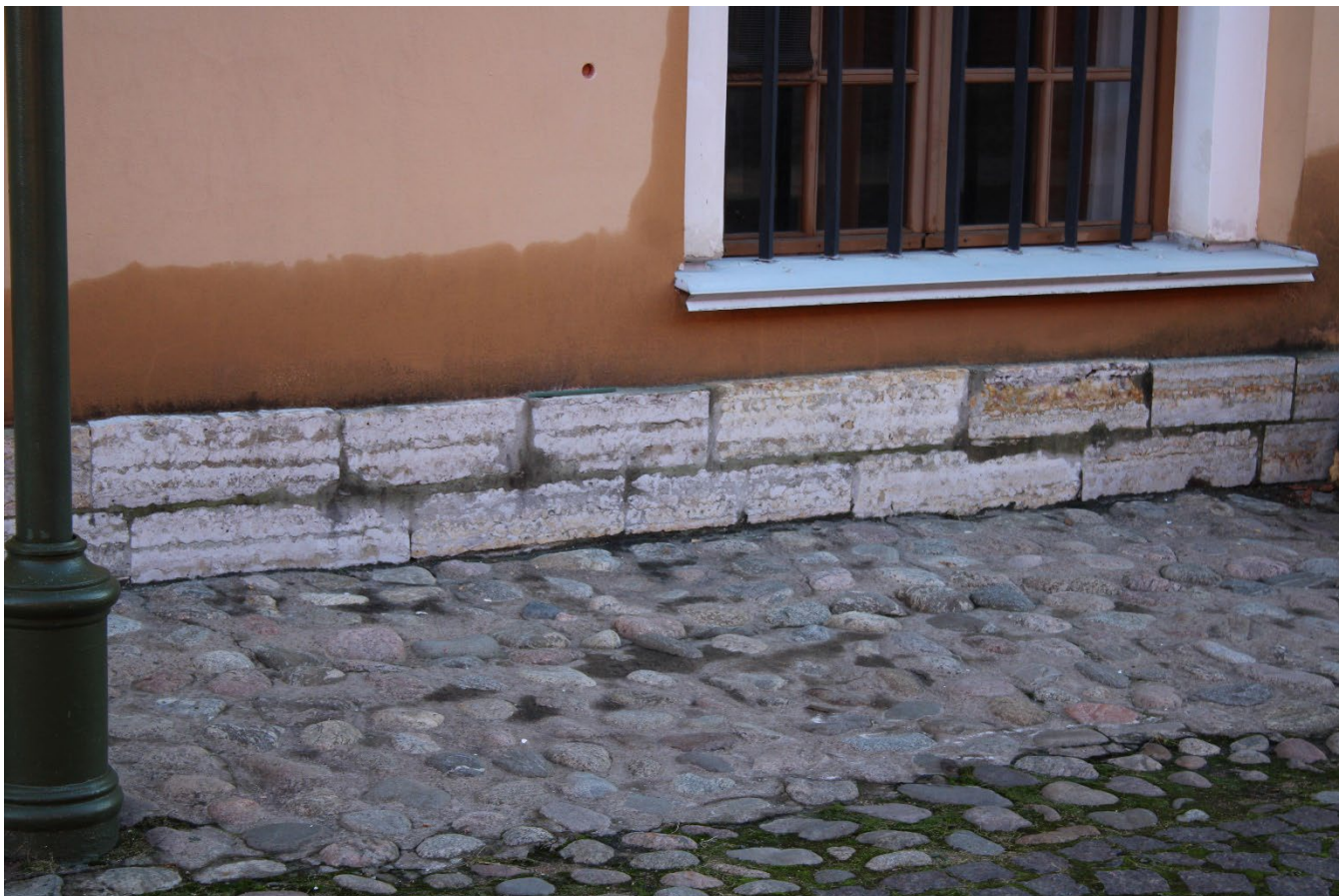
Фото 9. Отделка цоколя северного фасада – известняк. Фрагмент. Дата фотофиксации: 14.11.25
