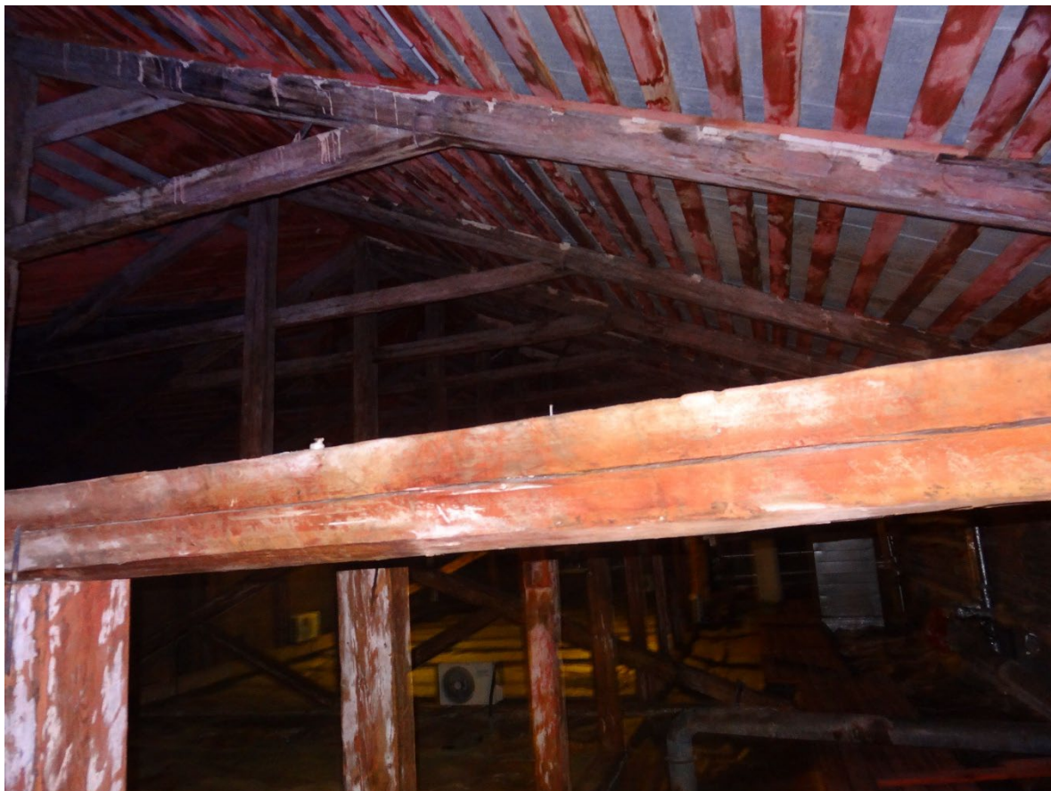
Фото 80. Стропильная система главного объёма чердака 1-го корпуса. Фрагмент. Дата фотофиксации: 14.11.25
