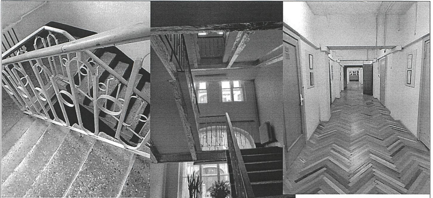
Фото 25-27. Лестница и коридор в дворовом корпусе
