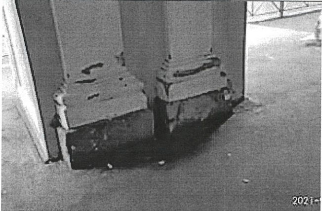
Фото 5. Фрагмент баз пилястр по Перинной линии
