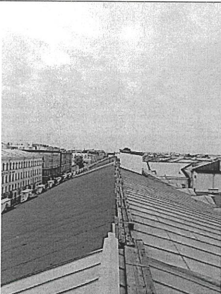
Фото 17. Кровля по Садовой линии
