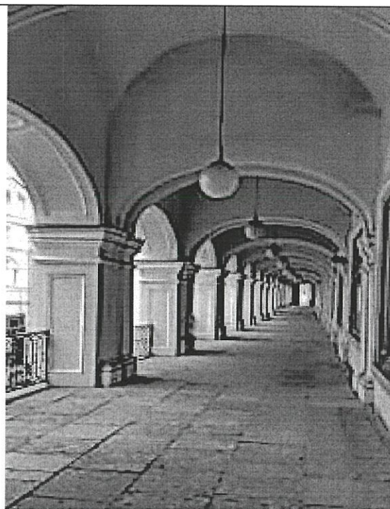
Фото 8. Крытая арочная галерея Ломоносовской линии 2 этажа
