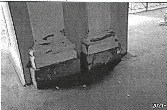
Фото 5. Фрагмент баз пилястр по Перинной линии
