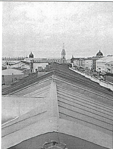
Фото 15. Кровля по Невской линии
