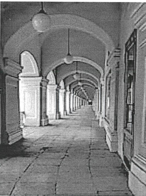
Фото 7. Крытая арочная галерея Садовой линии 1 этажа
