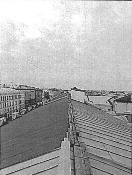
Фото 17. Кровля по Садовой линии
