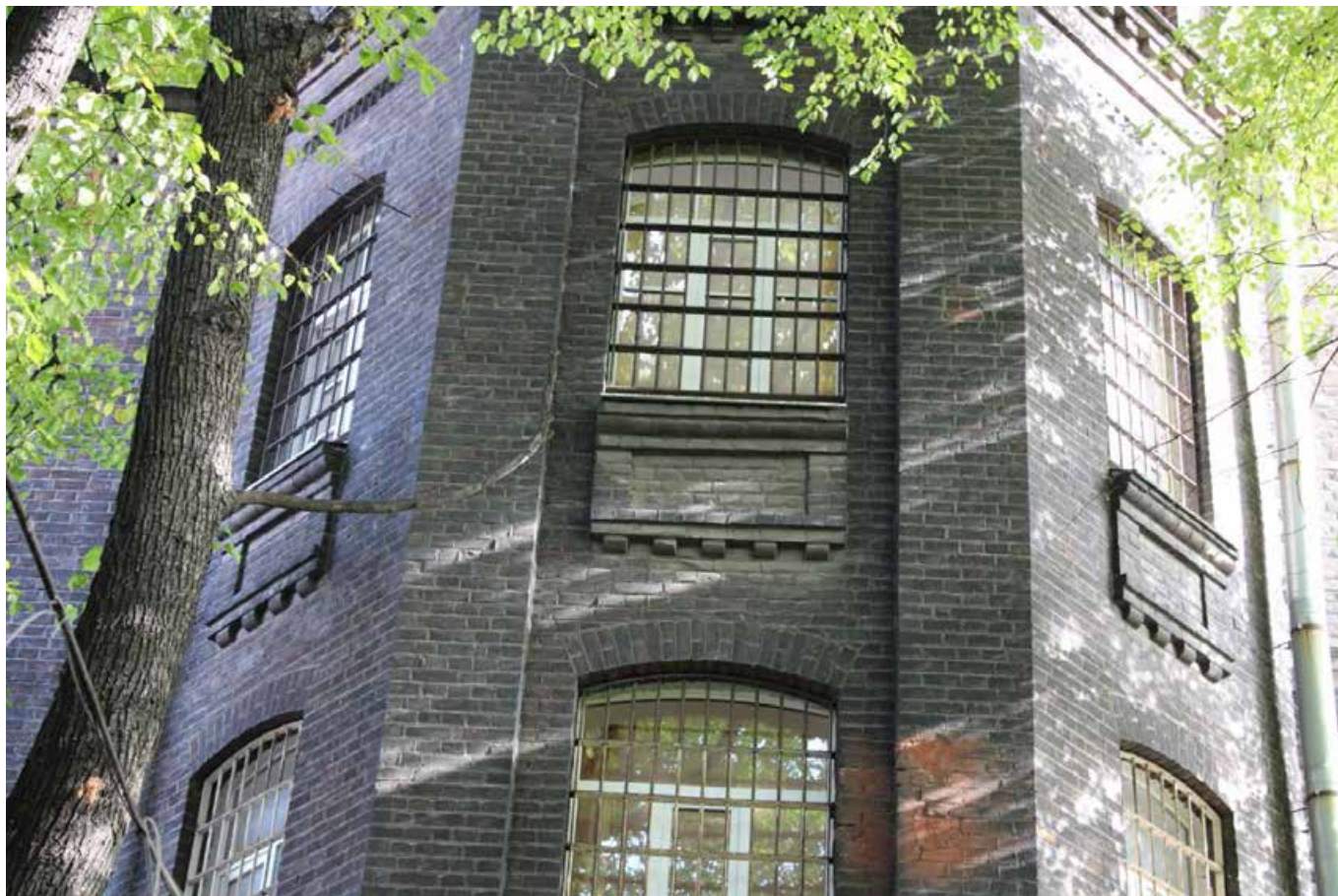
Фото 3. Оконные проёмы с выделенными лучковыми: филёнки в уровне 3-го этажа. Фрагмент. Дата фотофиксации: 07.10.25.
