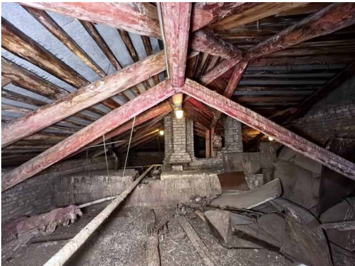
Фото 55. Стропила чердака административного здания. Фрагмент. Дата фотофиксации: 07.10.25.
