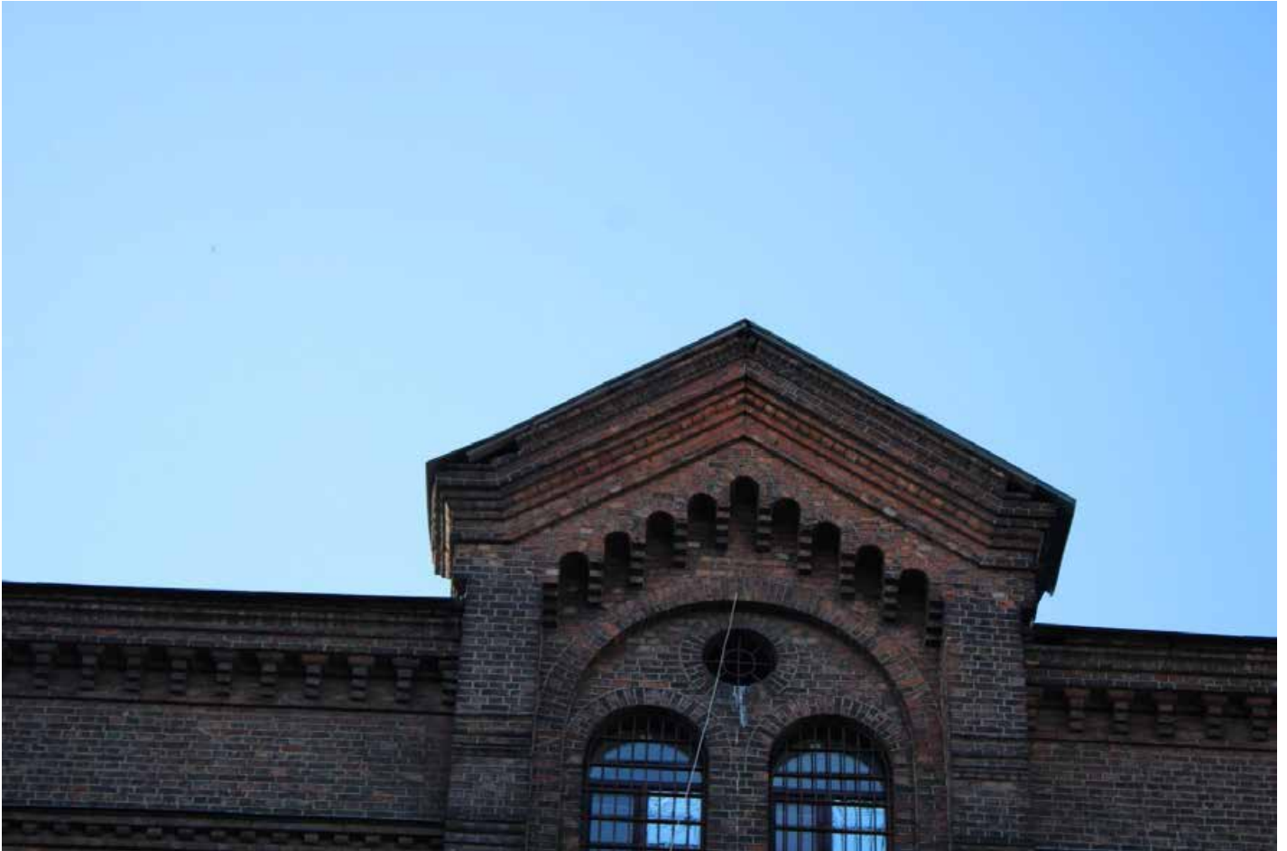
Фото 24. Ризалит, законченный двухскатным щипцом и окно-люкарна в уровне 6-го этажа. Фрагмент. Дата фотофиксации: 07.10.25.
