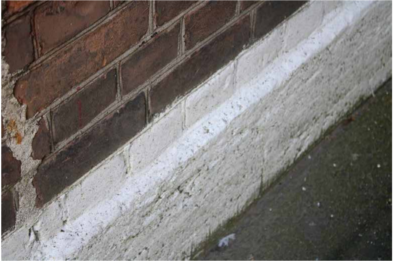
Фото 18. Материал отделки цоколя корпуса одиночного заключения – известняк. Фрагмент. Дата фотофиксации: 07.10.25.
