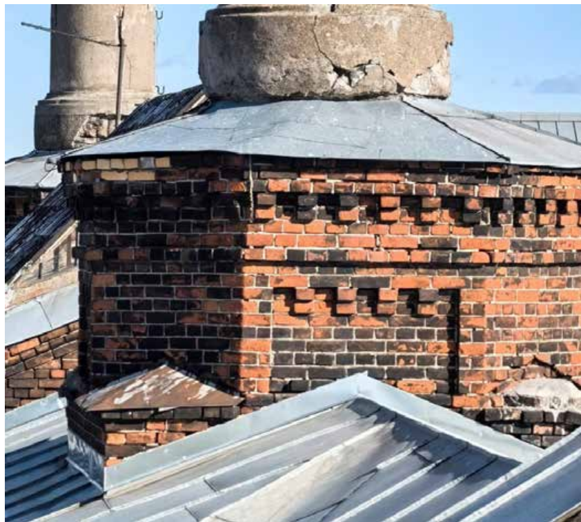
Фото 46. Кирпичный пьедестал оштукатуренной трубы корпуса камер одиночного заключения здания. Фрагмент. Дата фотофиксации: 07.10.25.
