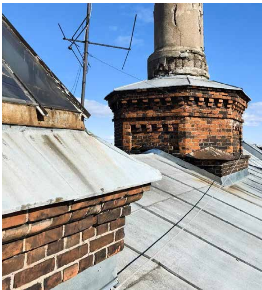
Фото 47. Кирпичный пьедестал оштукатуренной трубы корпуса камер одиночного заключения здания. Фрагмент. Дата фотофиксации: 07.10.25.
