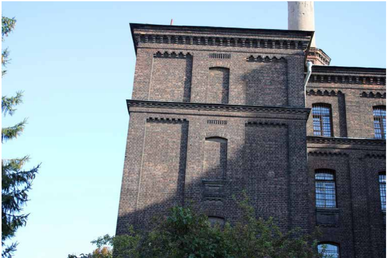
Фото 38. Неглубокие ниши с городчатым орнаментом выпущенного кирпича. Северо-западный фасад. Фрагмент. Дата фотофиксации: 07.10.25.
