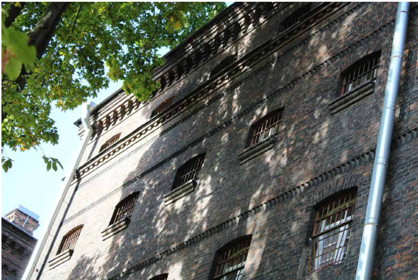
Фото 22. Венчающий и межэтажный карнизы южного фасада. Фрагмент. Дата фотофиксации: 07.10.25.
