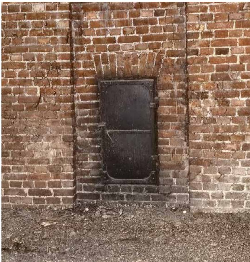
Фото 56. Металлическое дверное заполнение пьедестала дымохода в уровне чердака. Общий вид. Дата фотофиксации: 07.10.25.
