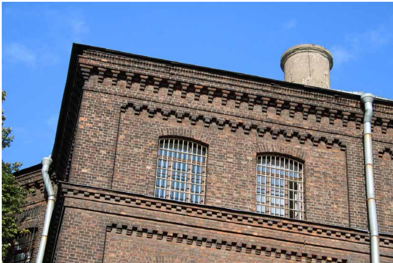
Фото 9. Венчающий карниз. Юго-западный фасад. Фрагмент. Дата фотофиксации: 07.10.25.
