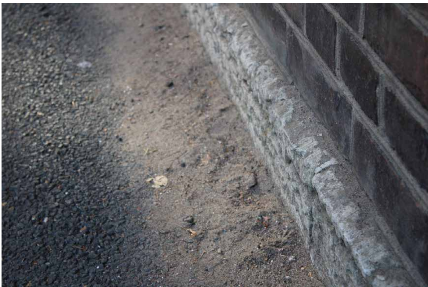
Фото 12. Материал отделки цоколя – известняк. Фрагмент. Дата фотофиксации: 07.10.25.
