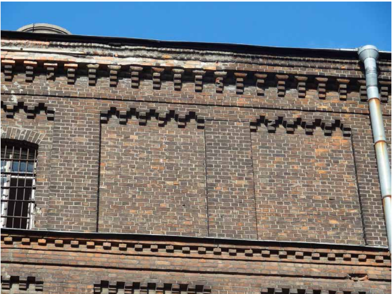
Фото 19. Венчающий карниз и неглубокие ниши с городчатым орнаментом выпущенного кирпича. Фрагмент. Дата фотофиксации: 07.10.25.
