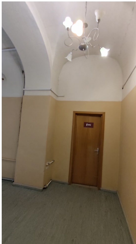
Фото 80. Полуциркульный свод с подпружными арками в помещении 14 (9-Н). Фрагмент. Дата фотофиксации: 07.10.25.
