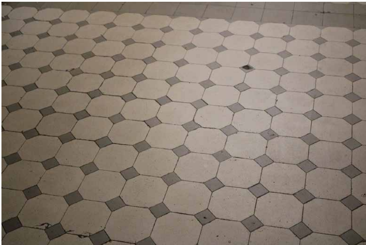
Фото 60. Метлахская плитка в объёме помещения 1 (1ЛК). Фрагмент. Дата фотофиксации: 07.10.25.
