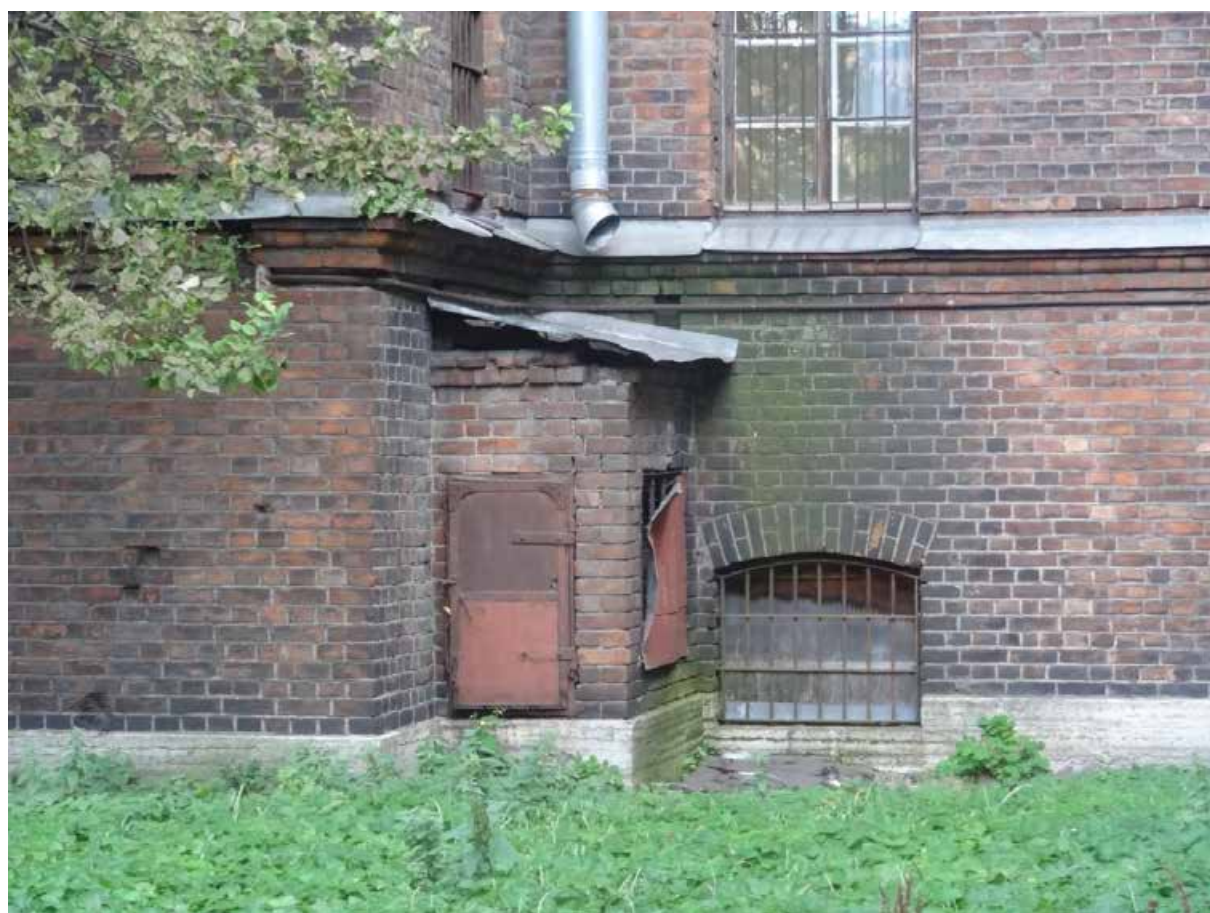
Фото 41. Металлическое дверное заполнение в уровне цоколя. Общий вид. Дата фотофиксации: 07.10.25.
