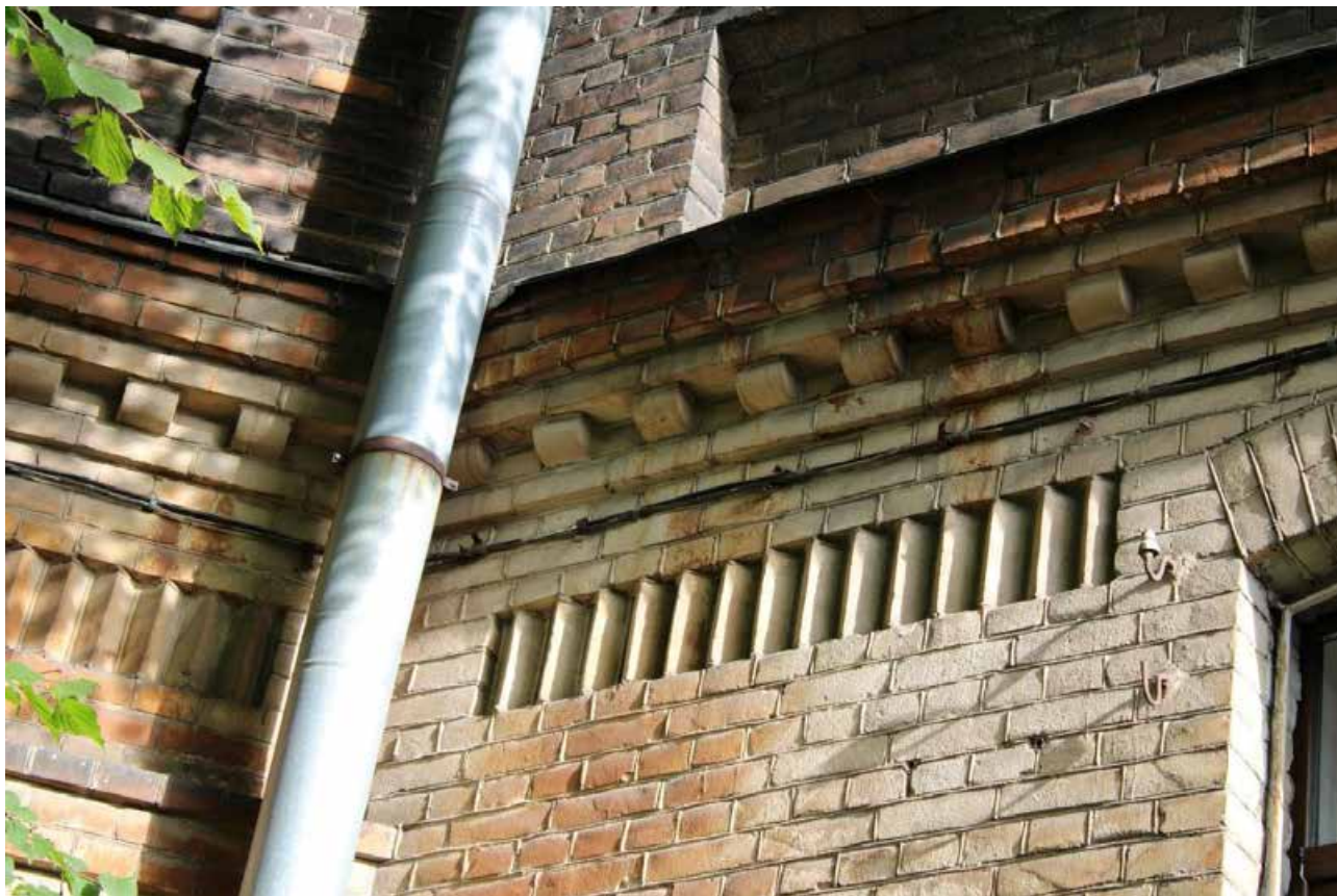
Фото 5. Межэтажный карниз. Фрагмент. Дата фотофиксации: 07.10.25.
