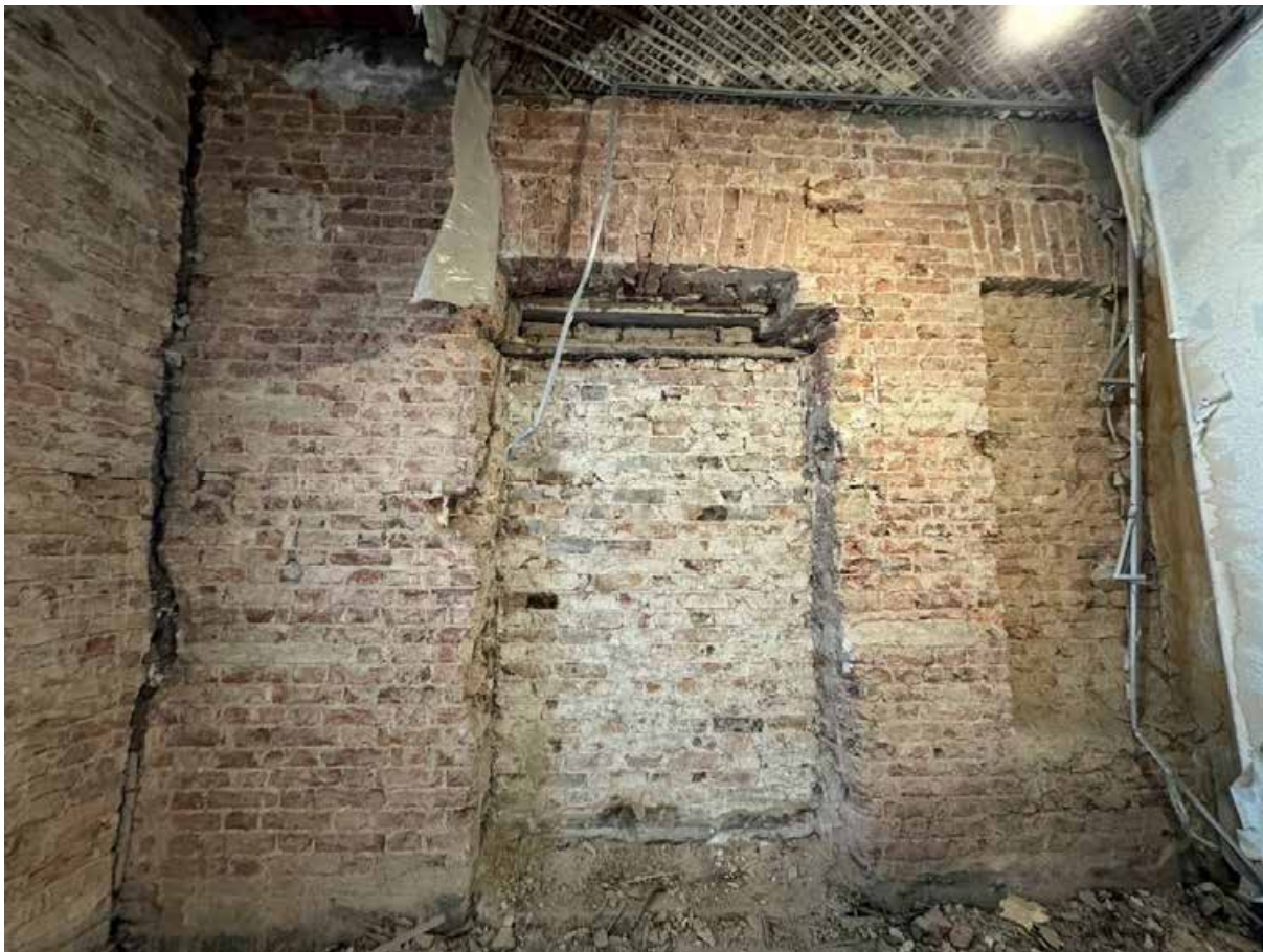
19. Вид на ниши заложенных проемов в интерьере квартиры №73 (пом.1 по тех.паспорту).
