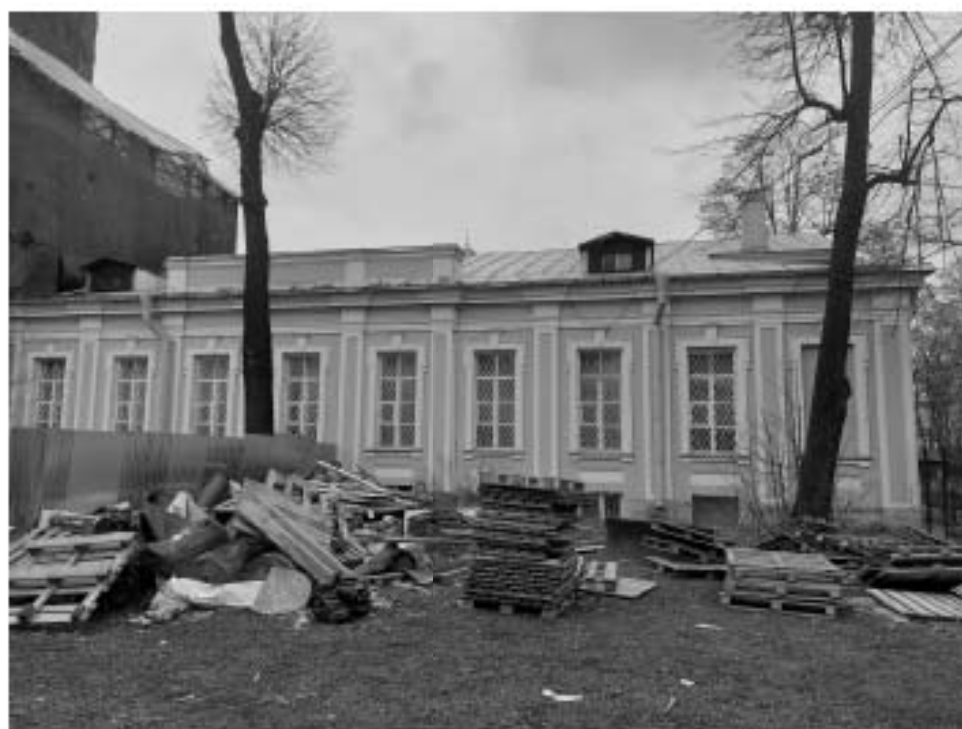
Фото 2. Южный фасад церкви.
