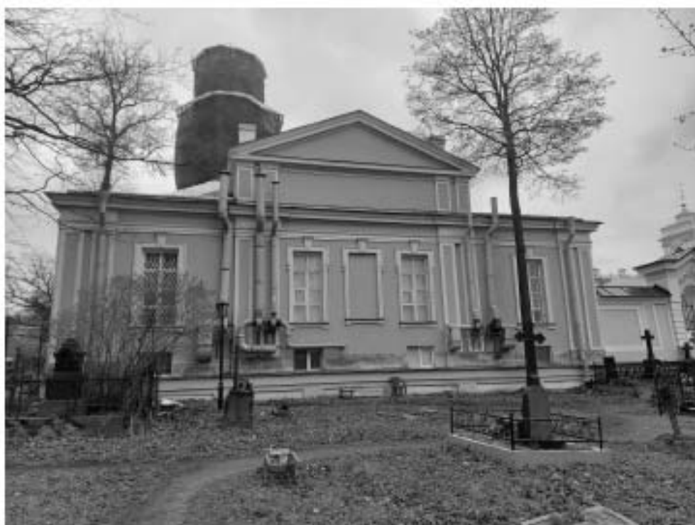
Фото 1. Восточный фасад церкви.
