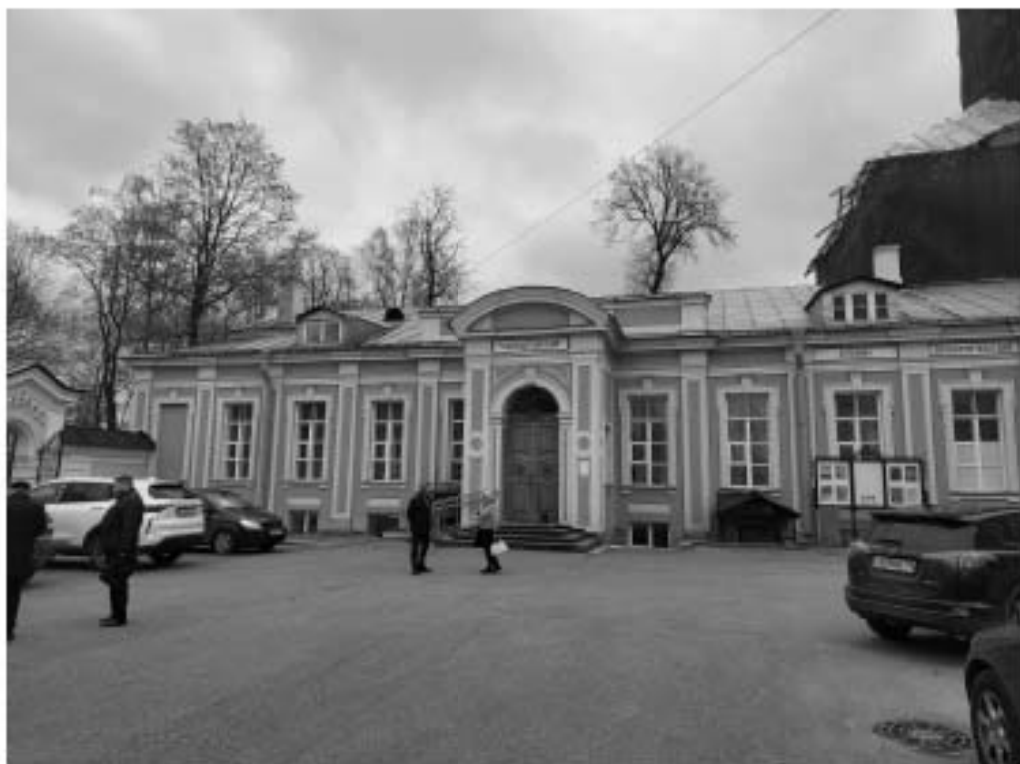
Фото 3. Северный фасад церкви. Главный вход.
