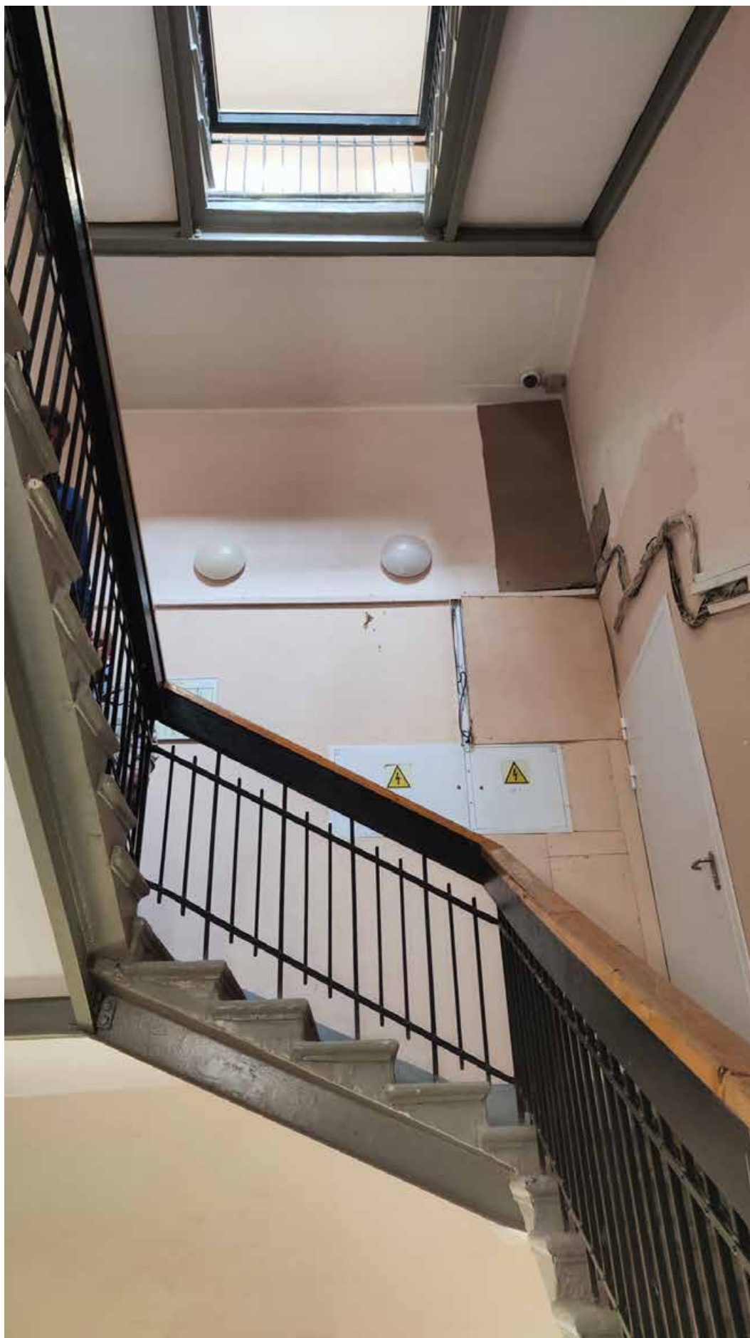
3. Вид на лестничную клетку
