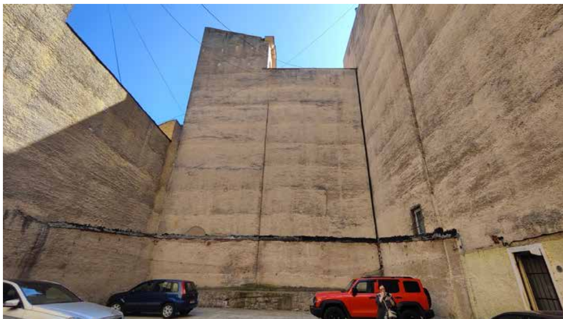
2. Вид на брандмауэрные стены здания
