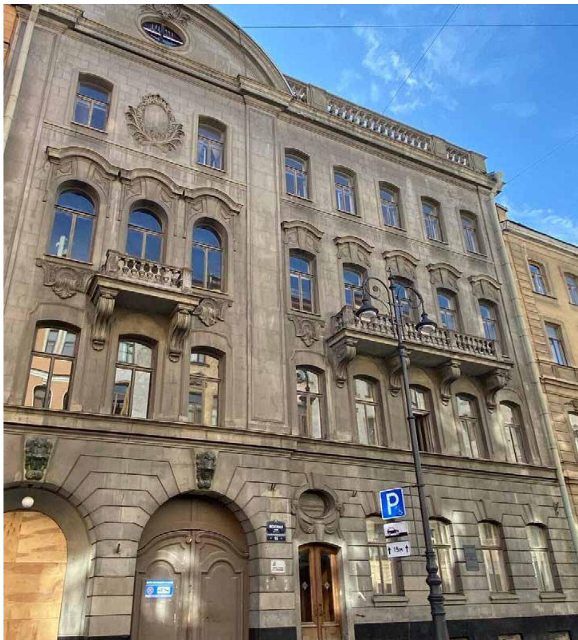
1. Вид на лицевой фасад здания №15
