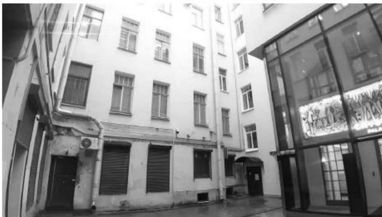
17. «Дом Протасовых (М.В.Воейковой)» (Невский пр., д. 72, лит. А). Дворовые фасады. Фото мест установки оборудования и прокладки кабельных трасс. Штиглиц М.С. 15.11.2025 г.
