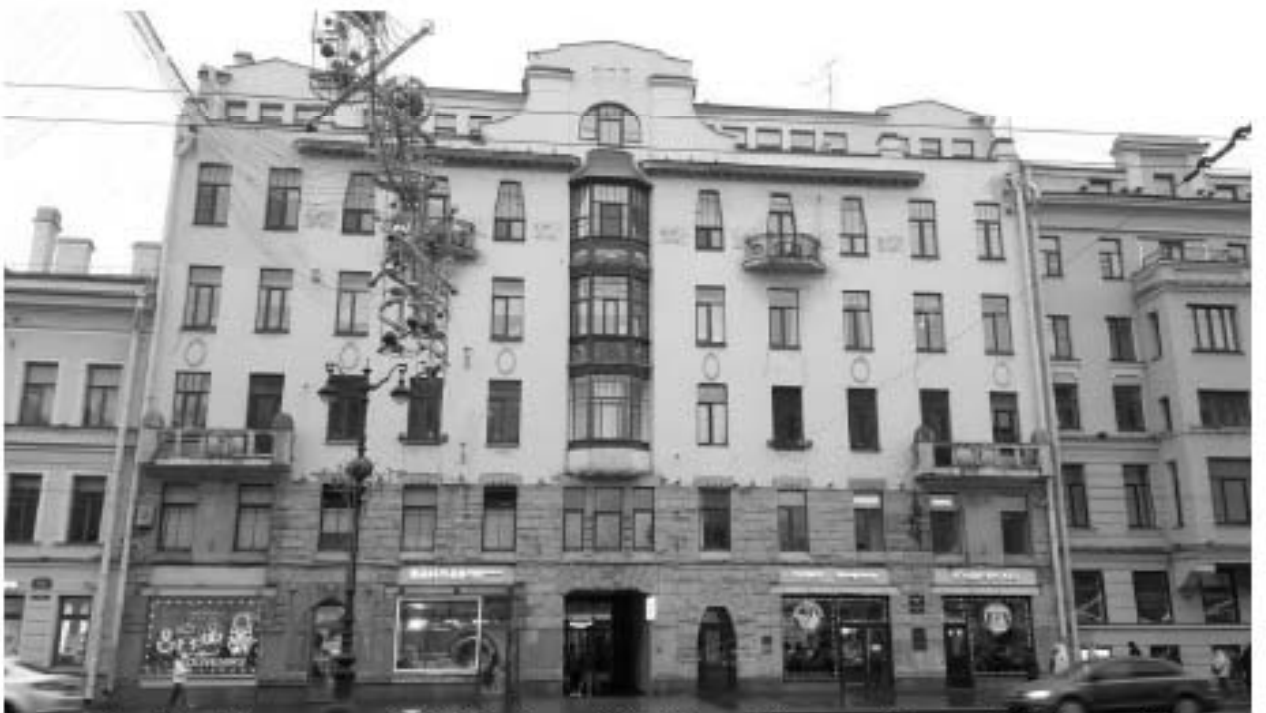
16. «Дом Протасовых (М.В. Воейковой)» (Невский пр., д. 72, лит. А). Лицевой фасад. Штиглиц М.С. 15.11.2025 г.
