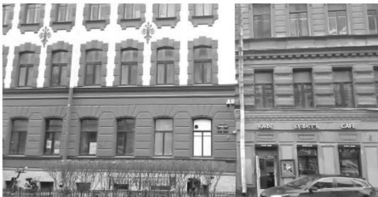
38. «Дом Р.К. Сан-Галли» (Пушкинская ул., д. 9, лит. А). Лицевой фасад. Фото мест установки оборудования и прокладки кабельных трасс. Штиглиц М.С. 15.11.2025 г.
