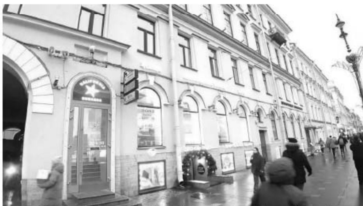
26. «Дом О.П. Кушелевой» (Невский пр., д 88, лит. А). Лицевой фасад. Фото мест установки оборудования и прокладки кабельных трасс. Штиглиц М.С. 15.11.2025 г.
