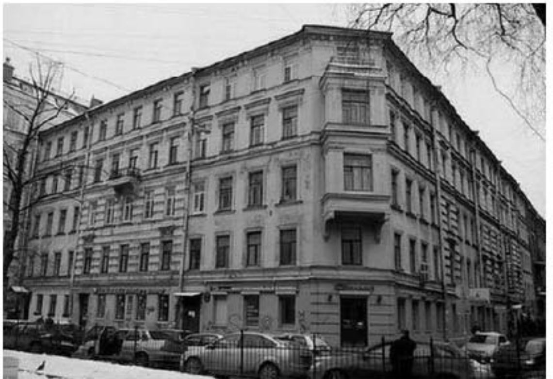
20. «Дом П.К. Симонова» (Пушкинская ул., д. 12, лит. А). 2020 [23].
