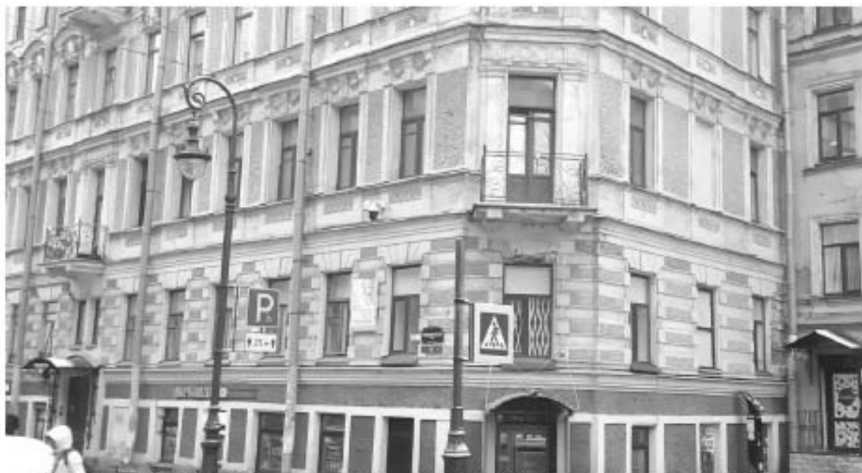
40. «Дом П. Д. и М. С. Мальцевых. Здесь в 1884-1893 гг. жила актриса П. А. Стрепетова» (Пушкинская ул., д. 10, лит. А). Лицевой фасад. Фото мест установки оборудования и прокладки кабельных трасс. Штиглиц М. С. 15.11.2025 г.
