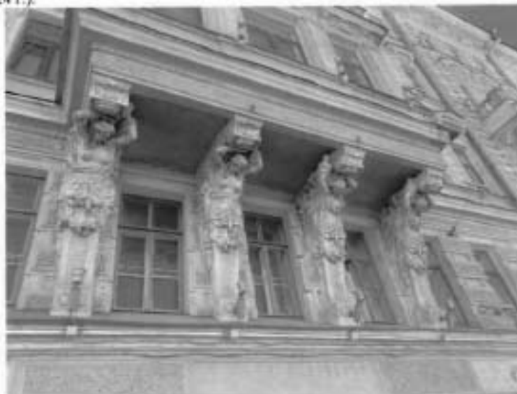
10. Вид на фасад объекта культурного наследия со стороны Невского проспекта. Фрагмент. (22.07.2024 г.).
