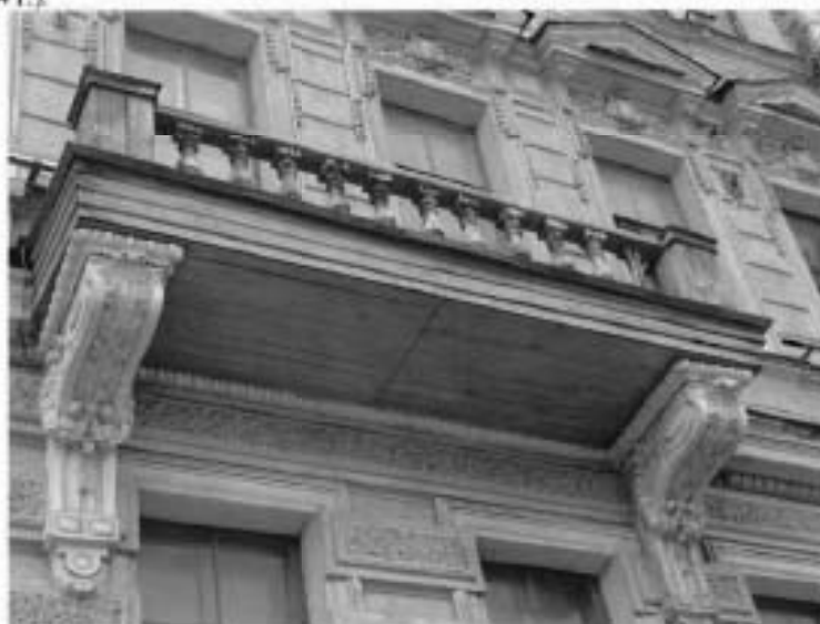
11. Вид на фасад объекта культурного наследия со стороны Невского проспекта. Фрагмент. (22.07.2024 г.).
