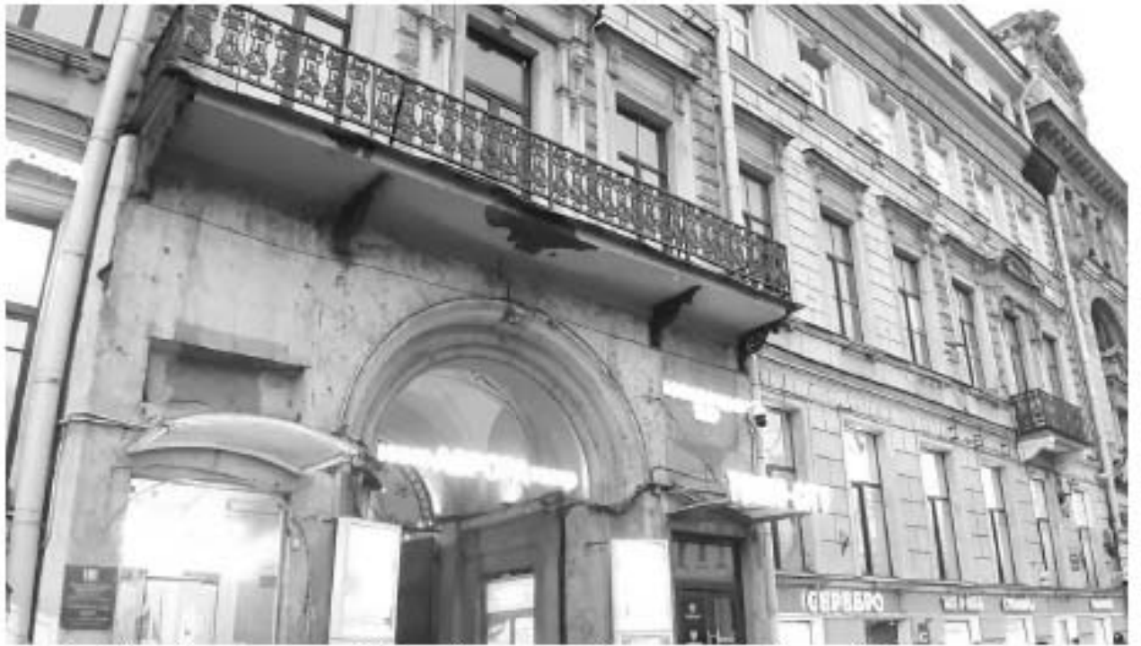
13. «Дом Глазуновъ» (Невский пр., д. 60, лит. А). Лицевой фасад. Фото мест установки оборудования и прокладки кабельных трасс. Штиглиц М.С. 15.11.2025 г.
