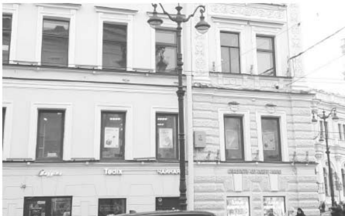
22. «Угловой дом» (в составе «Дома А. Тимофеева (К.А. Тура)») (Невский пр., д. 87/2, лит. А). Лицевой фасад по Невскому пр. (фрагмент). Фото мест установки оборудования и прокладки кабельных трасс. Штиглиц М.С. 15.11.2025 г.
