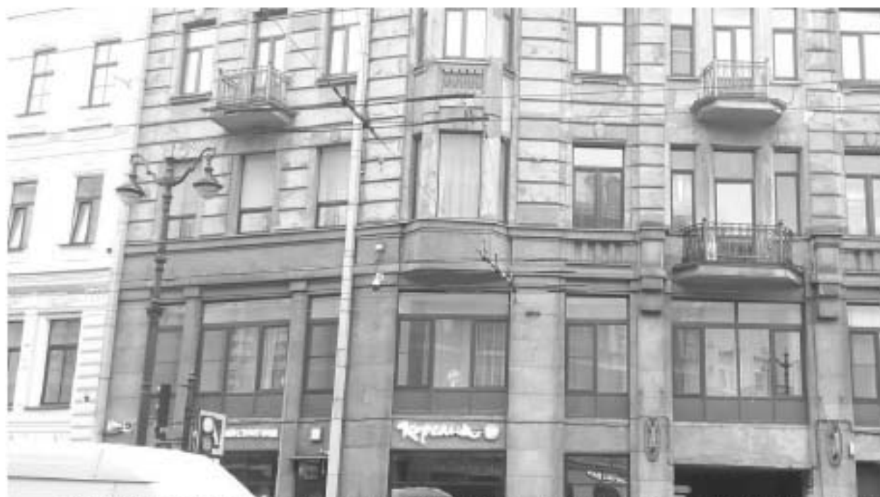
32. «Доходный дом Г. Г. Гесселя» (Невский пр., д. 95, лит. А). Лицевой фасад. Фото мест установки оборудования и прокладки кабельных трасс. Штиглиц М.С. 15.11.2025 г.
