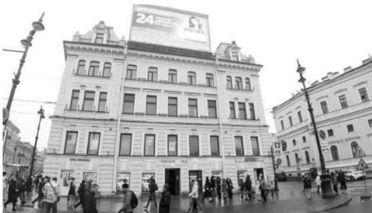
19. «Угловой дом» (в составе «Дома А. Тимофеева (К.А. Тура)») (Невский пр., д. 87/2, лит. А). Лицевой фасад по Восстания пл. Штиглиц М.С. 15.11.2025 г.
