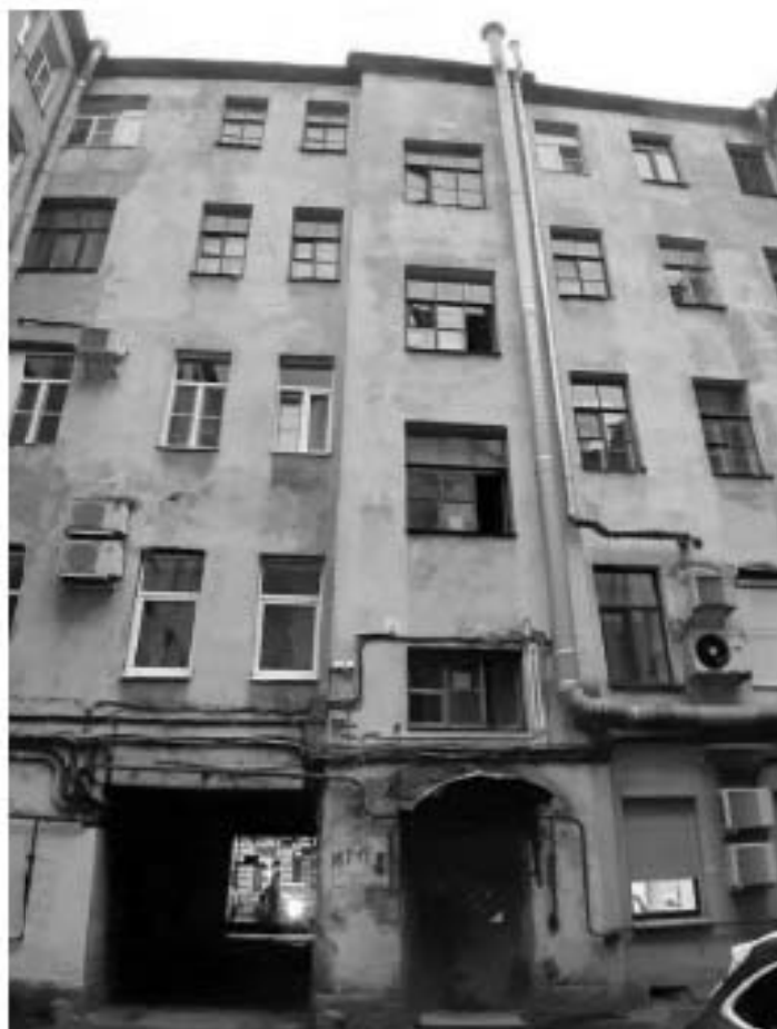
43. «Дом П.К. Симонова» (Пушкинская ул., д. 12, лит. А). Дворовые фасады. Фото мест установки оборудования и прокладки кабельных трасс. Штиглиц М.С. 15.11.2025 г.
