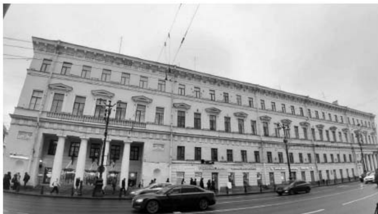
2. «Дом Котомина К.Б.» (Невский пр., д. 18, лит. А). Лицевой фасад по Невскому пр. Штиглиц М.С. 15.11.2025 г.
