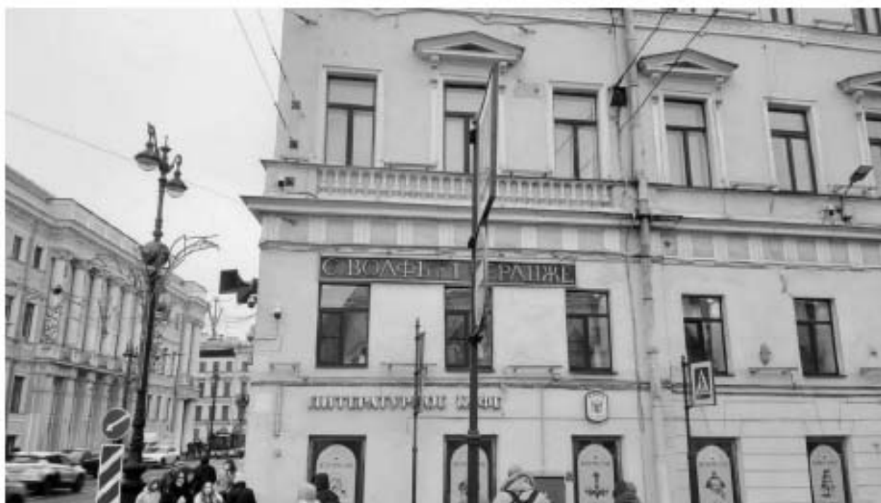
5. «Дом Котомина К.Б.» (Невский пр., д. 18, лит. А). Лицевой фасад по наб.р. Мойки. (фрагмент). Фото мест установки оборудования и прокладки кабельных трасс. Штиглиц М.С. 15.11.2025 г.
