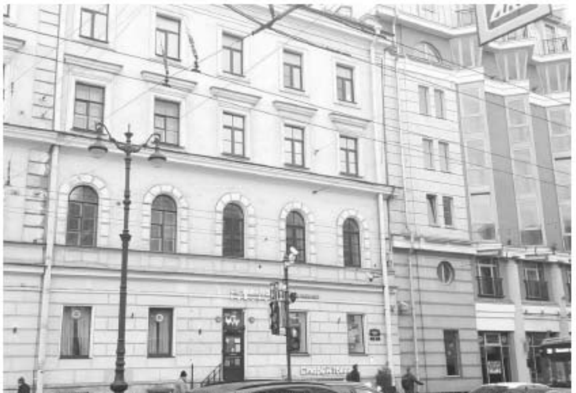
30. «Съезжий дом Каретной части» (Невский пр., д. 91, лит. Б). Лицевой фасад. Фото мест установки оборудования и прокладки кабельных трасс. Штиглиц М.С. 15.11.2025 г.
