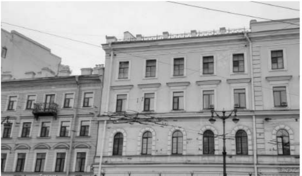
29. «Съезжий дом Каретной части» (Невский пр., д. 91, лит. Б). Лицевой фасад. Фото мест установки оборудования и прокладки кабельных трасс. Штиглиц М.С. 15.11.2025 г.
