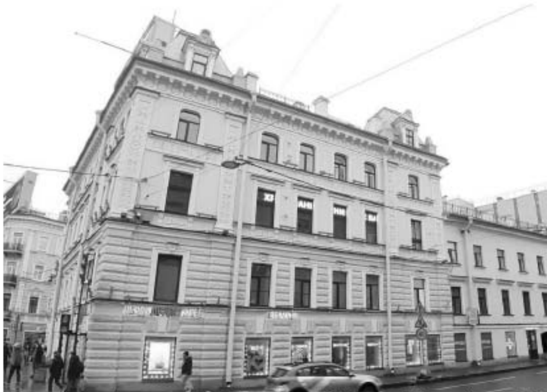
21. «Угловой дом» (в составе «Дома А. Тимофеева (К.А. Тура)») (Невский пр., д. 87/2, лит. А). Лицевой фасад по Гончарной ул. Штиглиц М.С. 15.11.2025 г.
