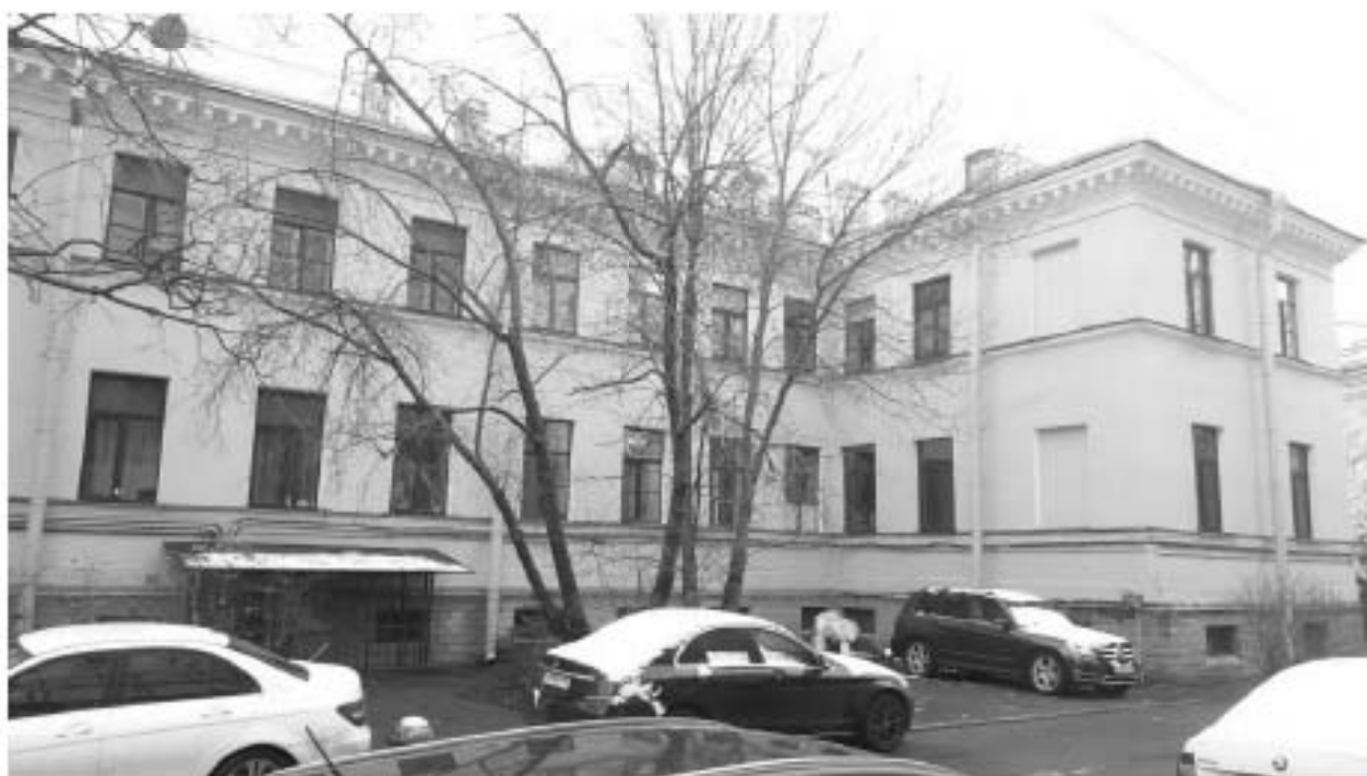
20. «Казармы офицерские (два корпуса)» (в составе «Казармы Преображенского полка») (Кирочная ул., д. 37, лит. А). Дворовые фасады. Фото мест установки оборудования и прокладки кабельных трасс. Штиглиц М.С. 15.11.2025 г.
