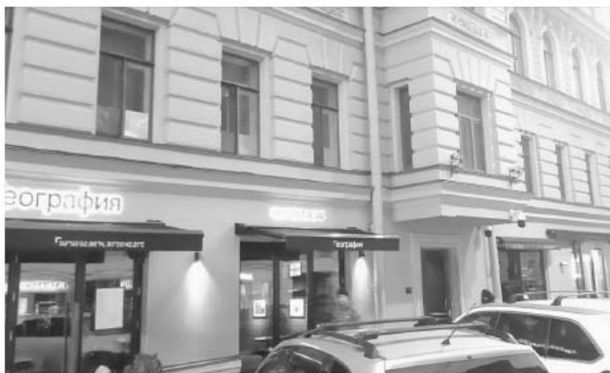
49. «Дом Г.Г. Мекленбург-Стрелицкого» (Рубинштейна ул., д. 5, лит. А). Лицевой фасад. Фото мест установки оборудования и прокладки кабельных трасс. Штиглиц М.С. 15.11.2025 г.
