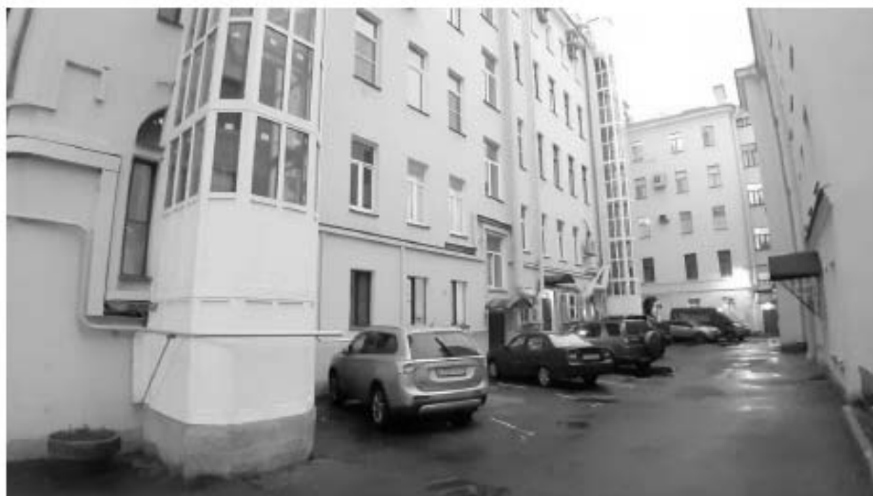
51. «Дом Г.Г. Мекленбург-Стрелицкого» (Рубинштейна ул., д. 5, лит. А). Дворовые фасады. Фото мест установки оборудования и прокладки кабельных трасс. Штиглиц М.С. 15.11.2025 г.
