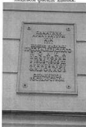
Фото 15. Здание по адресу: Кировная улица, дом 37, лит. А. Информационная табличка на лицевом фасаде здания.
