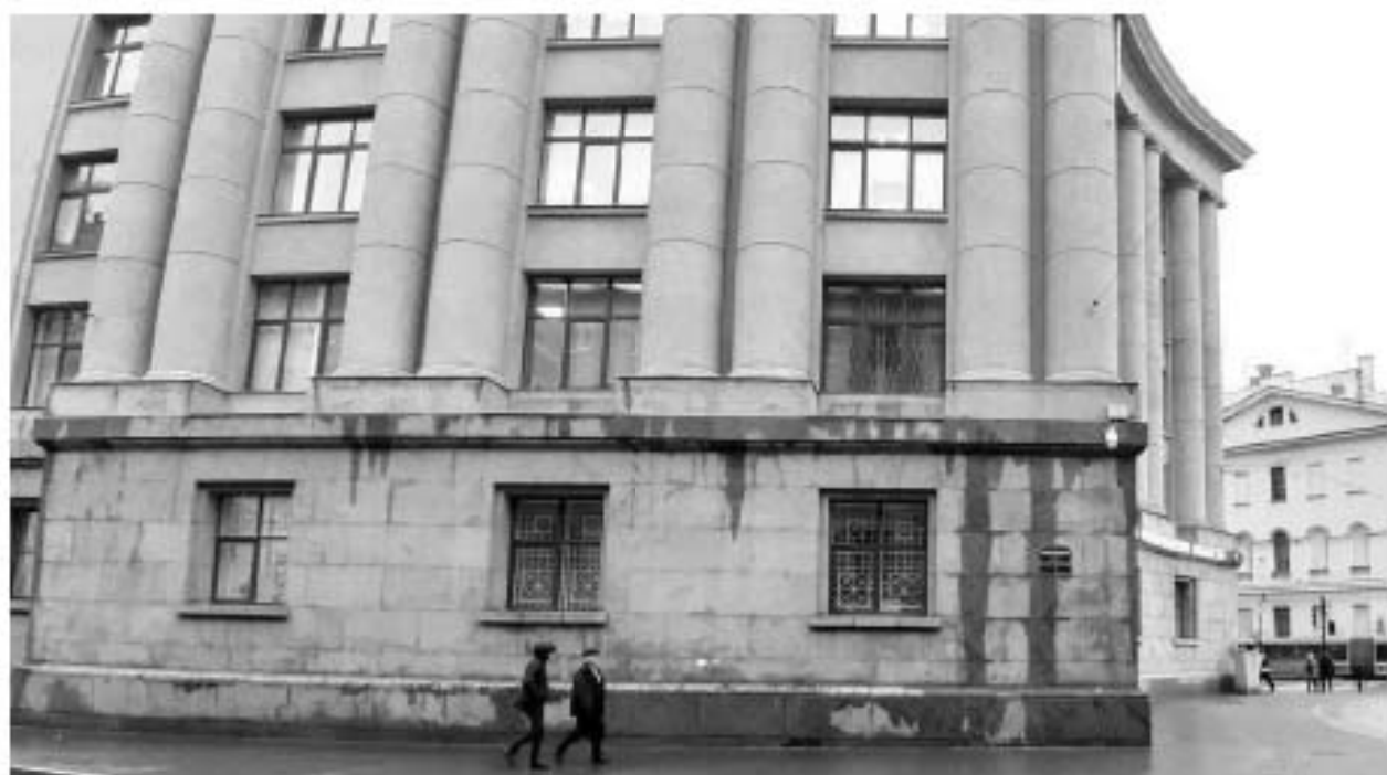
38. «Здание Академии легкой промышленности им. С.М.Кирова» (Суворовский пр., д. 50-52, лит. А). Лицевой фасад по Кавалергардской ул. (фрагмент). Фото мест установки оборудования и прокладки кабельных трасс. Штиглиц М.С. 15.11.2025 г.
