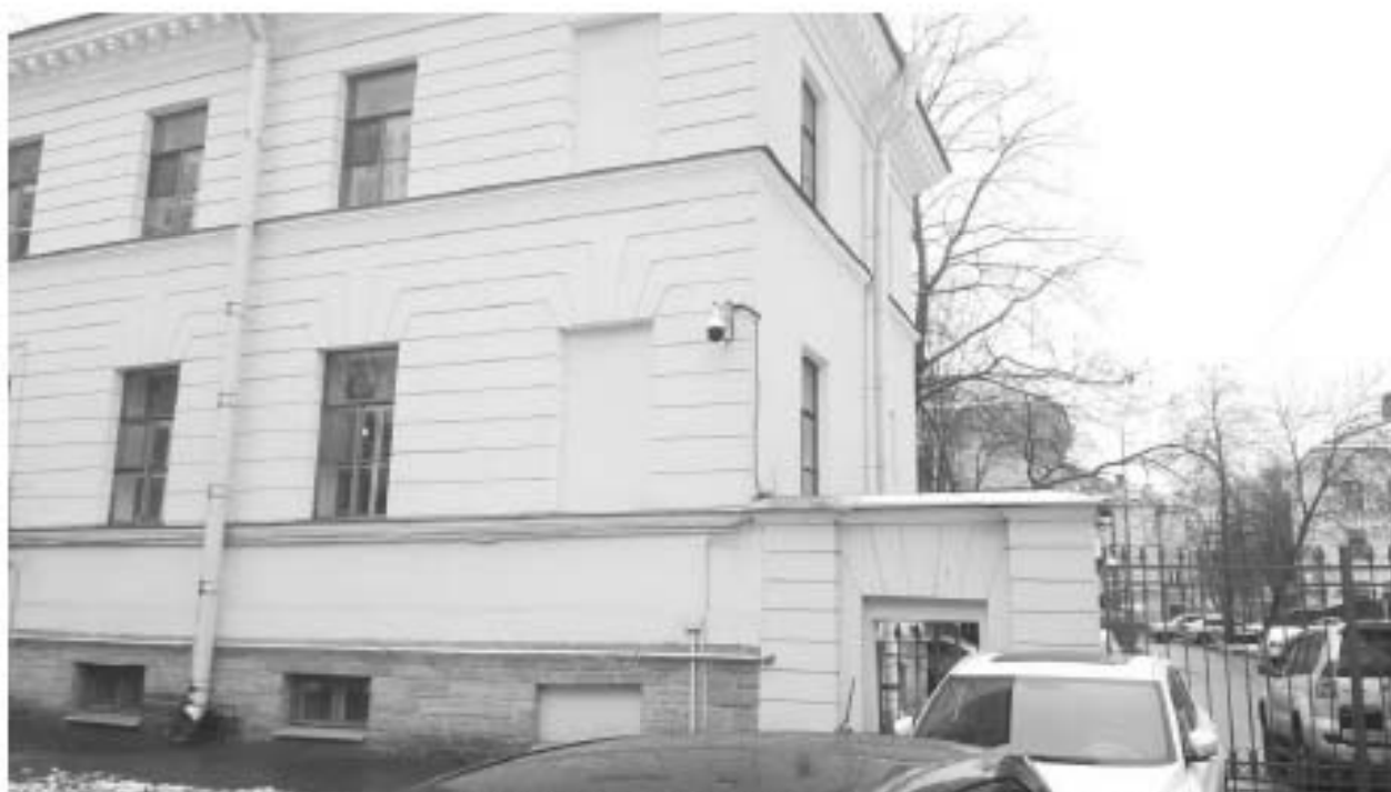
18. «Казармы офицерские (два корпуса)» (в составе «Казармы Преображенского полка») (Кирочная ул., д. 37, лит. А). Лицевой фасад на сад Салтыкова-Щедрина. (фрагмент). Фото мест установки оборудования и прокладки кабельных трасс. Штиглиц М.С. 15.11.2025 г.
