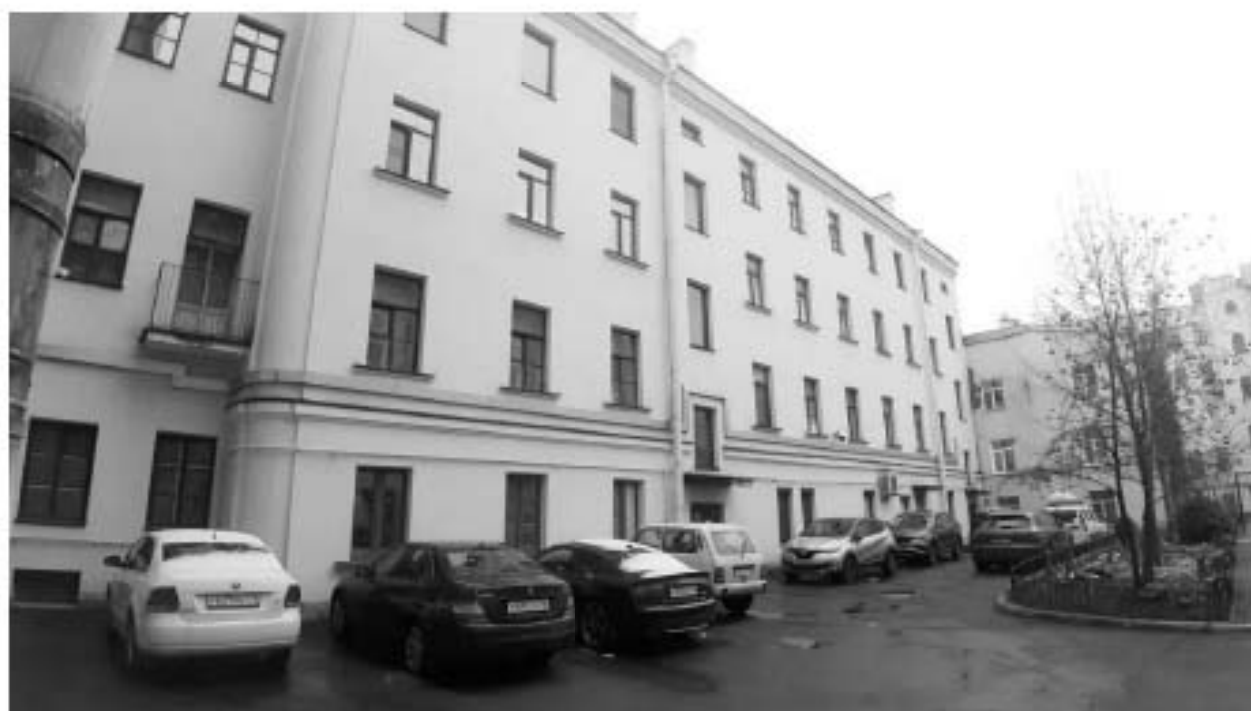
56. «Дом Челищева (Мануса)» (Чайковского ул., д. 31, лит. А). Дворовые фасады. Фото мест установки оборудования и прокладки кабельных трасс. Штиглиц М.С. 15.11.2025 г.
