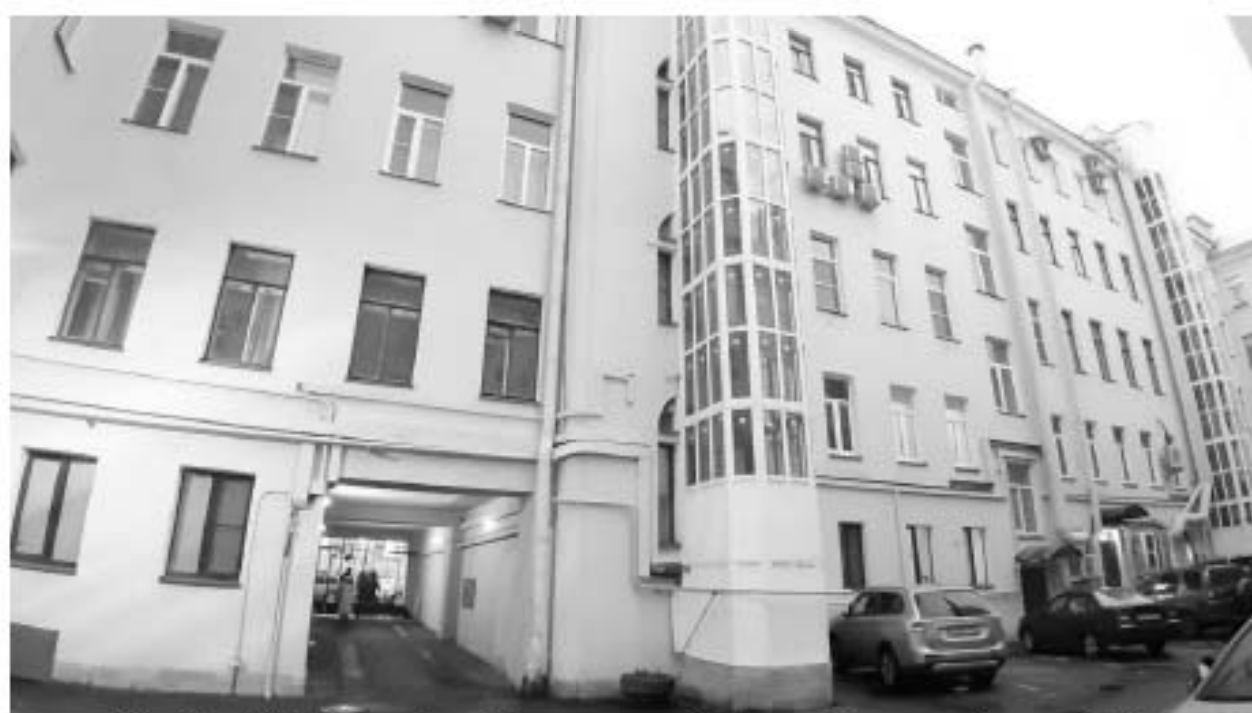
50. «Дом Г.Г. Мекленбург-Стрелицкого» (Рубинштейна ул., д. 5, лит. А). Дворовые фасады. Фото мест установки оборудования и прокладки кабельных трасс. Штиглиц М.С. 15.11.2025 г.
