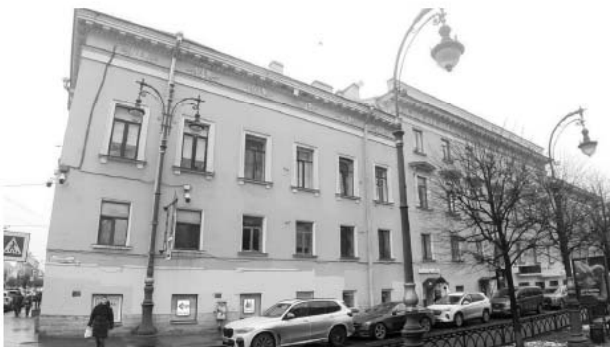
10. «Лазаретный дом» (в составе «Комплекс зданий Конторского двора Гоф-интендантской конторы») (Захарьевская ул., д. 14, лит. Г). Лицевой фасад по ул. Чернышевского. Штиглиц М.С. 15.11.2025 г.
