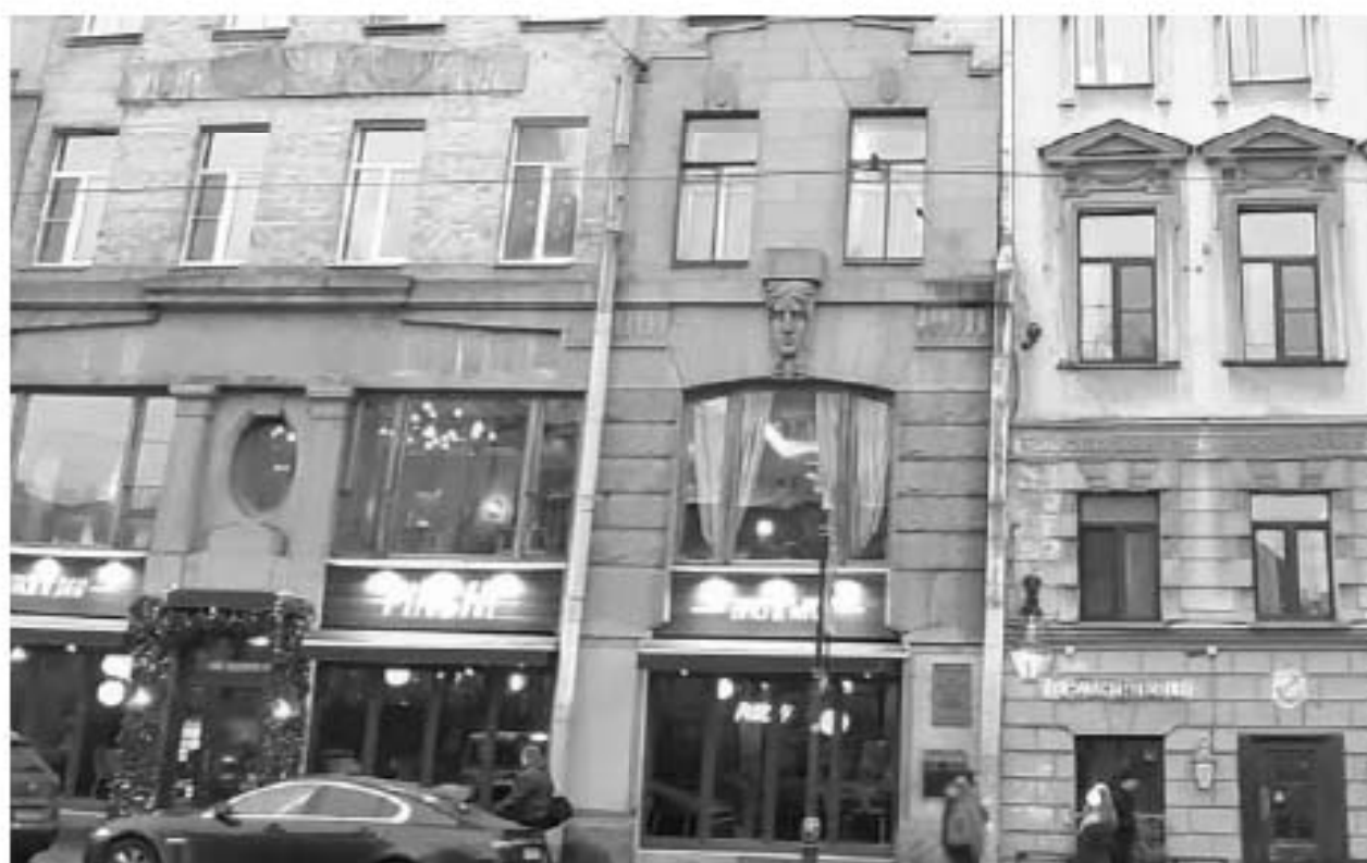
42. «Дом Н.А. и С.А. Латониных» (Белинского ул., д. 5, лит. А). Лицевой фасад. (фрагмент). Фото мест установки оборудования и прокладки кабельных трасс. Штиглиц М.С. 15.11.2025 г.
