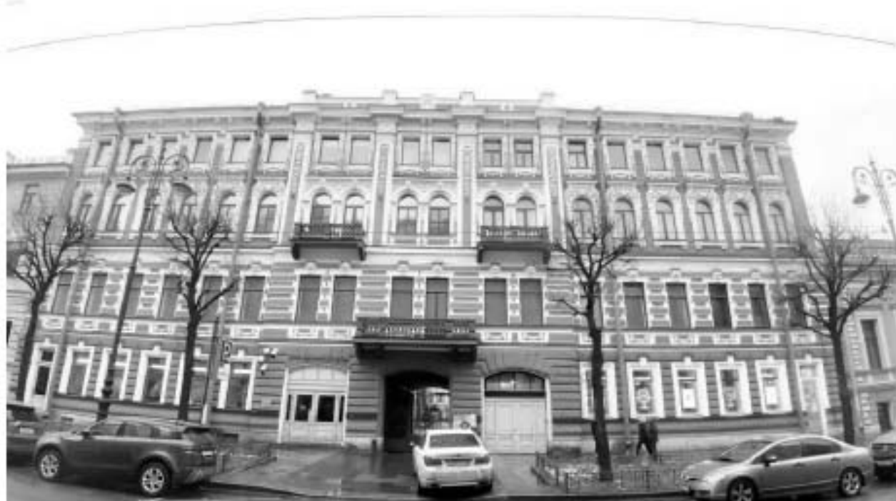
53. «Дом Челищева (Мануса)» (Чайковского ул., д. 31, лит. А). Лицевой фасад. Штиглиц М.С. 15.11.2025 г.
