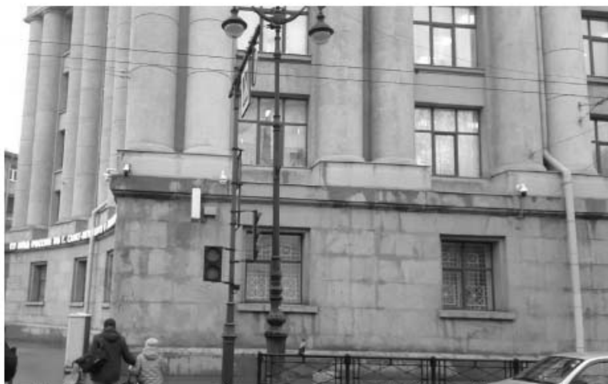
36. «Здание Академии легкой промышленности им. С.М.Кирова» (Суворовский пр., д. 50-52, лит. А). Лицевой фасад по Суворовскому пр. (фрагмент). Фото мест установки оборудования и прокладки кабельных трасс. Штиглиц М.С. 15.11.2025 г.
