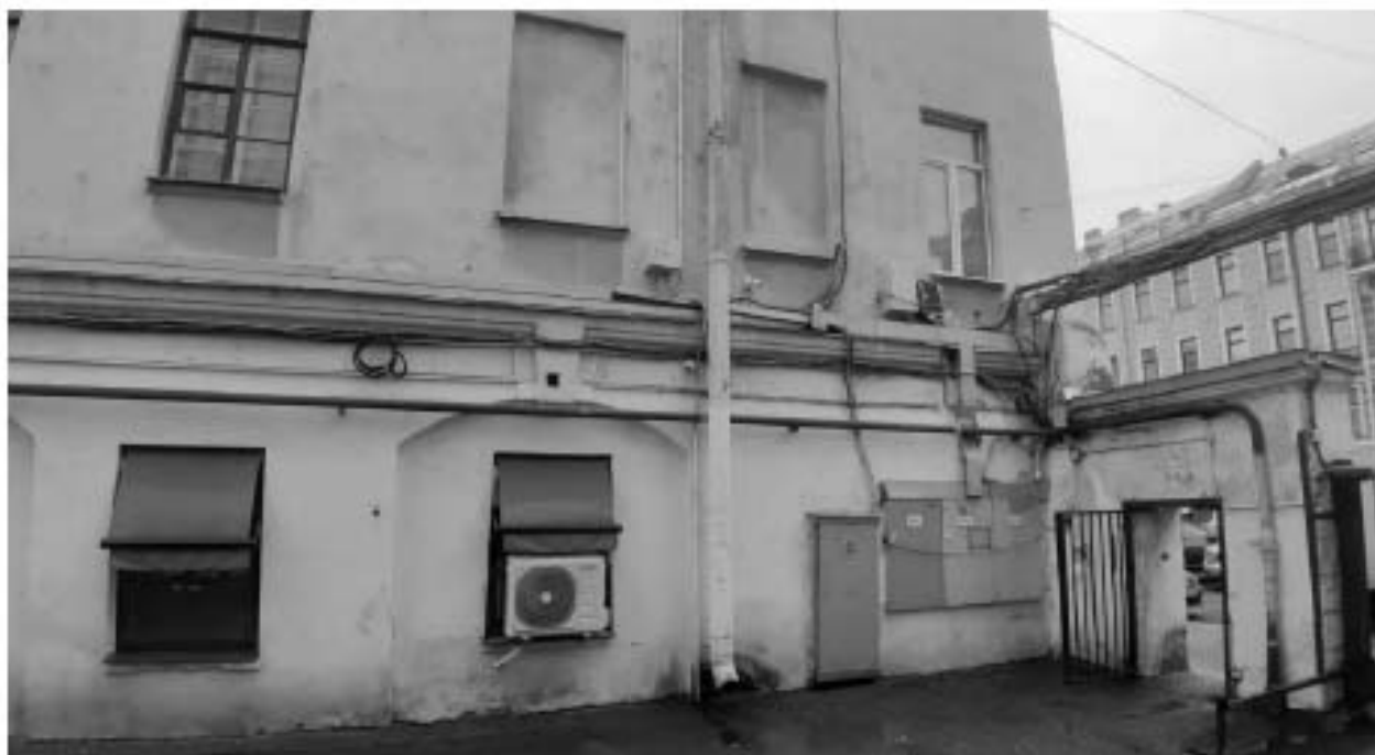
15. «Лазаретный дом» (в составе «Комплекс зданий Конторского двора Гоф-интендантской конторы») (Захарьевская ул., д. 14, лит. Г). Дворовые фасады. Фото мест установки оборудования и прокладки кабельных трасс. Штиглиц М.С. 15.11.2025 г.
