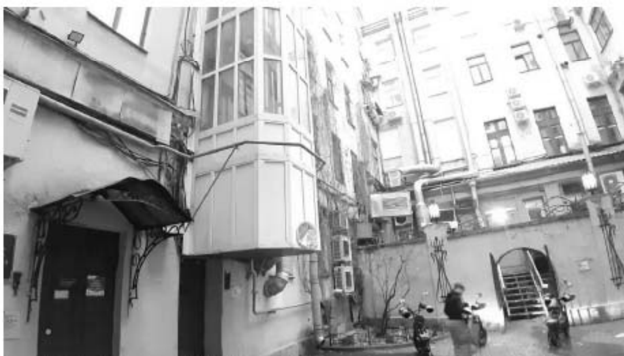
26. «Дом Демидовых (А.М. Ушакова)» (Малая Садовая ул., д. 3/54, лит. А). Дворовые фасады. Фото мест установки оборудования и прокладки кабельных трасс. Штиглиц М.С. 15.11.2025 г.
