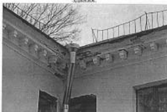
Фото 8. Здание по адресу: Кирочная улица, дом 31, лит. А. Фрагмент дворового фасада здания.
