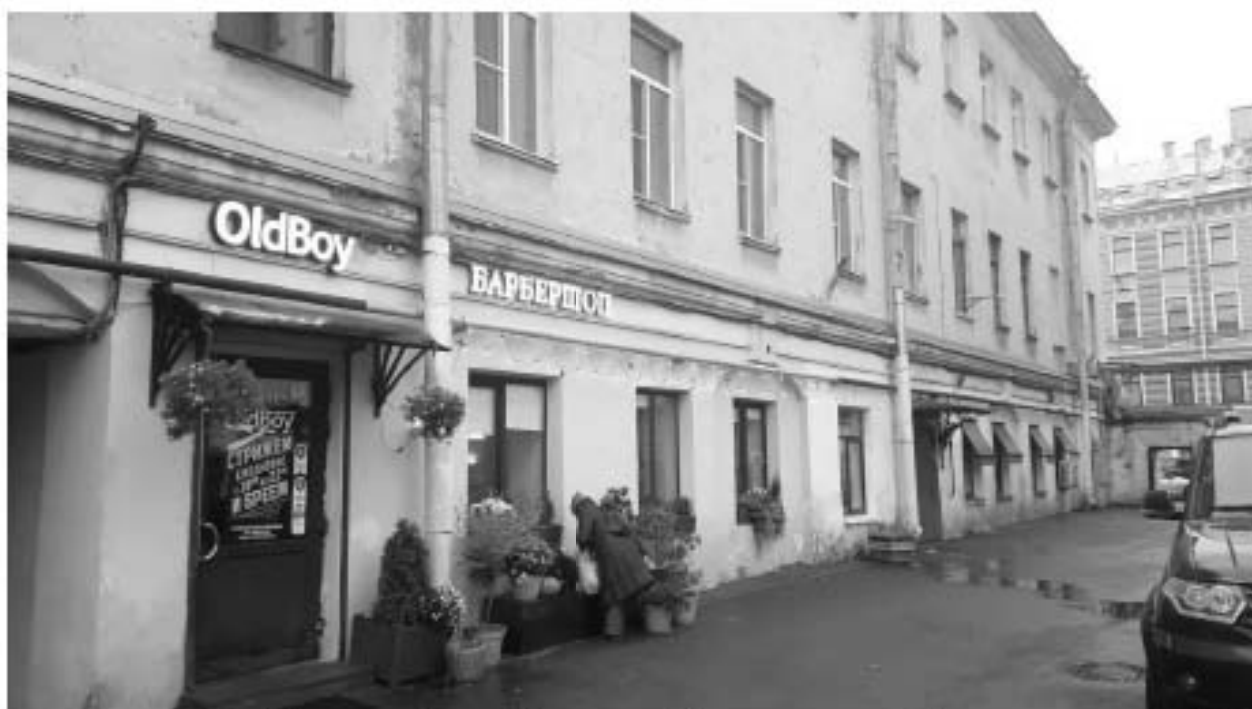
14. «Лазаретный дом» (в составе «Комплекс зданий Конторского двора Гоф-интендантской конторы») (Захарьевская ул., д. 14, лит. Г). Дворовые фасады. Фото мест установки оборудования и прокладки кабельных трасс. Штиглиц М.С. 15.11.2025 г.
