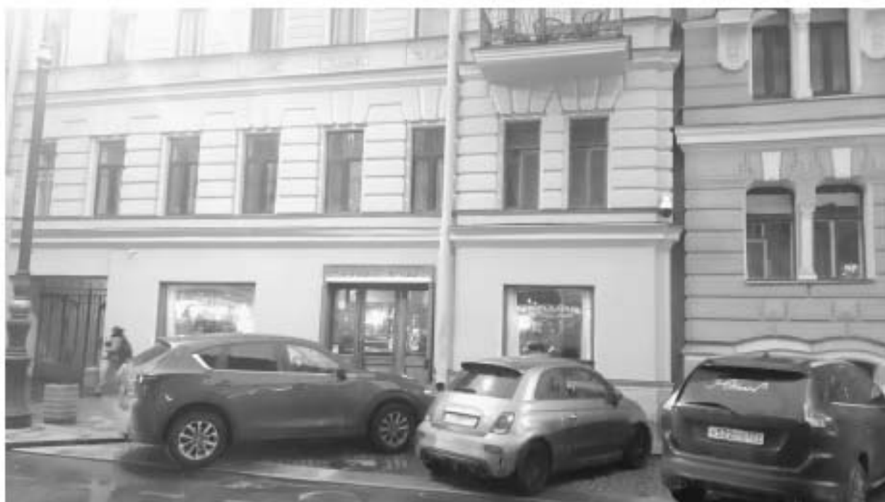
47. «Дом Г.Г. Мекленбург-Стрелицкого» (Рубинштейна ул., д. 5, лит. А). Лицевой фасад. Фото мест установки оборудования и прокладки кабельных трасс. Штиглиц М.С. 15.11.2025 г.
