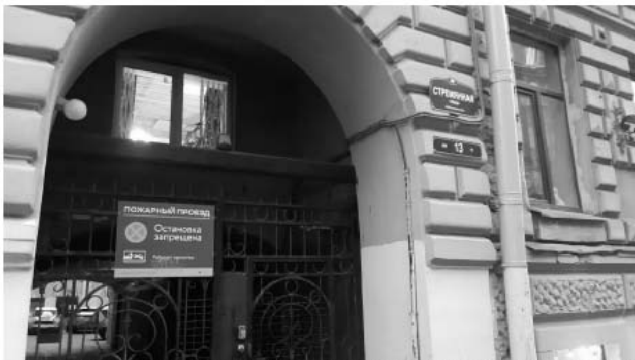
32. «Дом А. Ф. Мюзера» (Стремянная ул., д. 13, лит. А). Лицевой фасад (фрагмент). Фото мест установки оборудования и прокладки кабельных трасс. Штиглиц М.С. 15.11.2025 г.
