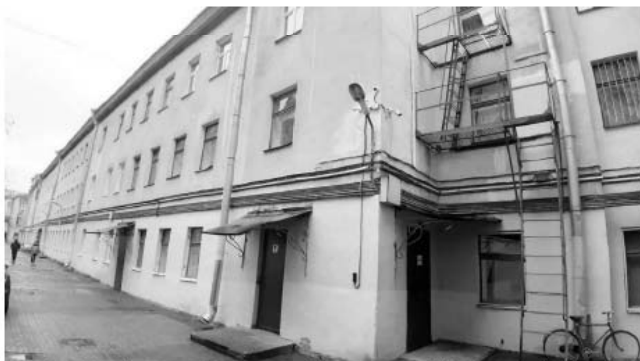
2. «Дом» (в составе «Особняк и дом Жалимировских (Н.Е. Демидовой)»). (Большая Конюшенная ул., д. 7, лит. А). Дворовые фасады. Фото мест установки оборудования и прокладки кабельных трасс. Штиглиц М.С. 15.11.2025 г.
