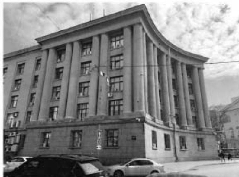
4. Вид на западный и южный фасады.
