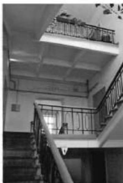
Фото №7. Центральная межэтажная лестница.
