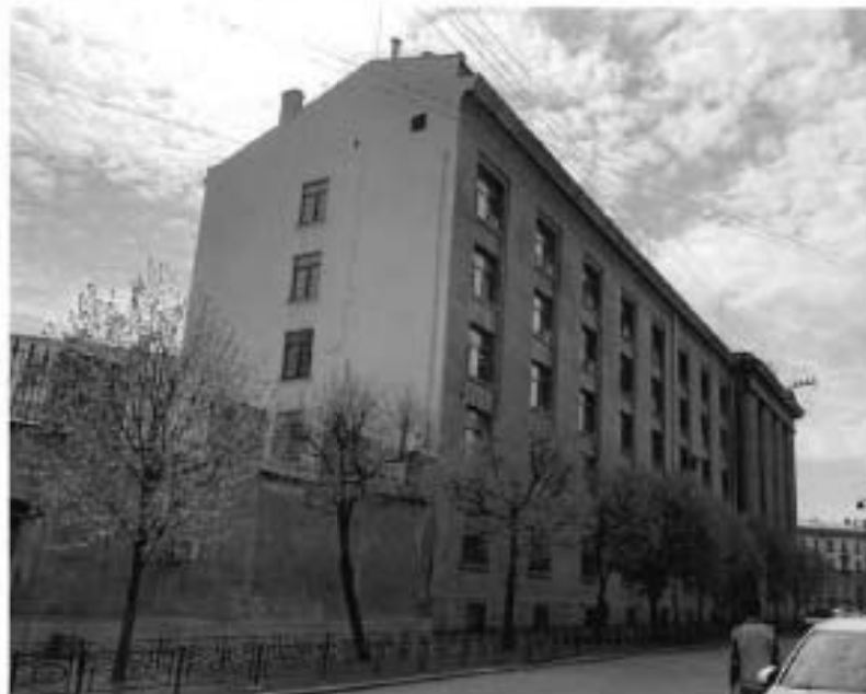
3. Вид на западный и северный фасады.
