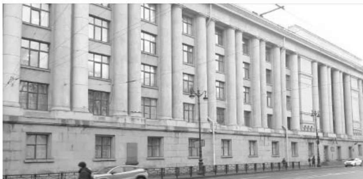
35. «Здание Академии легкой промышленности им. С.М.Кирова» (Суворовский пр., д. 50-52, лит. А). Лицевой фасад по Суворовскому пр. (фрагмент). Фото мест установки оборудования и прокладки кабельных трасс. Штиглиц М.С. 15.11.2025 г.
