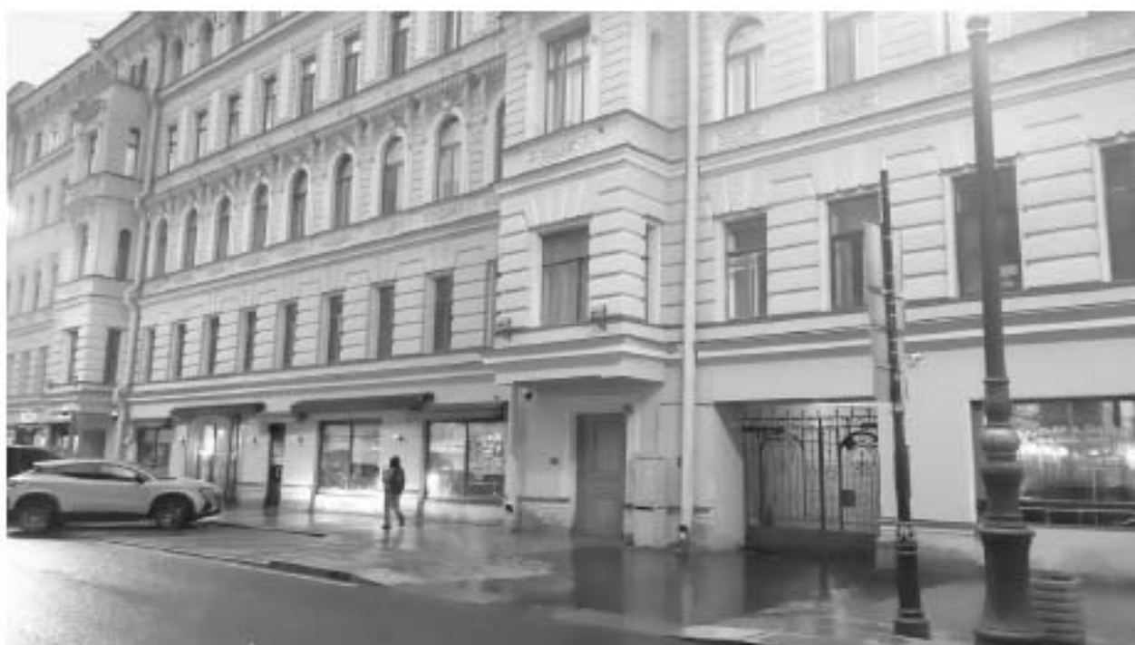
48. «Дом Г.Г. Мекленбург-Стрелицкого» (Рубинштейна ул., д. 5, лит. А). Лицевой фасад. Фото мест установки оборудования и прокладки кабельных трасс. Штиглиц М.С. 15.11.2025 г.
