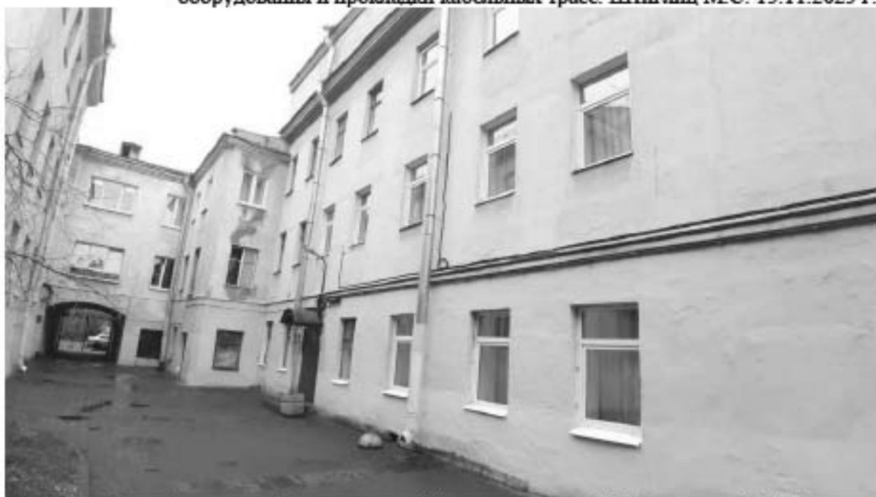
4. «Дом» (в составе «Особняк и дом Жалимировских (Н.Е. Демидовой)»). (Большая Конюшенная ул., д. 7, лит. А). Дворовые фасады. Фото мест установки оборудования и прокладки кабельных трасс. Штиглиц М.С. 15.11.2025 г.
