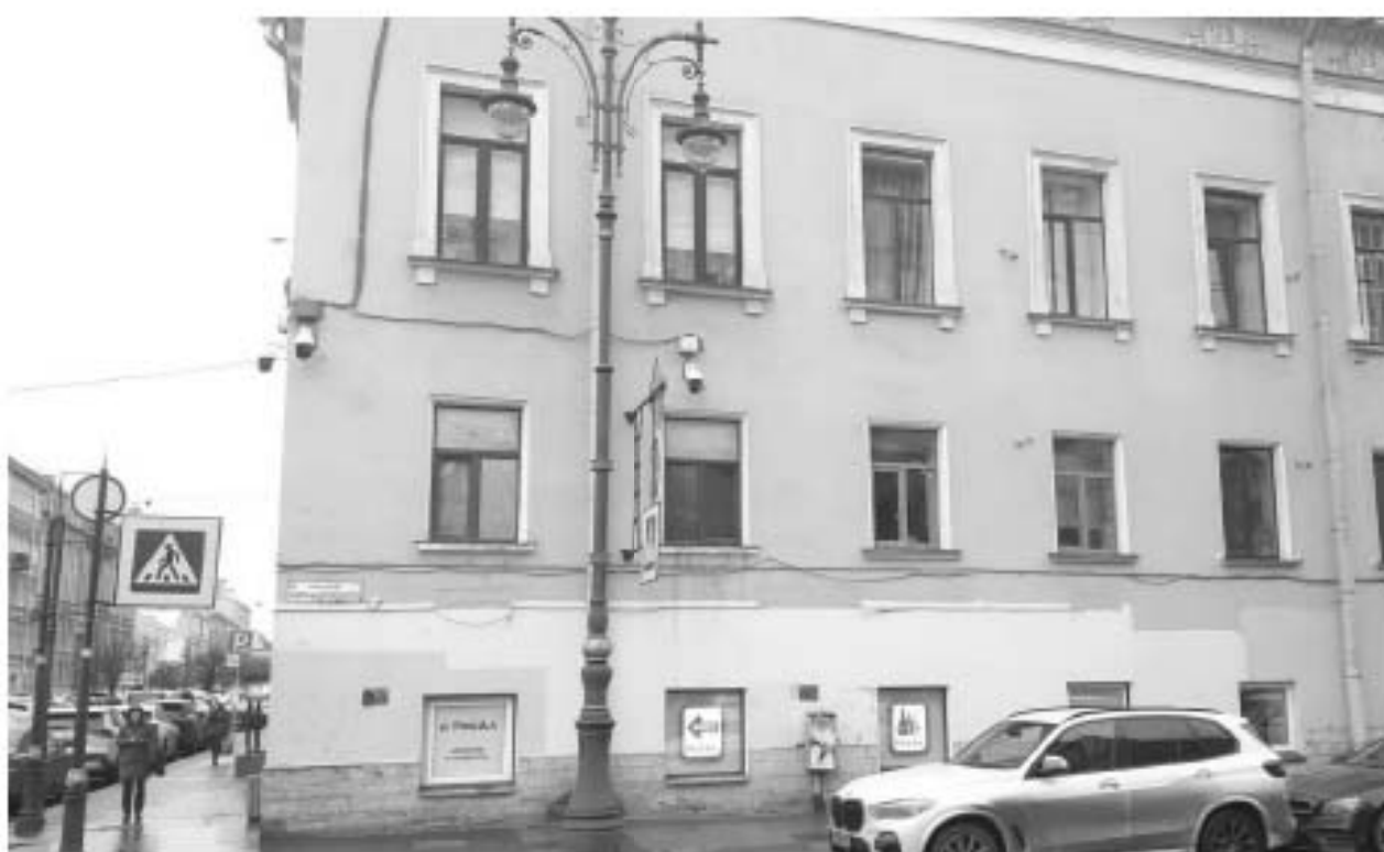
12. «Лазаретный дом» (в составе «Комплекс зданий Конторского двора Гоф-интендантской конторы») (Захарьевская ул., д. 14, лит. Г). Лицевой фасад по ул. Чернышевского (фрагмент). Фото мест установки оборудования и прокладки кабельных трасс. Штиглиц М.С. 15.11.2025 г.
