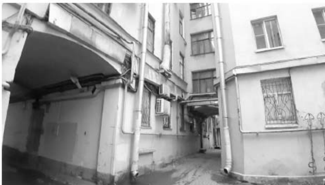
25. «Дом Демидовых (А.М. Ушакова)» (Малая Садовая ул., д. 3/54, лит. А). Дворовые фасады. Фото мест установки оборудования и прокладки кабельных трасс. Штиглиц М.С. 15.11.2025 г.
