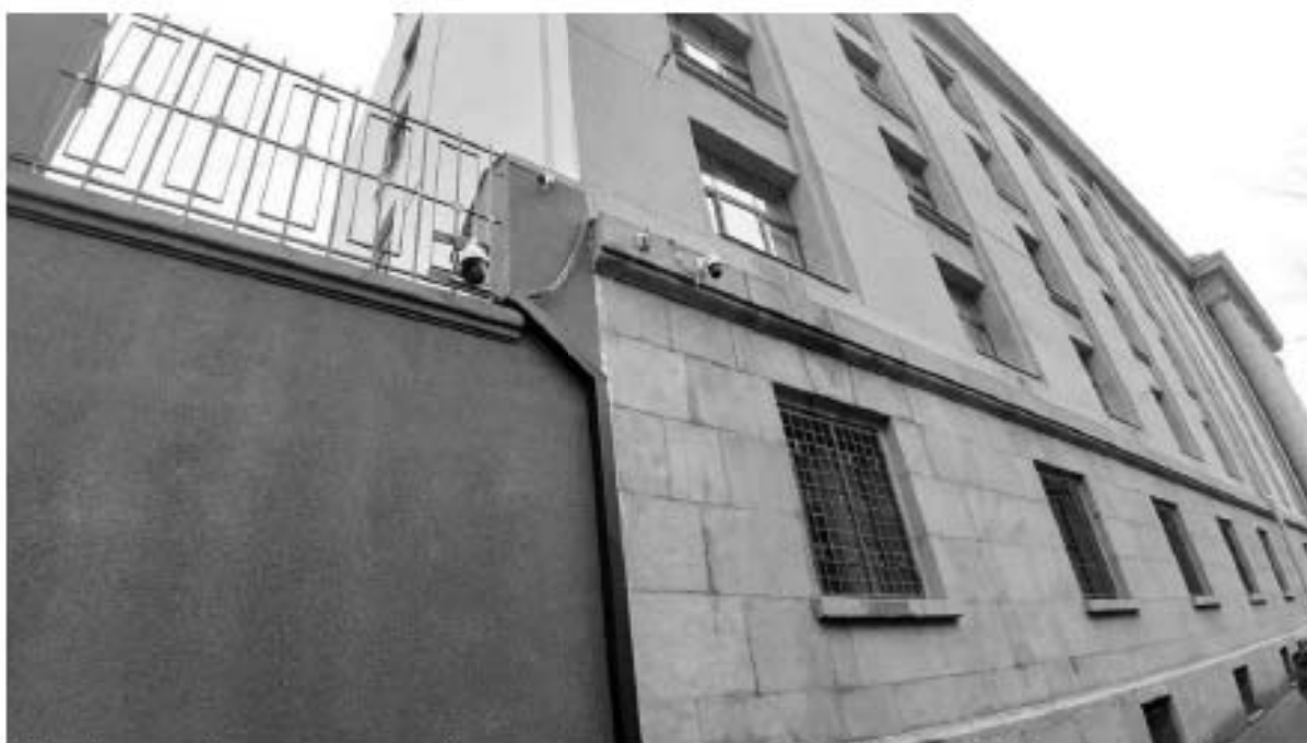
39. «Здание Академии легкой промышленности им. С.М.Кирова» (Суворовский пр., д. 50-52, лит. А). Лицевой фасад по Кавалергардской ул. (фрагмент). Фото мест установки оборудования и прокладки кабельных трасс. Штиглиц М.С. 15.11.2025 г.
