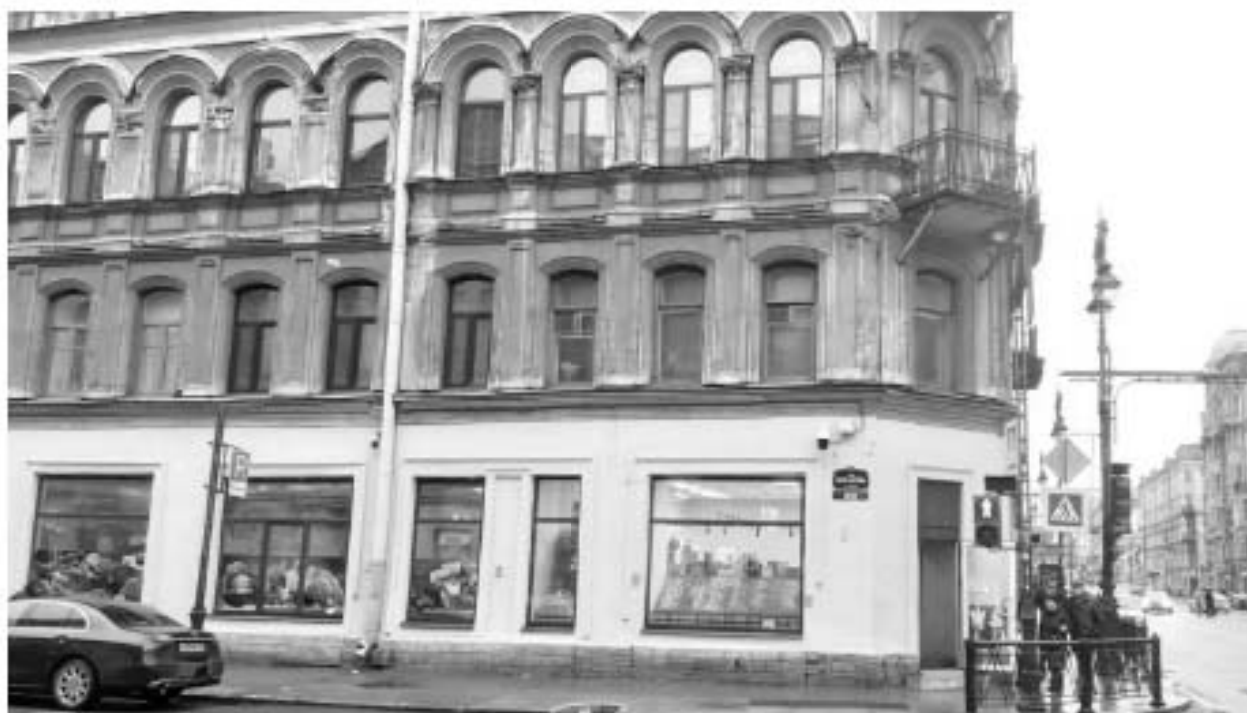
45. «Дом, где с 1881 по 1890 г. жил художественный критик Стасов Владимир Васильевич (б. кв. 6)» (Некрасова ул., д. 38/26, лит. А). Лицевой фасад по Некрасова ул. (фрагмент). Фото мест установки оборудования и прокладки кабельных трасс. Штиглиц М.С. 15.11.2025 г.
