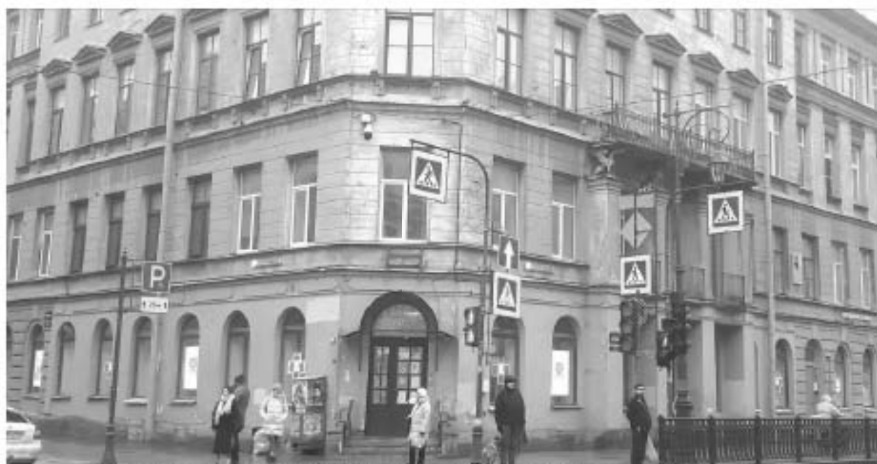
28. «Дом А.Х. Пеля» (Моховая ул., д. 22, лит. А). Лицевой фасад по Моховой ул. (фрагмент). Фото мест установки оборудования и прокладки кабельных трасс. Штиглиц М.С. 15.11.2025 г.
