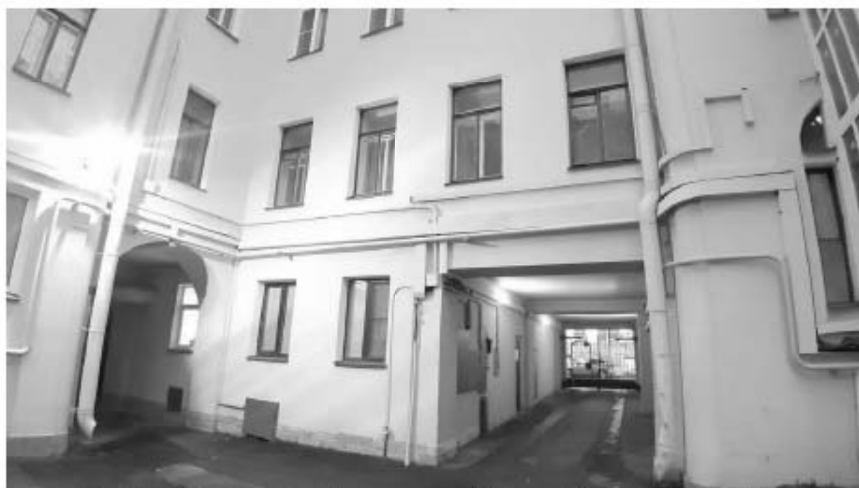
52. «Дом Г.Г. Мекленбург-Стрелицкого» (Рубинштейна ул., д. 5, лит. А). Дворовые фасады. Фото мест установки оборудования и прокладки кабельных трасс. Штиглиц М.С. 15.11.2025 г.
