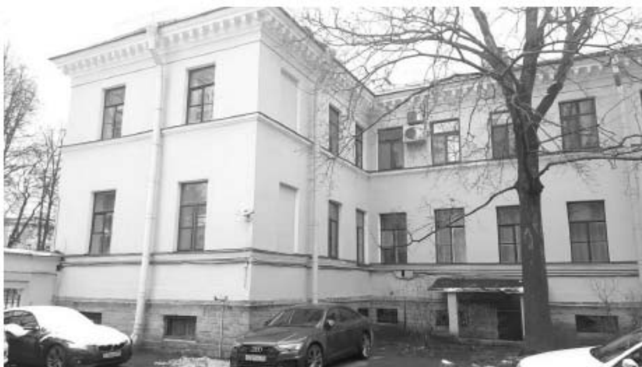
19. «Казармы офицерские (два корпуса)» (в составе «Казармы Преображенского полка») (Кирочная ул., д. 37, лит. А). Дворовые фасады. Фото мест установки оборудования и прокладки кабельных трасс. Штиглиц М.С. 15.11.2025 г.
