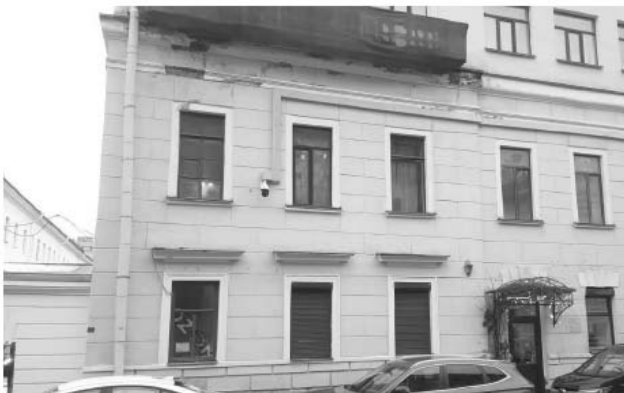
6. «Три жилых корпуса (в составе «Комплекс зданий Конторского двора Гоф-интенданской конторы»)) (Захарьевская ул., д. 14, лит. В). Лицевой фасад. Фото мест установки оборудования и прокладки кабельных трасс. Штиглиц М.С. 15.11.2025 г.
