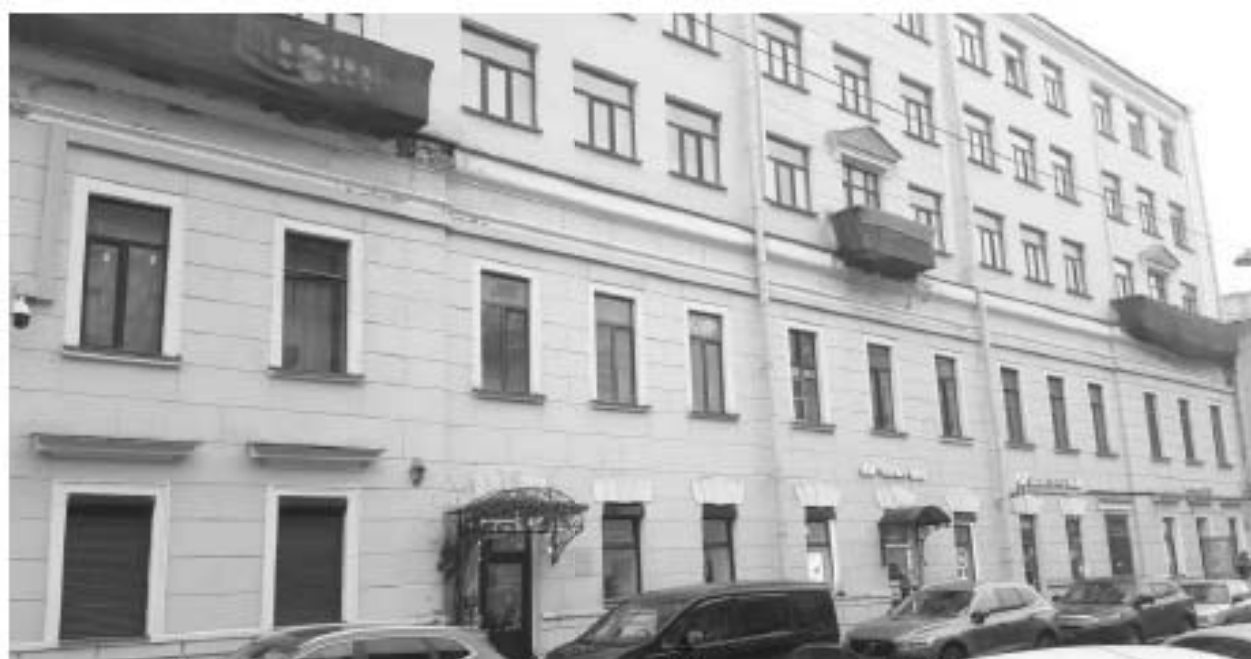
7. «Три жилых корпуса (в составе «Комплекс зданий Конторского двора Гоф-интенданской конторы»))» (Захарьевская ул., д. 14, лит. В). Лицевой фасад. Фото мест установки оборудования и прокладки кабельных трасс. Штиглиц М.С. 15.11.2025 г.
