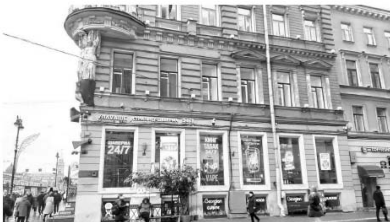
23. «Дом Демидовых (А.М. Ушакова)» (Малая Садовая ул., д. 3/54, лит. А). Лицевой фасад по Малой Садовой ул. (фрагмент). Фото мест установки оборудования и прокладки кабельных трасс. Штиглиц М.С. 15.11.2025 г.
