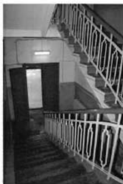
Фото №8. Боковая (западная) межэтажная лестница.
