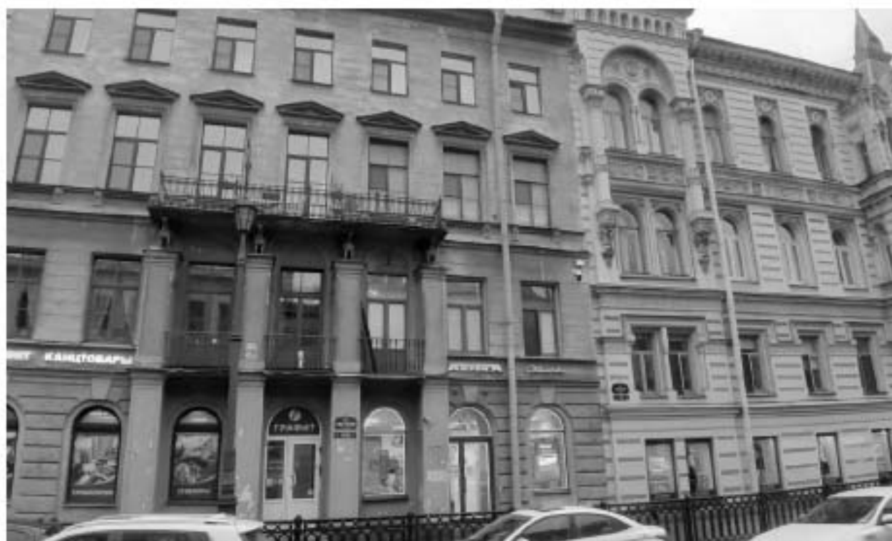
29. «Дом А.Х. Пеля» (Моховая ул., д. 22, лит. А). Лицевой фасад по Пестеля ул. (фрагмент). Фото мест установки оборудования и прокладки кабельных трасс. Штиглиц М.С. 15.11.2025 г.
