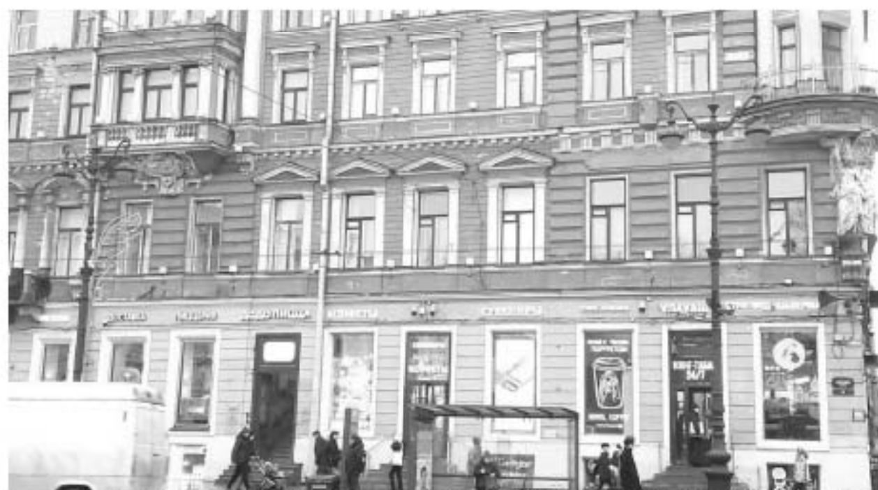
24. «Дом Демидовых (А.М. Ушакова)» (Малая Садовая ул., д. 3/54, лит. А). Лицевой фасад по Невскому пр. (фрагмент). Фото мест установки оборудования и прокладки кабельных трасс. Штиглиц М.С. 15.11.2025 г.
