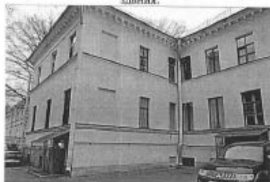
Фото 7. Здание по адресу: Кирочная улица, дом 31, лит. А. Фрагмент дворового фасада здания.
