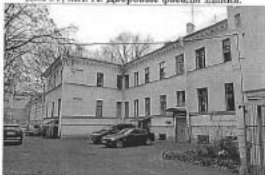
Фото 6. Здание по адресу: Кирочная улица, дом 31, лит. А. Дворовые фасады здания.
