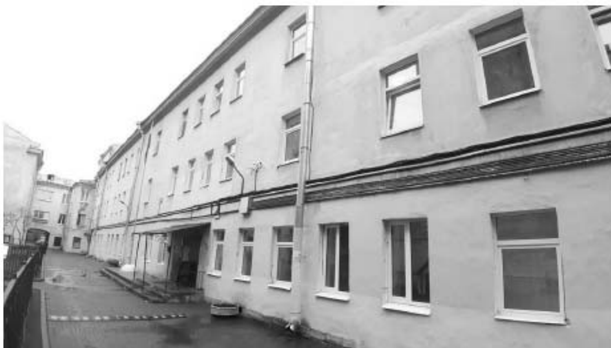
3. «Дом» (в составе «Особняк и дом Жалимировских (Н.Е. Демидовой)»). (Большая Конюшенная ул., д. 7, лит. А). Дворовые фасады. Фото мест установки оборудования и прокладки кабельных трасс. Штиглиц М.С. 15.11.2025 г.
