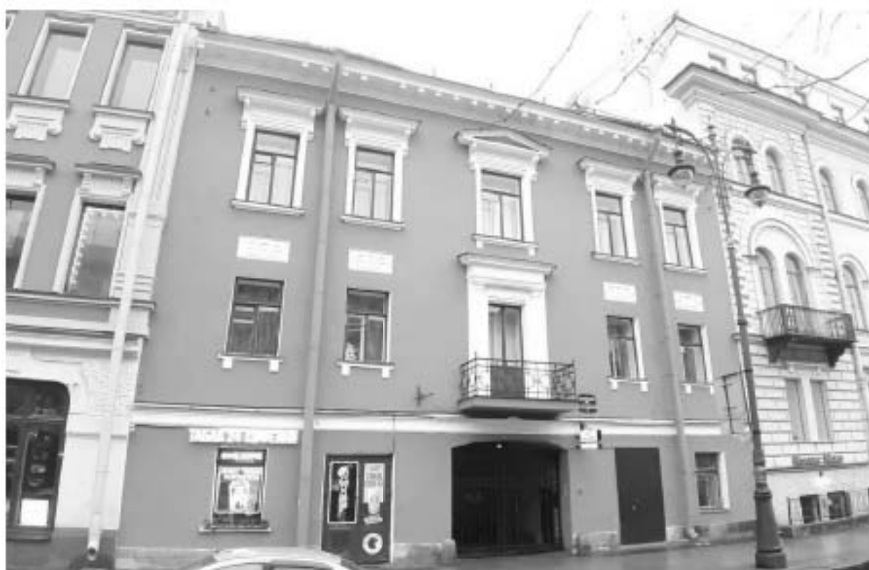
1. «Дом» (в составе «Особняк и дом Жалимировских (Н.Е. Демидовой)»). (Большая Конюшенная ул., д. 7, лит. А). Лицевой фасад. Штиглиц М.С. 15.11.2025 г.
