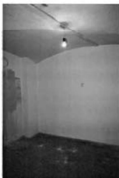
Фото №17. Помещение цокольного этажа.
