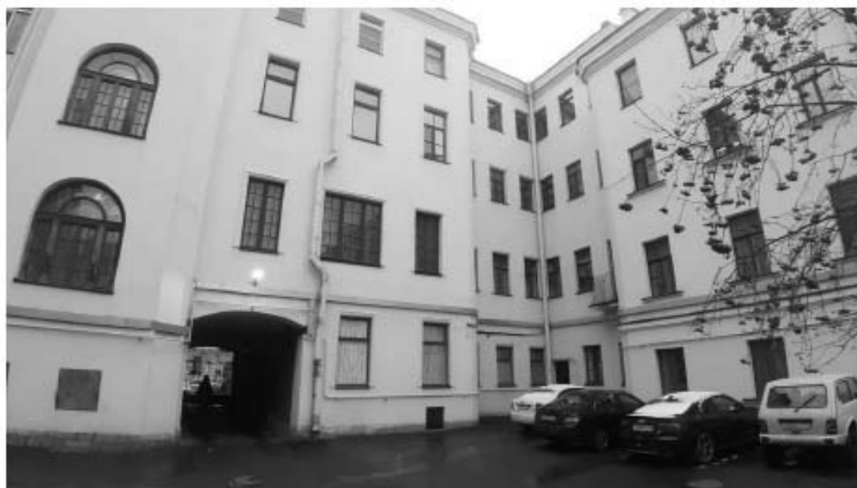
55. «Дом Челищева (Мануса)» (Чайковского ул., д. 31, лит. А). Дворовые фасады. Фото мест установки оборудования и прокладки кабельных трасс. Штиглиц М.С. 15.11.2025 г.
