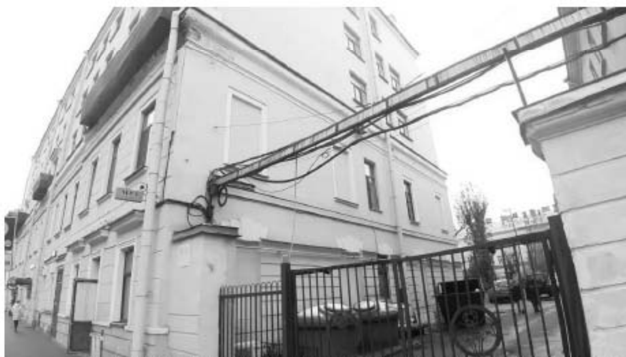
8. «Три жилых корпуса (в составе «Комплекс зданий Конторского двора Гоф-интенданской конторы»))» (Захарьевская ул., д. 14, лит. В). Лицевой фасад. Фото мест установки оборудования и прокладки кабельных трасс. Штиглиц М.С. 15.11.2025 г.
