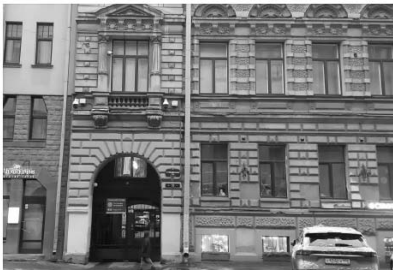
31. «Дом А. Ф. Мюзера» (Стремянная ул., д. 13, лит. А). Лицевой фасад (фрагмент). Фото мест установки оборудования и прокладки кабельных трасс. Штиглиц М.С. 15.11.2025 г.
