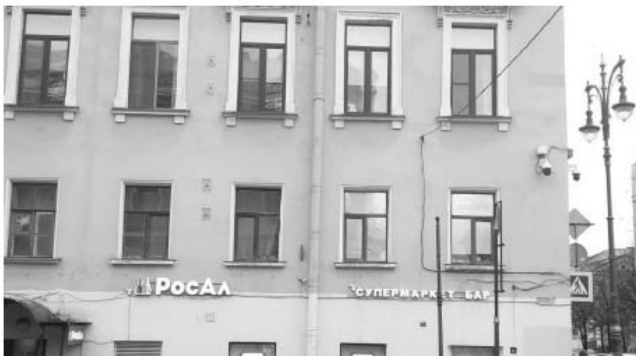
13. «Лазаретный дом» (в составе «Комплекс зданий Конторского двора Гоф-интендантской конторы») (Захарьевская ул., д. 14, лит. Г). Лицевой фасад по Захарьевской ул. (фрагмент). Фото мест установки оборудования и прокладки кабельных трасс. Штиглиц М.С. 15.11.2025 г.
