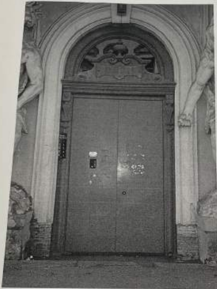
ФОТО № 2. Общий вид входа в парадную со стороны Саперного переулка. Сохранившееся оформление полукруглой фрамуги дверного проема. Декоративная отделка выполнена из древесины хвойных пород и многослойно окрашена масляными красками. Хорошо видна сохранившаяся рельефная резьба.
