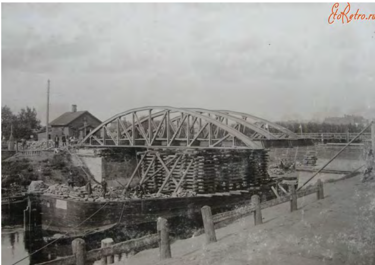
Илл. 14. Демонтаж старого моста через Обводный канал. Источник: https://etoretro.ru/pic267835.search.htm
