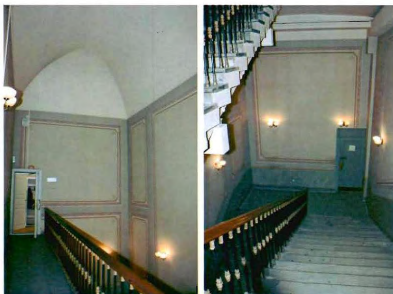
Фото №8, 9. Двухмаршевая межэтажная лестница.
