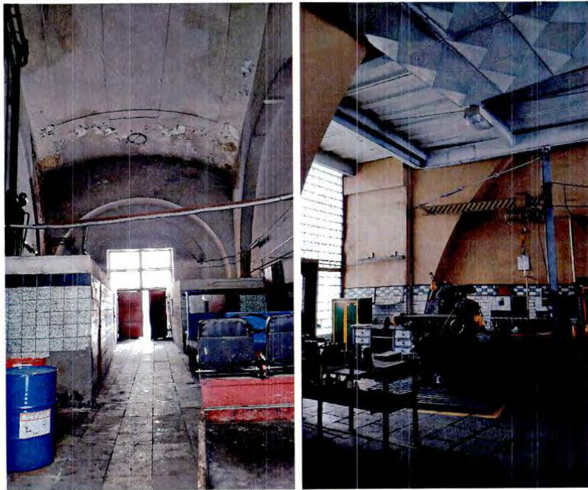
13, 14. Помещения объекта культурного наследия
