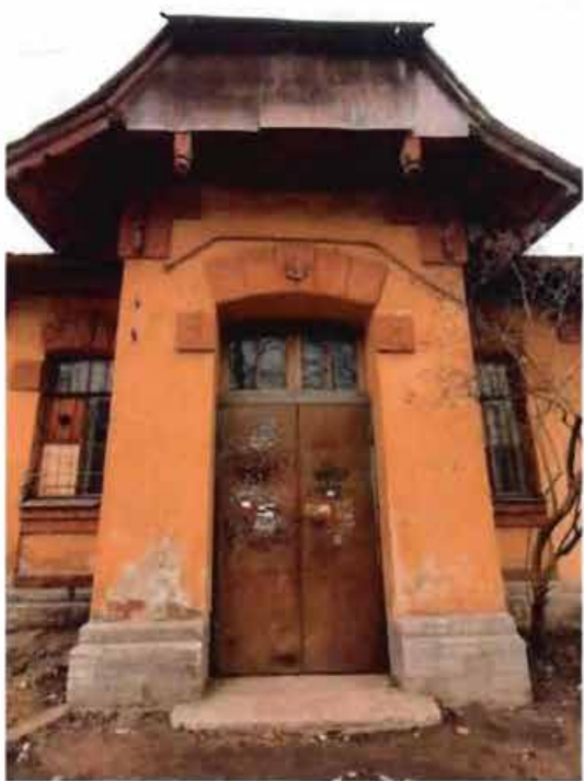
4. Фрагмент восточного фасада
