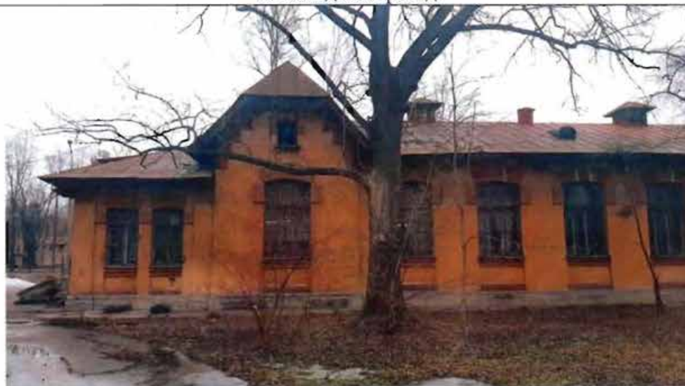
3. Фрагмент южного фасада
