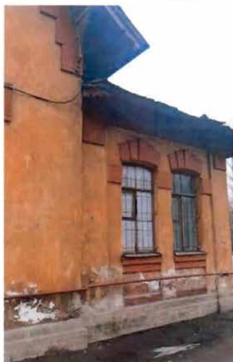
5. Фрагмент северного фасада
