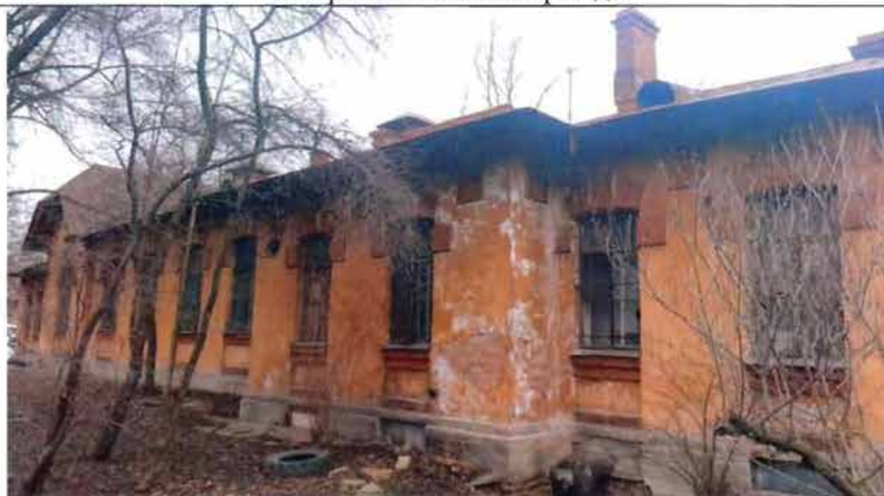
7. Фрагмент южного фасада
