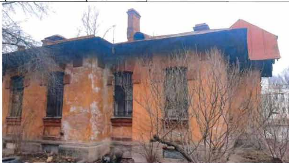
6. Фрагмент южного фасада
