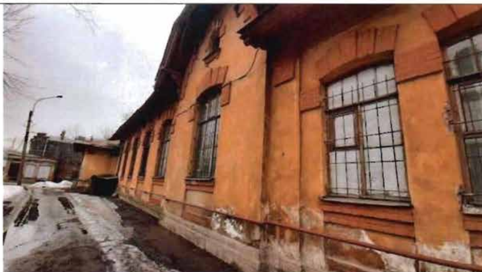
1. Фрагмент северного фасада
