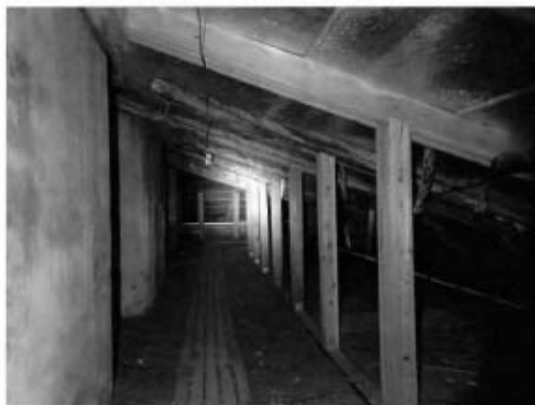
17. Чердачное пространство объекта культурного наследия (фото от 28.11.2023).
