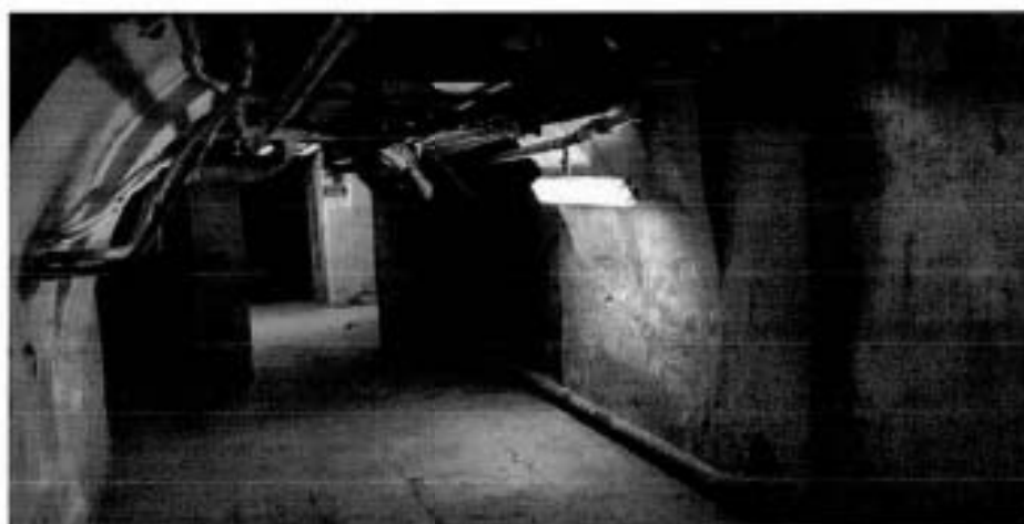
11. Фрагмент интерьеров (помещение подвала)
