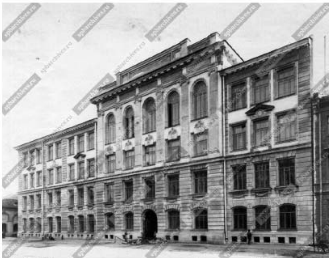
29. «3-я С.Петербургская гимназия с участком бывшего сада») (Соляной пер., д. 12, лит. А). 1995. Фасад здания гимназии. до 1914 г. ЦГАКФФД СПб Е 12573. Фотография ателье Буллы [26].
