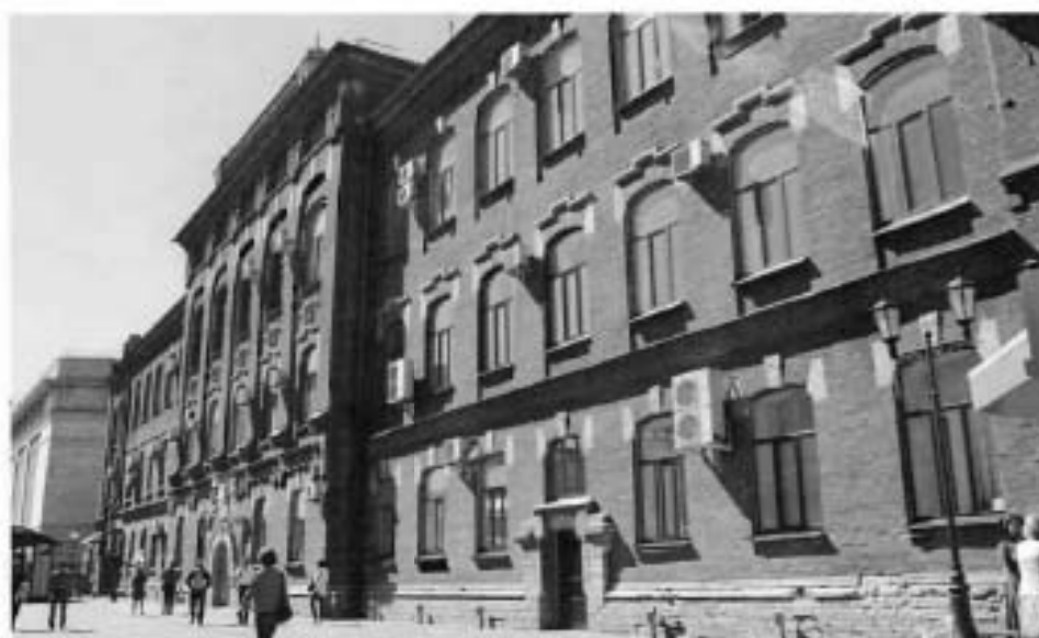
Фото №2. Вид на восточный фасад со стороны ж/д платформ.
