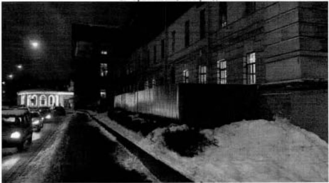
3. Фрагмент лицевого фасада
