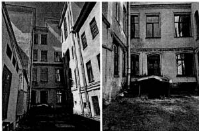
Фото 10, 11. Дворовой (восточный) фасад корпуса по Соляному переулку по южной границе объекта культурного наследия и примыок.
