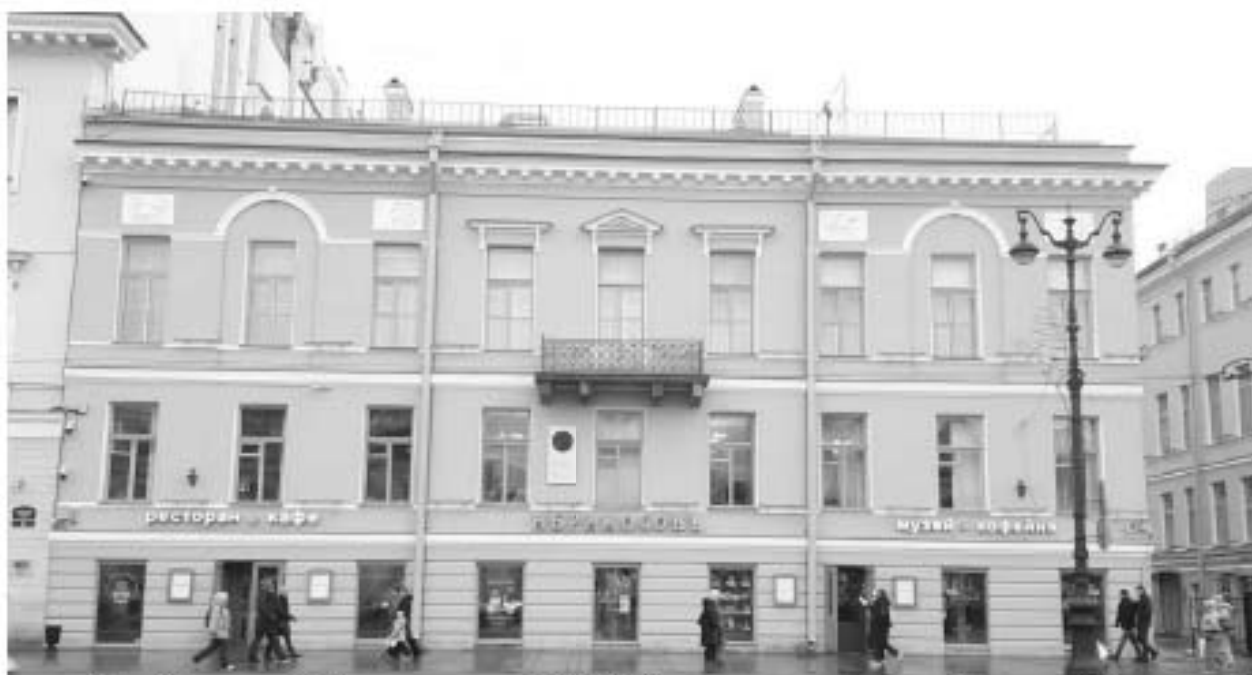
17. «Дом жилой. Здесь жили: в 1823-1832 гг. – государственный деятель Сперанский М.М., в 1823-1825 гг. – декабрист Батеньков Г.С., в 1854-1873 гг. – поэт Тютчев Ф.И.» (в составе «Церковь армянская святой Екатерины») (Невский пр., д. 40-42, лит. А). Лицевой фасад. Штиглиц М.С. 10.11.2025 г.
