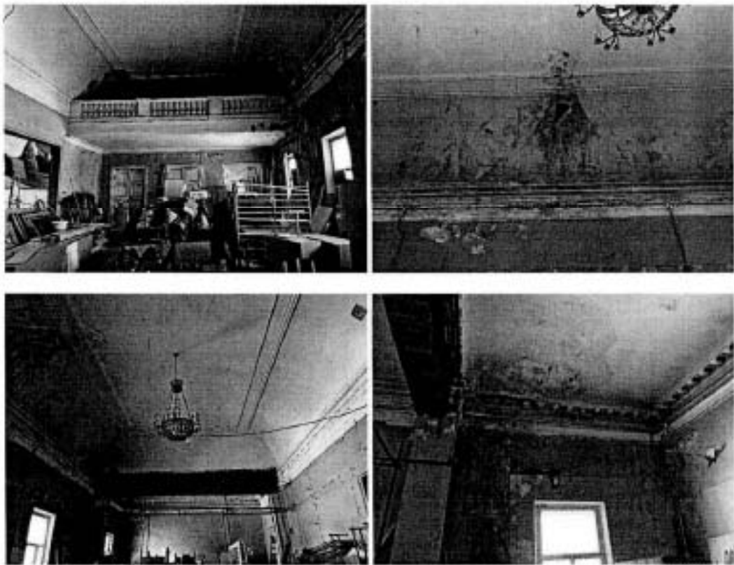
Фото 46, 47, 48, 49. Помещение 2 этажа центрального дворового корпуса (пом. 1-Н (97))
