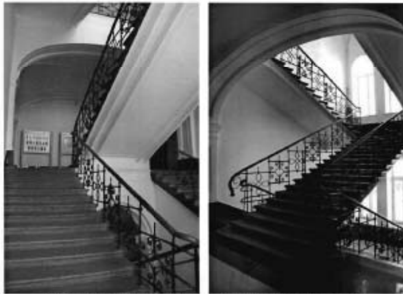
Фото №3, 4, 5. Парадная трехмаршевая распашная межэтажная лестница.
