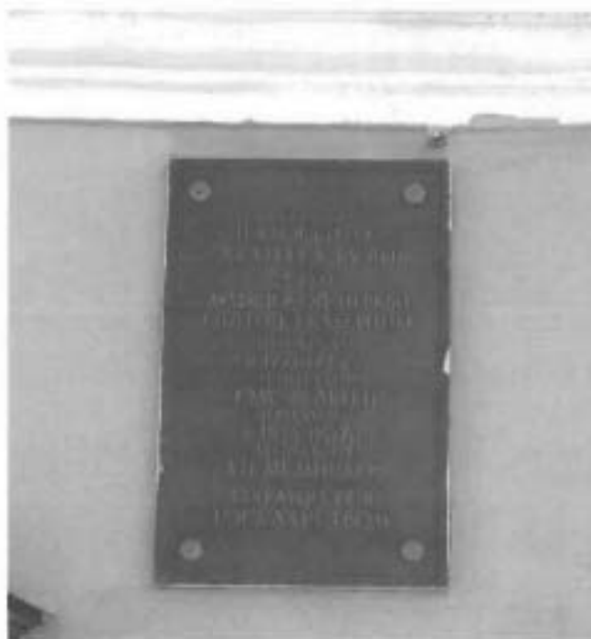
6. Фрагмент западного фасада объекта культурного наследия. Информационная табличка (фото от 06.09.2023).
