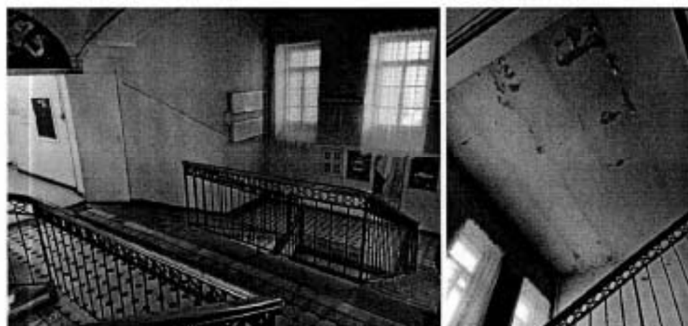
Фото 70, 71. Лестница Л-2 корпуса по Гагаринской улице
