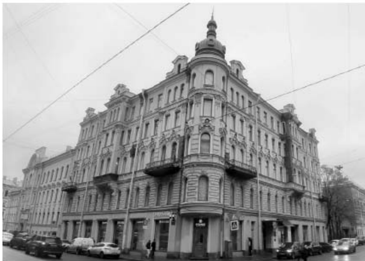
29. «Дом Н.В. Чайковского» (Короленко ул., д. 2, лит. А). Общий вид. Штиглиц М.С. 10.11.2025 г.
