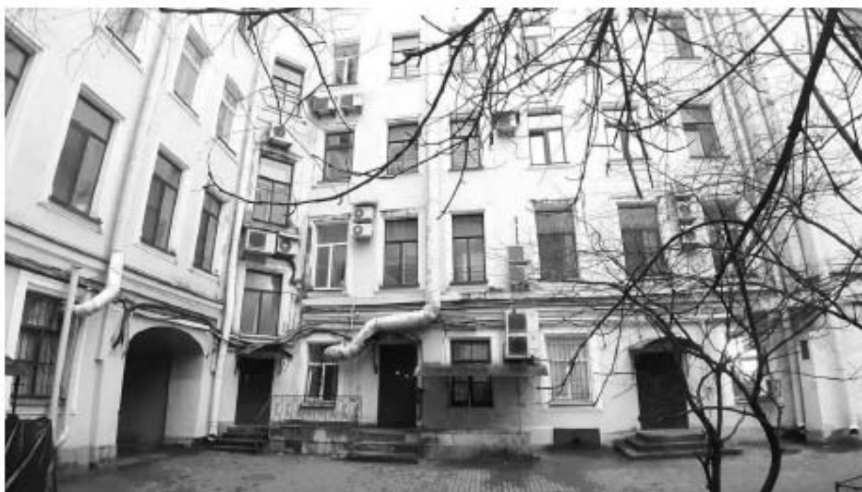
7. «Дом, где в меблированных комнатах «Париж» у Вацлава Вацлавовича Воровского в 1905 г. Владимир Ильич Ленин часто бывал по партийным делам». (наб. реки Фонтанки, д. 29/66, лит. А). Дворовые фасады. Фото мест установки оборудования и прокладки кабельных трасс. Штиглиц М.С. 10.11.2025 г.
