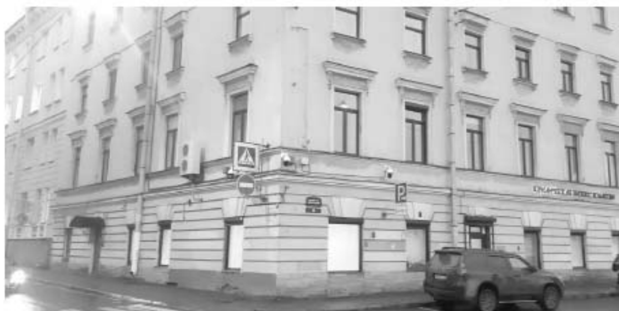
16. «Дом, в котором жили архитектор Л.А. Ильин (в 1918-1942 годах), художник Е.И. Чарушин (в 1948-1965 годах) и др.» (наб. реки Фонтанки, д. 50, лит. А). Лицевой фасад. Фото мест установки оборудования и прокладки кабельных трасс. Штиглиц М.С. 10.11.2025 г.
