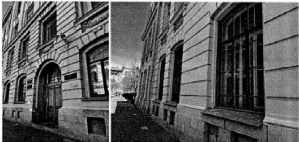
Фото 2, 3. Фрагменты 1 этажа лицевого фасада по Соляному переулку
