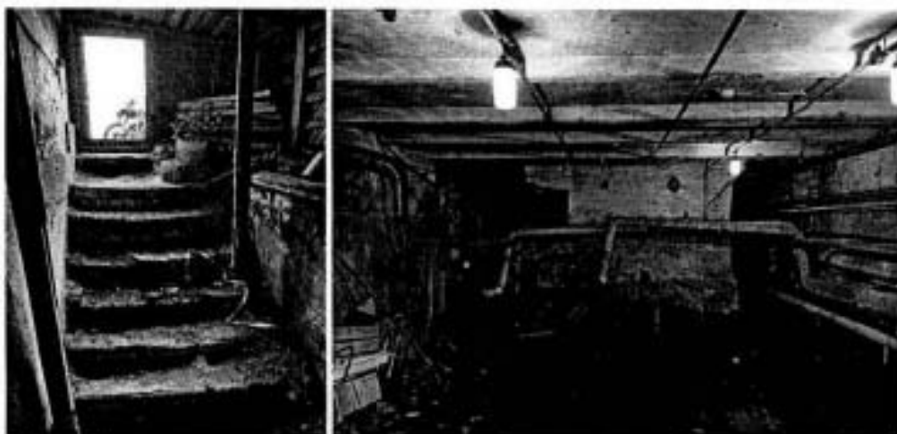
Фото 8. Ступени примыка дворового восточного фасада корпуса по Соляному переулку со стороны северного двора
