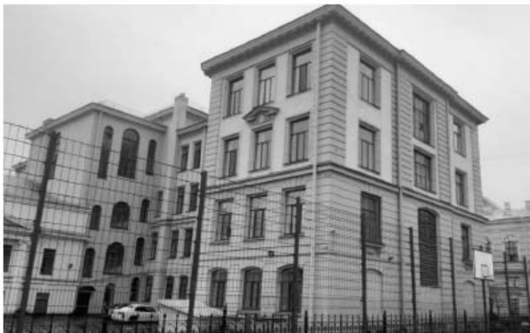
27. «3-я С.Петербургская гимназия с участком бывшего сада») (Соляной пер., д. 12, лит. А). Дворовые фасады. Фото мест установки оборудования и прокладки кабельных трасс. Штиглиц М.С. 10.11.2025 г.
