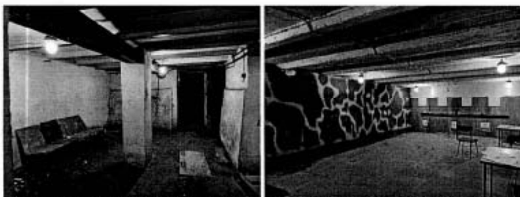
Фото 14, 15. Помещение подвала (пом. 14-Н) в южной части корпуса по Соляному переулку
