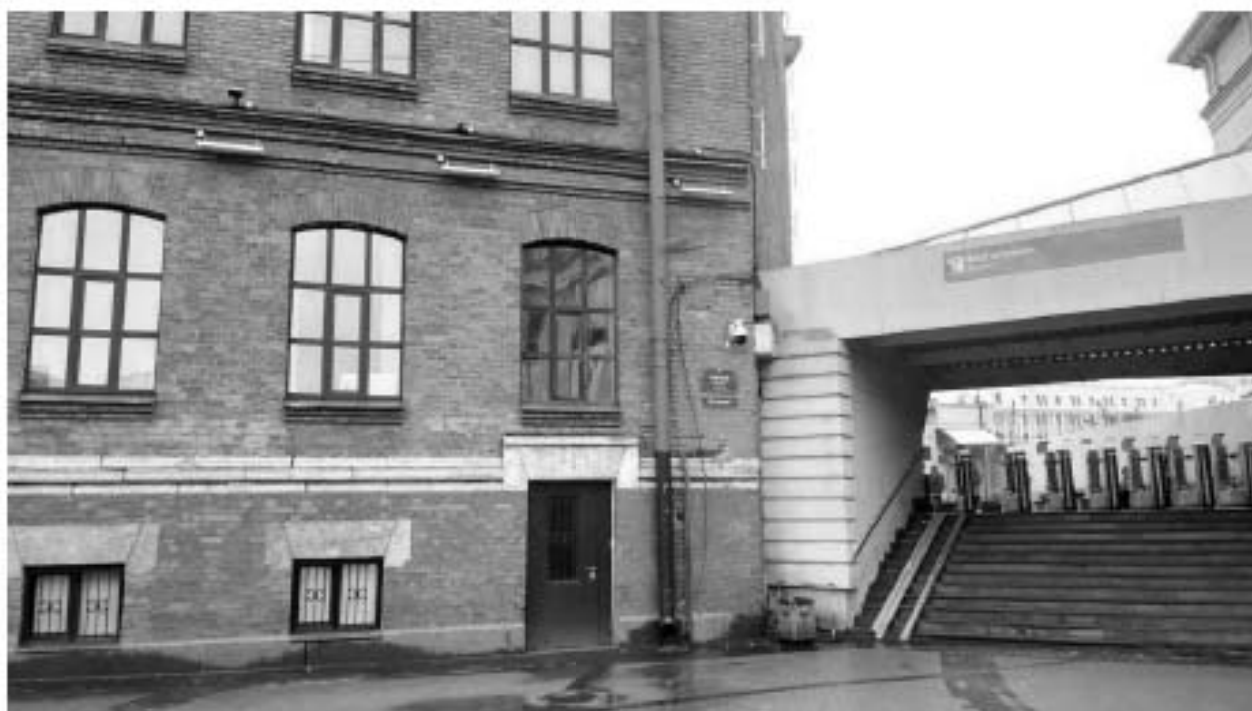
23. «Конторский корпус Николаевского вокзала» (Невский пр., д. 85, лит. 3). Лицевой фасад. Фото мест установки оборудования и прокладки кабельных трасс. Штиглиц М.С. 10.11.2025 г.
