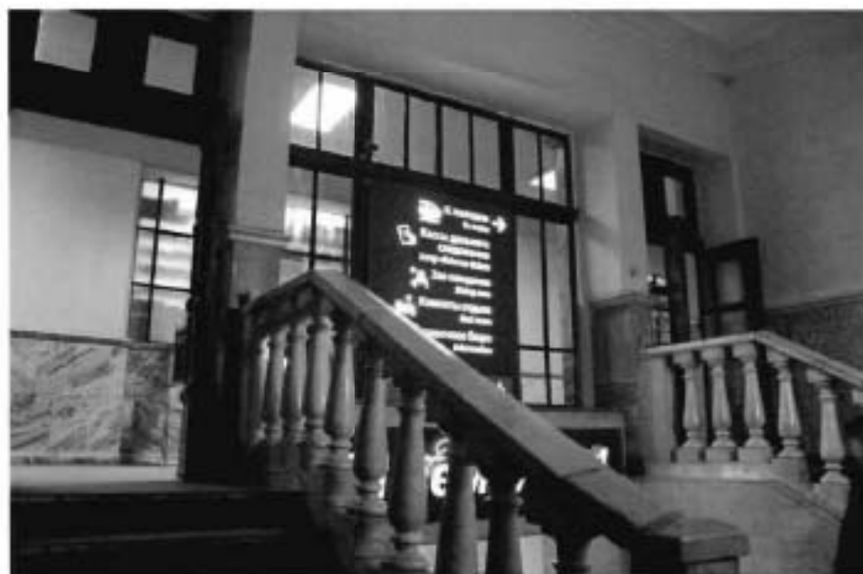
Фото №6. Двухмаршевая лестница от два схода.
