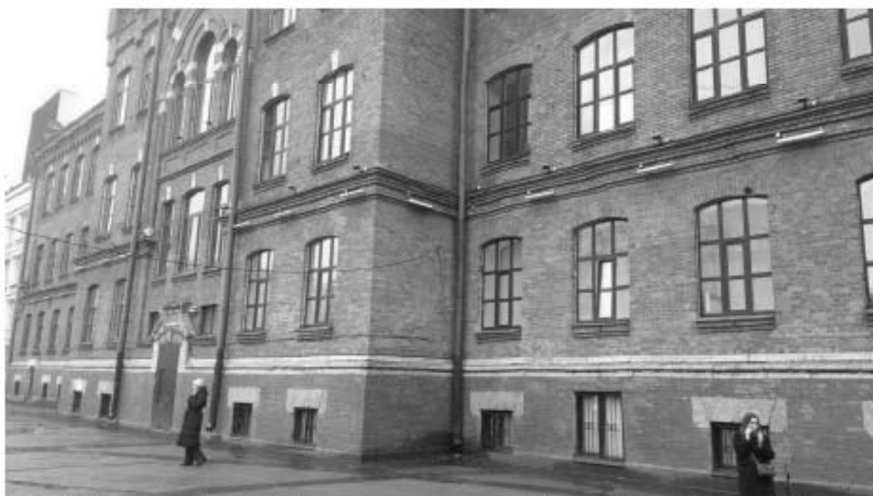
24. «Конторский корпус Николаевского вокзала» (Невский пр., д. 85, лит. 3). Лицевой фасад. Фото мест установки оборудования и прокладки кабельных трасс. Штиглиц М.С. 10.11.2025 г.
