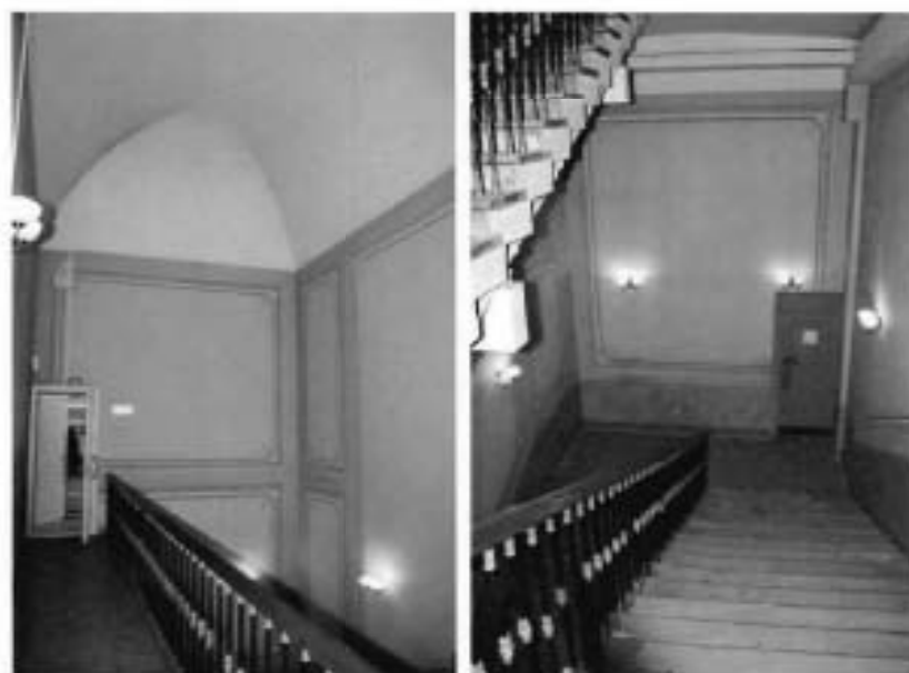
Фото №8, 9. Двухмаршевая межэтажная лестница.
