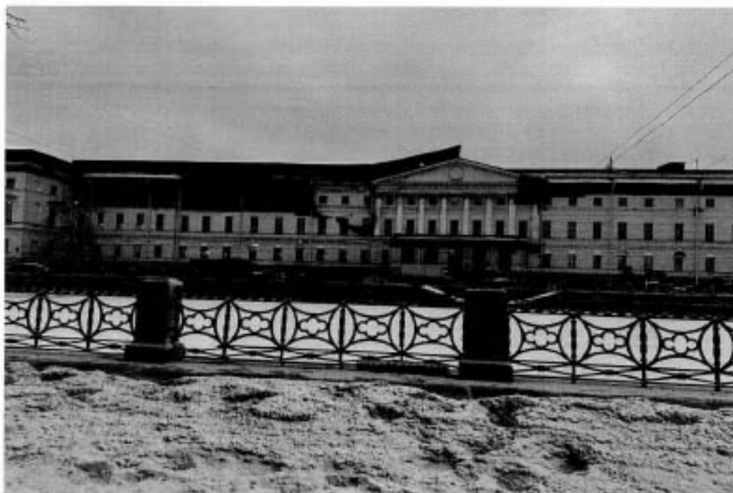
1. Фрагмент лицевого фасада
