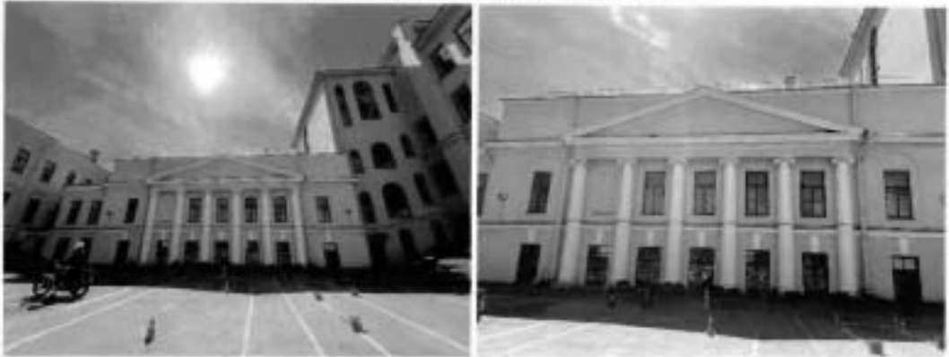
22, 23. Южный фасад центрального дворового корпуса
