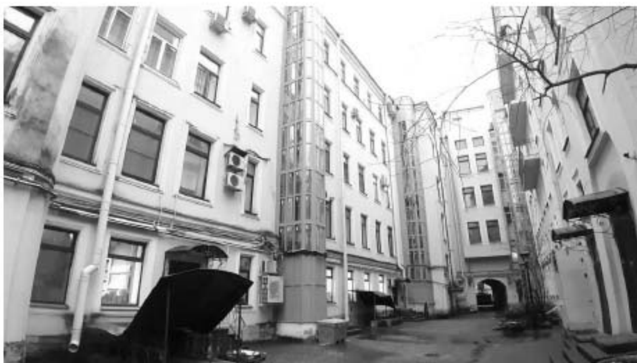
8. «Дом, где в меблированных комнатах «Париж» у Вацлава Вацлавовича Воровского в 1905 г. Владимир Ильич Ленин часто бывал по партийным делам». (наб. реки Фонтанки, д. 29/66, лит. А). Дворовые фасады. Фото мест установки оборудования и прокладки кабельных трасс. Штиглиц М.С. 10.11.2025 г.
