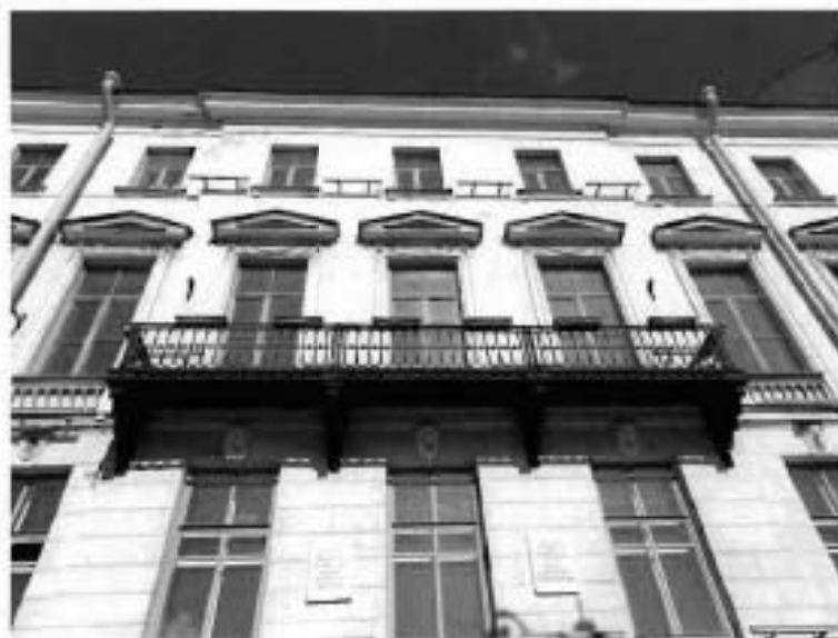
7. Фрагмент южного фасада объекта культурного наследия (фото от 06.09.2023).
