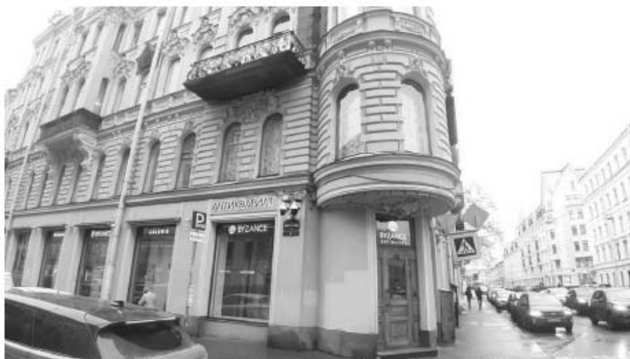
30. «Дом Н.В. Чайковского» (Короленко ул., д. 2, лит. А). Лицевой фасад по Некрасова ул. (фрагмент). Фото мест установки оборудования и прокладки кабельных трасс. Штиглиц М.С. 10.11.2025 г.
