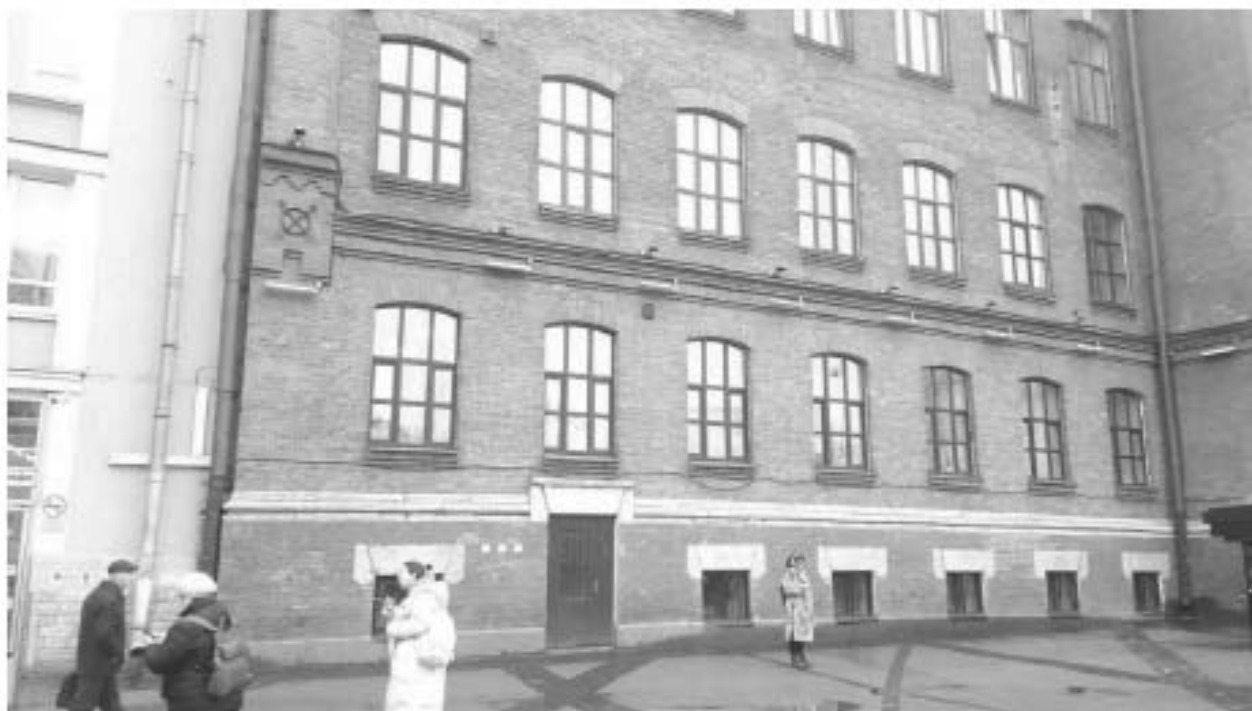
25. «Конторский корпус Николаевского вокзала» (Невский пр., д. 85, лит. 3). Лицевой фасад. Фото мест установки оборудования и прокладки кабельных трасс. Штиглиц М.С. 10.11.2025 г.
