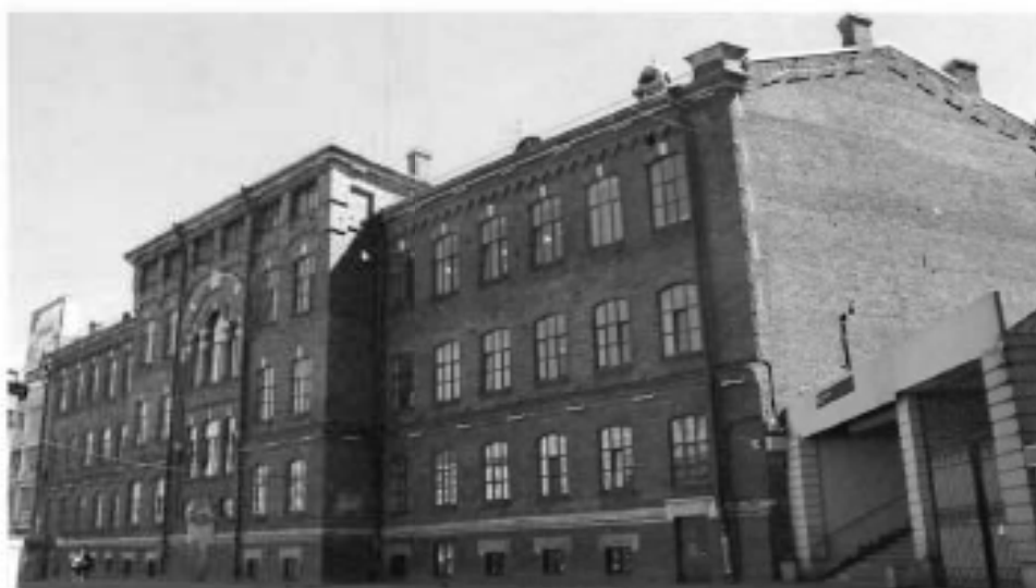
Фото №1. Вид на западный фасад и брадмауэрную южную стену со стороны Лиговского проспекта.
