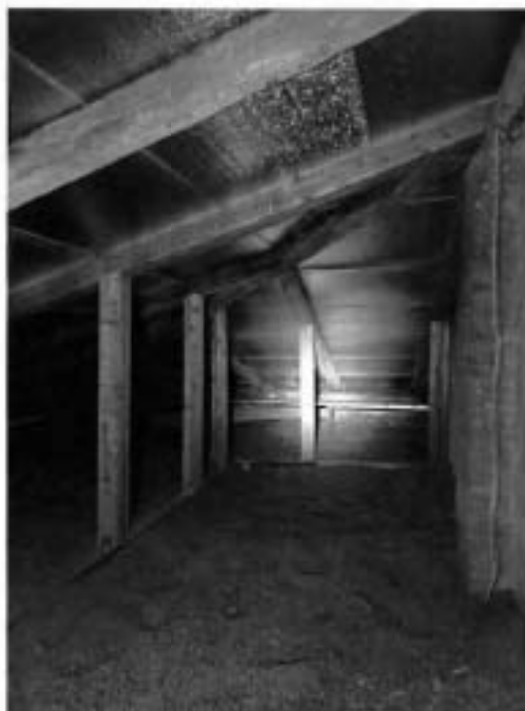
16. Чердачное пространство объекта культурного наследия (фото от 28.11.2023).
