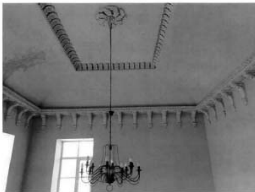
13. Интерьер объекта культурного наследия. 1ЛК в уровне 4-го этажа (фото от 06.09.2023).
