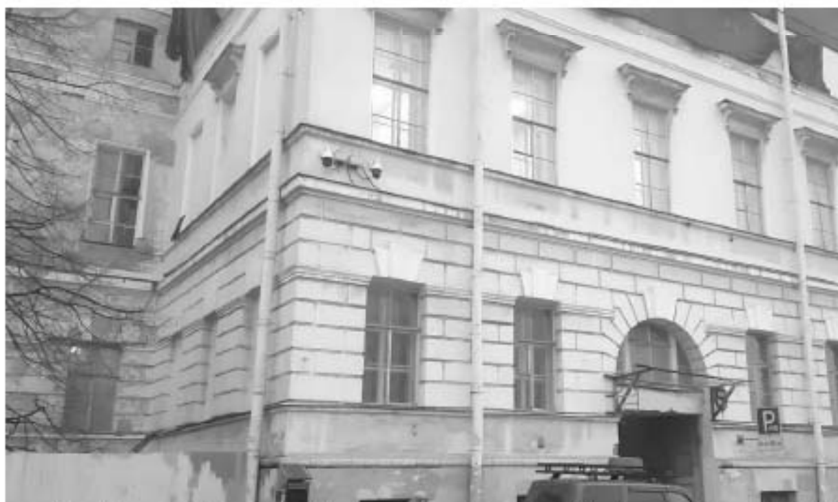
10. «Институт» (в составе «Институт Екатерининский») (наб. реки Фонтанки, д. 36, лит. А). Лицевой фасад. Фото мест установки оборудования и прокладки кабельных трасс. Штиглиц М.С. 10.11.2025 г.
