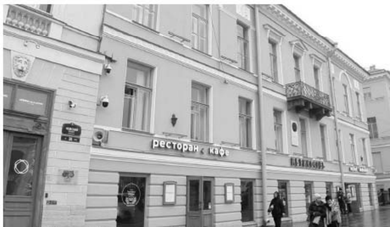
18. «Дом жилой. Здесь жили: в 1823-1832 гг. – государственный деятель Сперанский М.М., в 1823-1825 гг. – декабрист Батеньков Г.С., в 1854-1873 гг. – поэт Тютчев Ф.И.» (в составе «Церковь армянская святой Екатерины») (Невский пр., д. 40-42, лит. А). Лицевой фасад. Фото мест установки оборудования и прокладки кабельных трасс. Штиглиц М.С. 10.11.2025 г.
