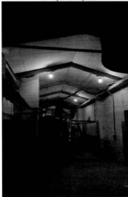
7. Фрагмент помещения чердака
