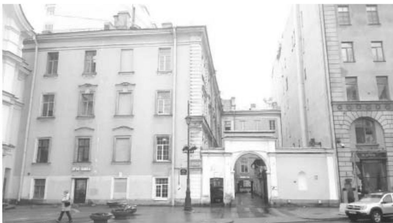
32. «Каменные ворота, помещение для охраны, два флигеля» (в составе «Особняк Кочубея В.П. (комплекс зданий Министерства внутренних дел)») (Пестеля ул., д. 9, лит. В). Лицевой фасад. Штиглиц М.С. 10.11.2025 г.
