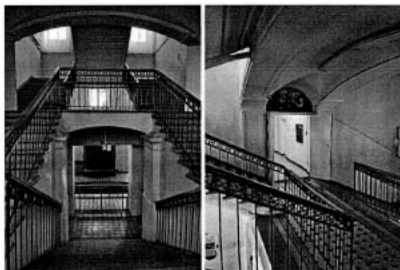
Фото 68, 69. Лестница Л-2 корпуса по Гагаринской улице
