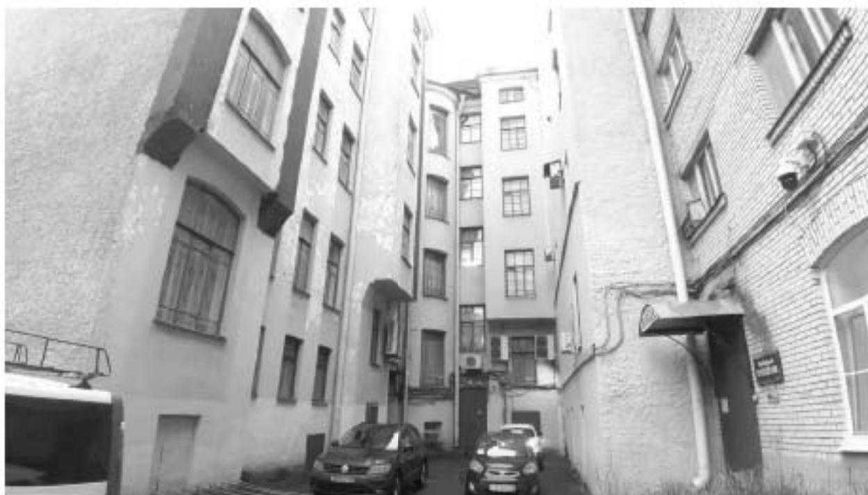
31. «Дом Н.В. Чайковского» (Короленко ул., д. 2, лит. А). Дворовые фасады. Фото мест установки оборудования и прокладки кабельных трасс. Штиглиц М.С. 10.11.2025 г.
