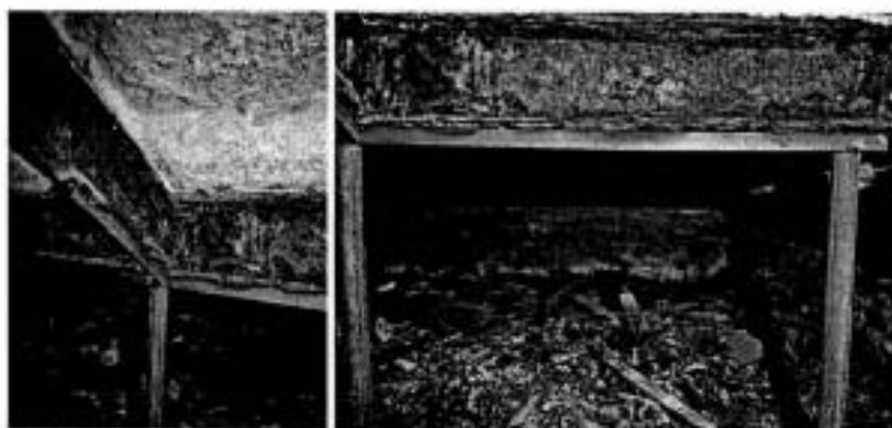
Фото 16, 17. Металлические балки в конструкции лестницы вестибюля (пом. 1Н (2))
