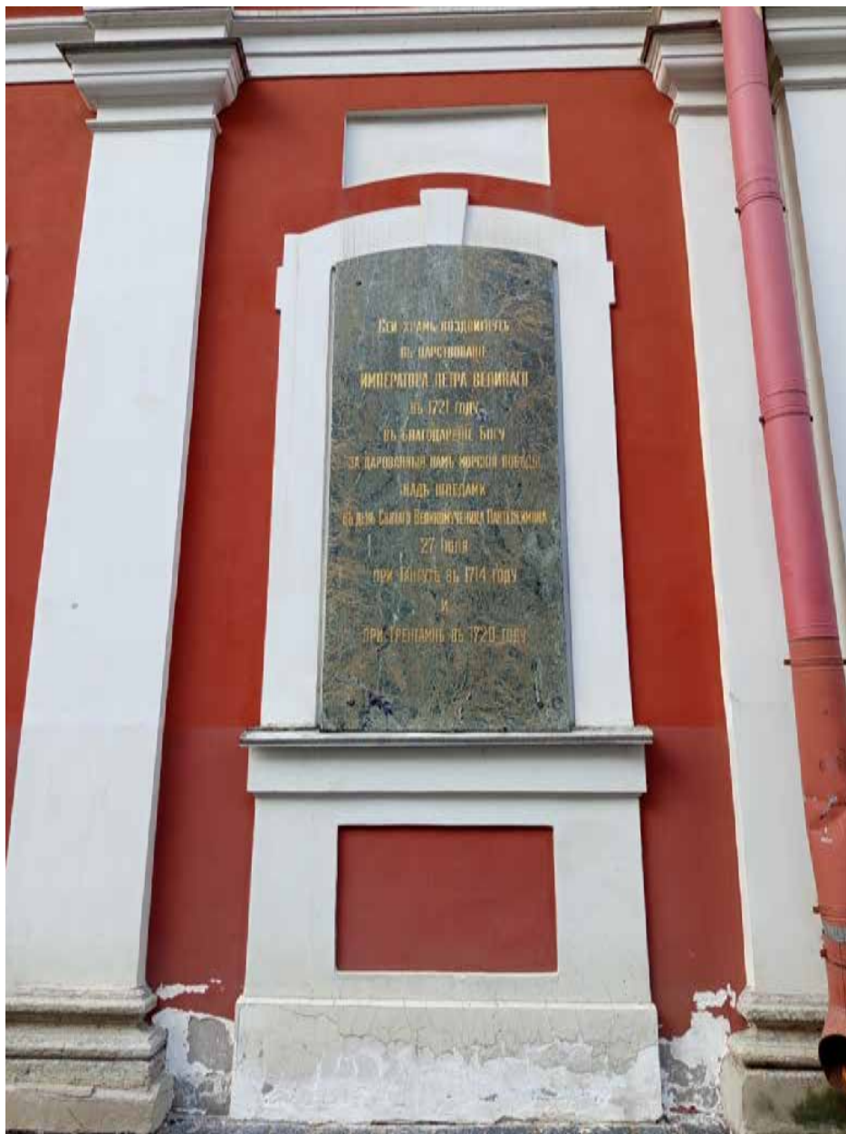
Фото 8. Общий вид части фасада.
