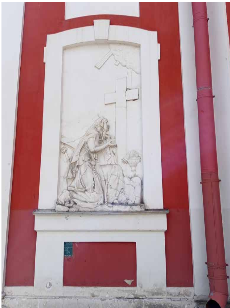
Фото 10. Общий вид части фасада.
