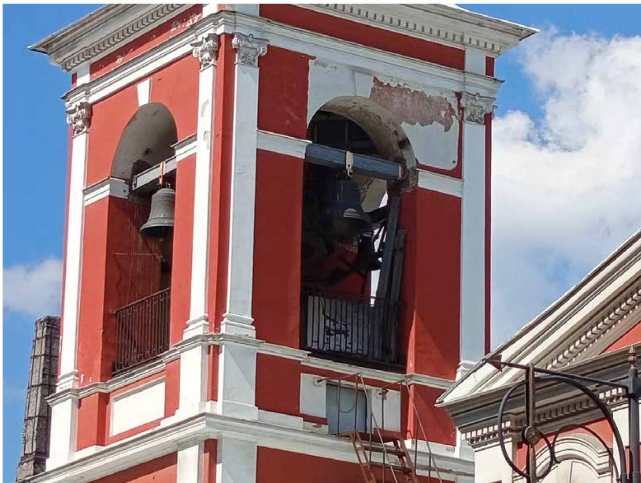
Фото 15. Общий вид части фасада.
