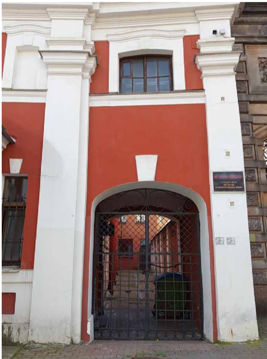
Фото 12. Общий вид части фасада.
