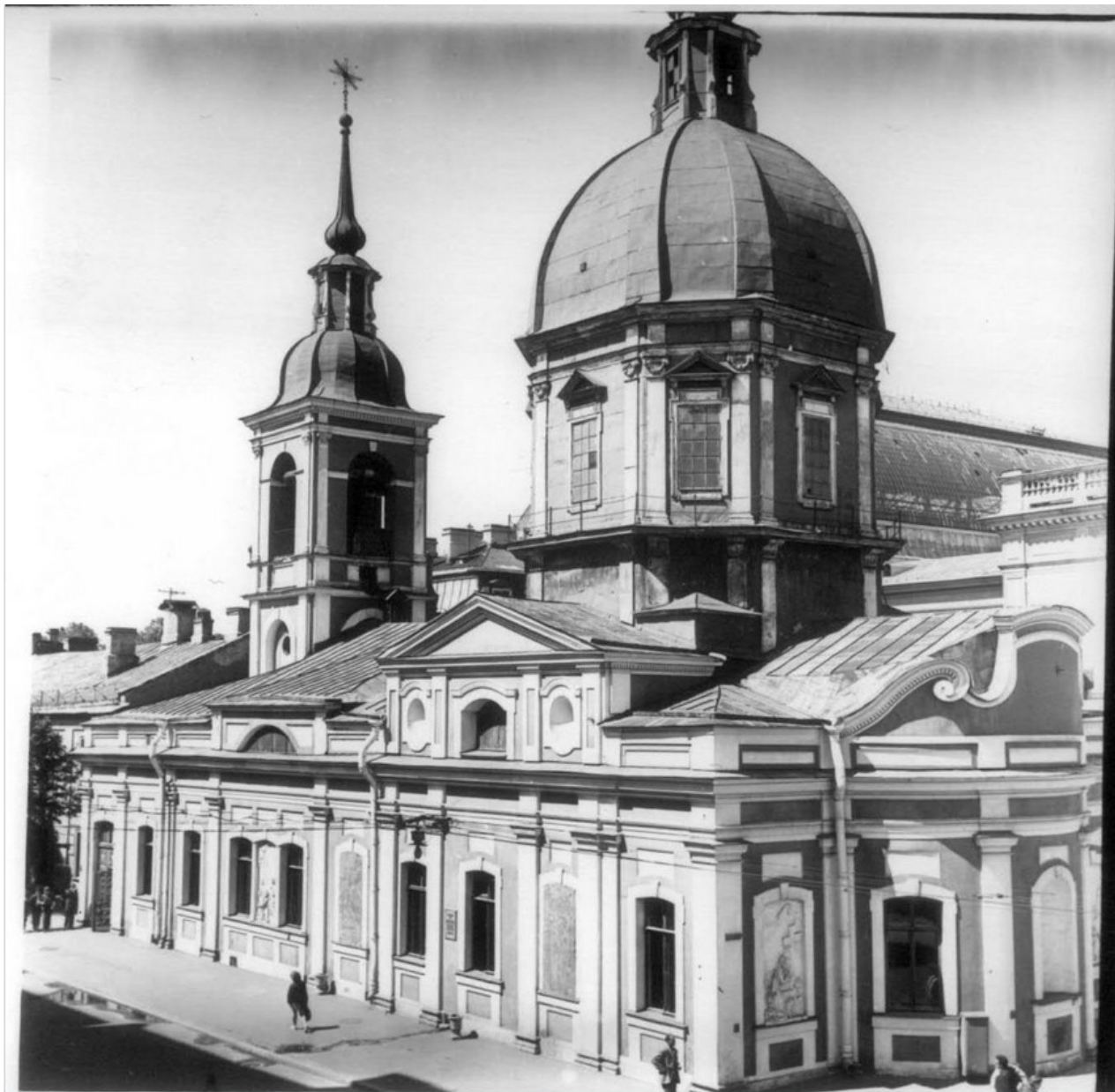
46. Общий вид здания Пантелеймоновской церкви с улицы Пестеля, дом 2а. Филиал Музея истории Ленинграда "Гангутский мемориал", 1970-е гг. ЦГАКФФД СПб. Фотодокументы. Опись 1БР-40. Ед.хр.49374
