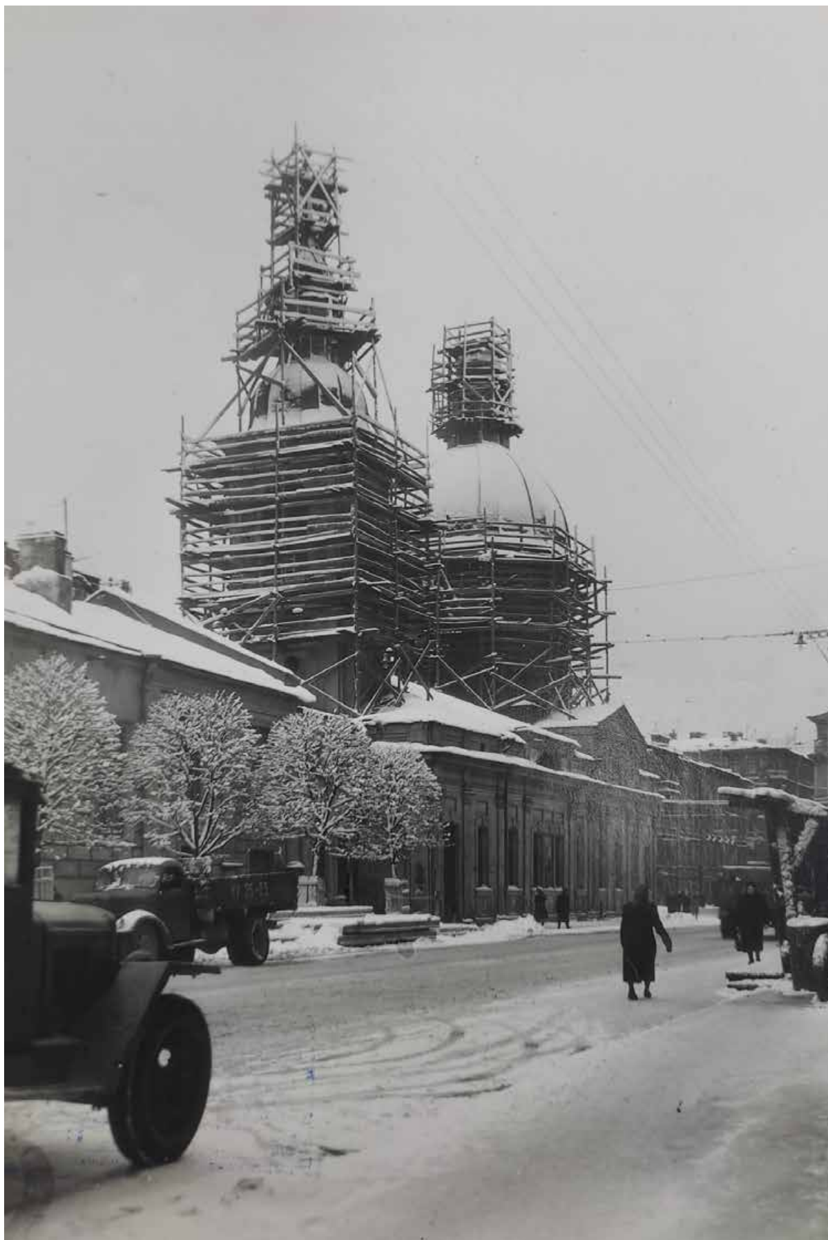
35. Реставрация церкви, 1958 г. Архив КГИОП. П.192.Н-1189
