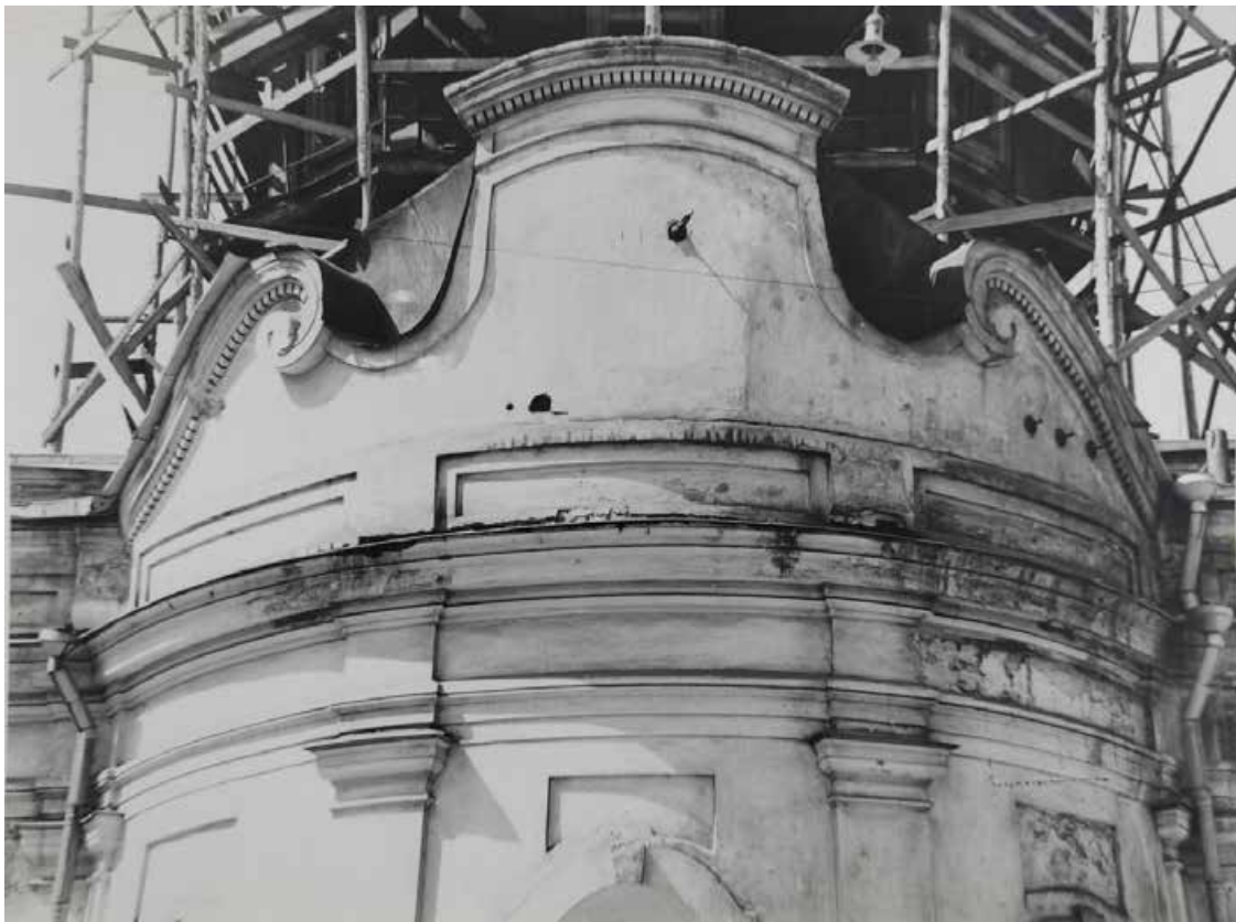
41. Восточный фасад в процессе реставрации, 1958 г. ЦГАНТД СПб. Ф. 488 Оп. 3-24 Д. 709
