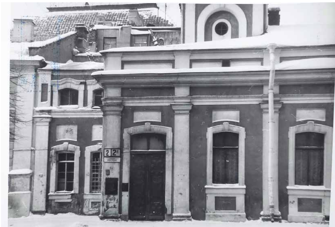
56. Фрагмент южного фасада, ноябрь, 1985 год. ЦГАНТД СПб, Ф.488 Оп.3-24. Д.714
