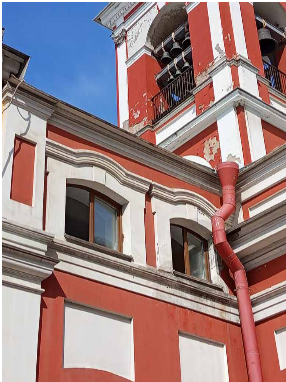
Фото 4. Общий вид части фасада.
