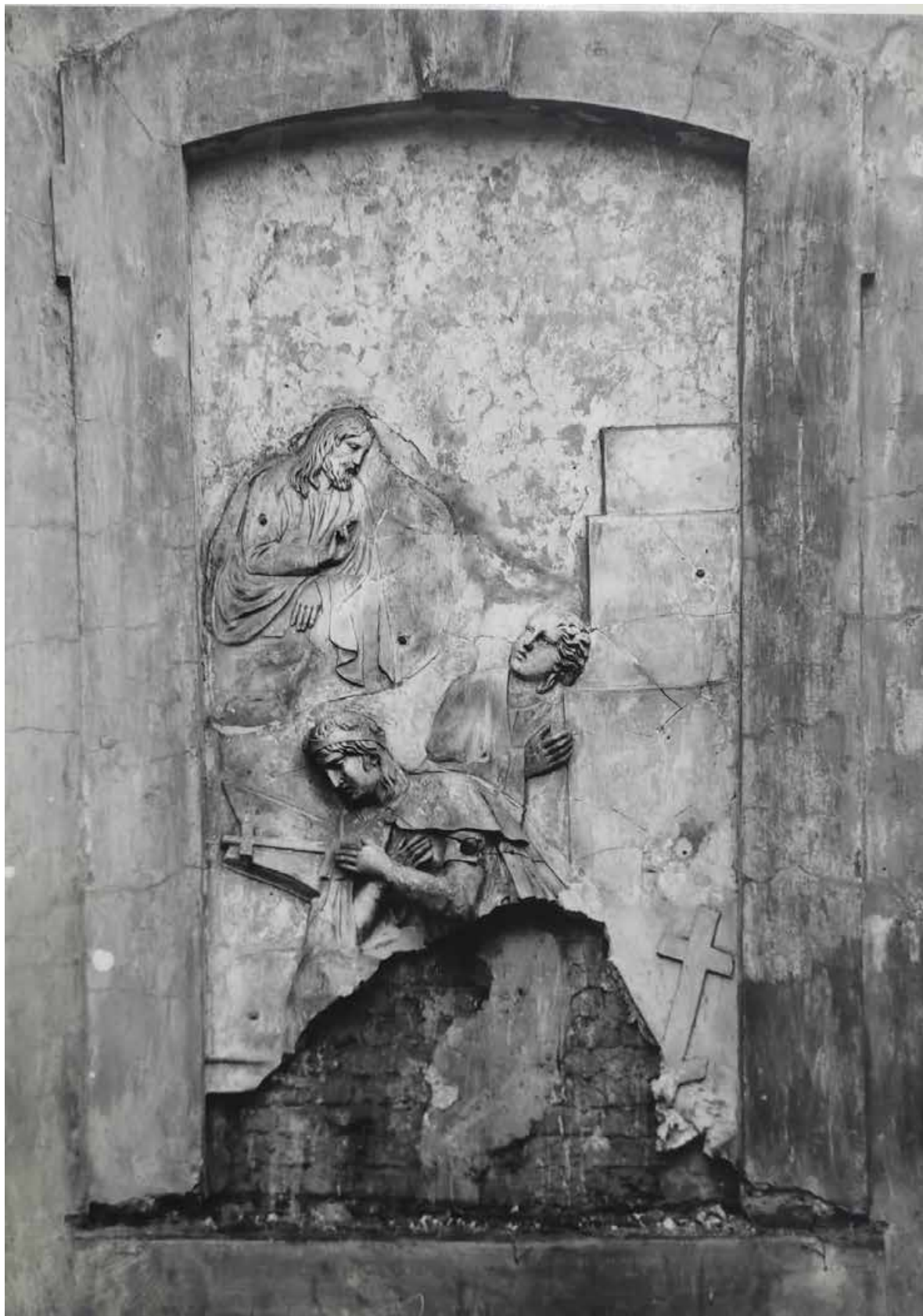
39. Барельеф на восточном фасаде до реставрации, 1958. ЦГАНТДСПб. Ф. 488 Оп. 3-24 Д.
