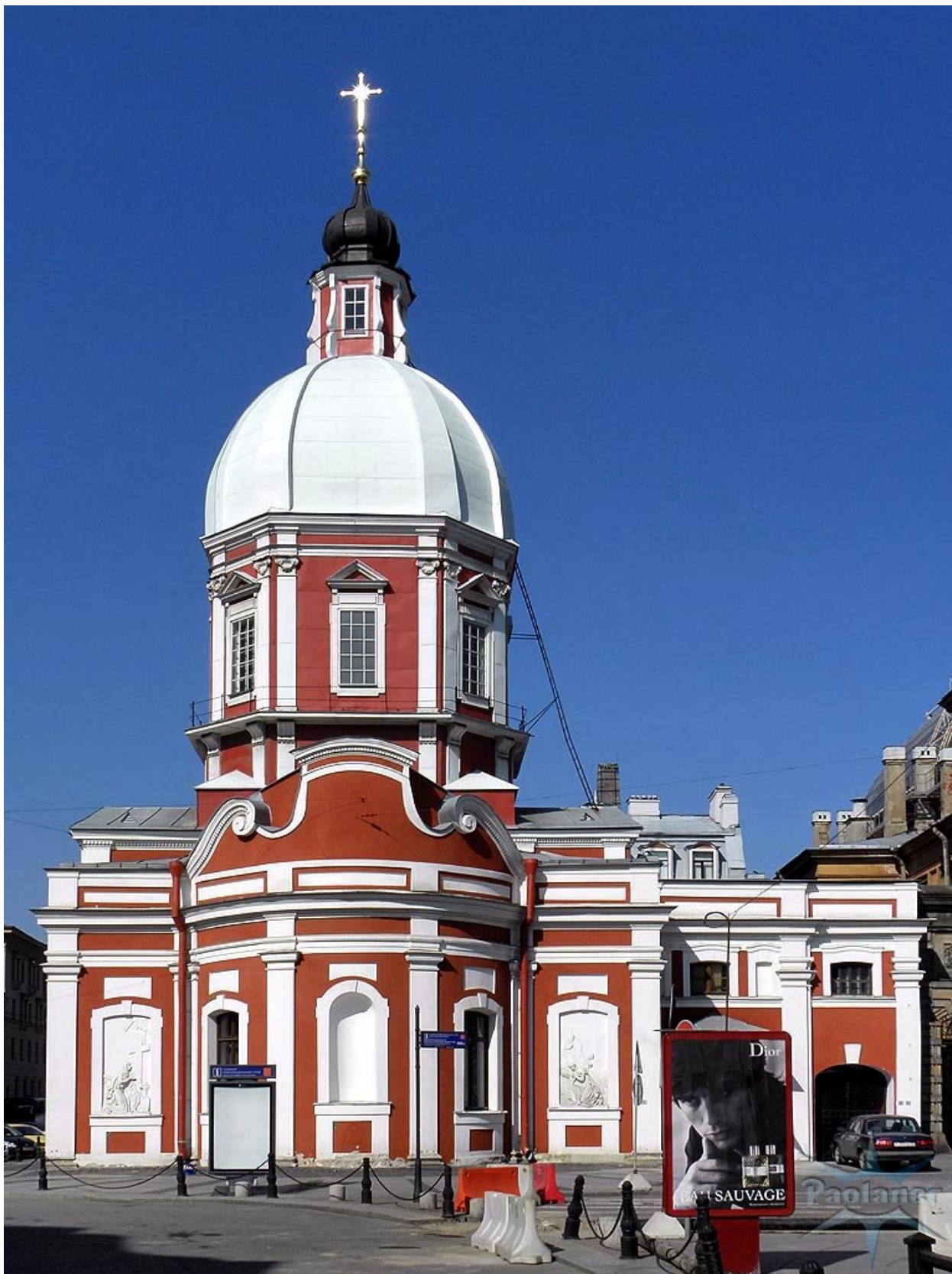
Фото 3. Общий вид объекта.
