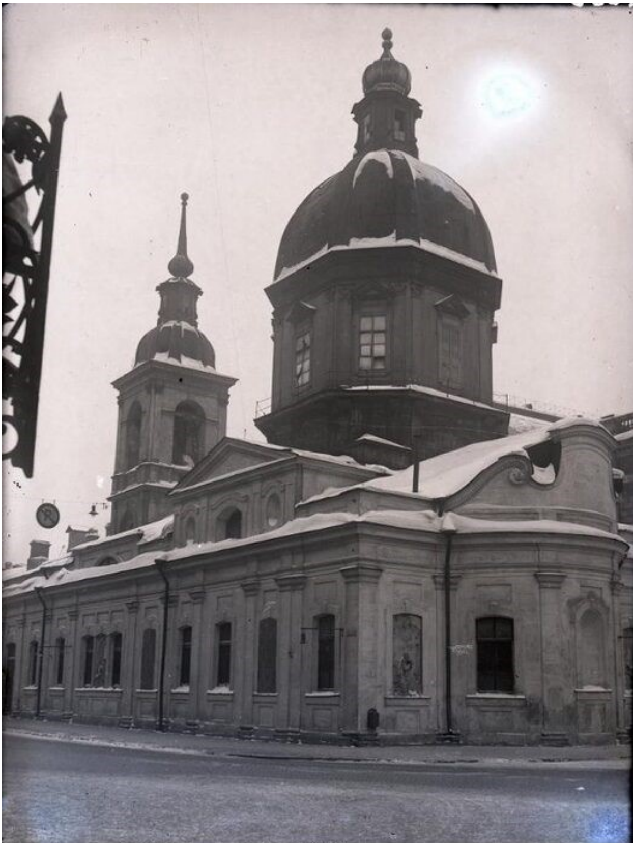
34. Вид на юго-восточный фасад, 1950-1965 (?) [Электронный ресурс] URL: https://www.citywalls.ru/ (дата обращения 08.09.2025)
