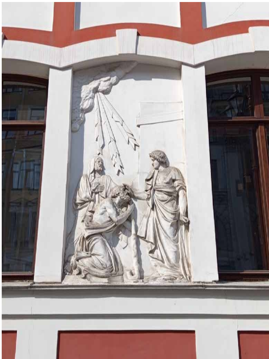
Фото 6. Общий вид части фасада.
