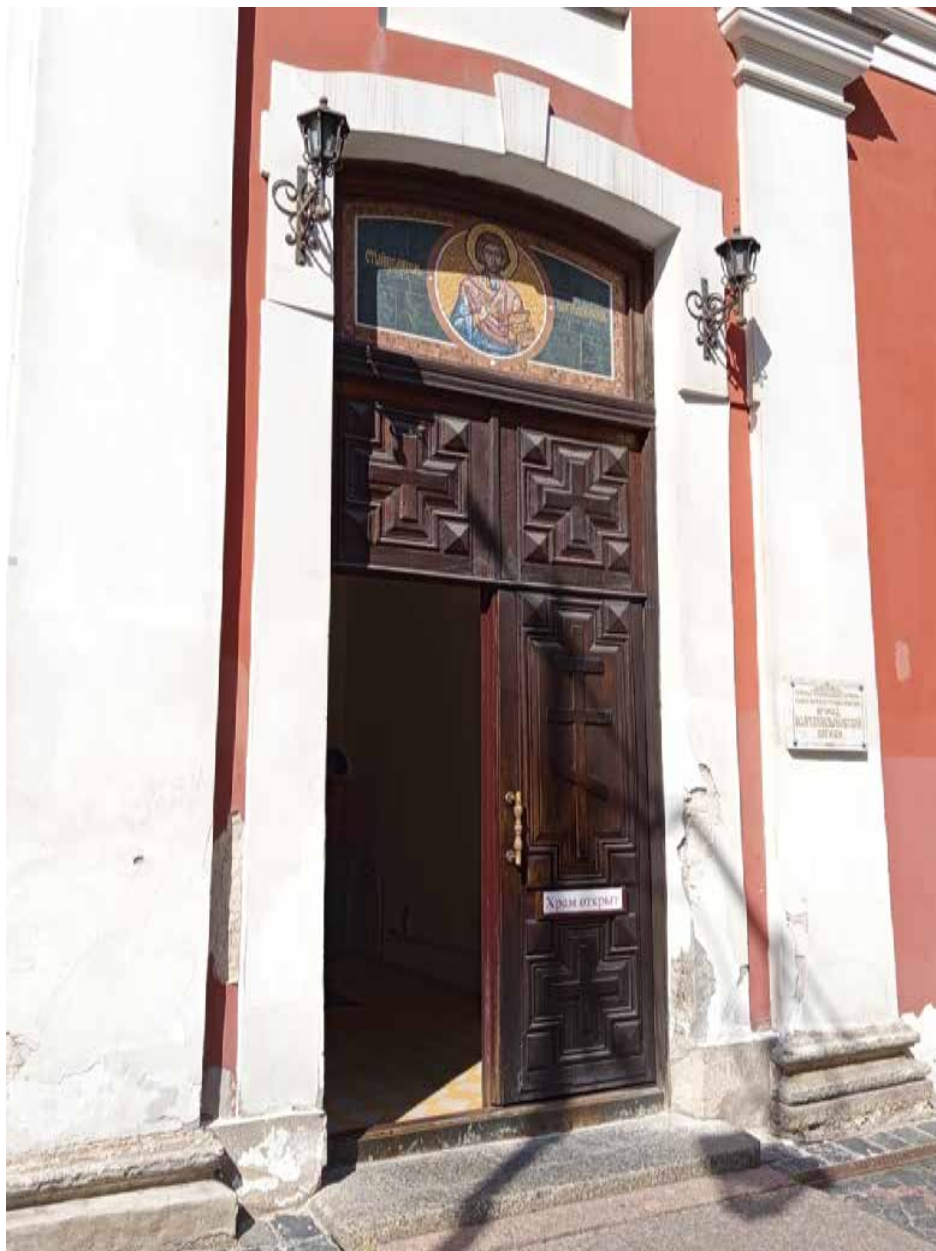
Фото 5. Общий вид части фасада.
