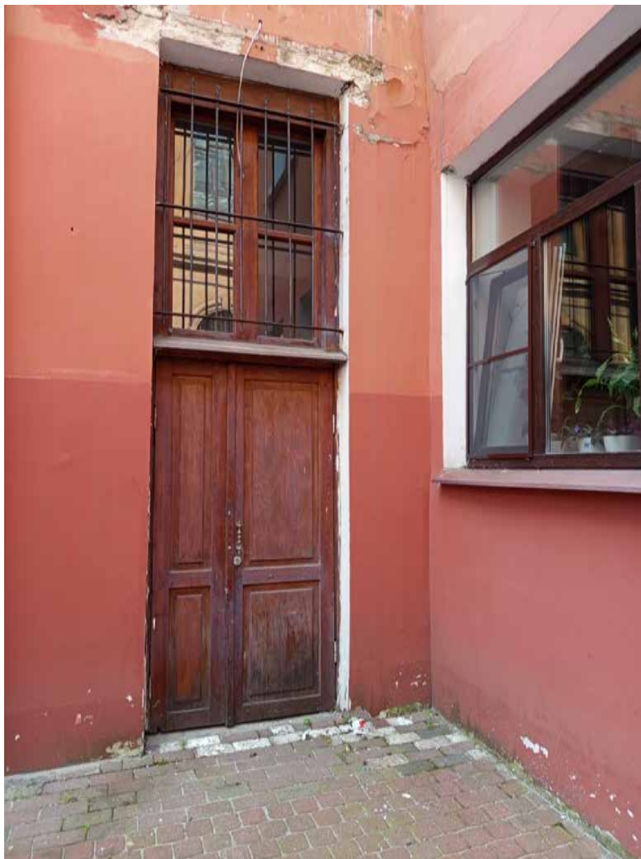
Фото 17. Общий вид части фасада.
