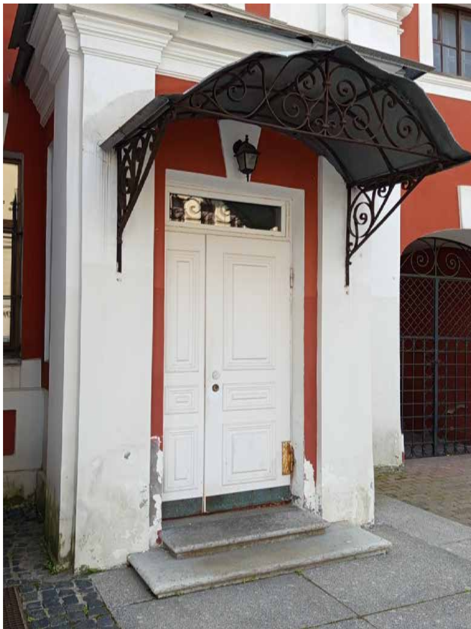
Фото 11. Общий вид части фасада.
