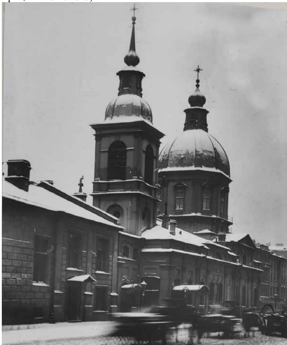
23. Вид на фасад с юго-запада, 1909 год. Архив КГИОП. П.192.Н-1189
