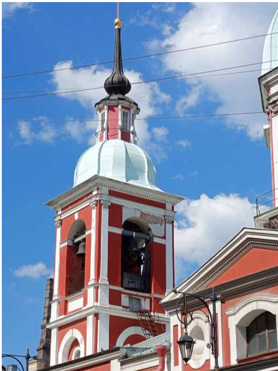
Фото 16. Общий вид части фасада.
