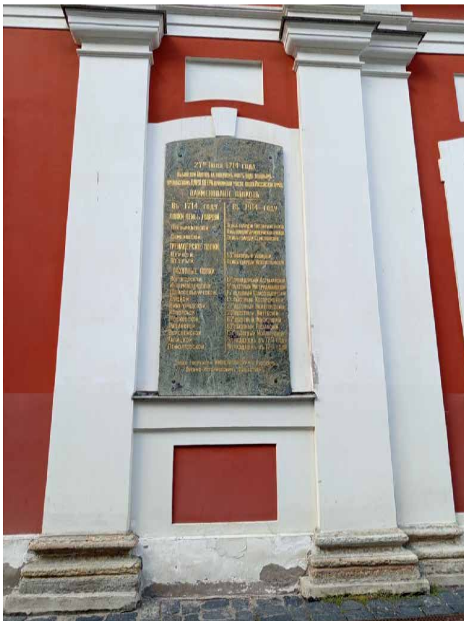
Фото 9. Общий вид части фасада.
