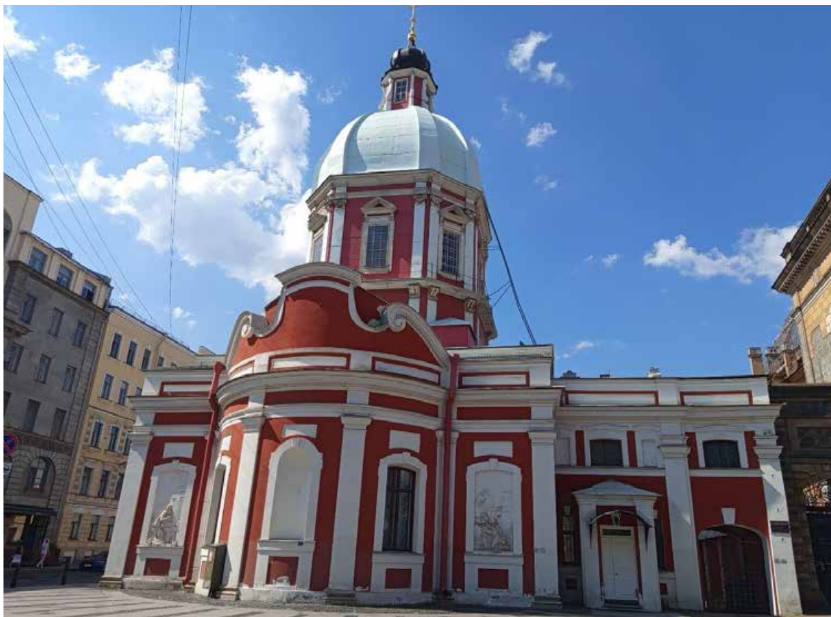
Фото 1. Общий вид объекта.
