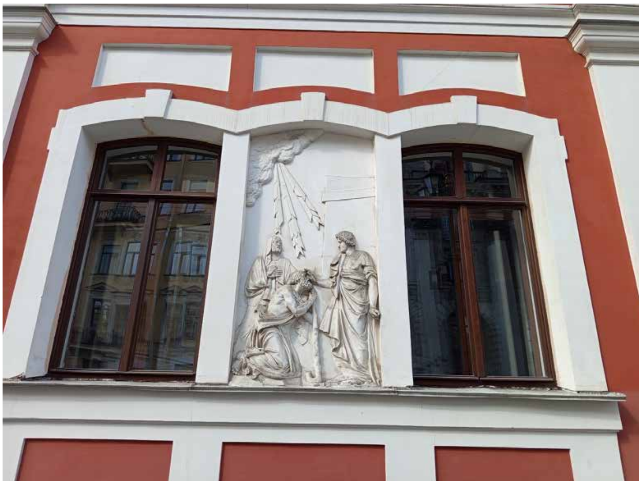
Фото 7. Общий вид части фасада.
