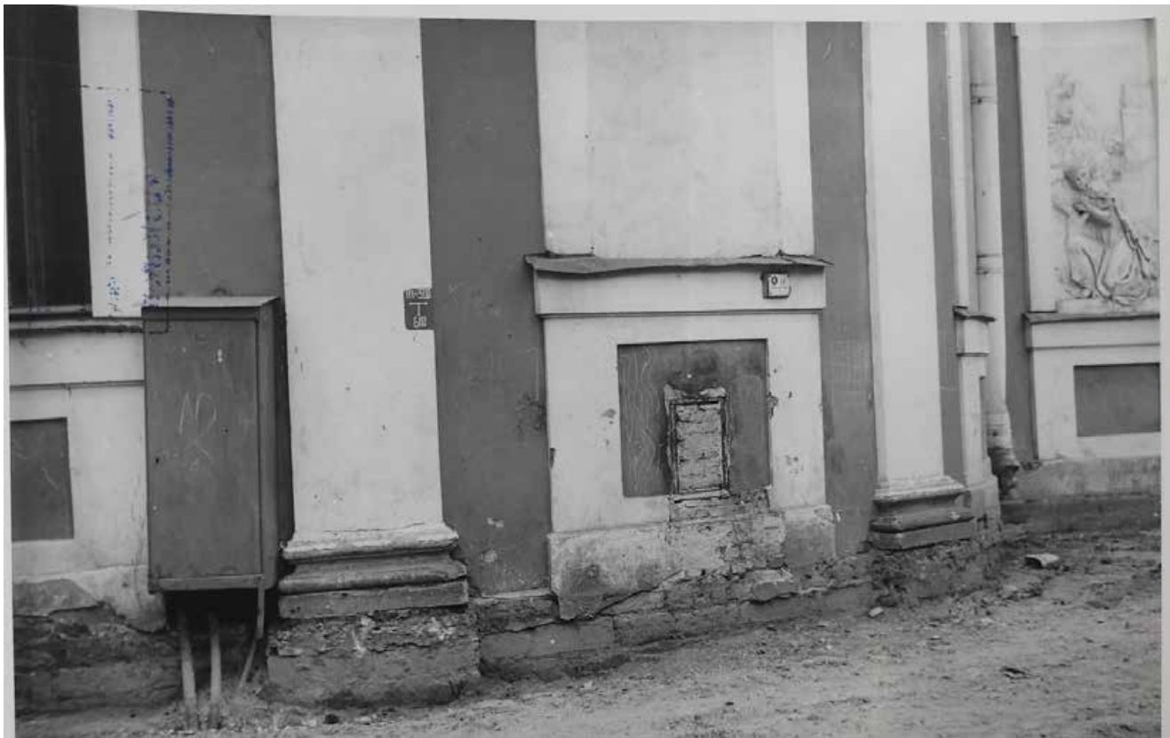
55. Обнажение нижних частей пилястр и частично цоколя при производстве дорожных работ, август, 1984 год ЦГАНТД СПб, Ф.488 Оп.3-24. Д.714
