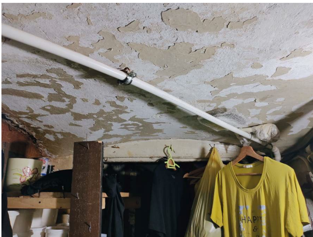
46. Выявленный объект культурного наследия «Дом Альбрехта» (г. Санкт-Петербург, Центральный район, Правды ул., 1; Разъезжая ул., 11) Помещение 7-Н
