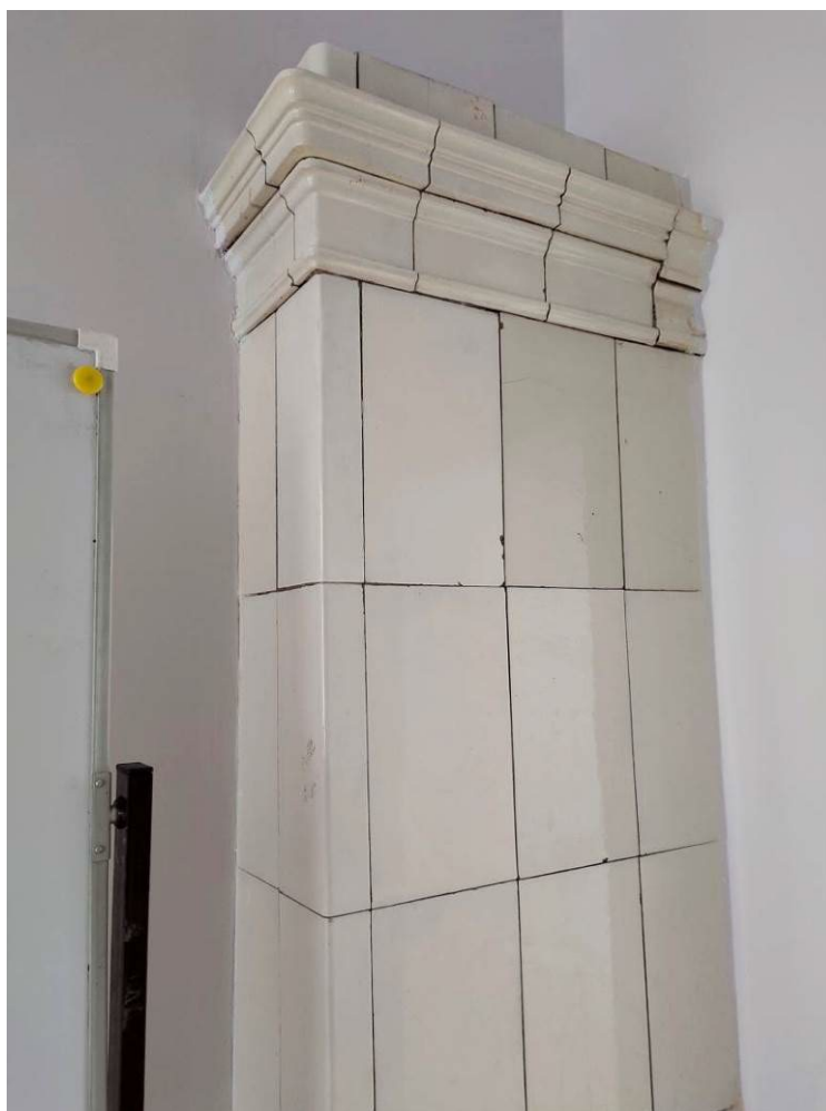
30. Выявленный объект культурного наследия «Дом Альбрехта» ( г. Санкт-Петербург, Центральный район, Правды ул., 1; Разъезжая ул., 11). Кв.№25
