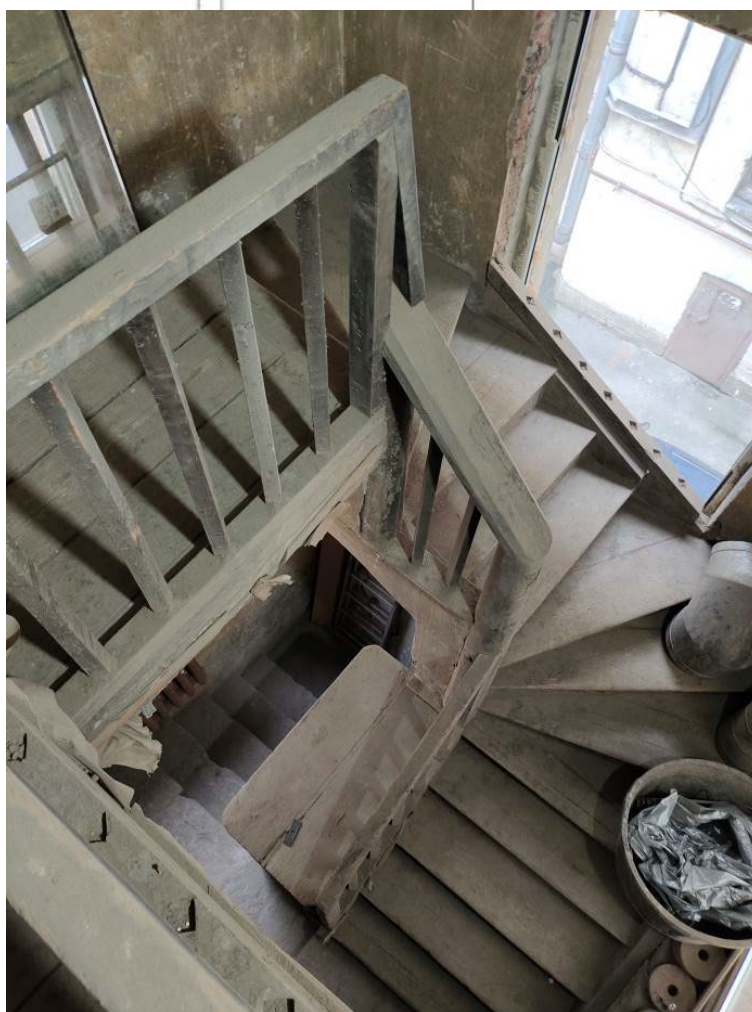
38. Выявленный объект культурного наследия «Дом Альбрехта» (г. Санкт-Петербург, Центральный район, Правды ул., 1; Разъезжая ул., 11). Черная лестница.Л-5
