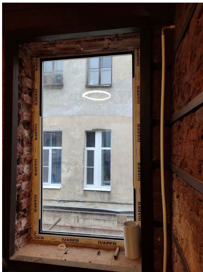
33. Выявленный объект культурного наследия «Дом Альбрехта» ( г. Санкт-Петербург, Центральный район, Правды ул., 1; Разъезжая ул., 11). Черная лестница. Л-5
