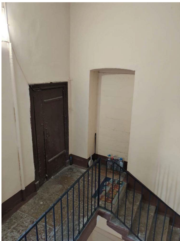
58. Выявленный объект культурного наследия «Дом Альбрехта» (г. Санкт-Петербург, Центральный район, Правды ул., 1; Разъезжая ул., 11). Черная лестница Л-1
