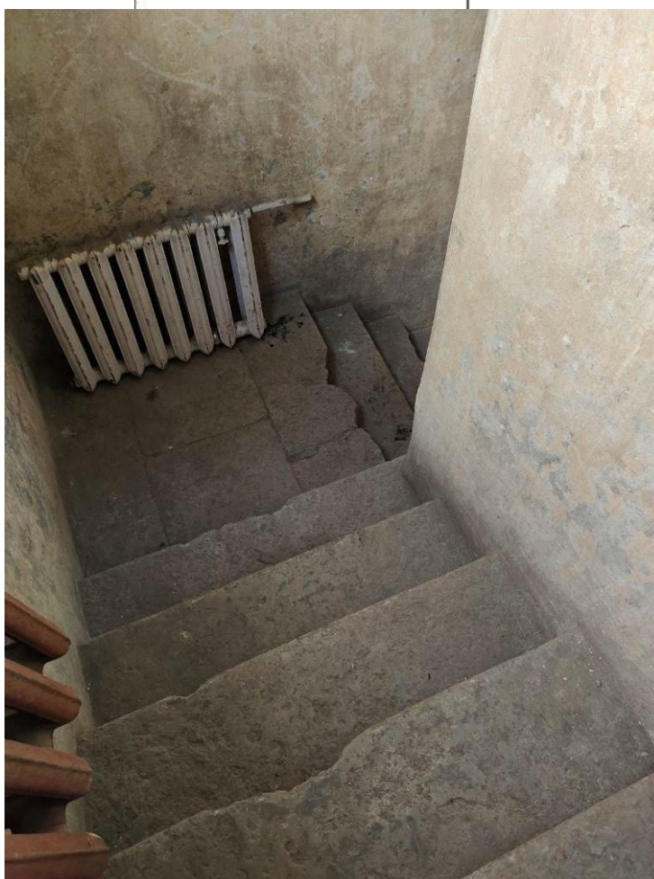
36. Выявленный объект культурного наследия «Дом Альбрехта» ( г. Санкт-Петербург, Центральный район, Правды ул., 1; Разъезжая ул., 11). Черная лестница.Л-5
