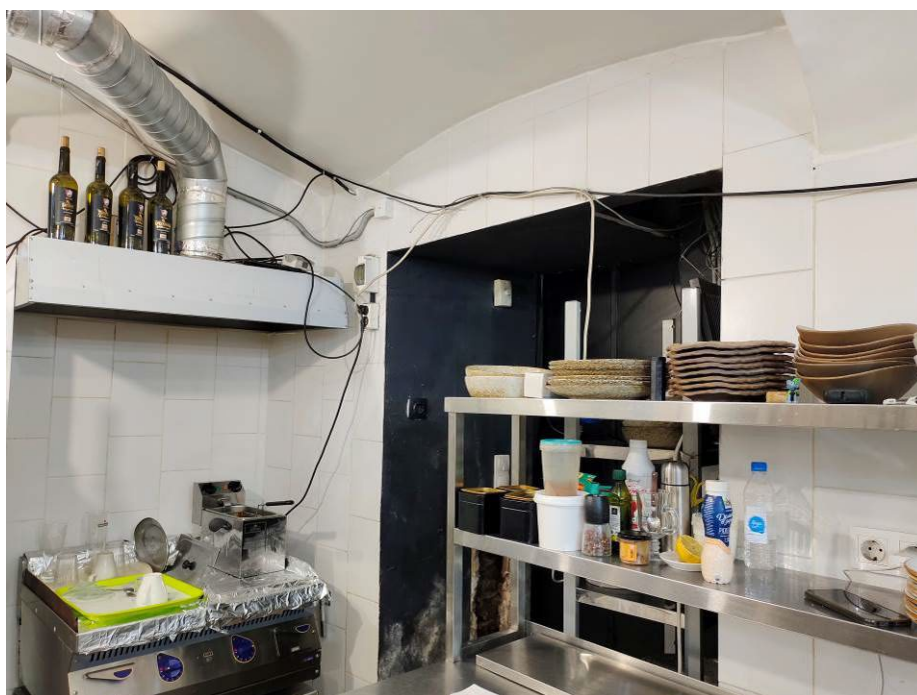
44. Выявленный объект культурного наследия «Дом Альбрехта» (г. Санкт-Петербург, Центральный район, Правды ул., 1; Разъезжая ул., 11) Кв. 11
