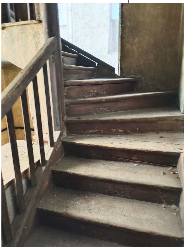
37. Выявленный объект культурного наследия «Дом Альбрехта» ( г. Санкт-Петербург, Центральный район, Правды ул., 1; Разъезжая ул., 11). Черная лестница.Л-5
