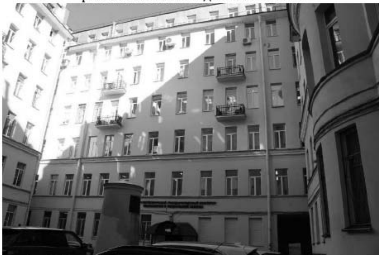
Фото 8. Вид на фасад дворового корпуса объекта культурного наследия регионального значения «Дом В.И. Упатчева».
