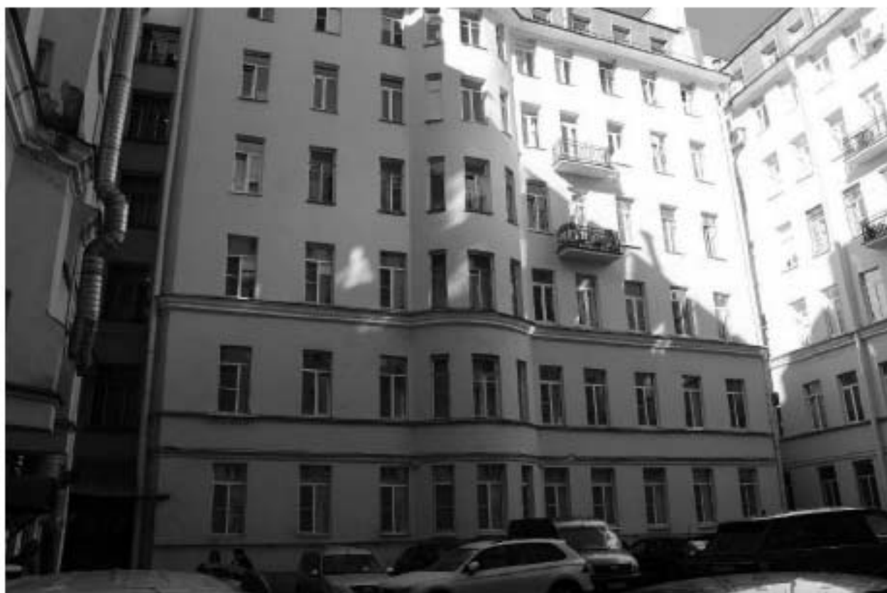
Фото 7. Вид на фасад дворового корпуса объекта культурного наследия регионального значения «Дом В.И. Упатчева».
