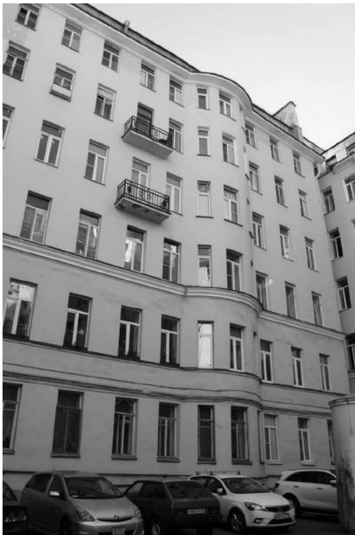
Фото 9. Вид на фасад дворового корпуса объекта культурного наследия регионального значения «Дом В.И. Упатчева».
