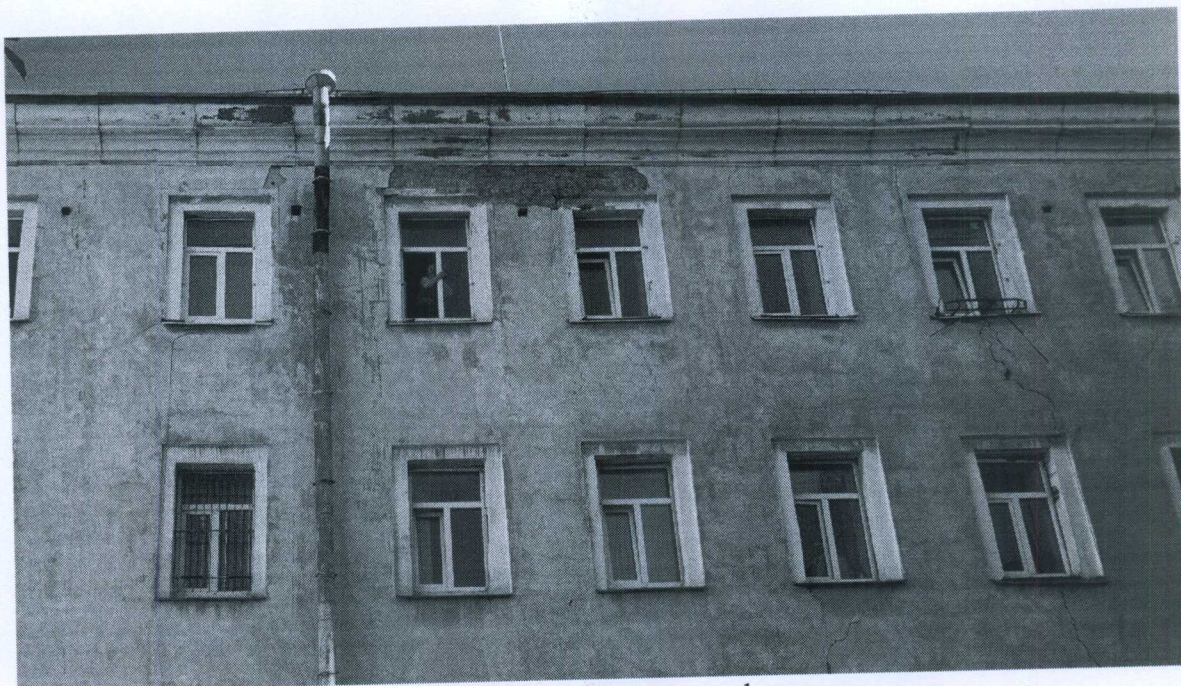
Фрагмент главного фасада
