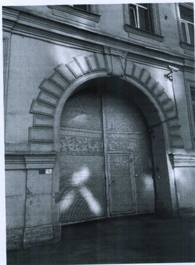
Фрагмент лицевого фасада по Мытнинской ул.
