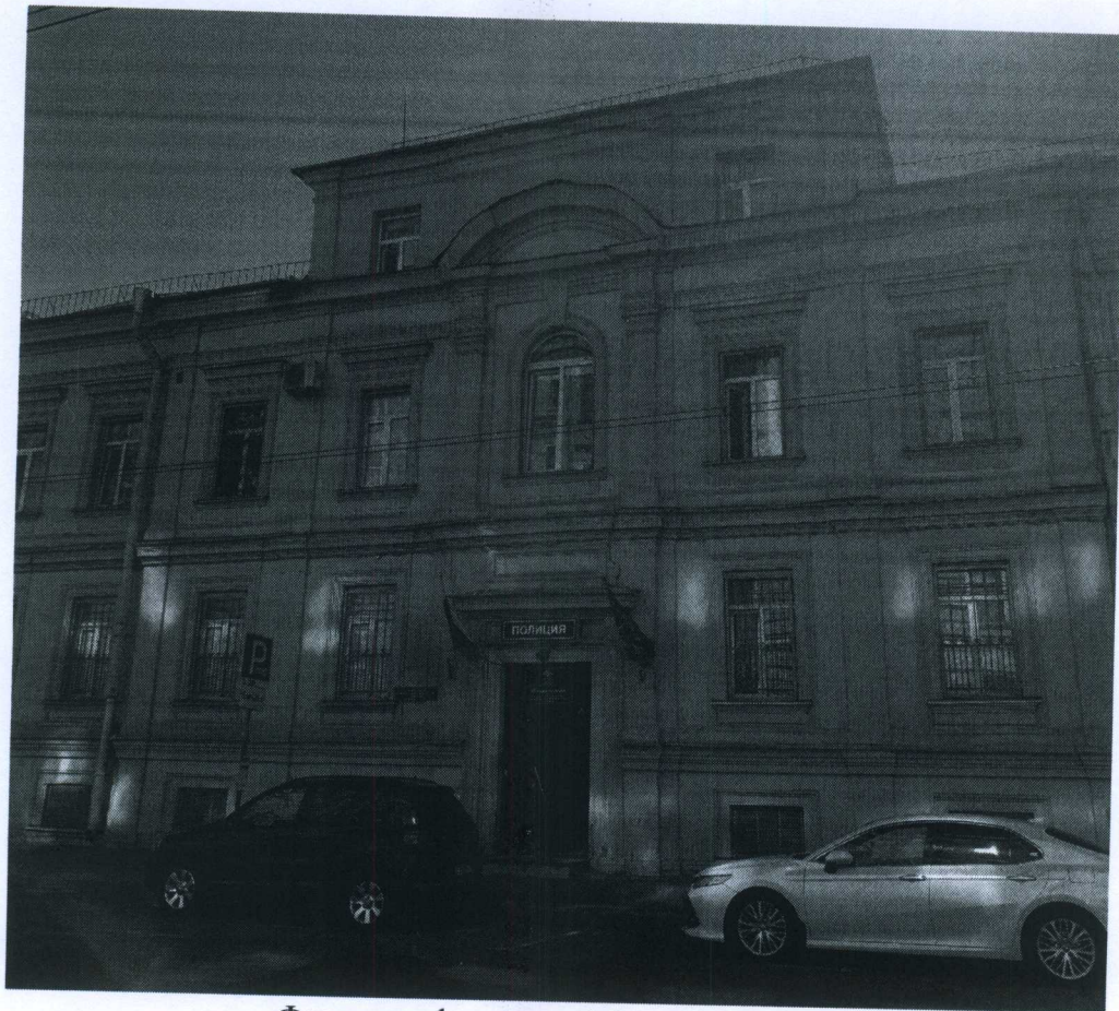
Фрагмент фасада по Мытнинской ул.
