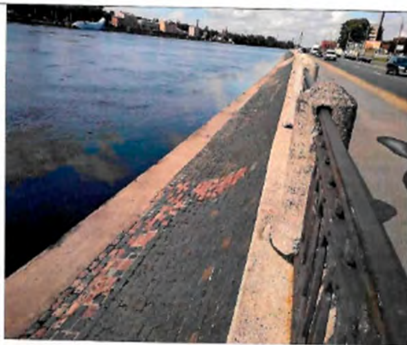
3. Высокая железобетонная стенка на свайном основании, облицована гранитом.
