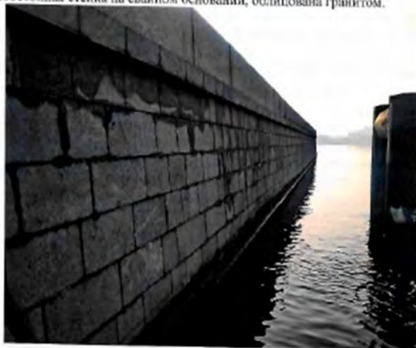
3. Высокая железобетонная стенка на свайном основании, облицована гранитом.
