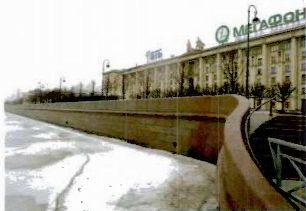
5. Вид стенки набережной
