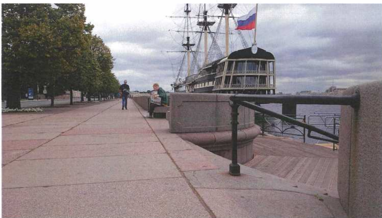
2. Вид на спуск набережной
