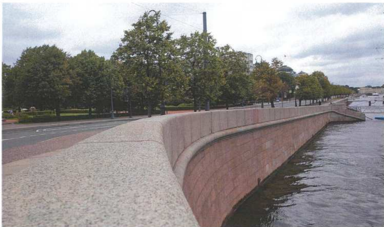
1. Вид на стенку набережной около Троицкого моста
