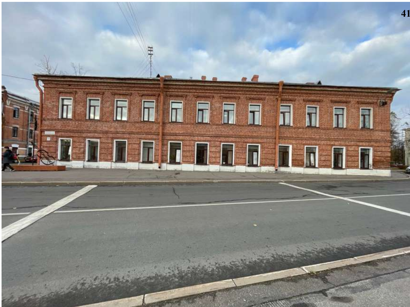
Фото 1. Общий вид объекта.
