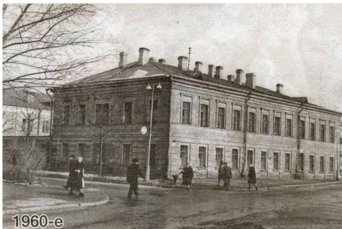
Илл. 9. Здание по ул. Культуры, д.1 в 1960-е гг.
