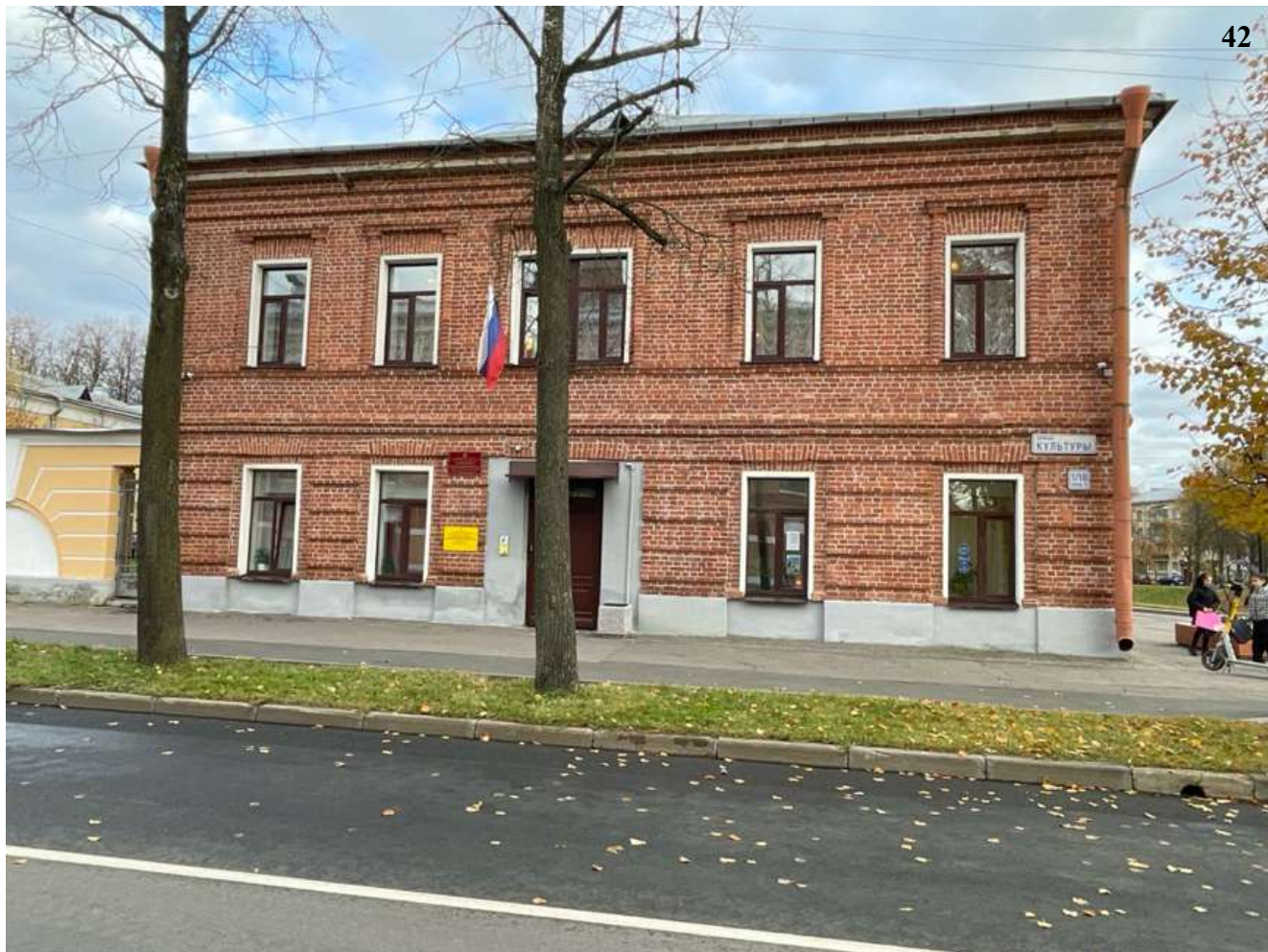
Фото 3. Общий вид объекта.
