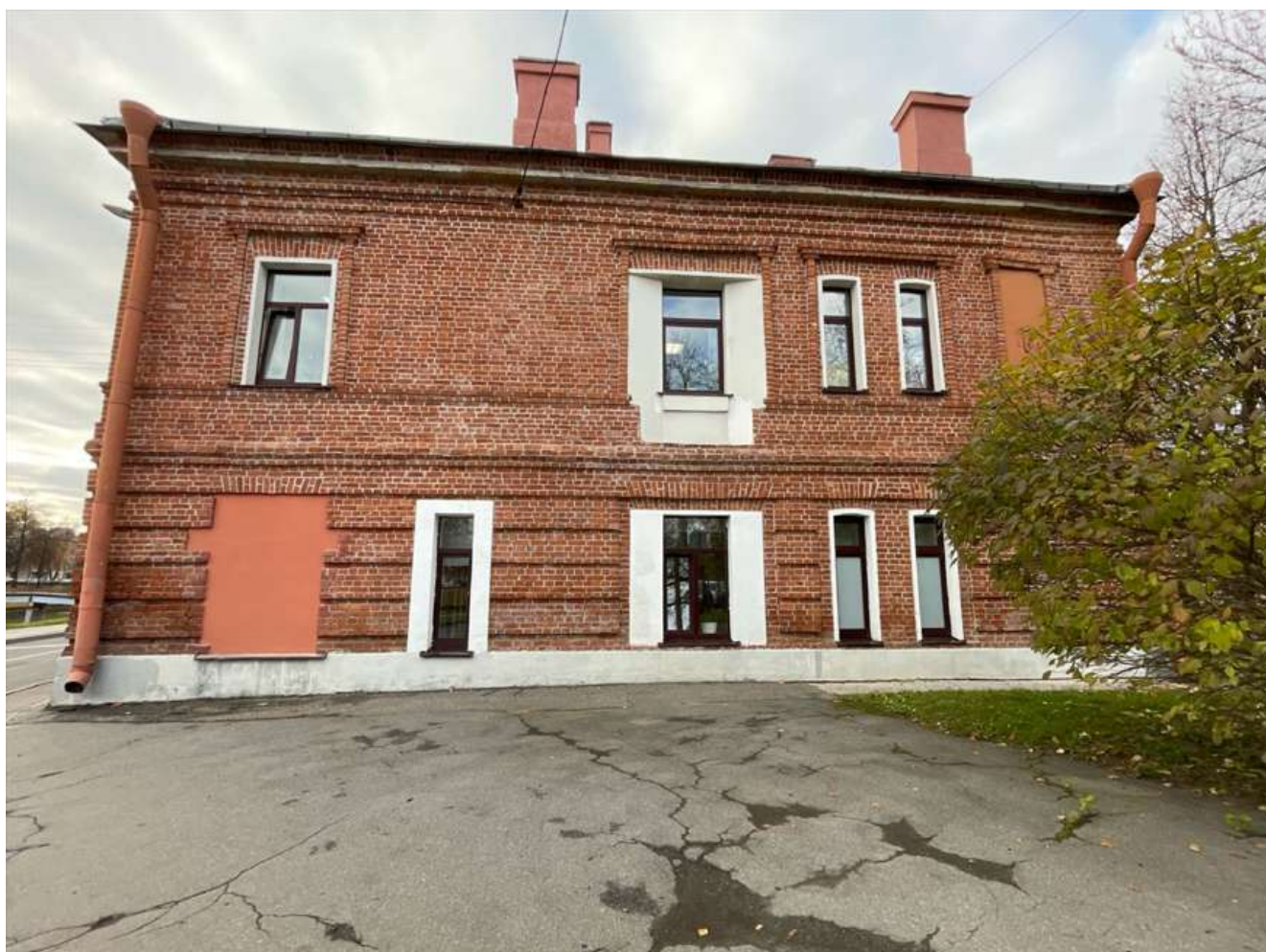
Фото 2. Общий вид объекта.
