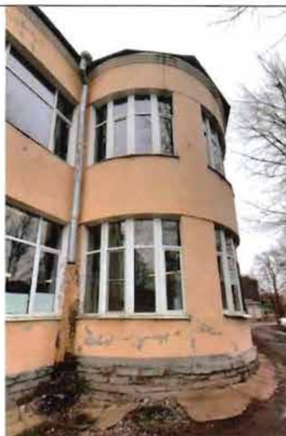
5. Фрагмент юго-западного фасада
