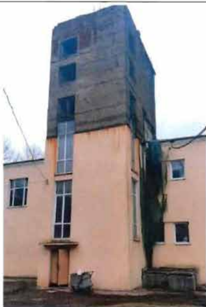
4. Фрагмент северо-западного фасада
