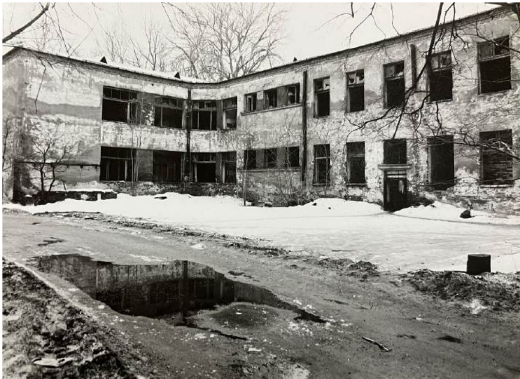
24. Ул. Миргородская, д. 3, Лит. 3. Дворовой фасад. 1990-е гг.
