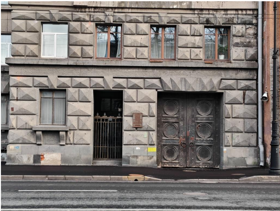
25. «Дом жилой работников Всесоюзного института экспериментальной медицины», Каменноостровский пр., д. 69, литера А. Юго-западный фасад. Фрагмент. Фото 14.11.2025г.
