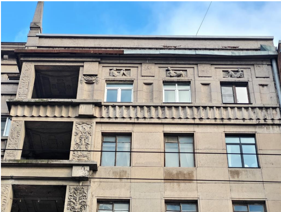
23. «Дом жилой работников Всесоюзного института экспериментальной медицины», Каменноостровский пр., д. 69, литера А. Юго-западный фасад. Фрагмент. Фото 14.11.2025г.
