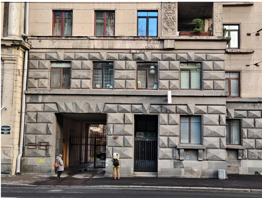
6. «Дом жилой работников Всесоюзного института экспериментальной медицины», Каменноостровский пр., д. 69, литера А. Юго-западный фасад. Фрагмент. Фото 14.11.2025г.
