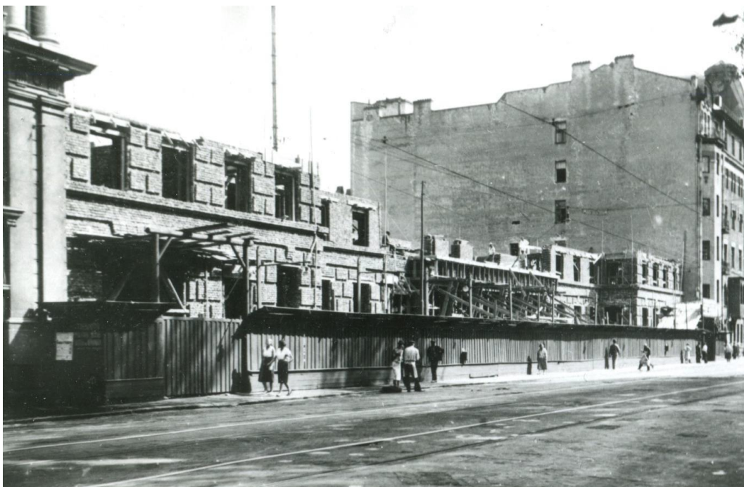
19. Начальный этап строительства жилого дома ВИЭМ по ул. Красных Зорь. Фотография. 1934 г. ЦГАКФФД СПб (Опись 1БР-31. Ед.хр. 41585).
