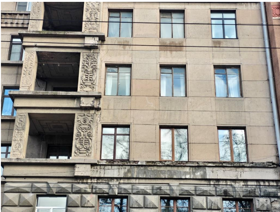
24. «Дом жилой работников Всесоюзного института экспериментальной медицины», Каменноостровский пр., д. 69, литера А. Юго-западный фасад. Фрагмент. Фото 14.11.2025г.
