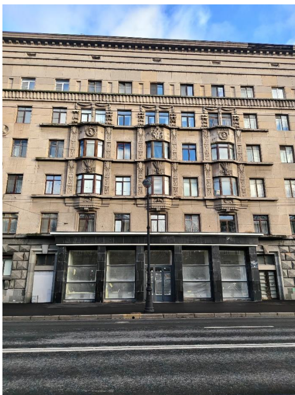
12. «Дом жилой работников Всесоюзного института экспериментальной медицины», Каменноостровский пр., д. 69, литера А. Юго-западный фасад. Фрагмент. Фото 14.11.2025г.
