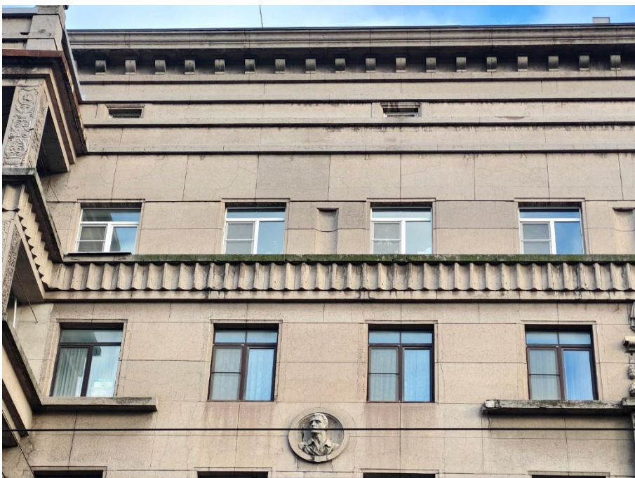
8. «Дом жилой работников Всесоюзного института экспериментальной медицины», Каменноостровский пр., д. 69, литера А. Юго-западный фасад. Фрагмент. Фото 14.11.2025г.
