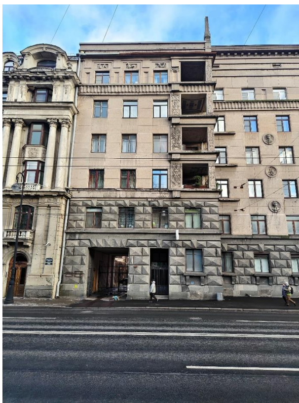
4. «Дом жилой работников Всесоюзного института экспериментальной медицины», Каменноостровский пр., д. 69, литера А. Юго-западный фасад. Фрагмент. Фото 14.11.2025г.
