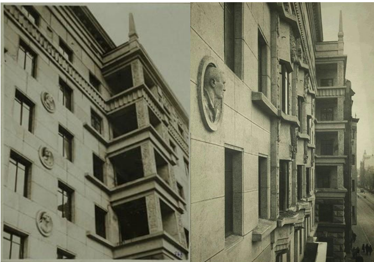
22. Завершающий этап строительства жилого дома ВИЭМ. Детали фасадов. Фотографии. 1936 г. (?) ГМИ СПб (Инв.№-II-Б-3325 ф; Инв.№-II-Б-3328 ф).
