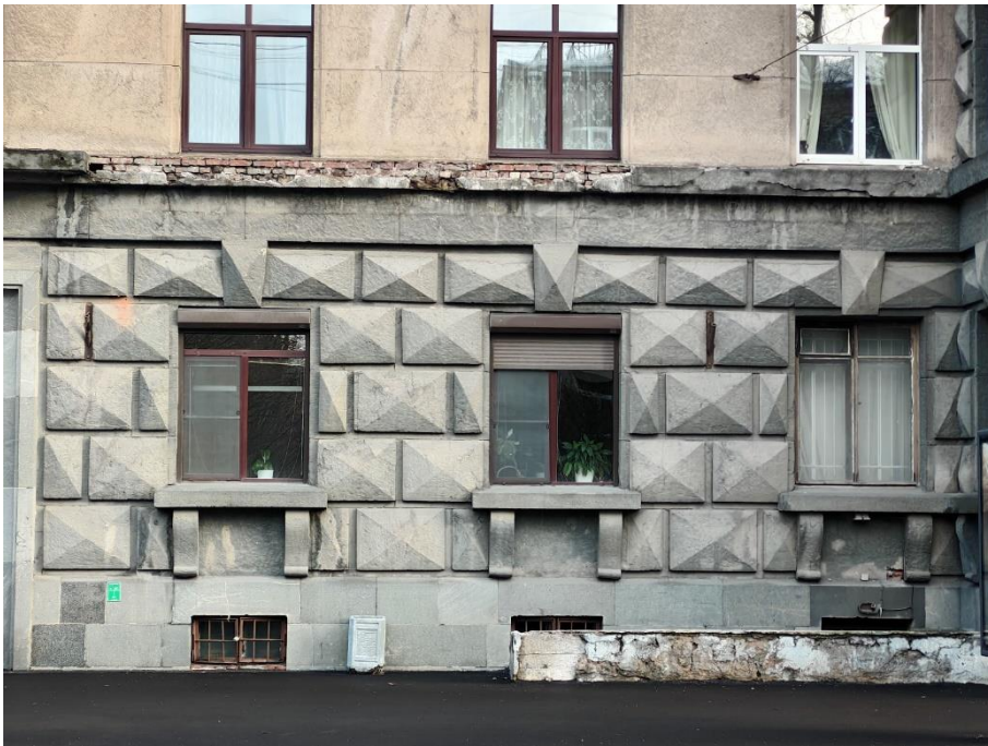
21. «Дом жилой работников Всесоюзного института экспериментальной медицины», Каменноостровский пр., д. 69, литера А. Юго-западный фасад. Фрагмент. Фото 14.11.2025г.
