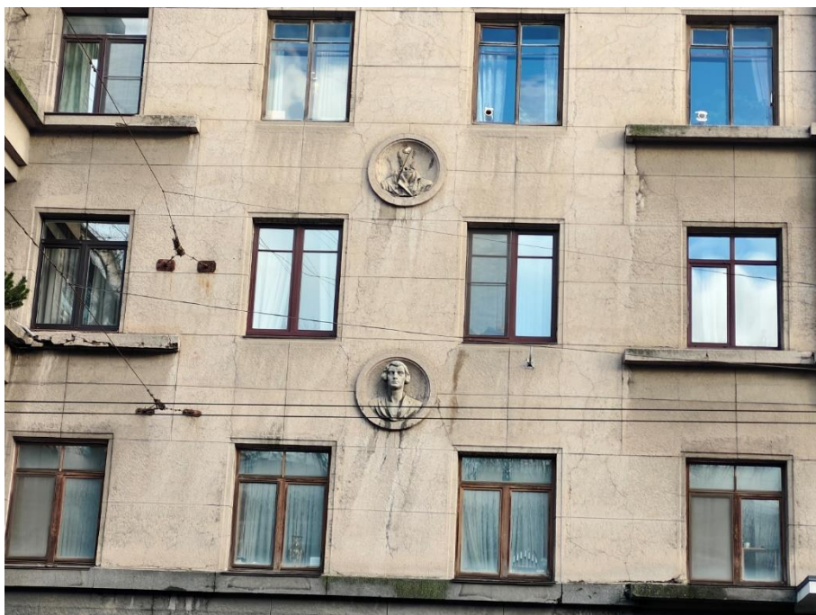
9. «Дом жилой работников Всесоюзного института экспериментальной медицины», Каменноостровский пр., д. 69, литера А. Юго-западный фасад. Фрагмент. Фото 14.11.2025г.
