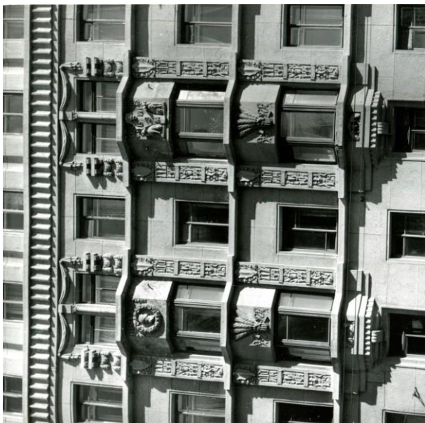
47. Жилой дом ВИЭМ. Декоративное оформление фасада. Фотография Трубского О.В. 1985 г. Сектор хранения документированной информации (архив) КГИОП.
