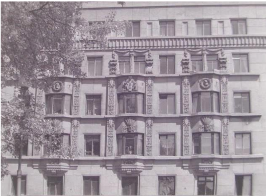
38. Общий вид и детали фасада жилого дома работников ВИЭМ на Кировском проспекте. Фотография С.Г. Шиманского. 1950-е гг. ГНИМА им. А.В. Щусева (инв. №№ ОФ-4834/167-170).
