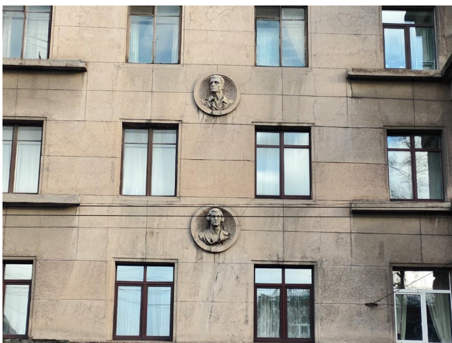
20. «Дом жилой работников Всесоюзного института экспериментальной медицины», Каменноостровский пр., д. 69, литера А. Юго-западный фасад. Фрагмент. Фото 14.11.2025г.
