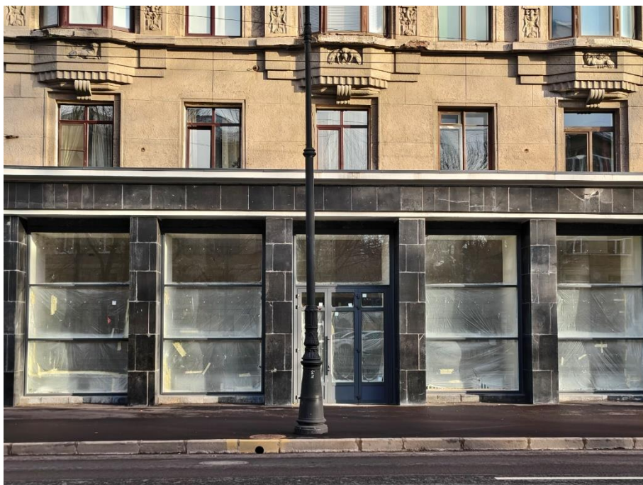
15. «Дом жилой работников Всесоюзного института экспериментальной медицины», Каменноостровский пр., д. 69, литера А. Юго-западный фасад. Фрагмент. Фото 14.11.2025г.
