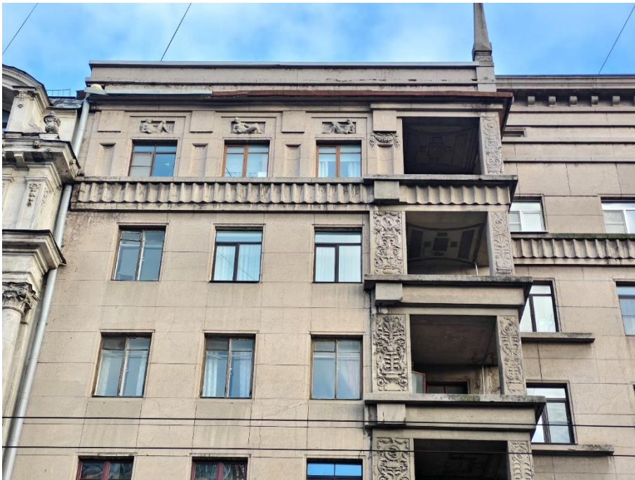
5. «Дом жилой работников Всесоюзного института экспериментальной медицины», Каменноостровский пр., д. 69, литера А. Юго-западный фасад. Фрагмент. Фото 14.11.2025г.
