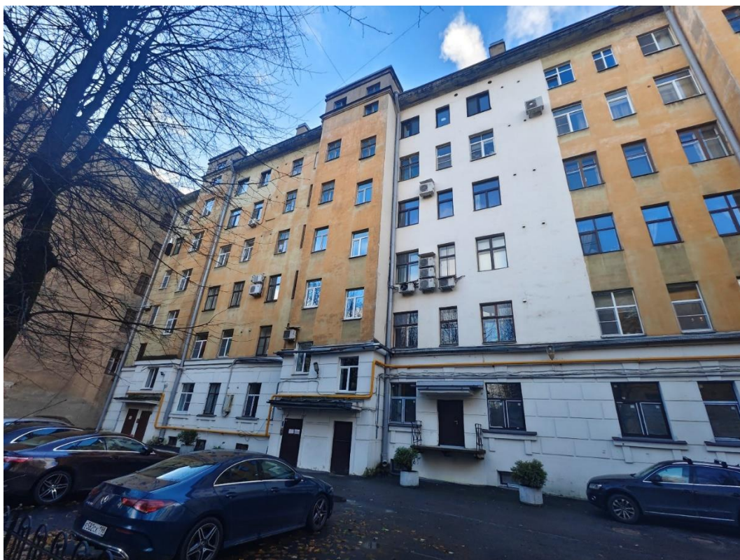
2. «Дом жилой работников Всесоюзного института экспериментальной медицины», Каменноостровский пр., д. 69, литера А. Северо-восточный фасад. Общий вид. Фото 14.11.2025г.
