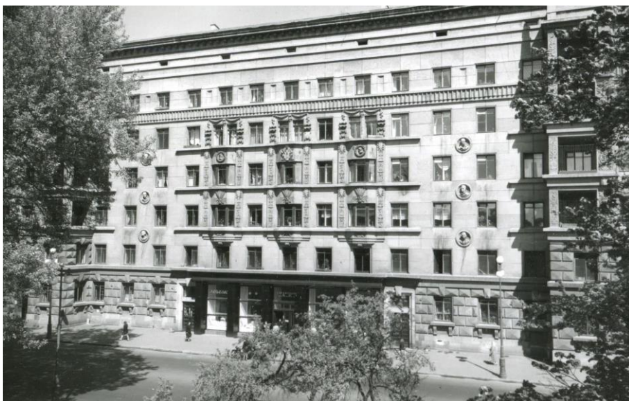
39. Жилой дом ВИЭМ на Кировском пр., 69. Фотография С.Г. Шиманского. 1952 г. ЦГАКФФД СПб. Опись 1ВР-48. Ед.хр.70999.
