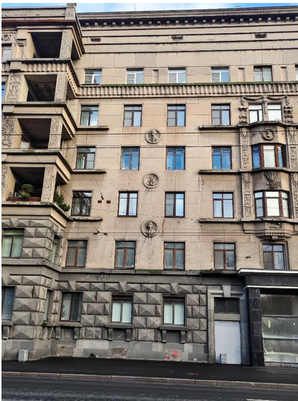
7. «Дом жилой работников Всесоюзного института экспериментальной медицины», Каменноостровский пр., д. 69, литера А. Юго-западный фасад. Фрагмент. Фото 14.11.2025г.
