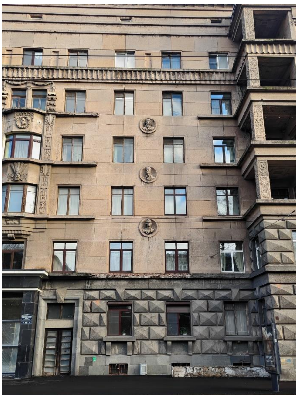
16. «Дом жилой работников Всесоюзного института экспериментальной медицины», Каменноостровский пр., д. 69, литера А. Юго-западный фасад. Фрагмент. Фото 14.11.2025г.
