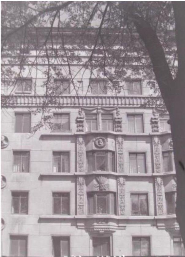
37. Общий вид и детали фасада жилого дома работников ВИЭМ на Кировском проспекте. Фотография С.Г. Шиманского. 1950-е гг. ГНИМА им. А.В. Щусева (инв. №№ ОФ-4834/167-170).
