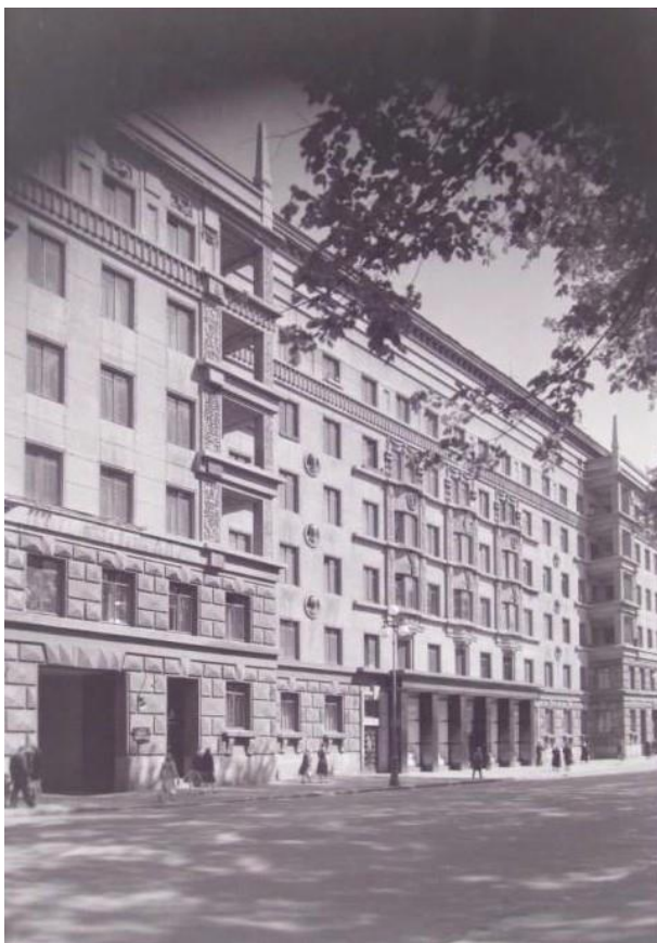
36. Общий вид и детали фасада жилого дома работников ВИЭМ на Кировском проспекте. Фотография С.Г. Шиманского. 1950-е гг. ГНИМА им. А.В. Щусева (инв. №№ ОФ-4834/167-170).
