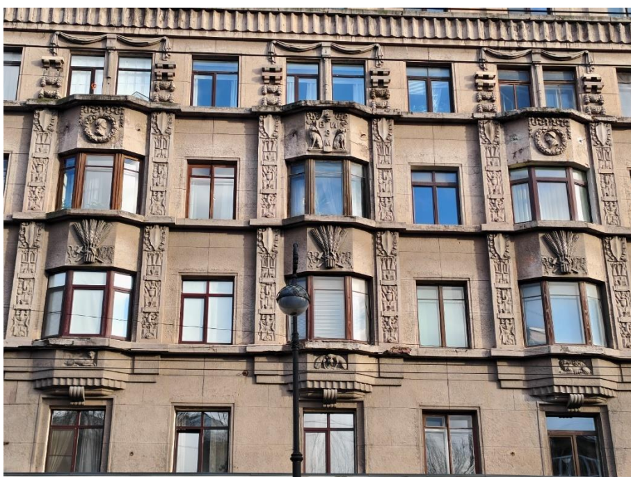
14. «Дом жилой работников Всесоюзного института экспериментальной медицины», Каменноостровский пр., д. 69, литера А. Юго-западный фасад. Фрагмент. Фото 14.11.2025г.
