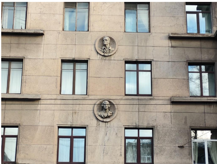
19. «Дом жилой работников Всесоюзного института экспериментальной медицины», Каменноостровский пр., д. 69, литера А. Юго-западный фасад. Фрагмент. Фото 14.11.2025г.
