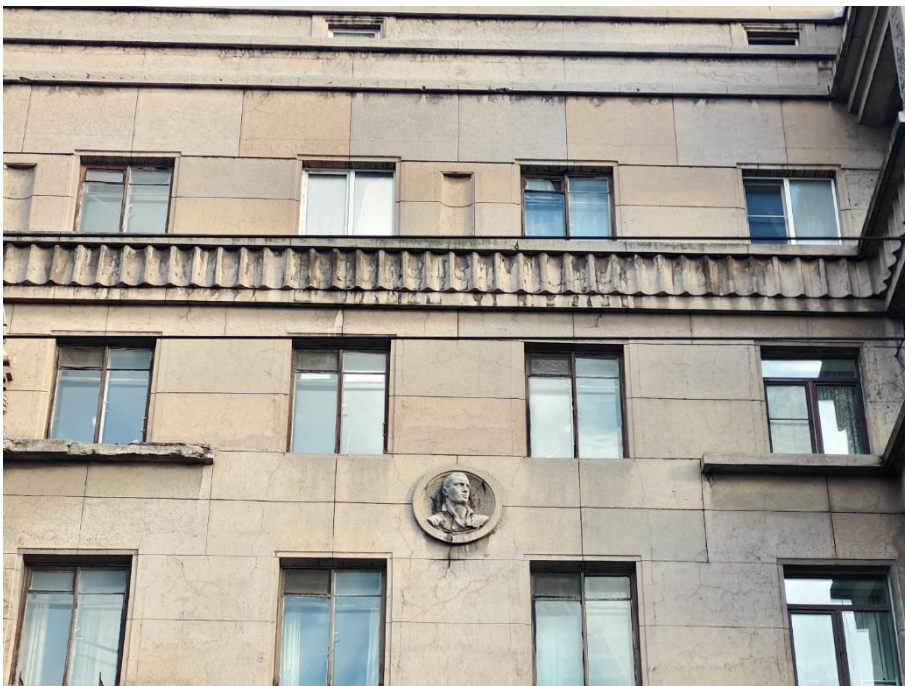
17. «Дом жилой работников Всесоюзного института экспериментальной медицины», Каменноостровский пр., д. 69, литера А. Юго-западный фасад. Фрагмент. Фото 14.11.2025г.
