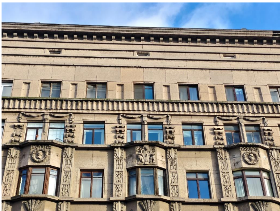
13. «Дом жилой работников Всесоюзного института экспериментальной медицины», Каменноостровский пр., д. 69, литера А. Юго-западный фасад. Фрагмент. Фото 14.11.2025г.
