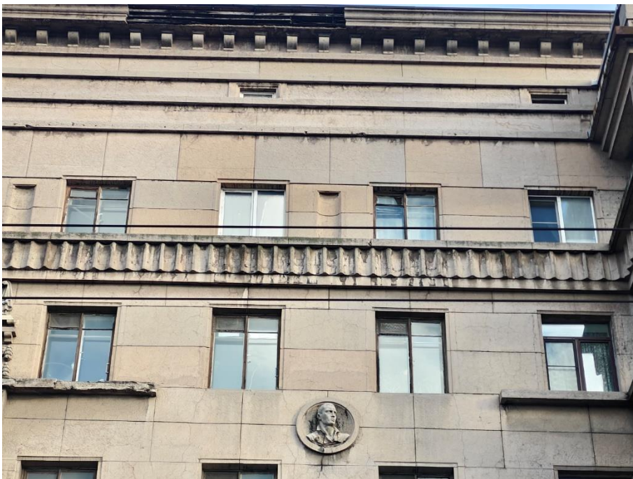
18. «Дом жилой работников Всесоюзного института экспериментальной медицины», Каменноостровский пр., д. 69, литера А. Юго-западный фасад. Фрагмент. Фото 14.11.2025г.
