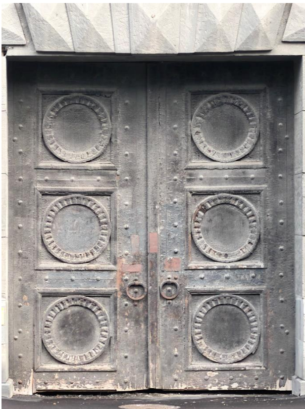
26. «Дом жилой работников Всесоюзного института экспериментальной медицины», Каменноостровский пр., д. 69, литера А. Юго-западный фасад. Фрагмент. Фото 14.11.2025г.
