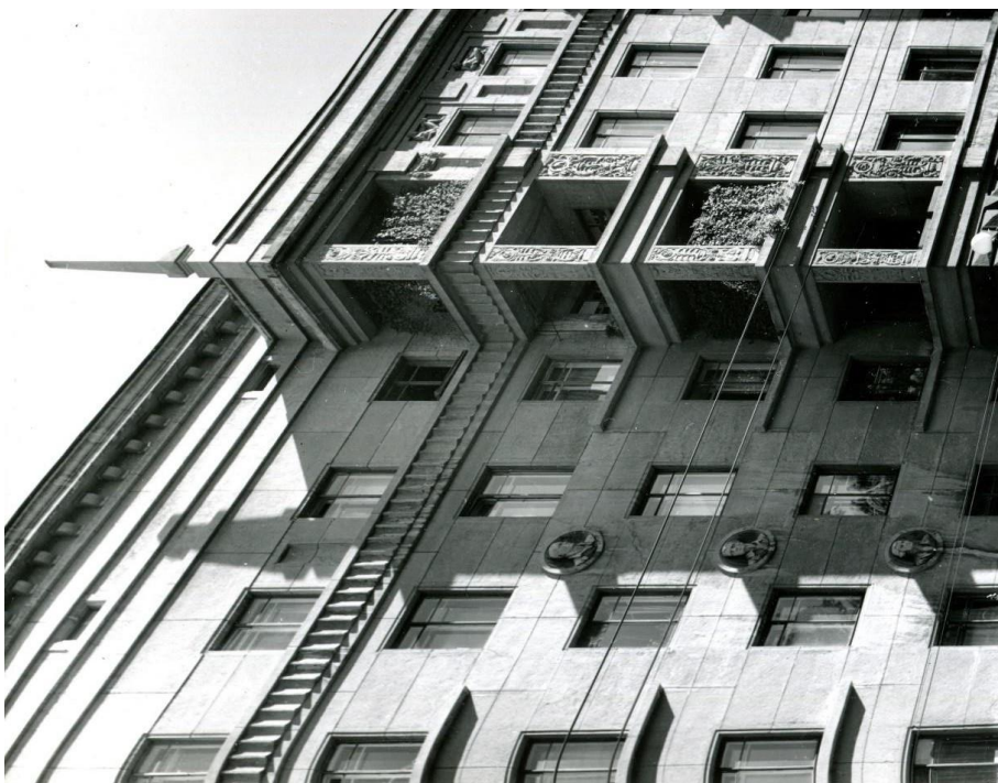
49. Жилой дом ВИЭМ. Декоративное оформление фасада. Фотография Трубского О.В. 1985 г. Сектор хранения документированной информации (архив) КГИОП.
