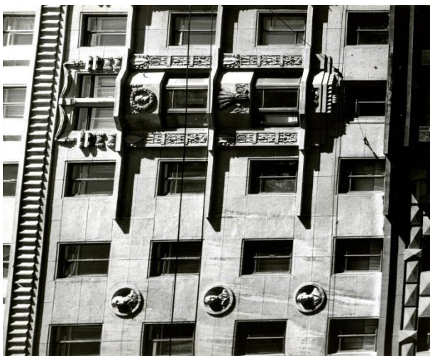
48. Жилой дом ВИЭМ. Декоративное оформление фасада. Фотография Трубского О.В. 1985 г. Сектор хранения документированной информации (архив) КГИОП.
