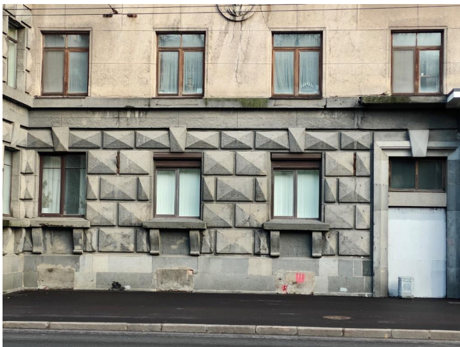
11. «Дом жилой работников Всесоюзного института экспериментальной медицины», Каменноостровский пр., д. 69, литера А. Юго-западный фасад. Фрагмент. Фото 14.11.2025г.
