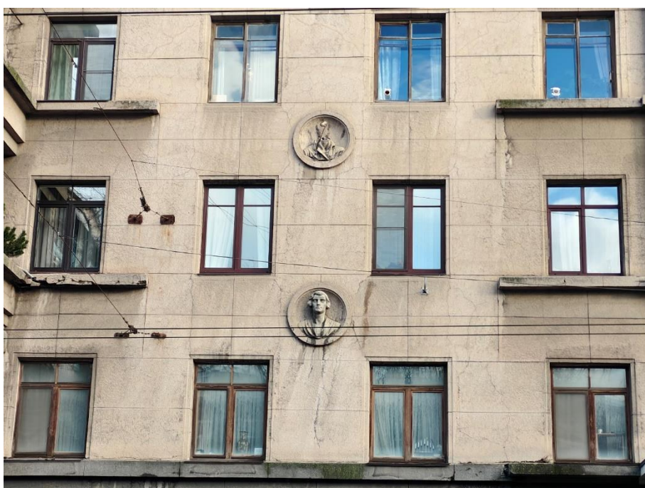
10. «Дом жилой работников Всесоюзного института экспериментальной медицины», Каменноостровский пр., д. 69, литера А. Юго-западный фасад. Фрагмент. Фото 14.11.2025г.
