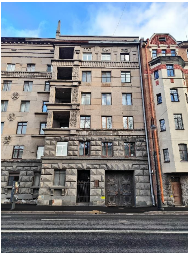
22. «Дом жилой работников Всесоюзного института экспериментальной медицины», Каменноостровский пр., д. 69, литера А. Юго-западный фасад. Фрагмент. Фото 14.11.2025г.
