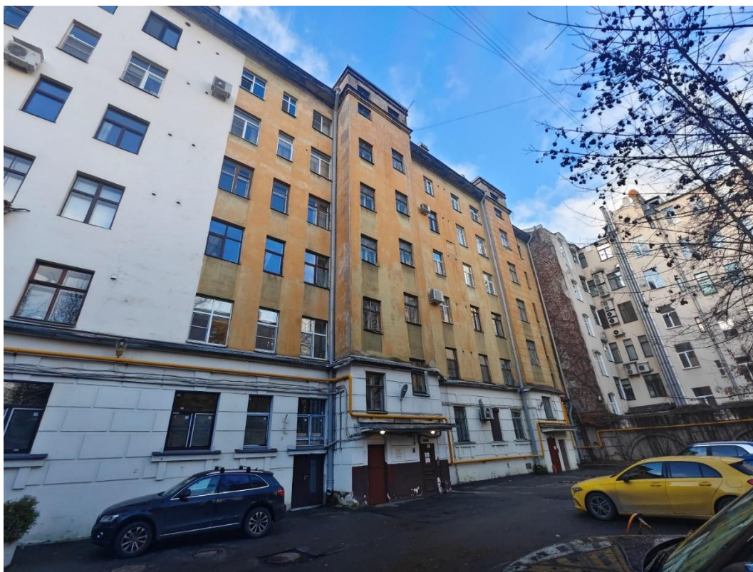
3. «Дом жилой работников Всесоюзного института экспериментальной медицины», Каменноостровский пр., д. 69, литера А. Северо-восточный фасад. Общий вид. Фото 14.11.2025г.
