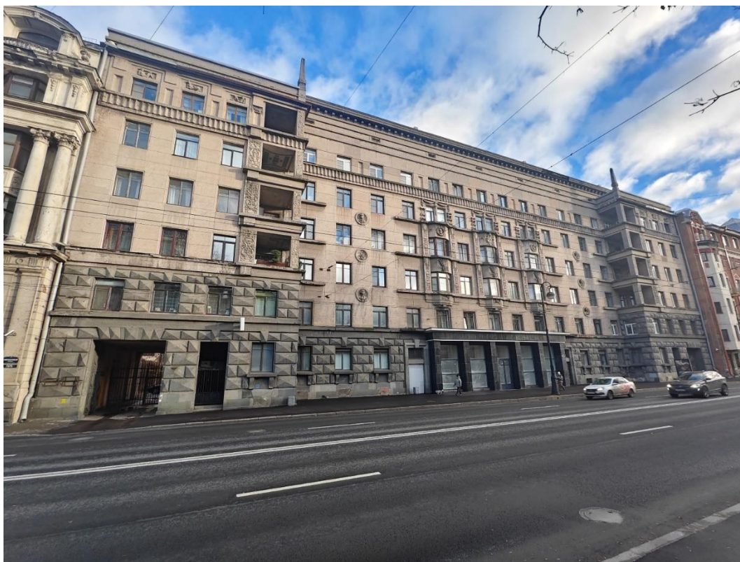
1. «Дом жилой работников Всесоюзного института экспериментальной медицины», Каменноостровский пр., д. 69, литера А. Юго-западный фасад. Общий вид. Фото 14.11.2025г.
