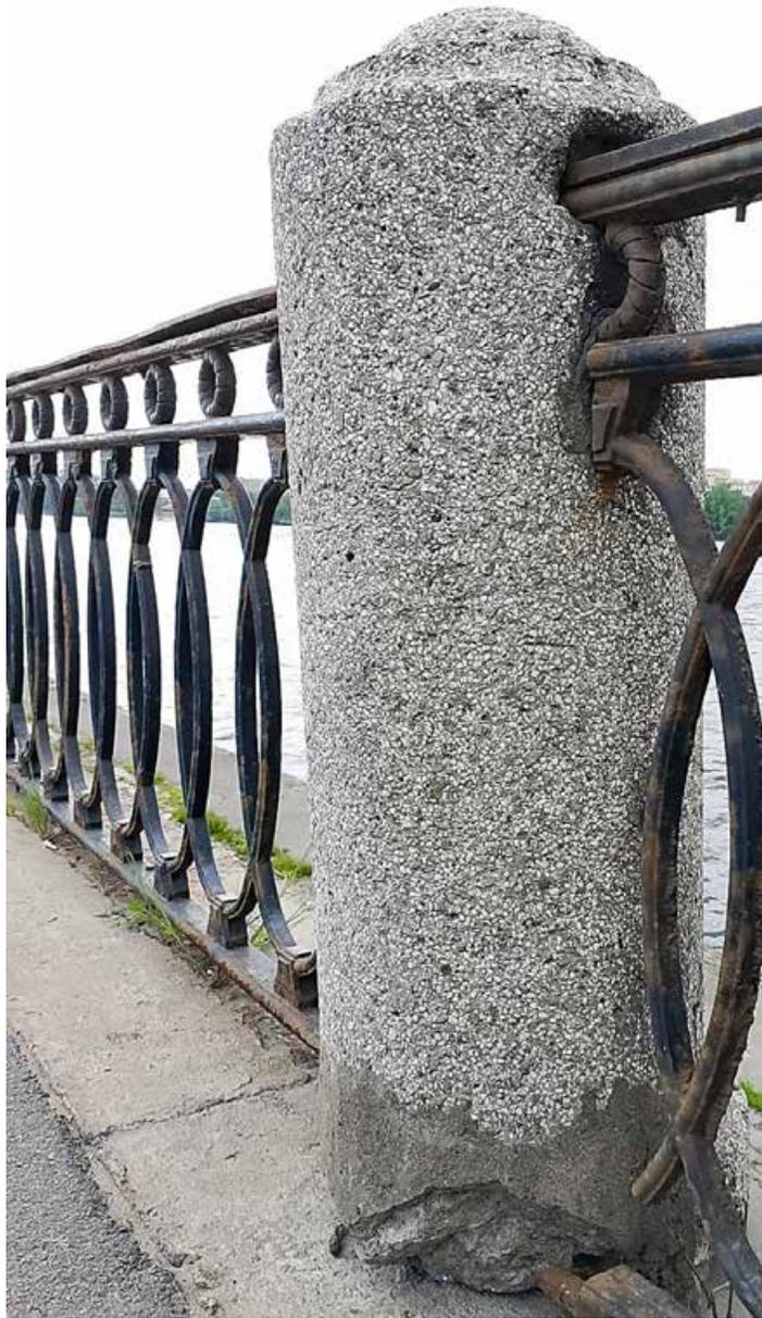
3. Бетонная тумба с крупным сколом в нижней части, потёками от корродирующего металла, утратой мастиковки в месте монтажа секции ограждения.
