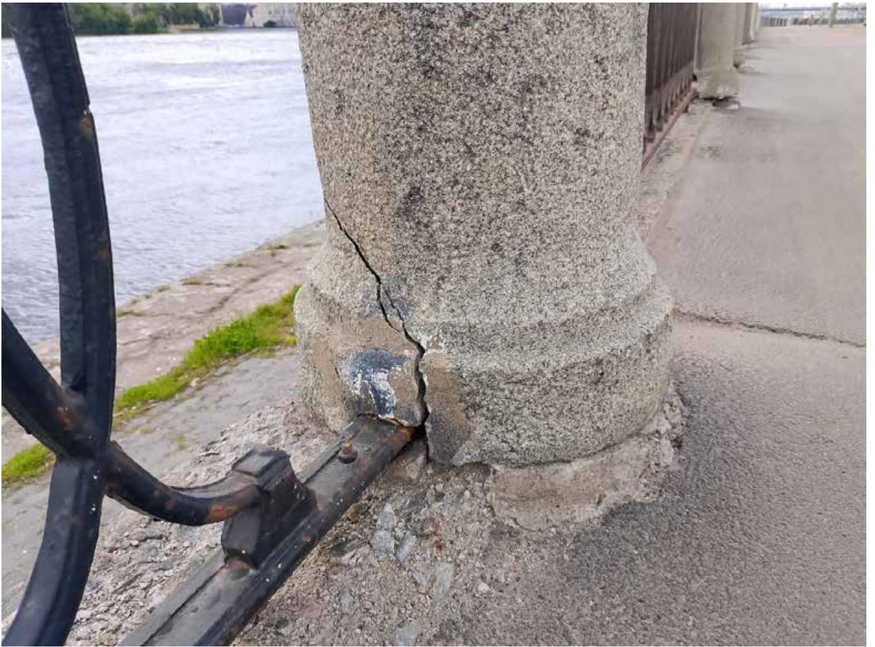
38. Сквозная наклонная трещина у основания тумбы.
