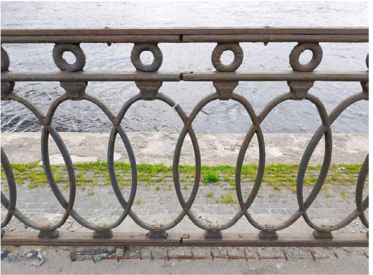
39. Коррозия чугунной решётки, расхождение узлов монтажа секций.
