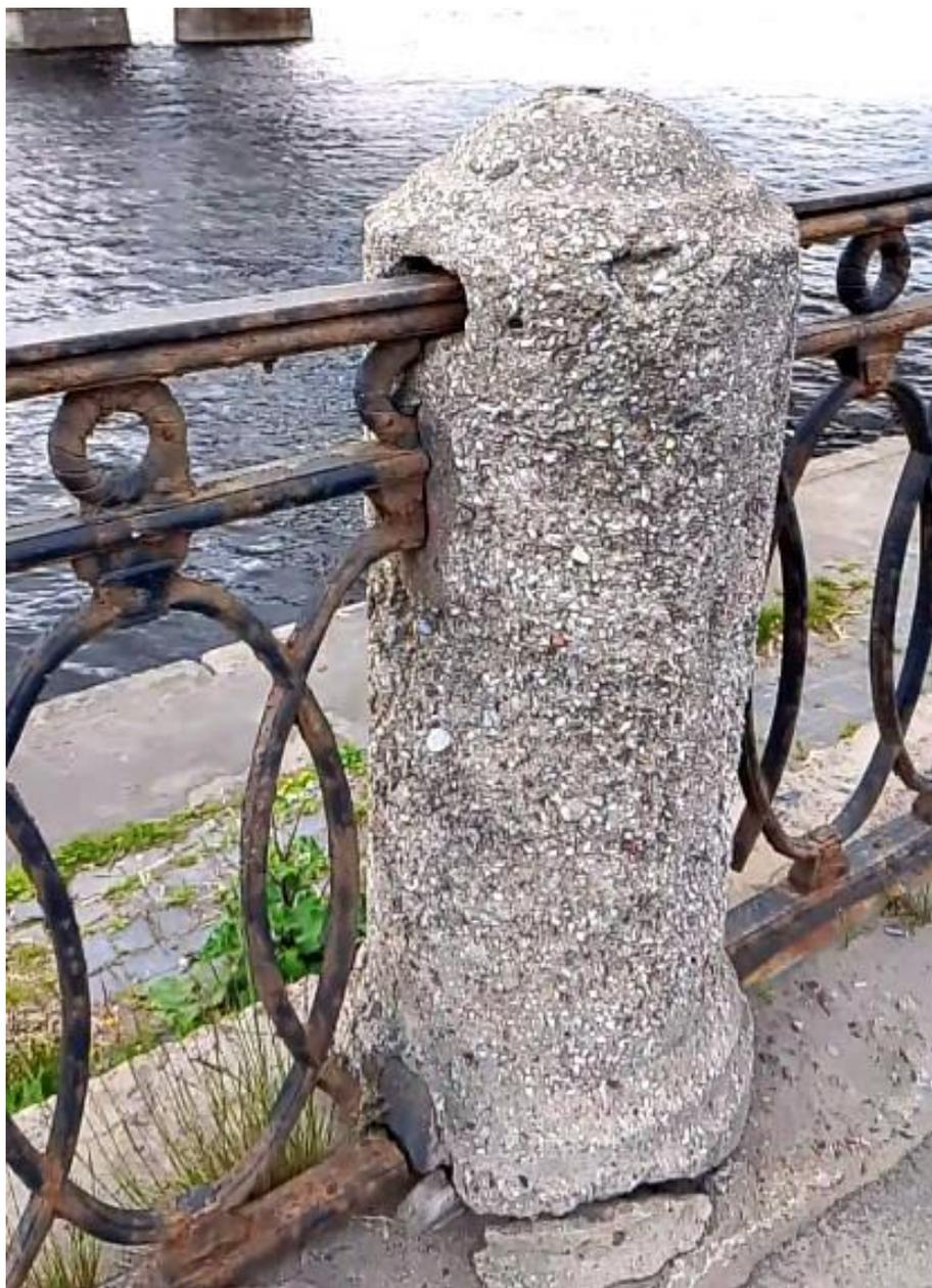
5. Бетонная тумба с многочисленными повреждениями; чугунная решётка корродирована.
