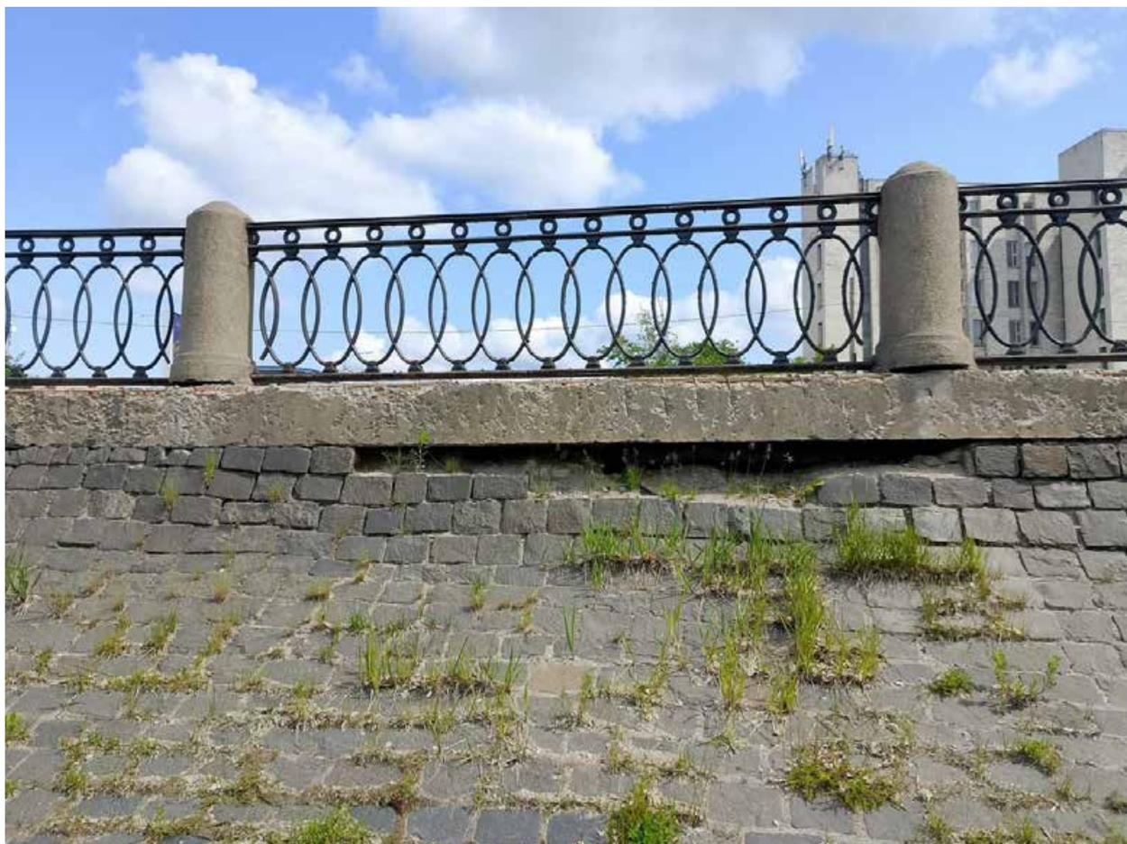
18. Вымывание основания под бетонным карнизом.
