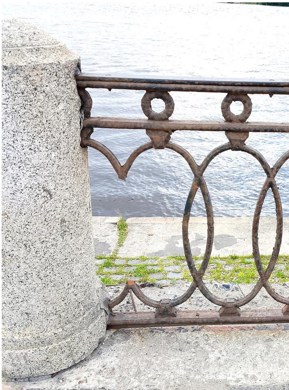
9. Секция ограждения поражена коррозией; утрачен фрагмент.
