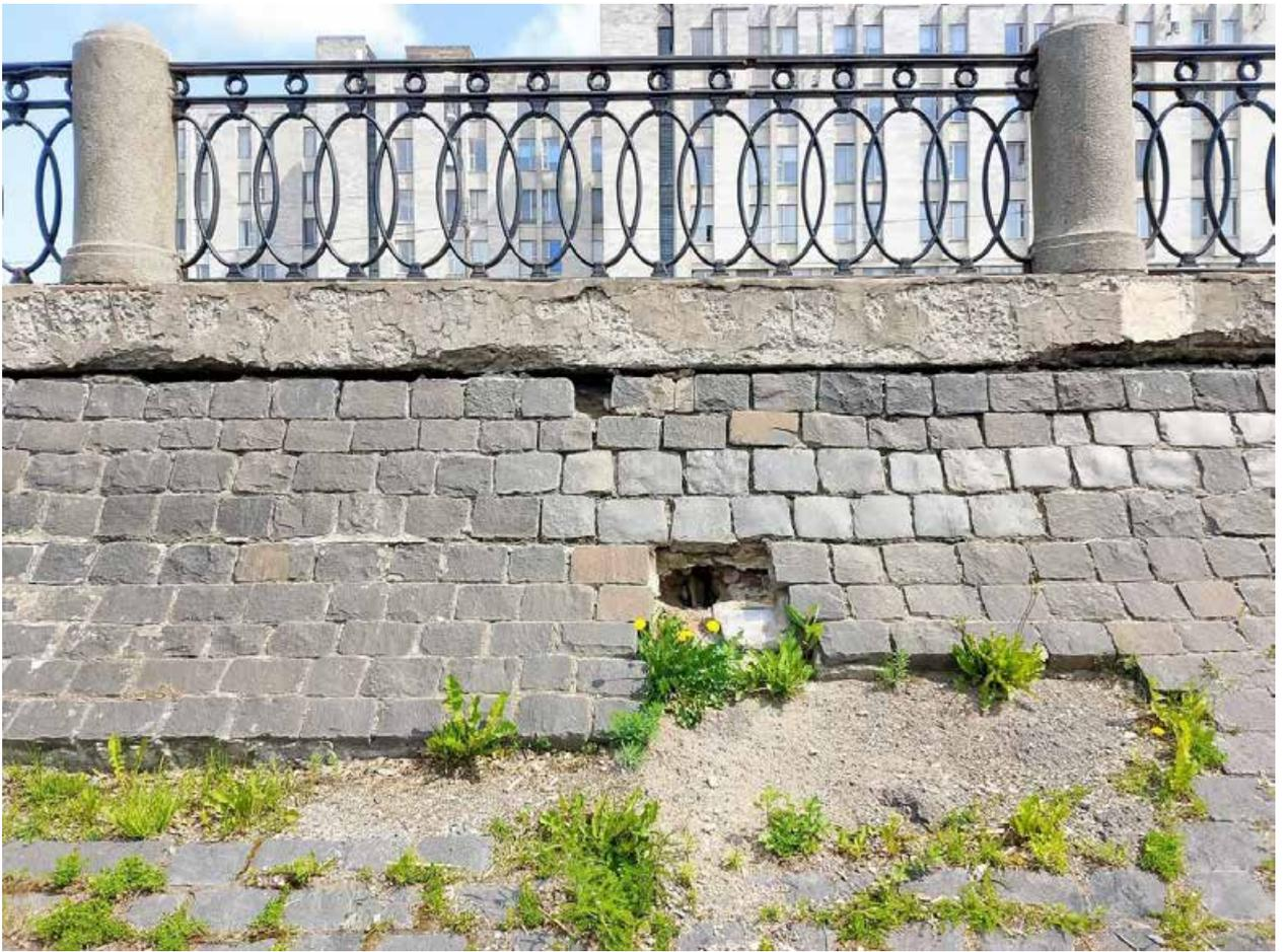
20. Утраты мощения диабазом, промывы, разрушение бетона в основании ограждения.
