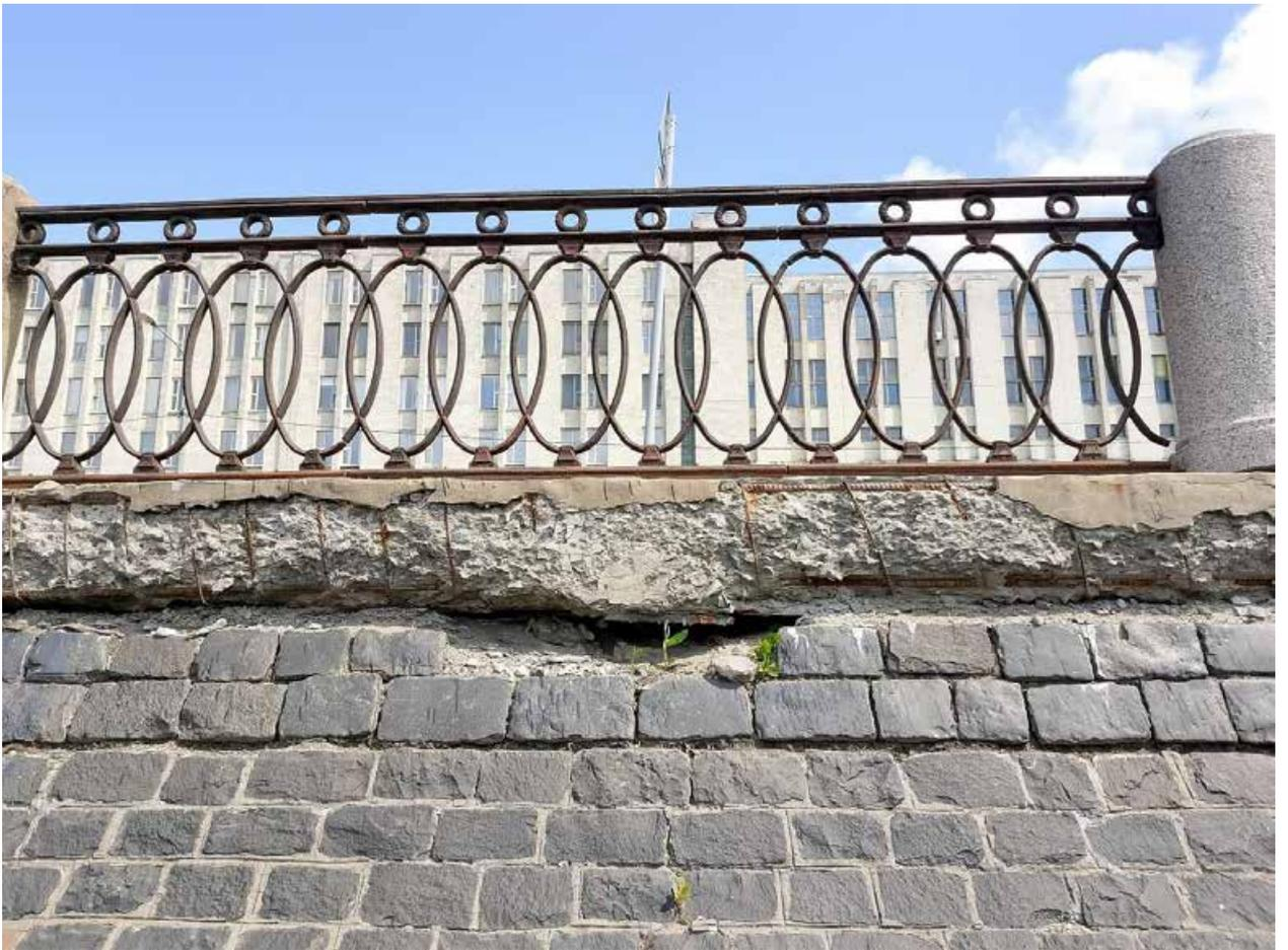
23. Обнажение арматуры, выкрашивание бетона карниза. Металлическое ограждение корродировано.
