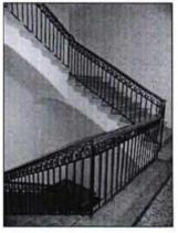
трехмаршевые лестницы (Л-5, Л-6) — на ползучих арках со ступенями из лещадной плиты и ограждением из кованого железа в виде вертикальных стоек;
