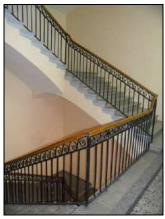
трехмаршевые лестницы (Л-5, Л-6) — на ползучих арках со ступенями из лещадной плиты и ограждением из кованого железа в виде вертикальных стоек;
