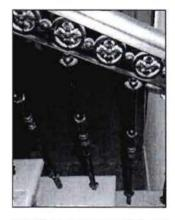
трехмаршевые лестницы (Л-1, Л-2, Л-4) — на ползучих арках со ступенями из лещадной плиты и ограждением из кованого железа в виде вертикальных стоек и фриза с орнаментом «бегущая волна»;
