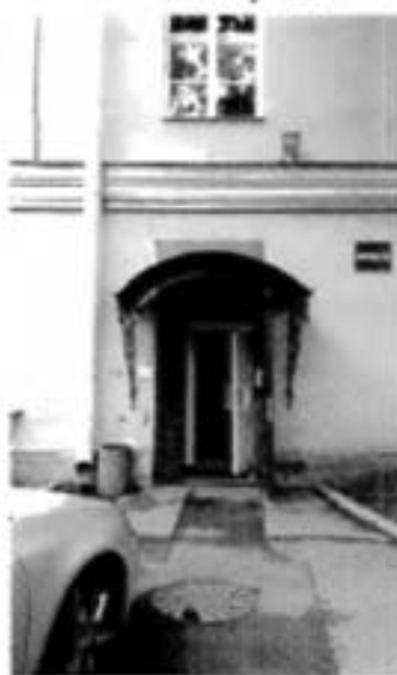
19. Вход с восточной стороны
