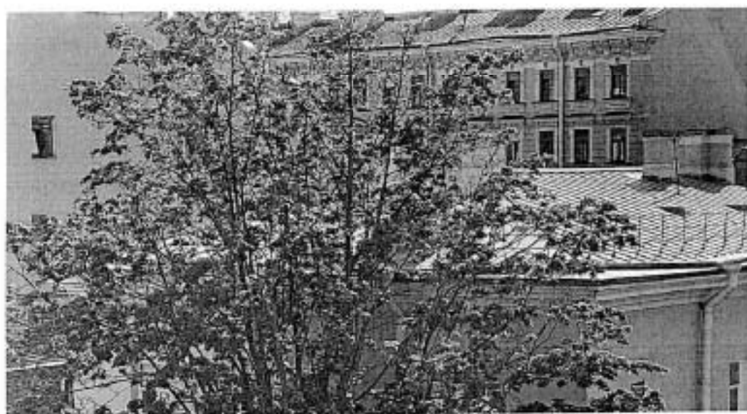
11. Фрагмент крыши корпуса лит.Б.
