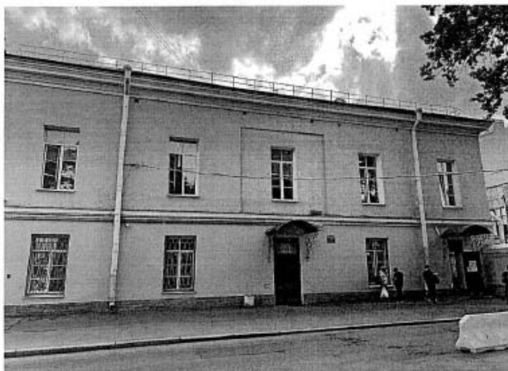
6. Фрагмент дворовых фасадов корпуса лит.В
