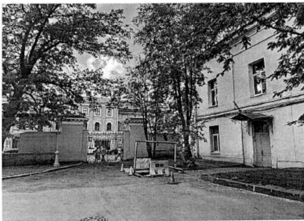
2. Дворовый фасад корпуса лит.Б
