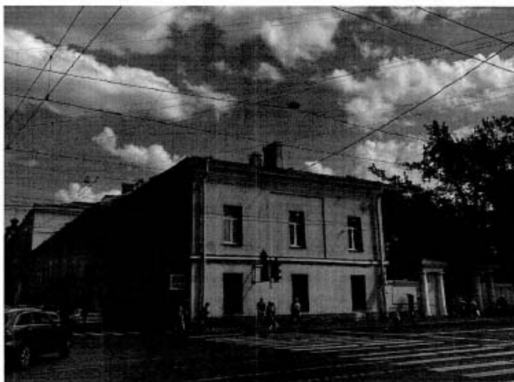
1. Лицевые фасады корпуса лит.Б
