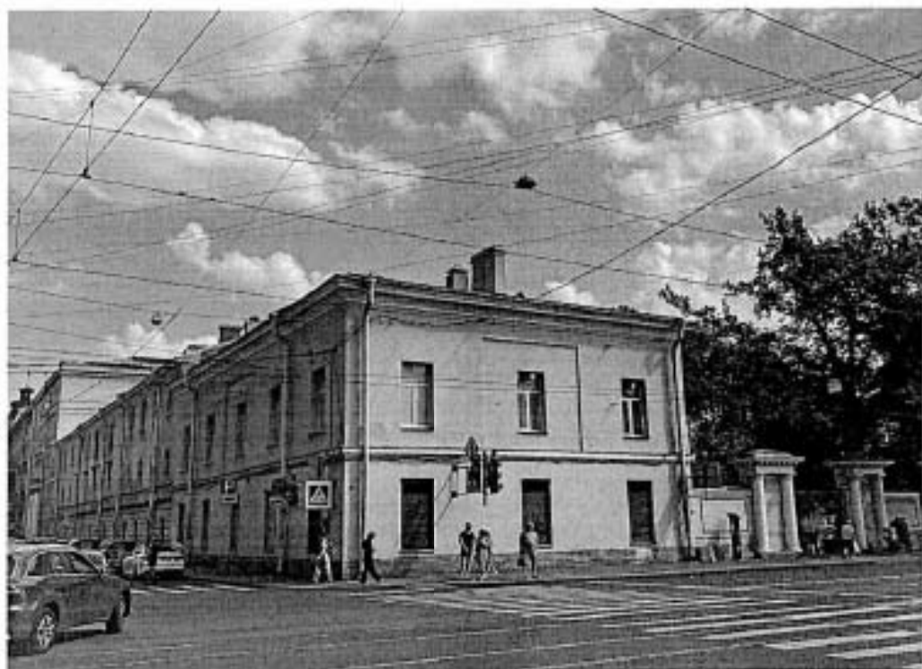
1. Лицевые фасады корпуса лит.Б
