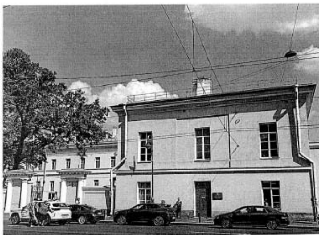
7. Лицевой фасад корпуса лит.В
