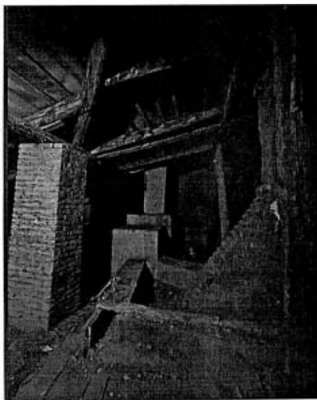
5. Фрагмент помещения чердака корпуса лит.Б
