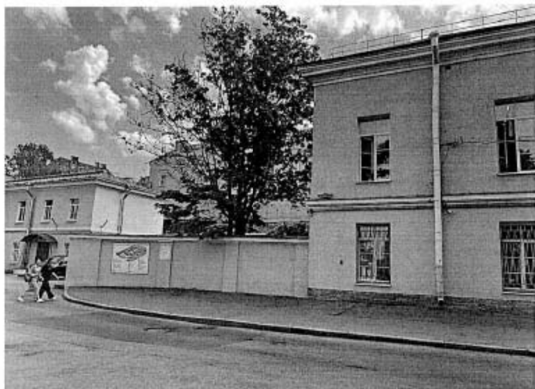
8. Фрагмент дворового фасадов корпуса лит.В
