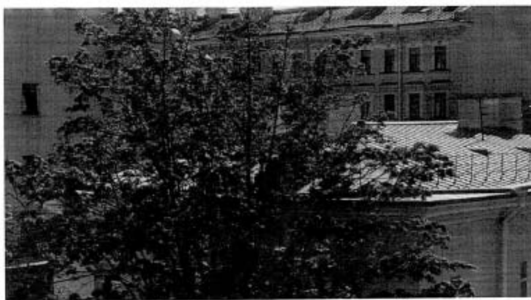
8. Фрагмент крыши корпуса лит.Б.
