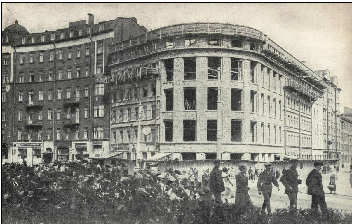
Илл. 21. Строительство дома на площади Стачек на угловом участке — угол площади Стачек и проспекта Юного пролетария (ныне Старо-Петергофского). Дом включает в себя два четырехэтажных дореволюционных здания, выходящих на проспект и на площадь. Фото 1930-х гг. Интернет-ресурс https://pastvu.com./116953
