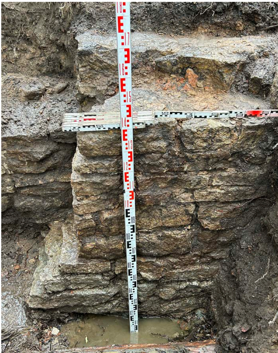
Илл. 43. Санкт-Петербург, набережная Крюкова канала, д. 20-22, литера А. Шурф 1. Фундамент 1, вскрытый до уровня стояния грунтовых вод. Деталь. Вид с востока.
