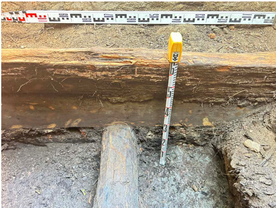
Илл. 31. Санкт-Петербург, набережная Крюкова канала, д. 20-22, литера А. Шурф 1. Деревянные конструкции после разборки дощатого пола – опалубка фундаментного рва и опорная поперечная лага. Деталь. Вид с востока.
