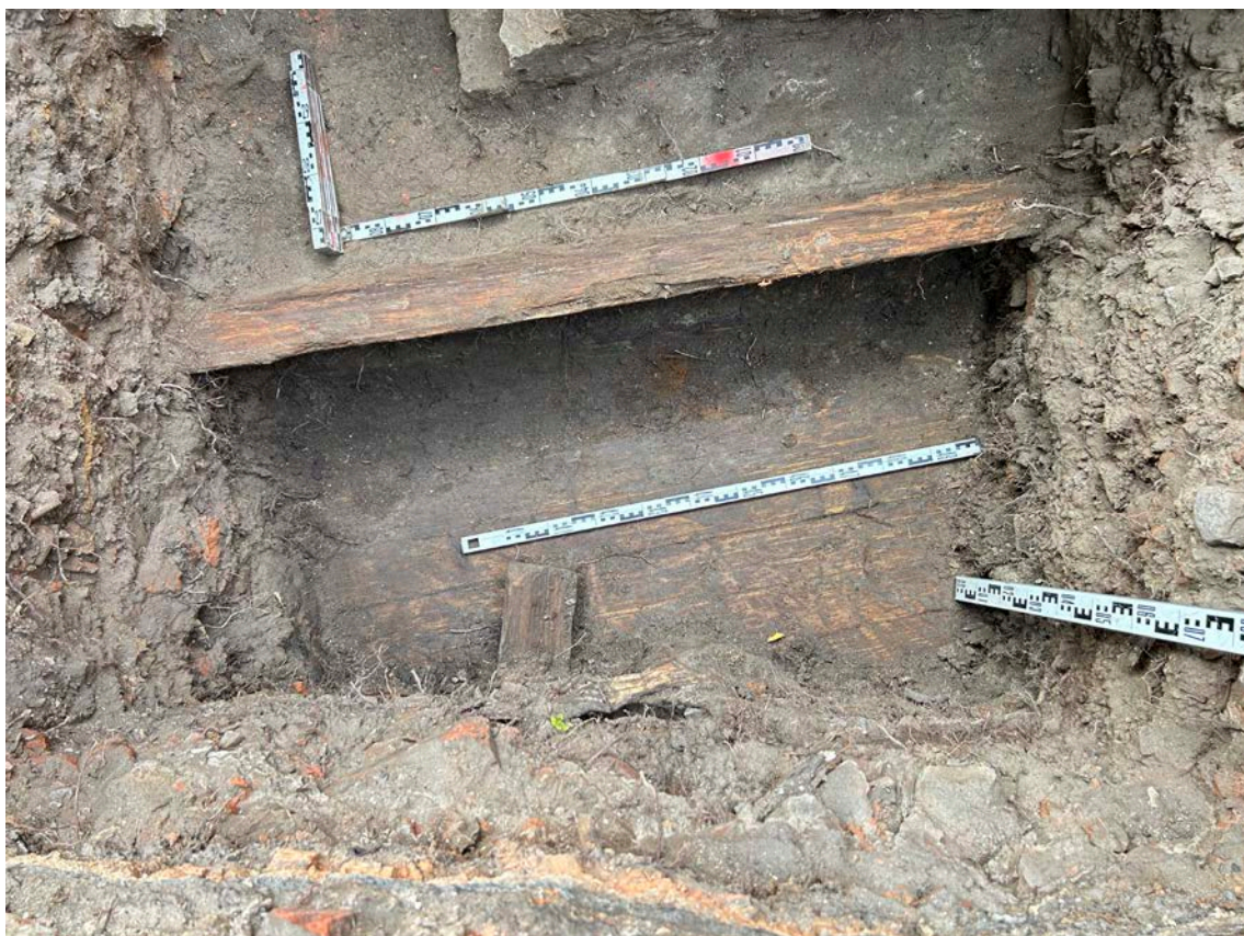
Илл. 29. Санкт-Петербург, набережная Крюкова канала, д. 20-22, литера А. Шурф 1. Деревянные конструкции (опалубка фундаментного рва и дощатый пол). Деталь. Вид с востока.
