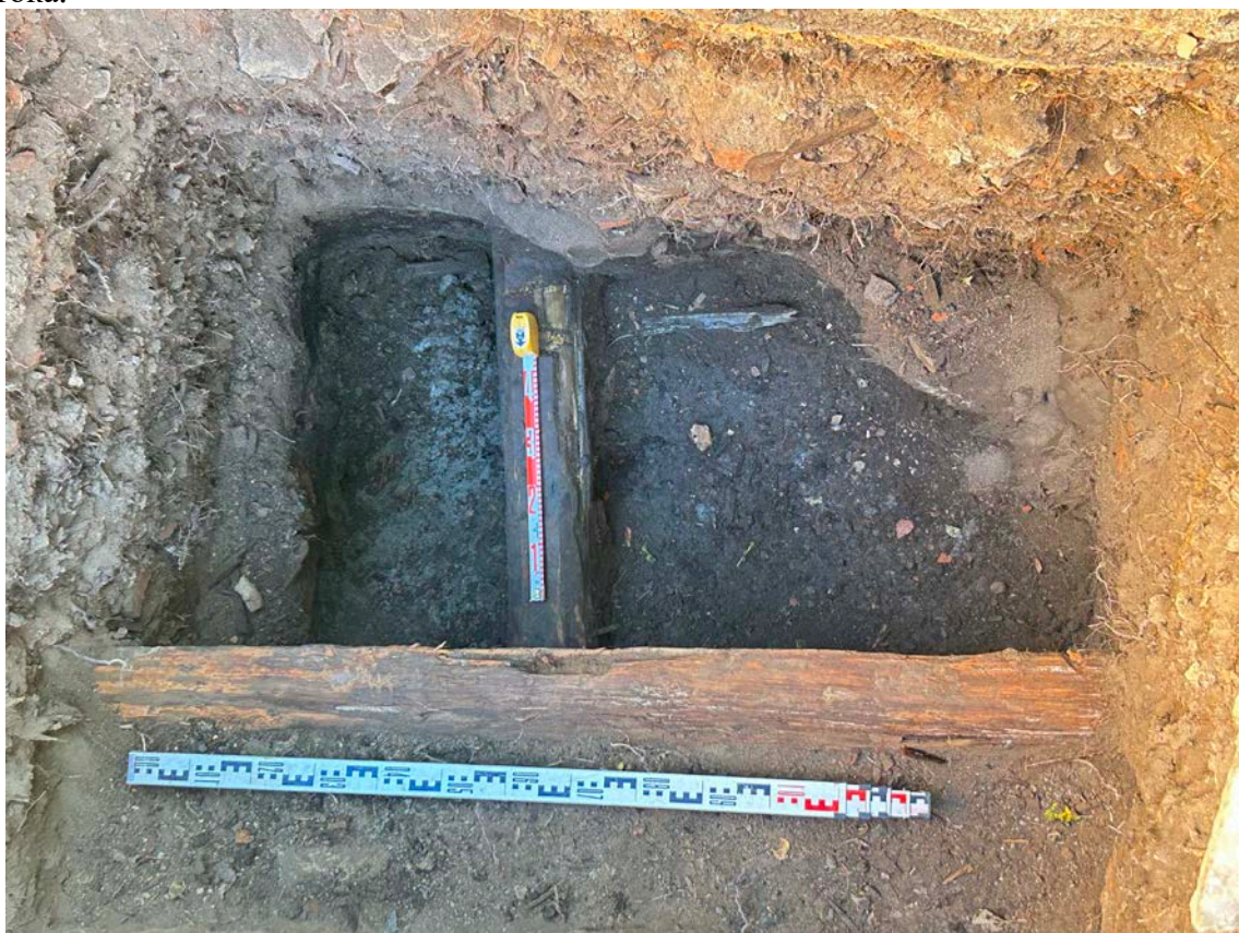
Илл. 30. Санкт-Петербург, набережная Крюкова канала, д. 20-22, литера А. Шурф 1. Деревянные конструкции после разборки дощатого пола – опалубка фундаментного рва и опорная поперечная лага. Деталь. Вид с запада.
