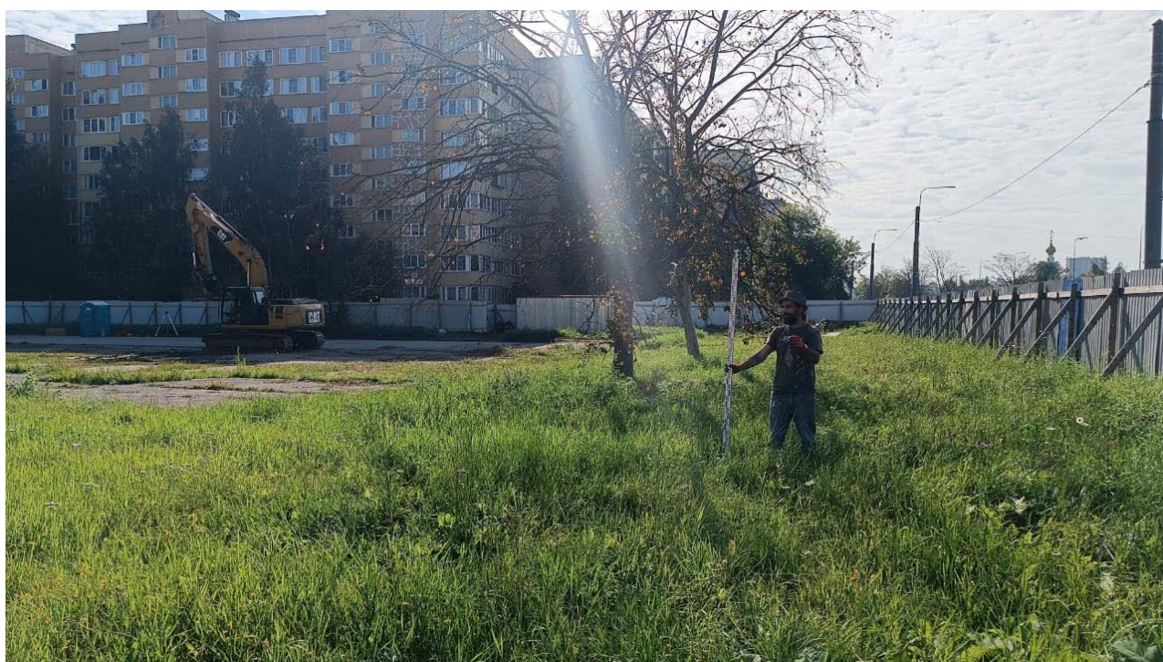
Рис. 25. СПб-2025. Ул. Маршала Захарова, КН: 78:40:0008312:1014. Точка фотофиксации 3, вид с севера.
