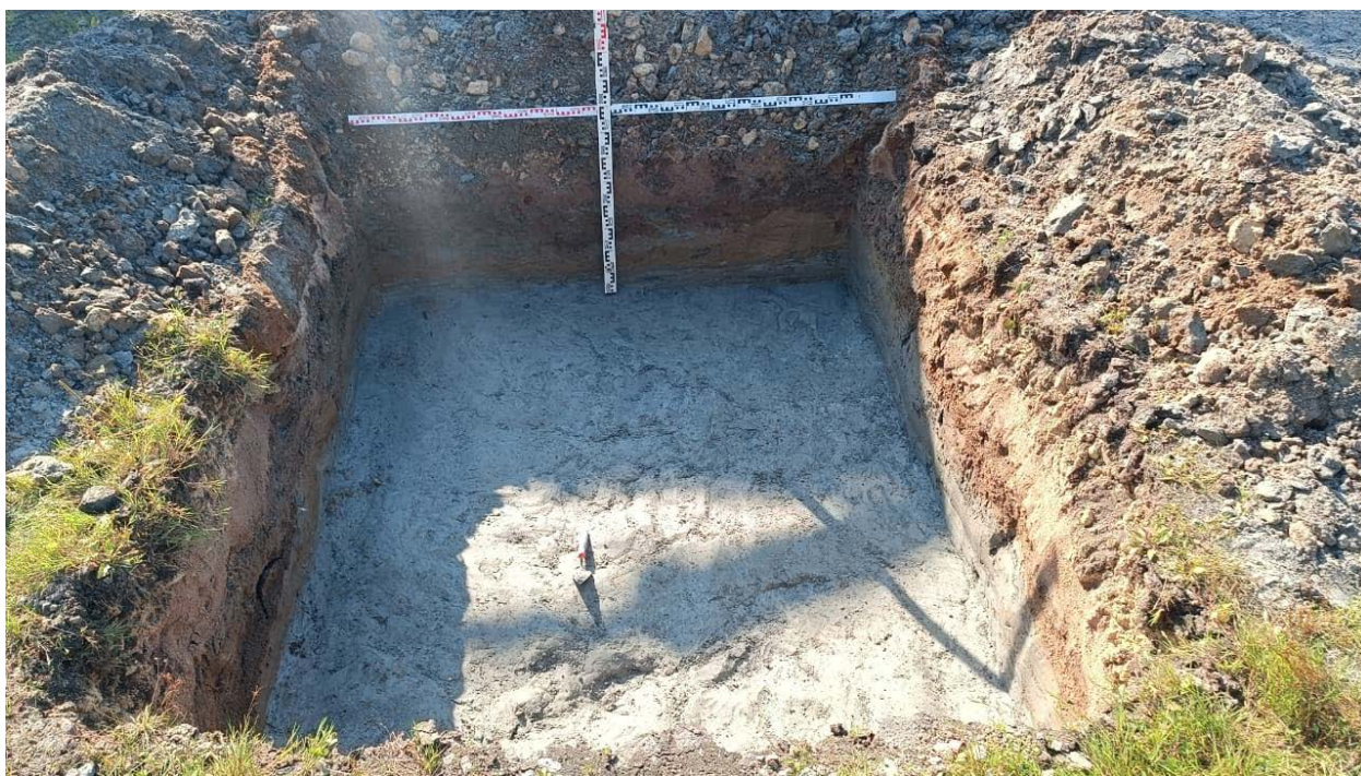
Рис. 49. СПб-2025. Ул. Маршала Захарова, КН: 78:40:0008312:1014. Шурф 1, фиксация по уровню окончания работ, вид с севера.
