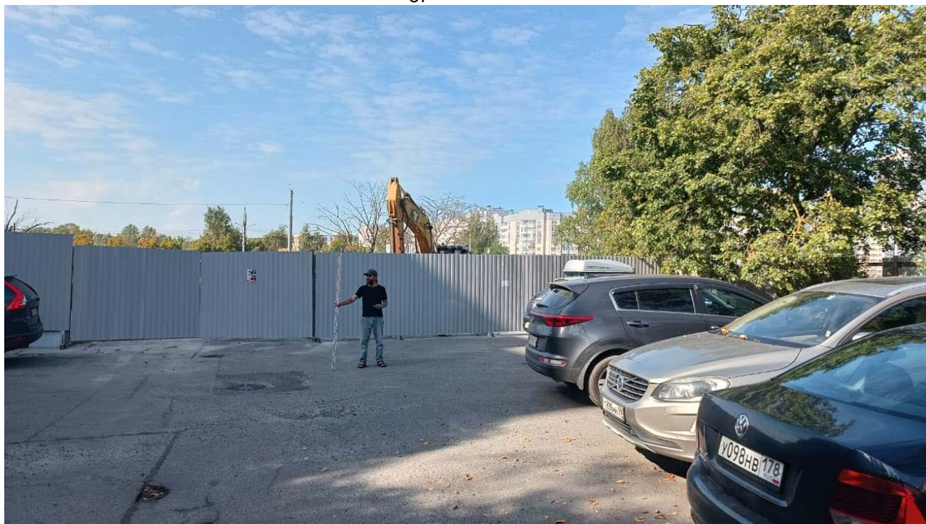
Рис. 36. СПб-2025. Ул. Маршала Захарова, КН: 78:40:0008312:1014. Точка фотофиксации 7, вид с востока.
