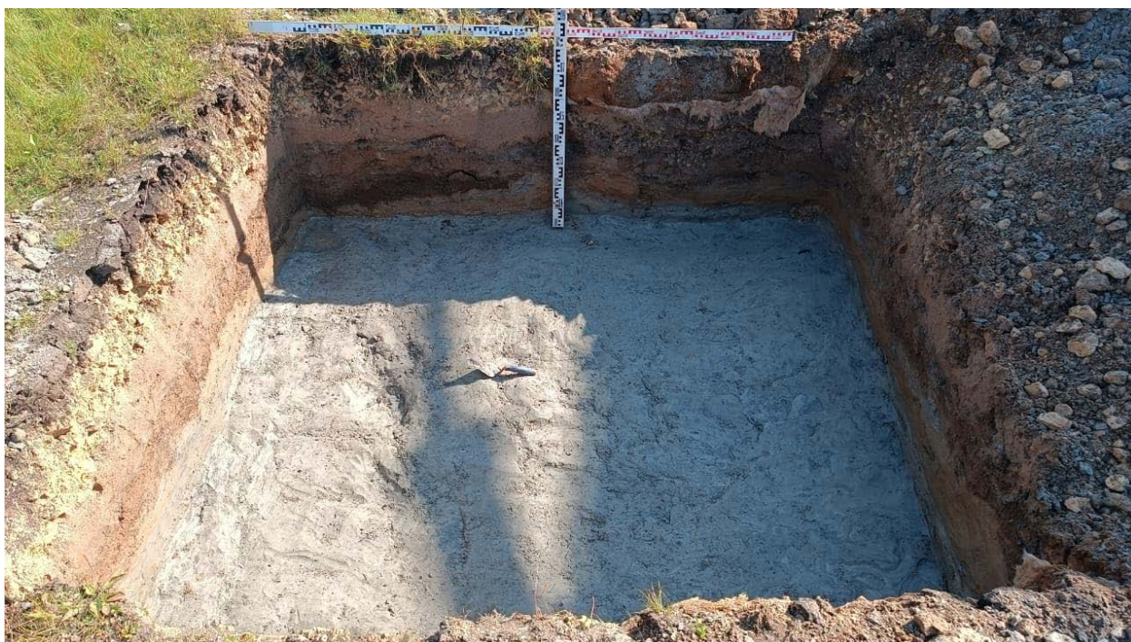
Рис. 47. СПб-2025. Ул. Маршала Захарова, КН: 78:40:0008312:1014. Шурф 1, фиксация по уровню окончания работ, вид с запада.
