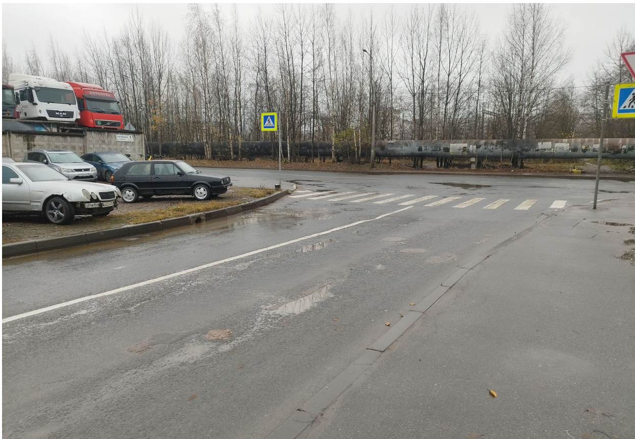
Илл. 17. Участок экспертизы. Общий вид с северо-запада. 08.11.2025 г.
